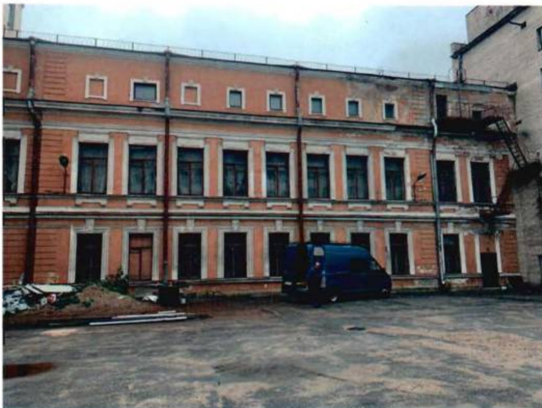
2. Вид на северный фасад объекта культурного наследия.
