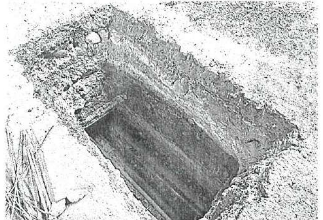
9. Асфальтовое покрытие северного проезда (между трехэтажным и двухэтажным корпусом)
