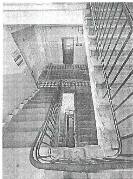
21. Служебная лестница объекта культурного наследия
