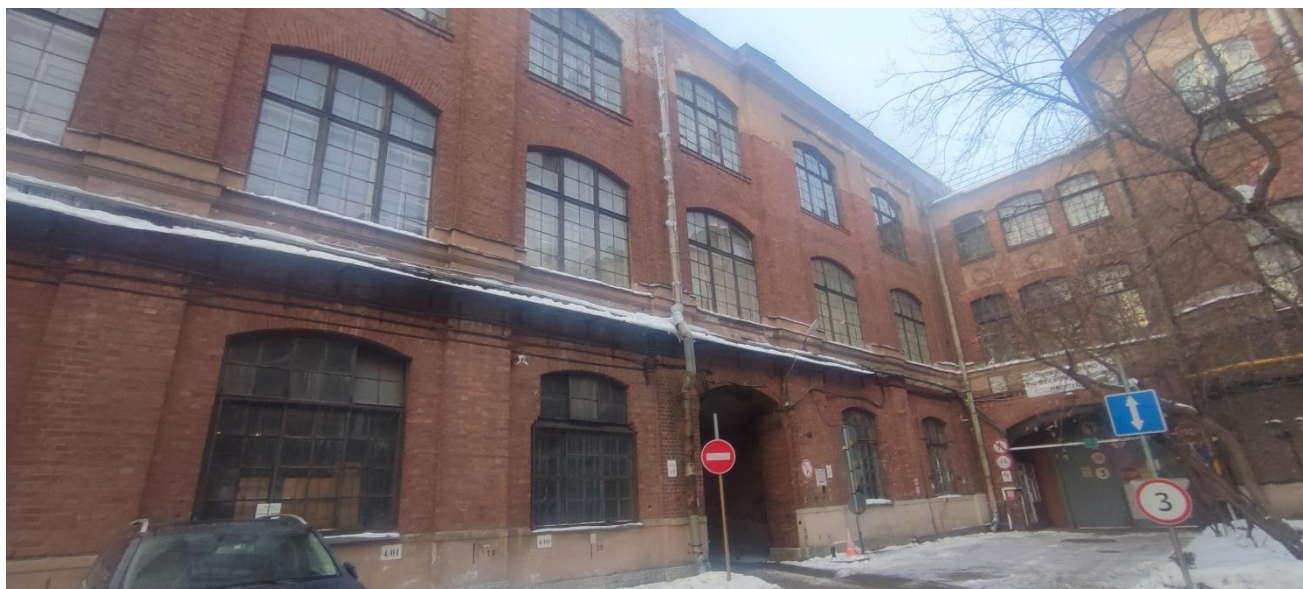
11. Восточные фасад здания.
