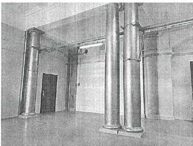
14. Фрагмент вестибюля парадного входа со стороны Гатчинской улицы
