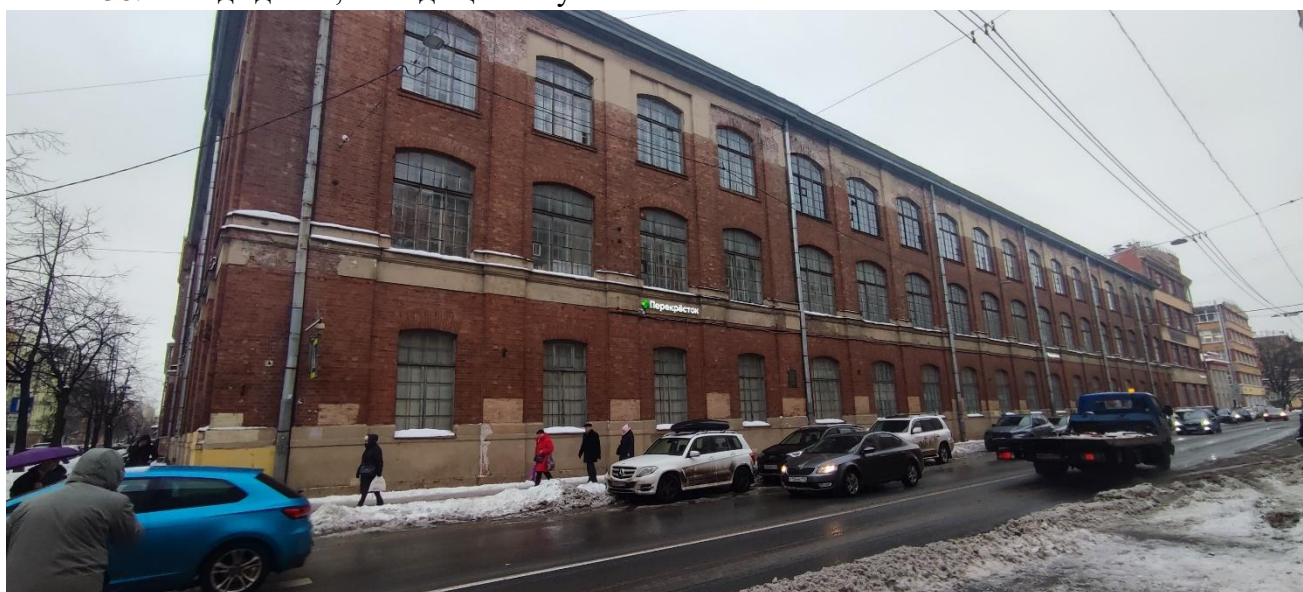
39. Фасад здания, выходящий на пр. Чкаловский.
