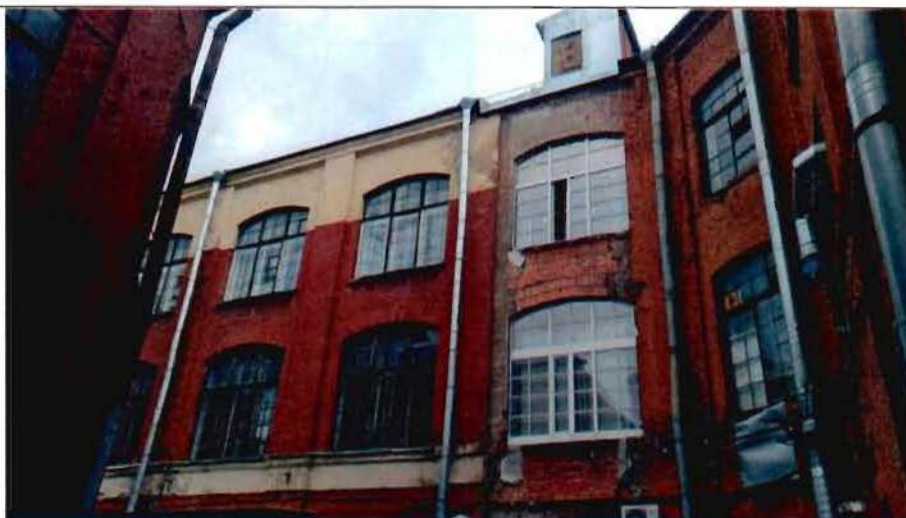
4. Фрагмент дворового фасада
