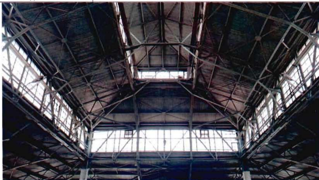
7. Металлоконструкции светового фонаря
