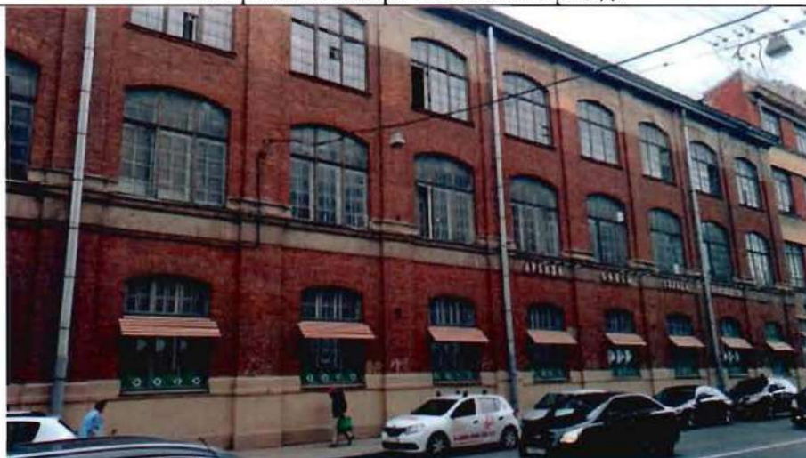
2. Фрагмент северо-западного фасада
