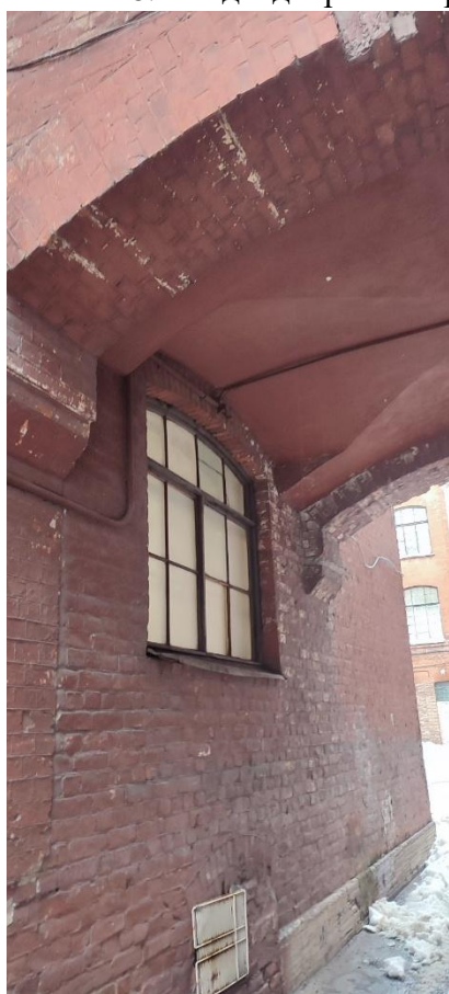
29. Оконные проём в дворовом проезде.
