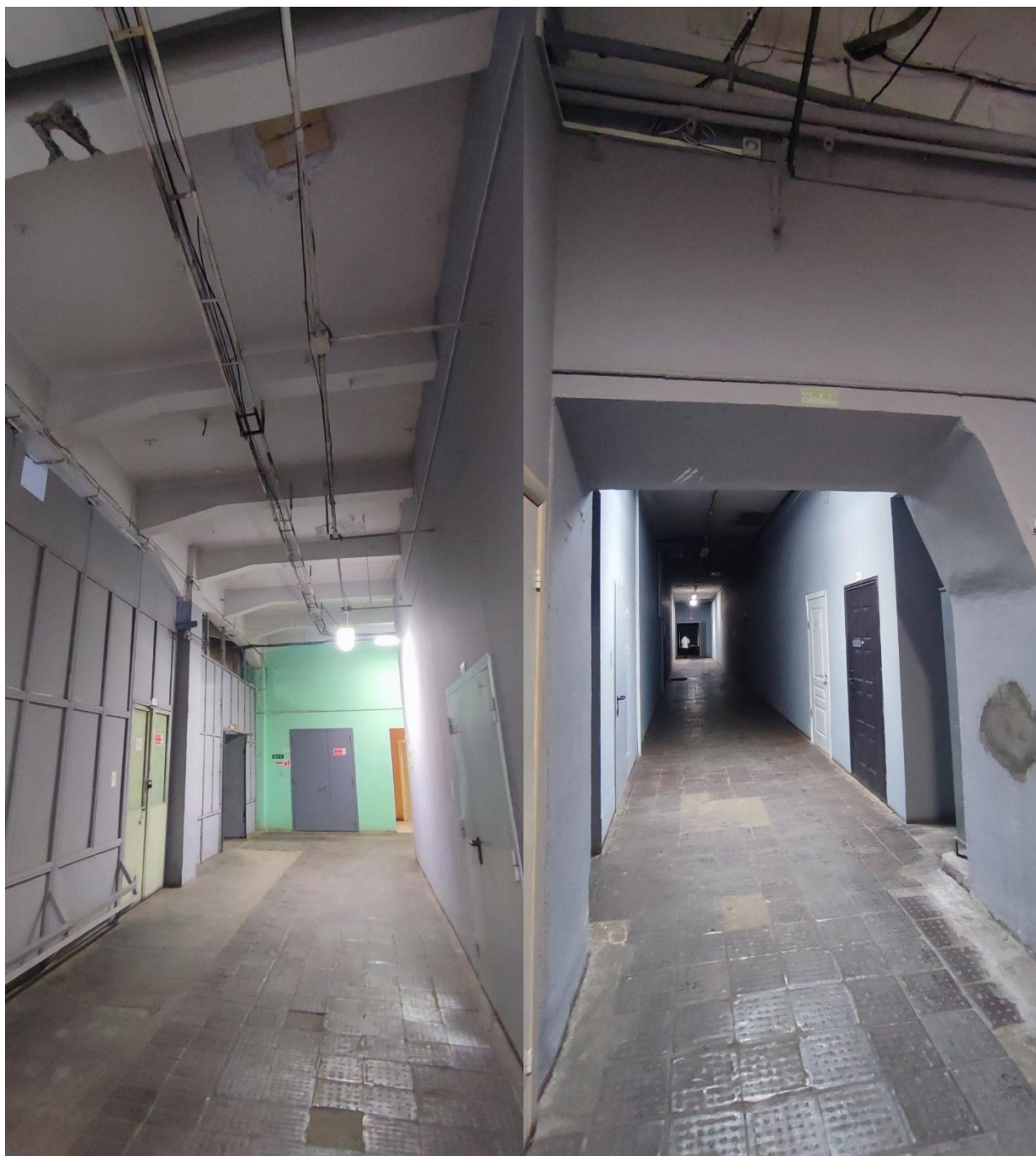
7. Коридор 2-го этажа части здания включаемой в границы территории объекта культурного наследия «Государственная типография».
