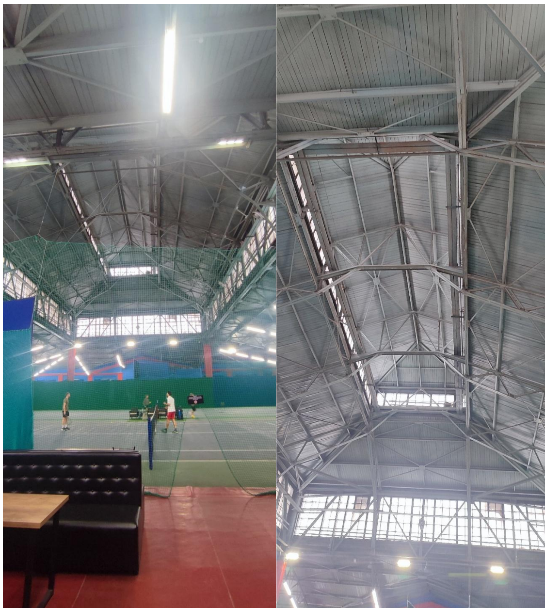
21. Фермовая металлическая конструкция дворового корпуса.
