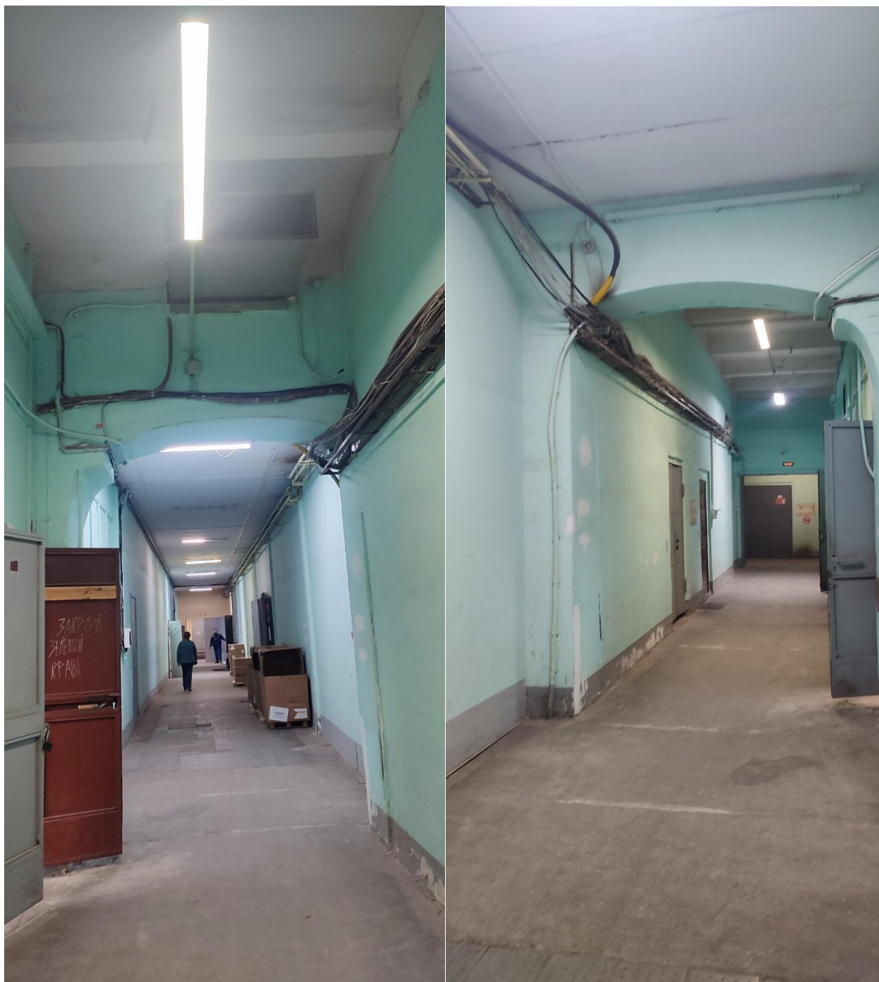
8. Коридор 3-го этажа части здания включаемой в границы территории объекта культурного наследия «Государственная типография».
