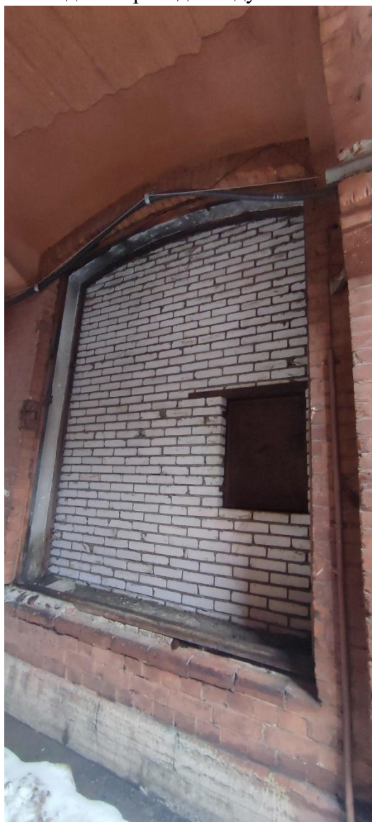
16. Оконный проём в арочной проезде.
