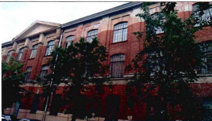
1. Фрагмент северо-восточного фасада
