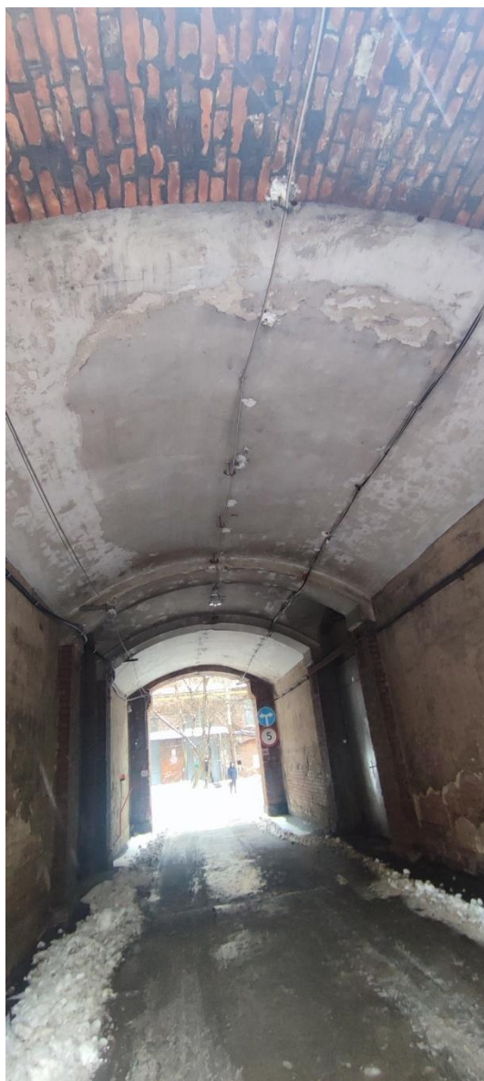
5. Арочный проезд, включаемый в границу территории объекта культурного наследия.
