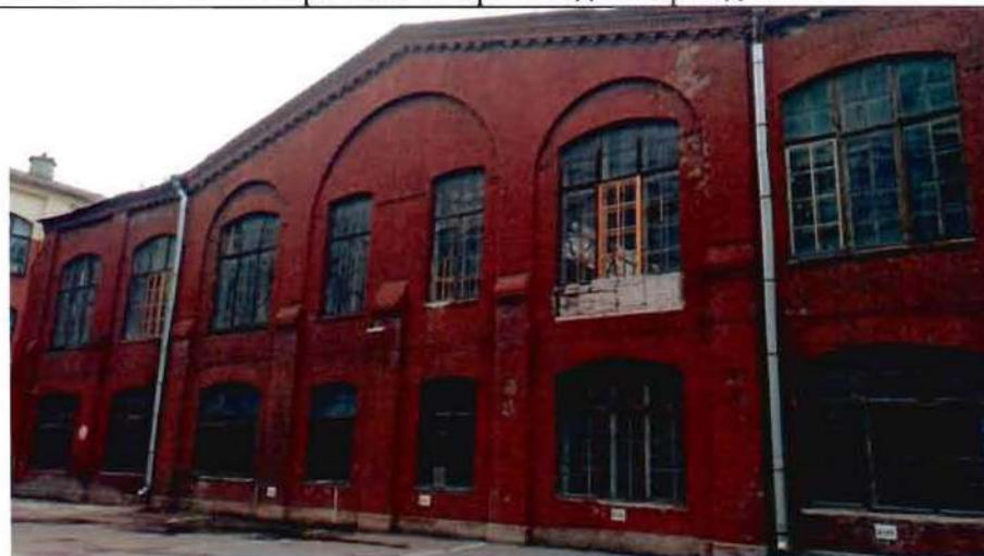
3. Фрагмент юго-западного фасада
