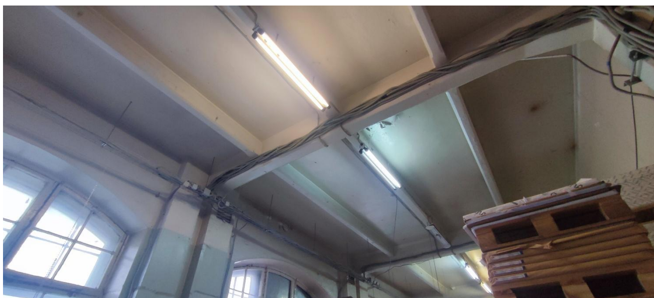
10. Внутреннее помещение 3-го этажа части здания включаемой в границы территории объекта культурного наследия «Государственная типография».
