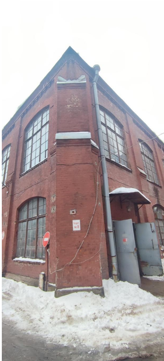
13. Угловая лопатка производственного корпуса.
