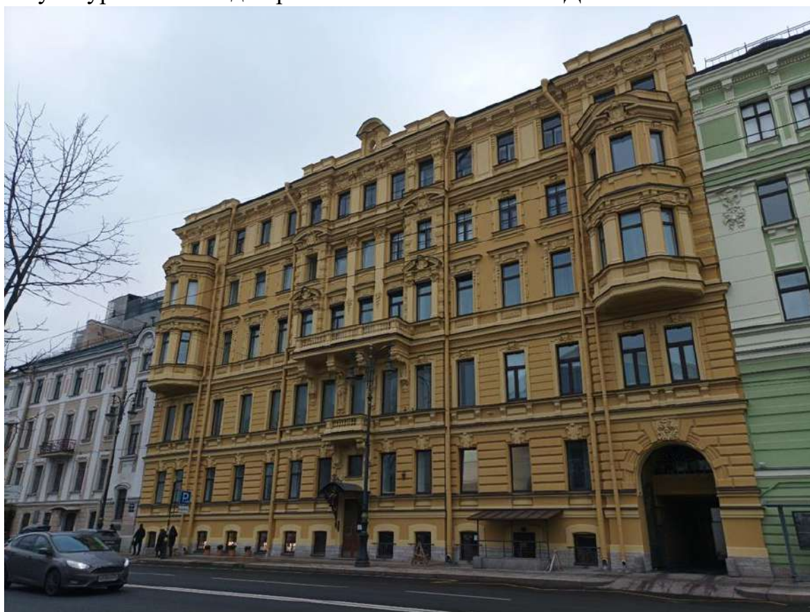
Фото 4. Вид на лицевой фасад пятиэтажного на цокольном этаже объема объекта культурного наследия регионального значения «Дом В.П. Лихачева».
