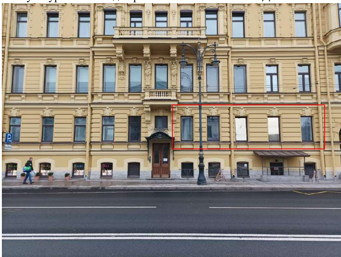
Фото 6. Вид на лицевой фасад пятиэтажного на цокольном этаже объема объекта культурного наследия регионального значения «Дом В.П. Лихачева». Красным отмечены окна квартиры № 1.
