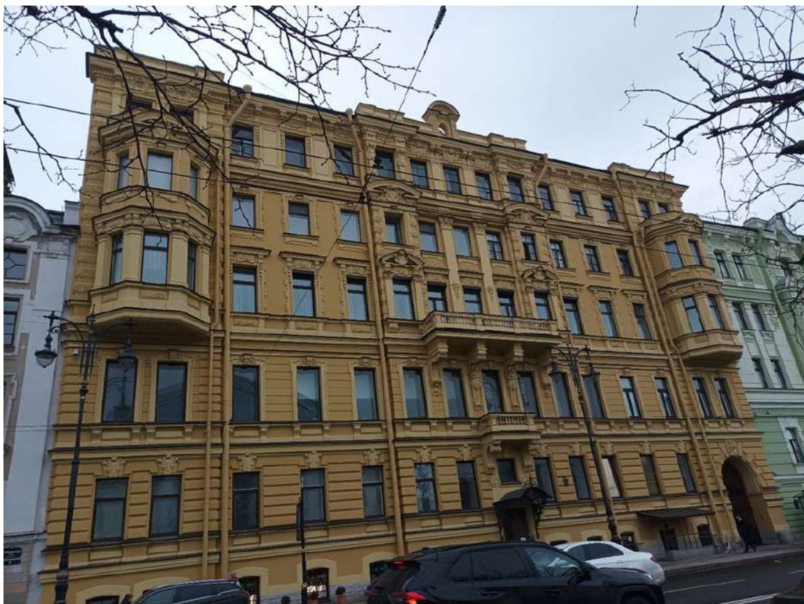
Фото 5. Вид на лицевой фасад пятиэтажного на цокольном этаже объема объекта культурного наследия регионального значения «Дом В.П. Лихачева».
