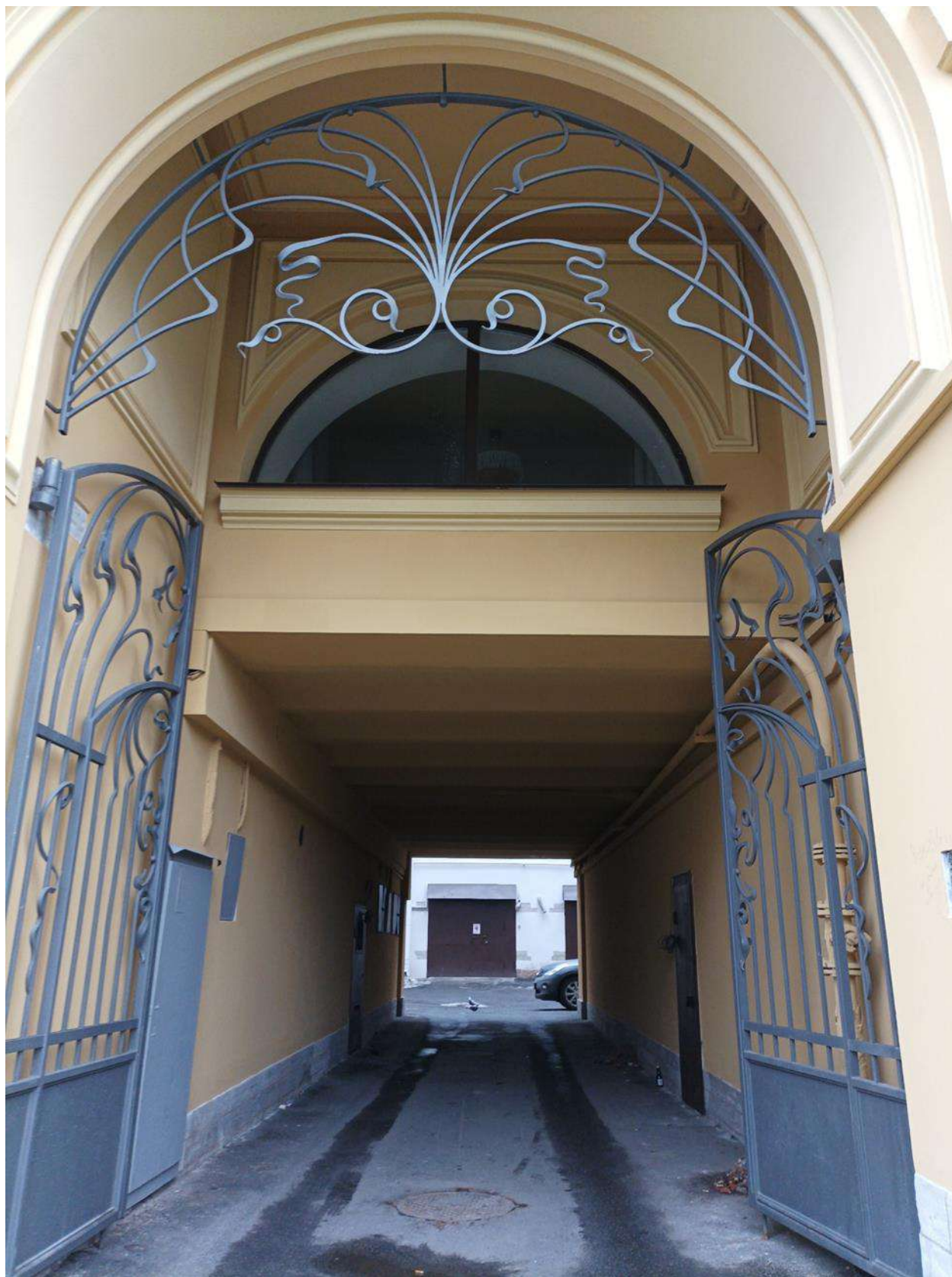
Фото 7. Воротный проезд пятиэтажного на цокольном этаже объема объекта культурного наследия регионального значения «Дом В.П. Лихачева».
