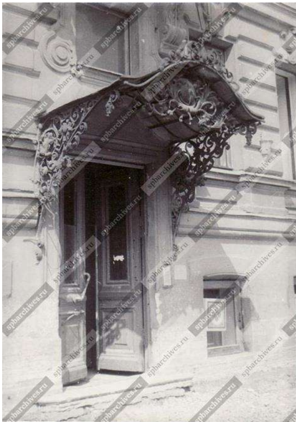
Илл. 58. Козырек над входом в дом № 7 по Потемкинской улице. 1988 г. (источник: ЦГАКФФД СПб. Фотодокументы. Опись 1АР-154. Ед.хр.215031).
