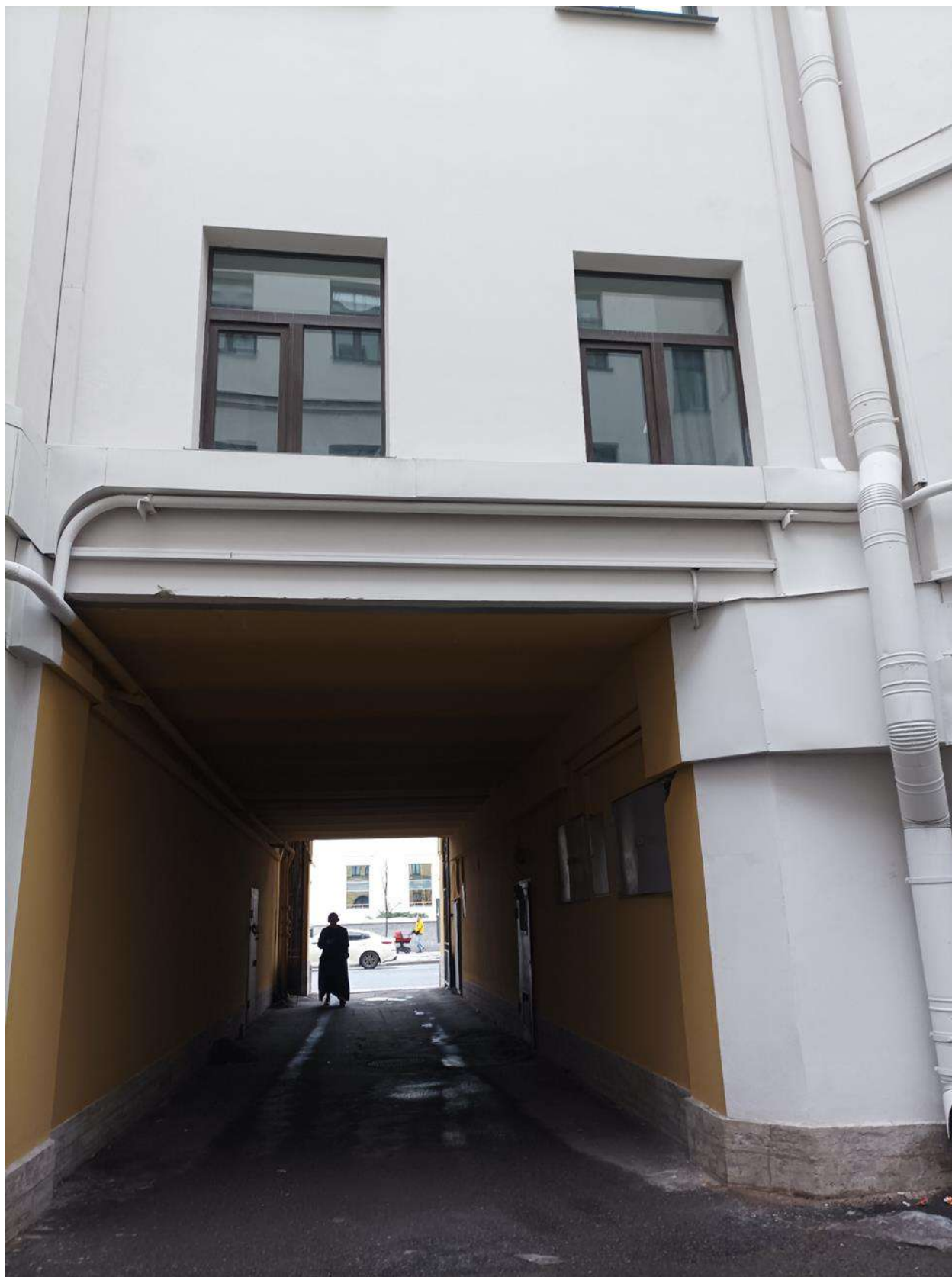
Фото 8. Воротный проезд пятиэтажного на цокольном этаже объема объекта культурного наследия регионального значения «Дом В.П. Лихачева».
