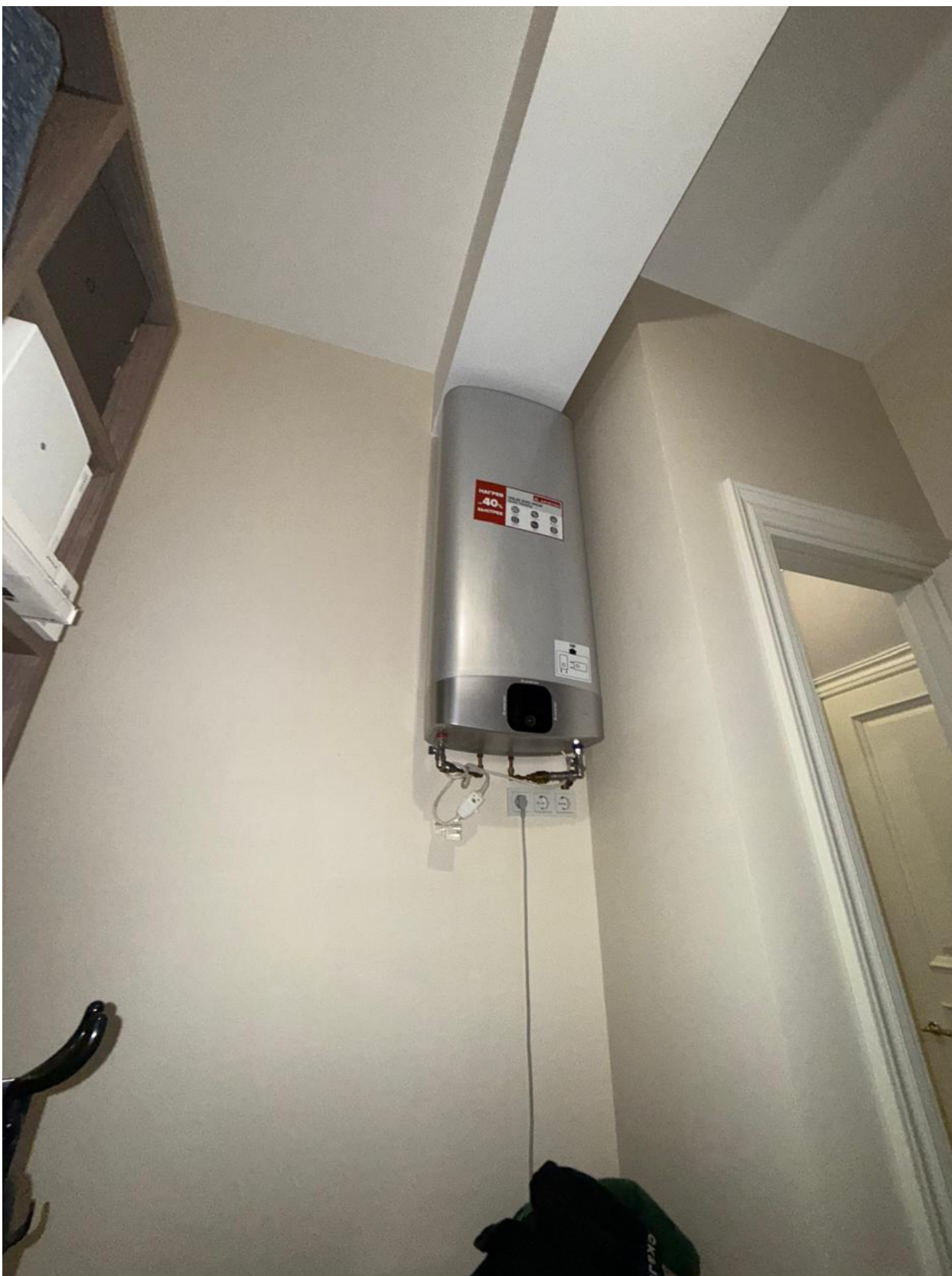
16. Помещение 4 (после перепланировки).
