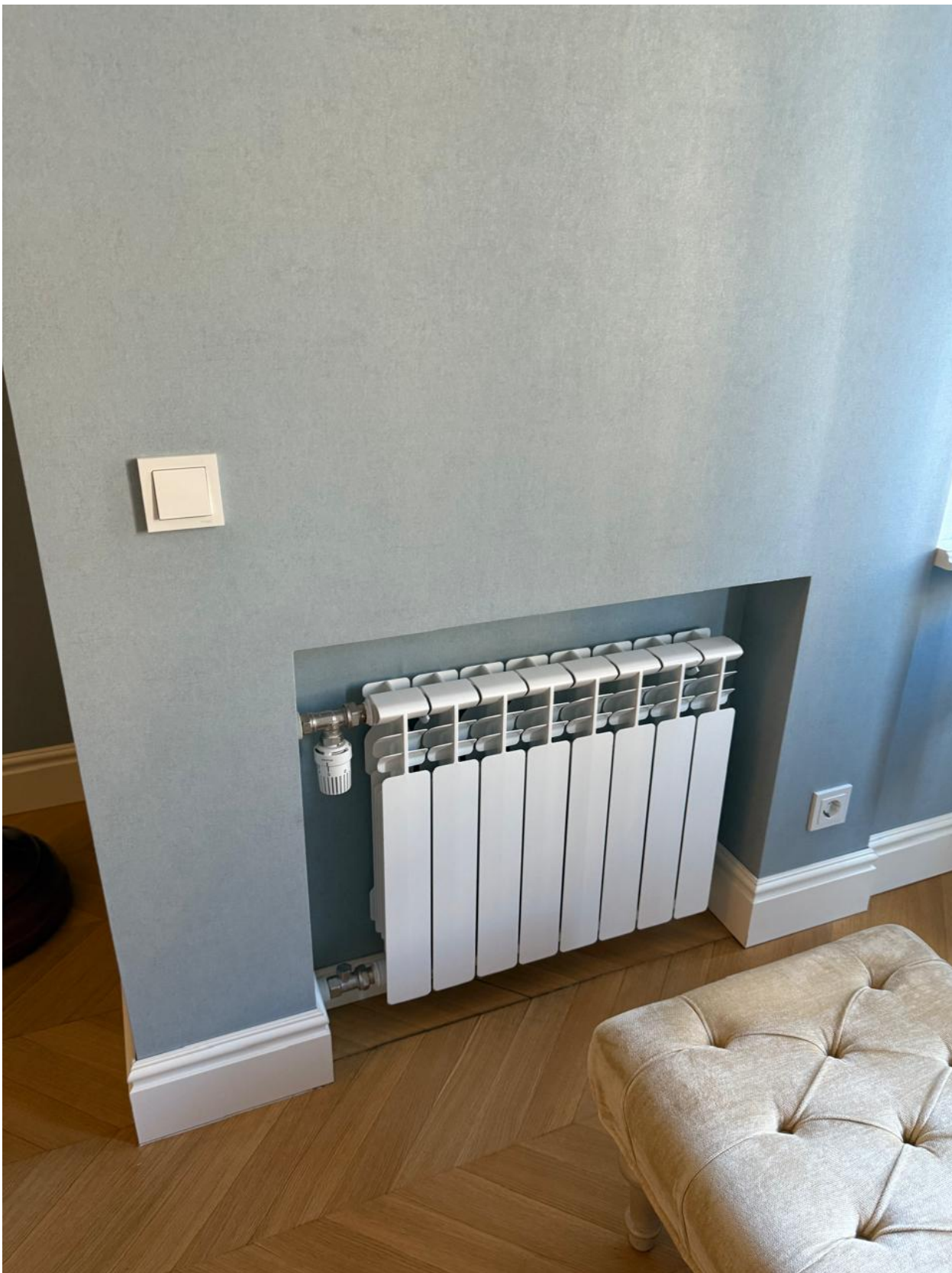
20. Помещение 2 (после перепланировки).
