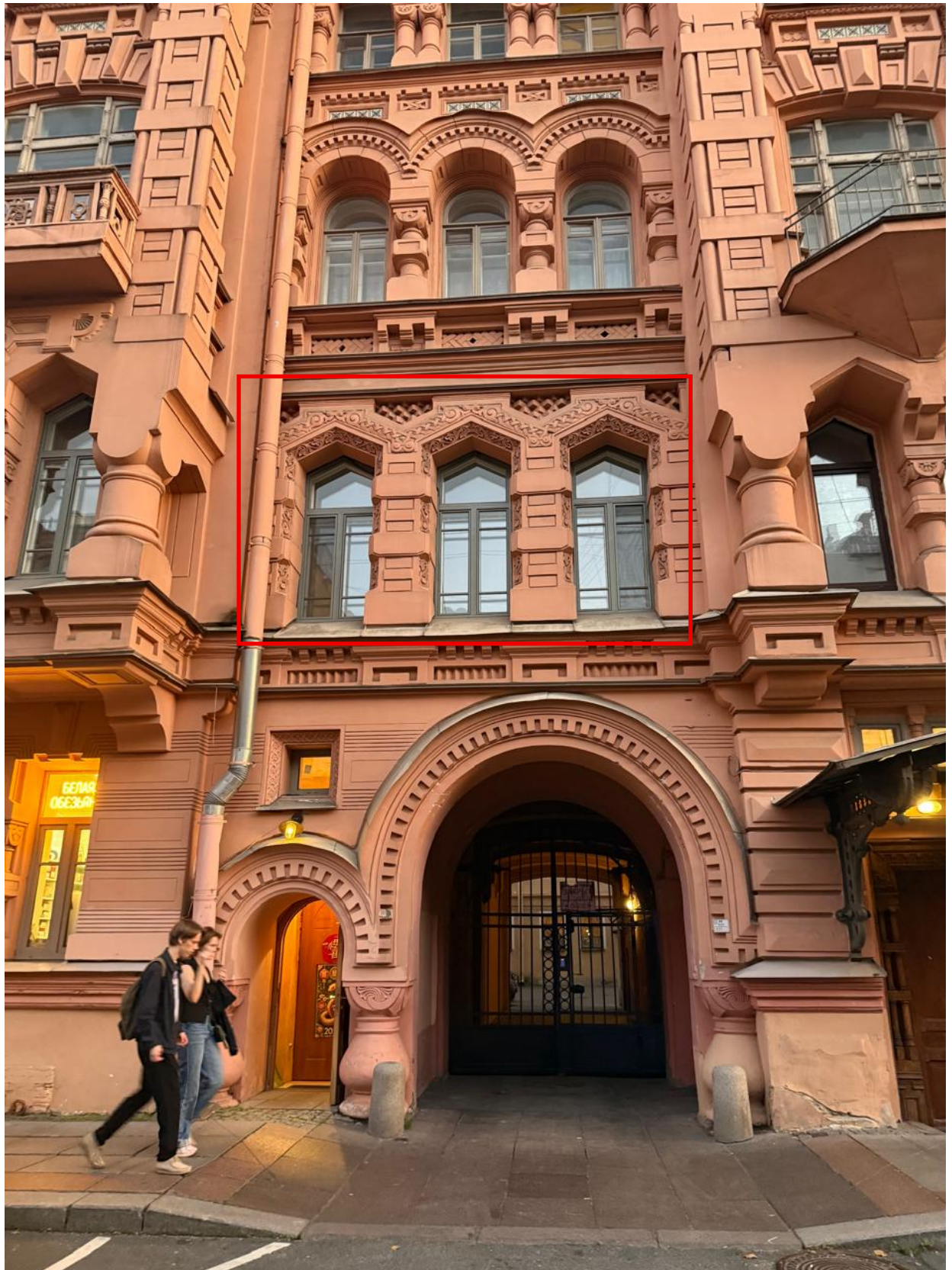
4. Фрагмент лицевого фасада. Красной линией отмечены оконные проемы квартиры.
