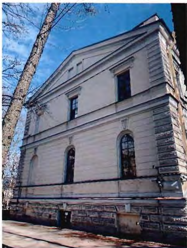
3. Юго-западный торцевой фасад объекта культурного наследия.
