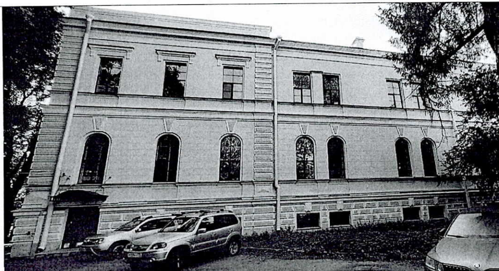
Фото 3. Фрагмент дворового фасада
