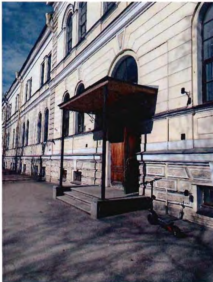
5. Юго-восточный фасад объекта культурного наследия. Входной портал.
