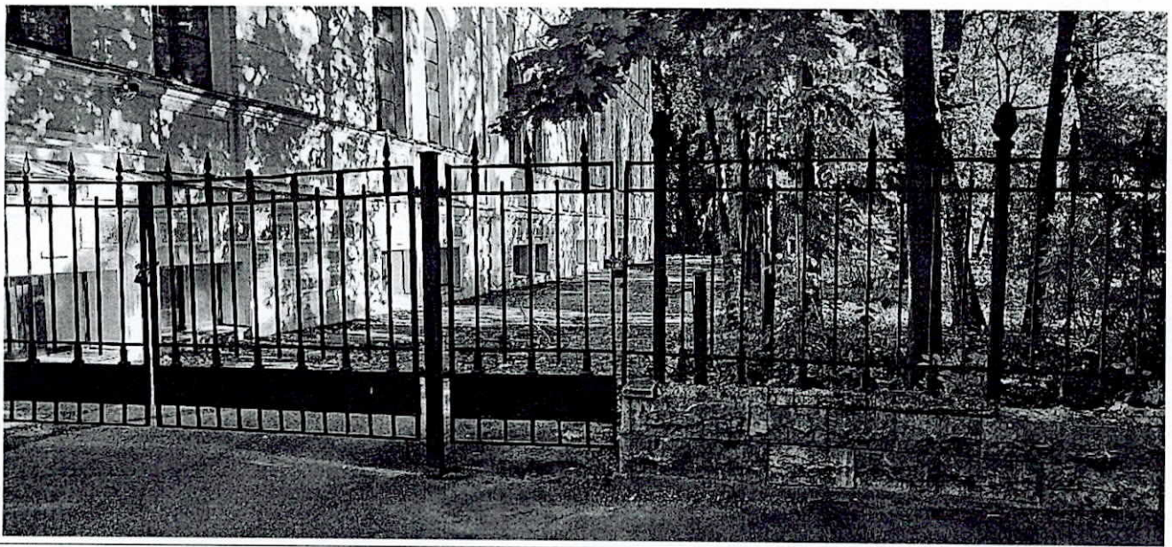
Фото 6. Ограда со стороны дворового фасада здания.
