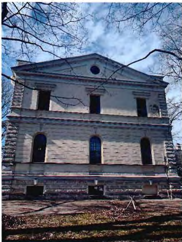
2. Вид на северо-восточный фасад объекта культурного наследия.
