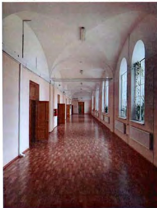
7. Коридор 1-го этажа. Своды с распалубками.
