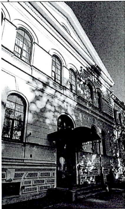
Фото 1. Фрагмент лицевого фасада
