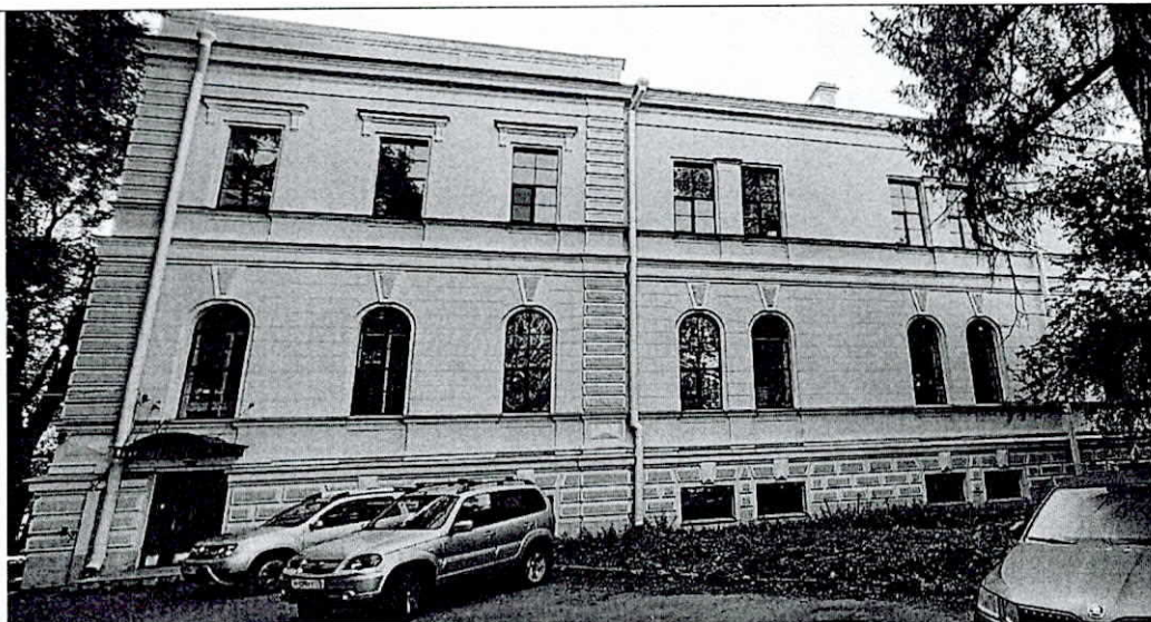
Фото 3. Фрагмент дворового фасада
