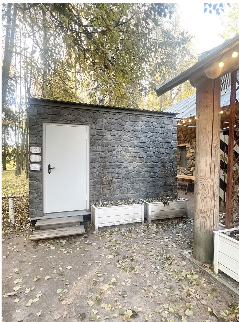
Фото 10. Павильон «Молочня». Временное сооружение. Южный фасад.
