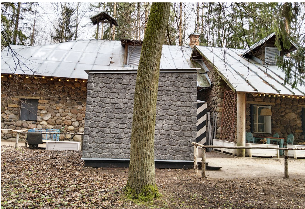
Фото 8. Павильон «Молочня». Временное сооружение. Вид с запада.
