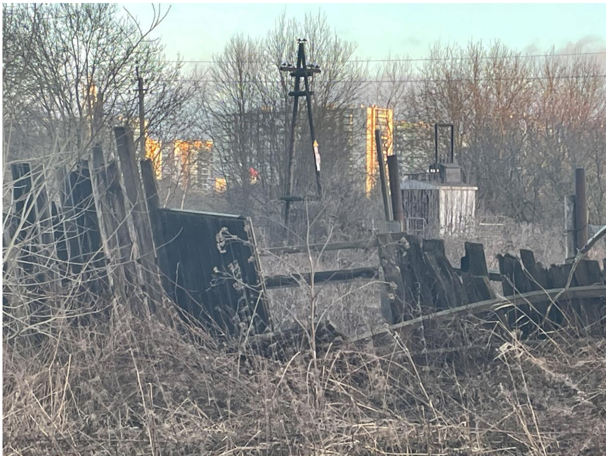
Фото № 6. Зона производства работ. Фото Лобановой Н. В. (19.12.2025 г.)
