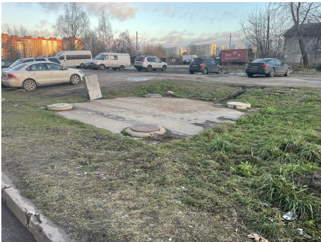
Фото № 5. Зона производства работ. Фото Лобановой Н. В. (19.12.2025 г.)
