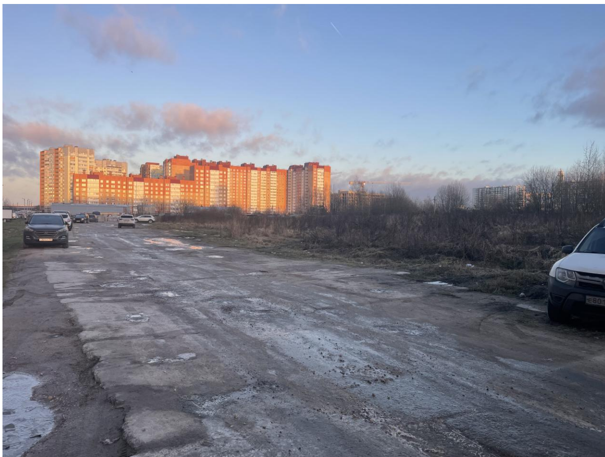
Фото № 7. Зона производства работ. Фото Лобановой Н. В. (19.12.2025 г.)
