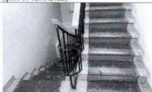
Фото 18. Лестница (пом. 2-Н (25) (фото от 12.05.2022).
