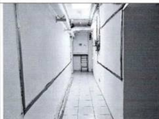
Фото 45. Помещение подвала (2-Н (76)) (фото от 05.09.2022).
