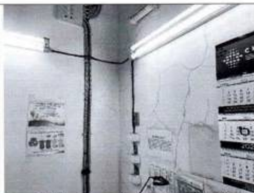
Фото 56. Помещение 1 этажа (пом. 2-Н (5) (фото от 12.05.2022).
