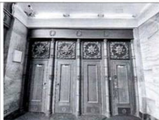
Фото 49. Помещение вестибюля (пом. 2-Н (1) (фото от 12.05.2022).
