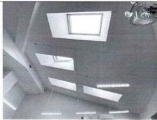
Фото 79. Помещение мансардного этажа (фото от 12.05.2022).
