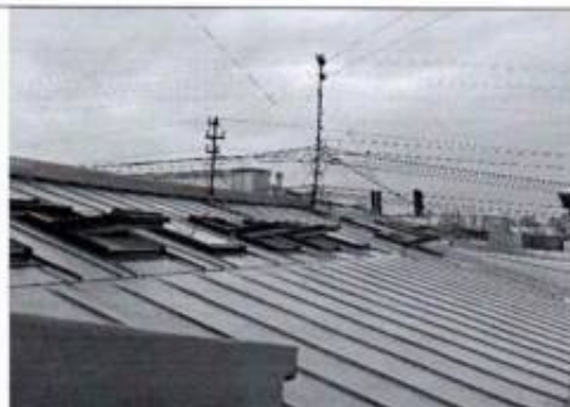
Фото 16. Фрагмент кровли (фото от 12.05.2022).
