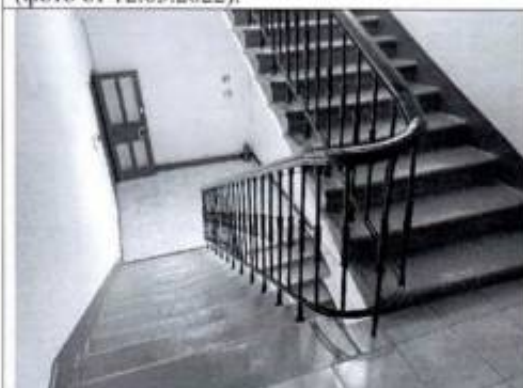
Фото 21. Лестница (1ЛК) (фото от 12.05.2022).
