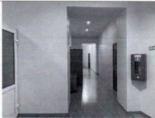
Фото 61. Помещение 2 этажа (пом. 7-Н (18)) (фото от 12.05.2022).
