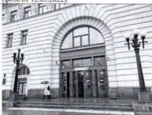
Фото 6. Крыльцо со стороны северо-западного фасада (фото от 12.05.2022).
