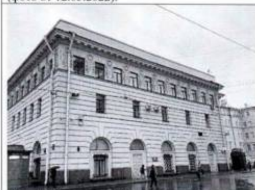
Фото 3. Юго-западный фасад (фото от 12.05.2022).
