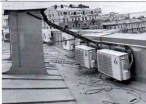
Фото 15. Фрагмент кровли (фото от 12.05.2022).
