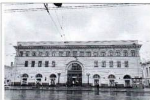
Фото 1. Северо-западный фасад (фото от 12.05.2022).
