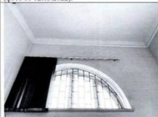
Фото 57. Помещение 1 этажа (пом. 2-Н (45) (фото от 12.05.2022).
