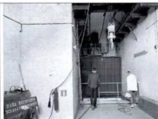
Фото 55. Помещение 1 этажа (пом. 2-Н (10) (фото от 12.05.2022).
