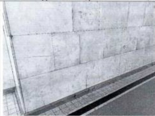
Фото 35. Перронный зал (фото от 12.05.2022).
