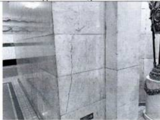
Фото 36. Перронный зал (фото от 12.05.2022).
