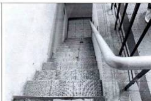
Фото 20. Лестница (пом. 2-Н (30)) (фото от 12.05.2022).
