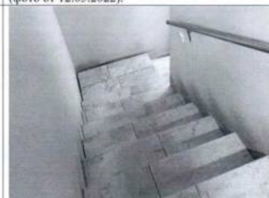
Фото 22. Лестница (пом. 3-Н (1)) (фото от 12.05.2022).
