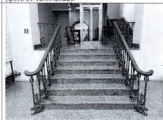
Фото 24. Лестница (пом. 2ЛК (2)) (фото от 12.05.2022).
