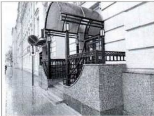
Фото 7. Крыльцо со стороны северо-восточного фасада (фото от 12.05.2022).
