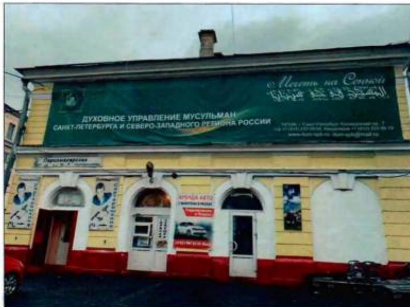
10. Южный фасад части объекта культурного наследия.
