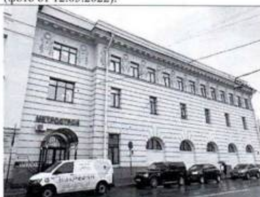
Фото 4. Северо-восточный фасад (фото от 12.05.2022).
