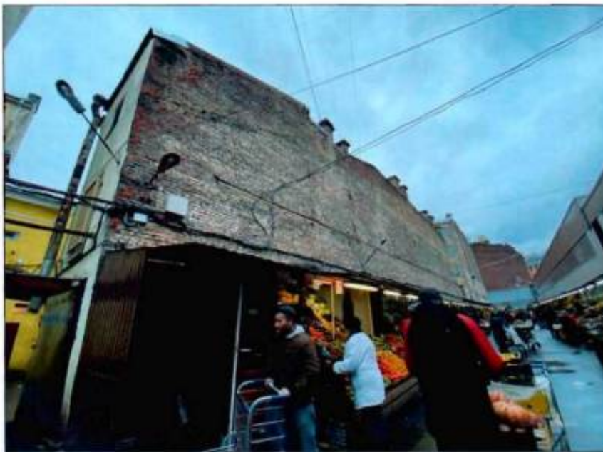
15. Северо-восточный фасад части объекта культурного наследия.
