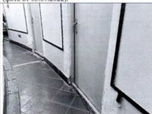
Фото 46. Помещение подвала (2-Н (64)) (фото от 05.09.2022).
