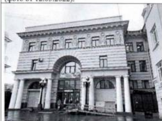
Фото 5. Юго-восточный фасад (фото от 12.05.2022).
