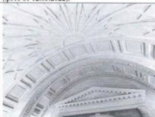
Фото 52. Помещение эскалаторного зала (пом. 2-Н (31) (фото от 12.05.2022).
