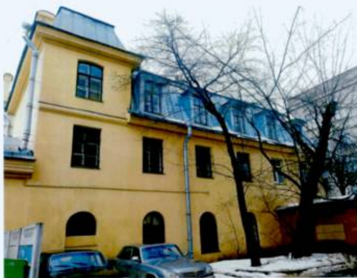
2. Общий вид. Восточный фасад объекта культурного наследия.
