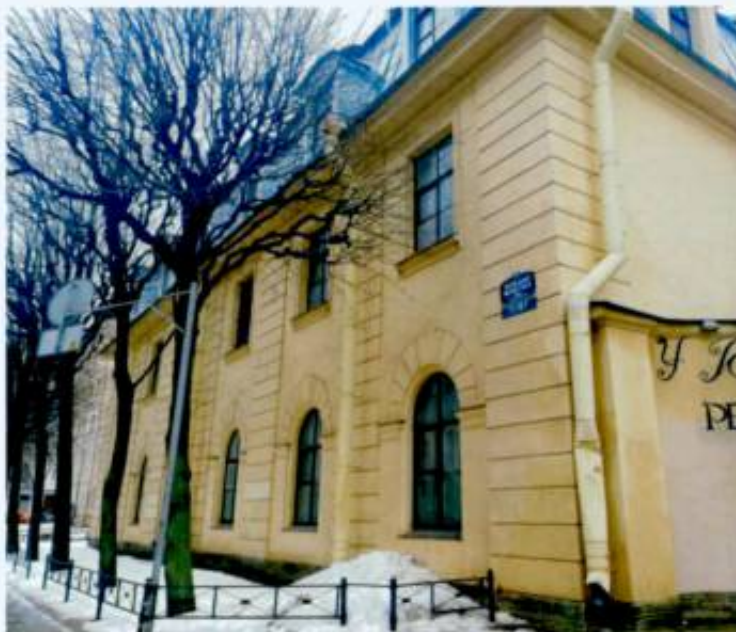
1. Общий вид. Северный фасад объекта культурного наследия.
