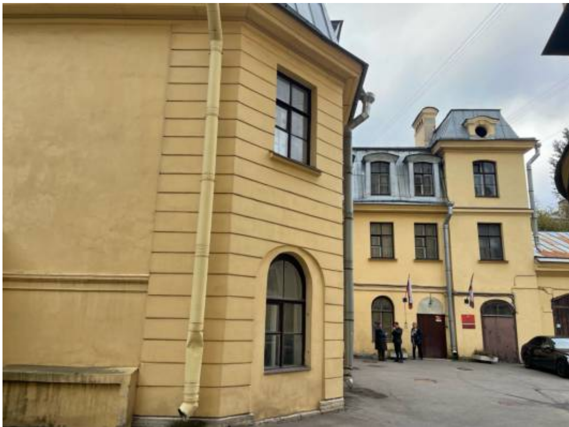
4. Вид на западные фасады со стороны двора
