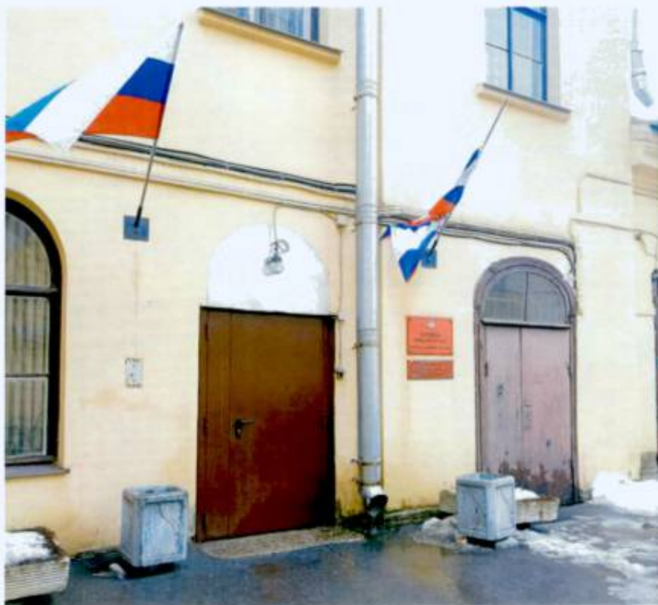
5. Фрагмент. Западный фасад объекта культурного наследия.
