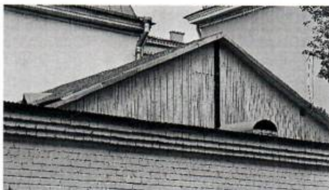
4. Фрагмент крыши здания (с южной стороны)
