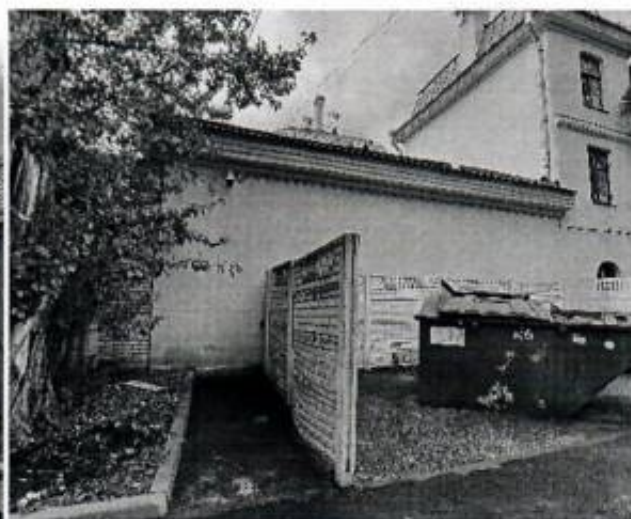
2. Фрагмент восточного фасада
