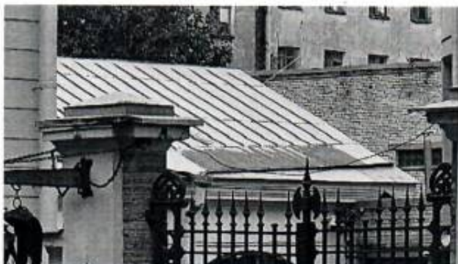
3. Фрагмент крыши здания
