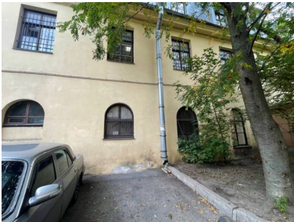
8. Вид на западные фасады напротив дома №19А
