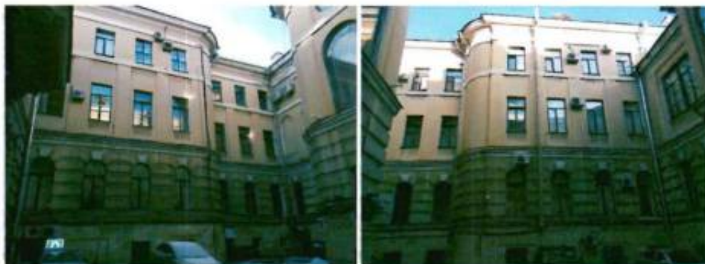
11, 12. Северный двор. Северный и южный фасад
