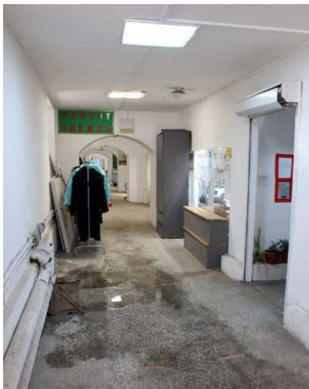
Рис. 1. Общий вид на помещение 0.12
