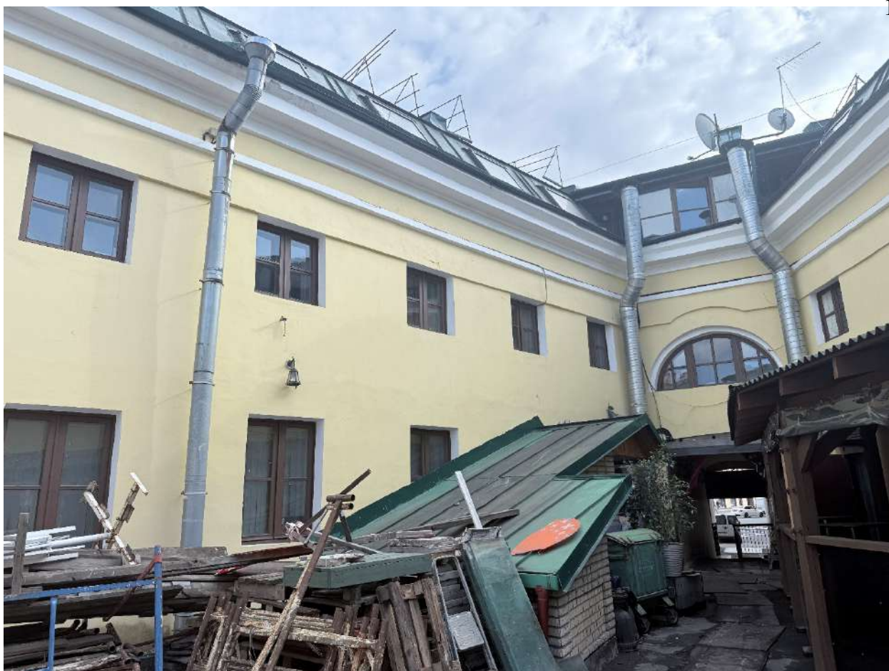
Рис. 120. Общий вид на дворовые фасады объекта.
