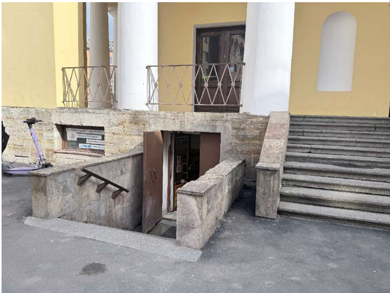
Рис. 84. Общий вид на часть объекта со стороны пересечения Разъезжей ул. и Боровой ул.
