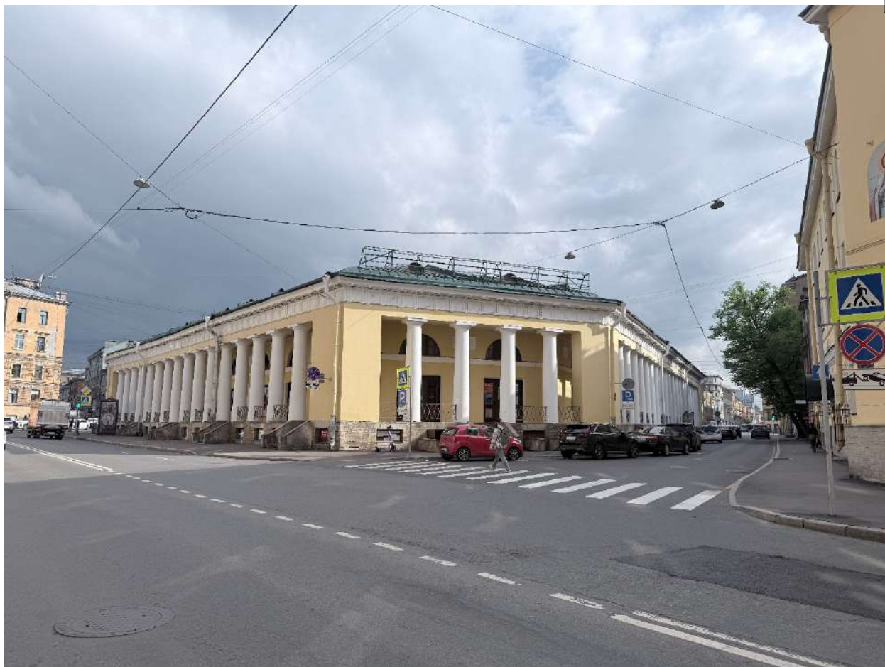
Рис. 80. Общий вид на лицевые фасады со стороны пересечения Разъезжей ул. и Боровой ул.
