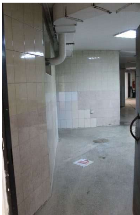
Рис. 26. Помещение 0.15. Вид на помещение 0.38
