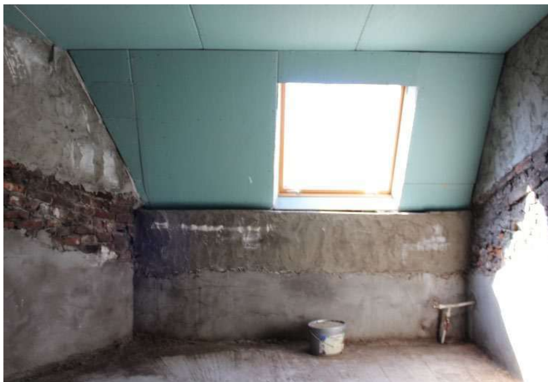
Рис. 74. Вид на помещение 3.170
