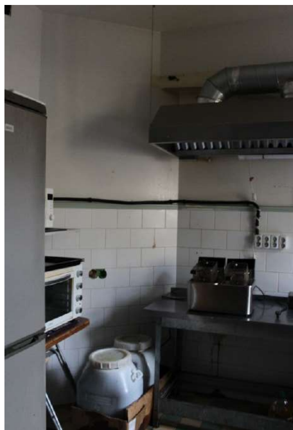
Рис. 32. Помещение 1.81. Вид на стену по оси 7
