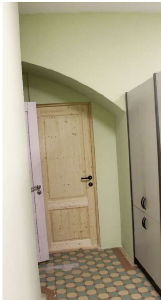
Рис. 36. Помещение 1.90. Вид на стену по оси 10'
