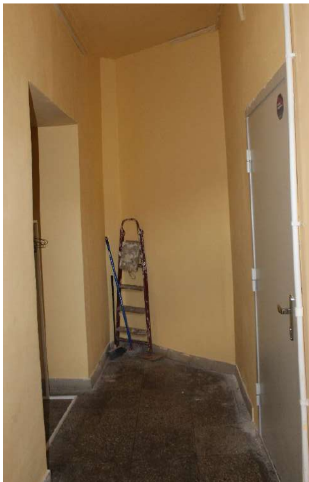
Рис. 35. Вид на помещение 1.95
