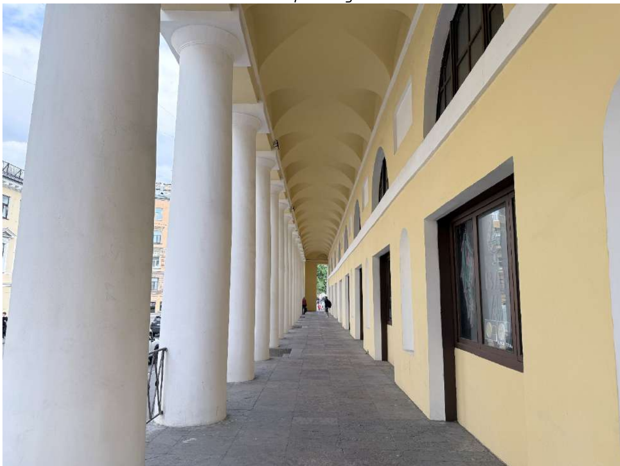
Рис. 111. Общий вид на галерею со стороны Разъезжей ул.
