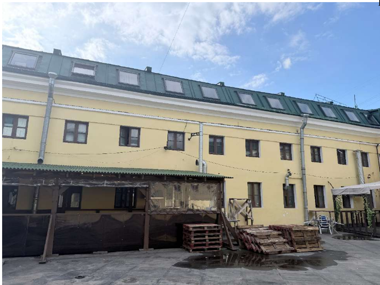
Рис. 118. Общий вид на дворовые фасады объекта.
