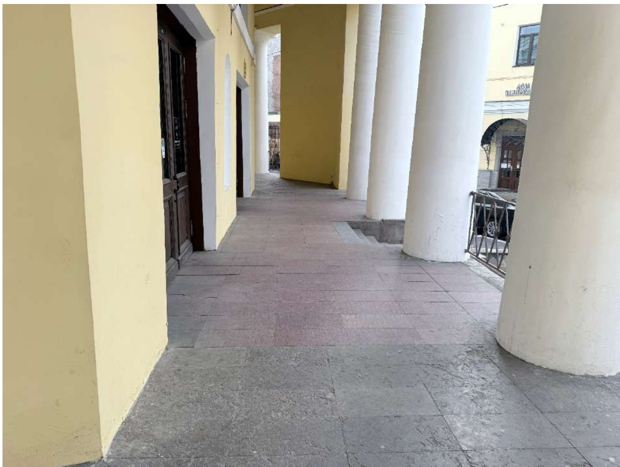
Рис. 110. Общий вид на часть галереи со стороны пересечения Разъезжей ул. и Боровой ул.
