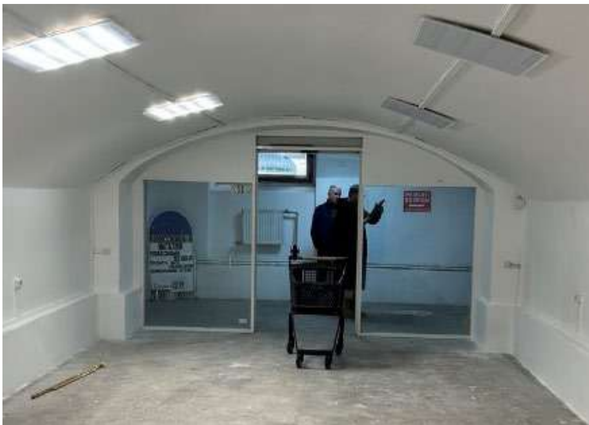
Рис. 16. Помещение 0.22. Вид на стену по оси 14
