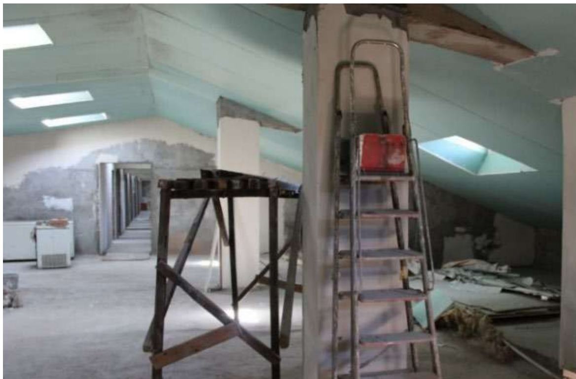
Рис. 68. Общий вид на помещение 3.179
