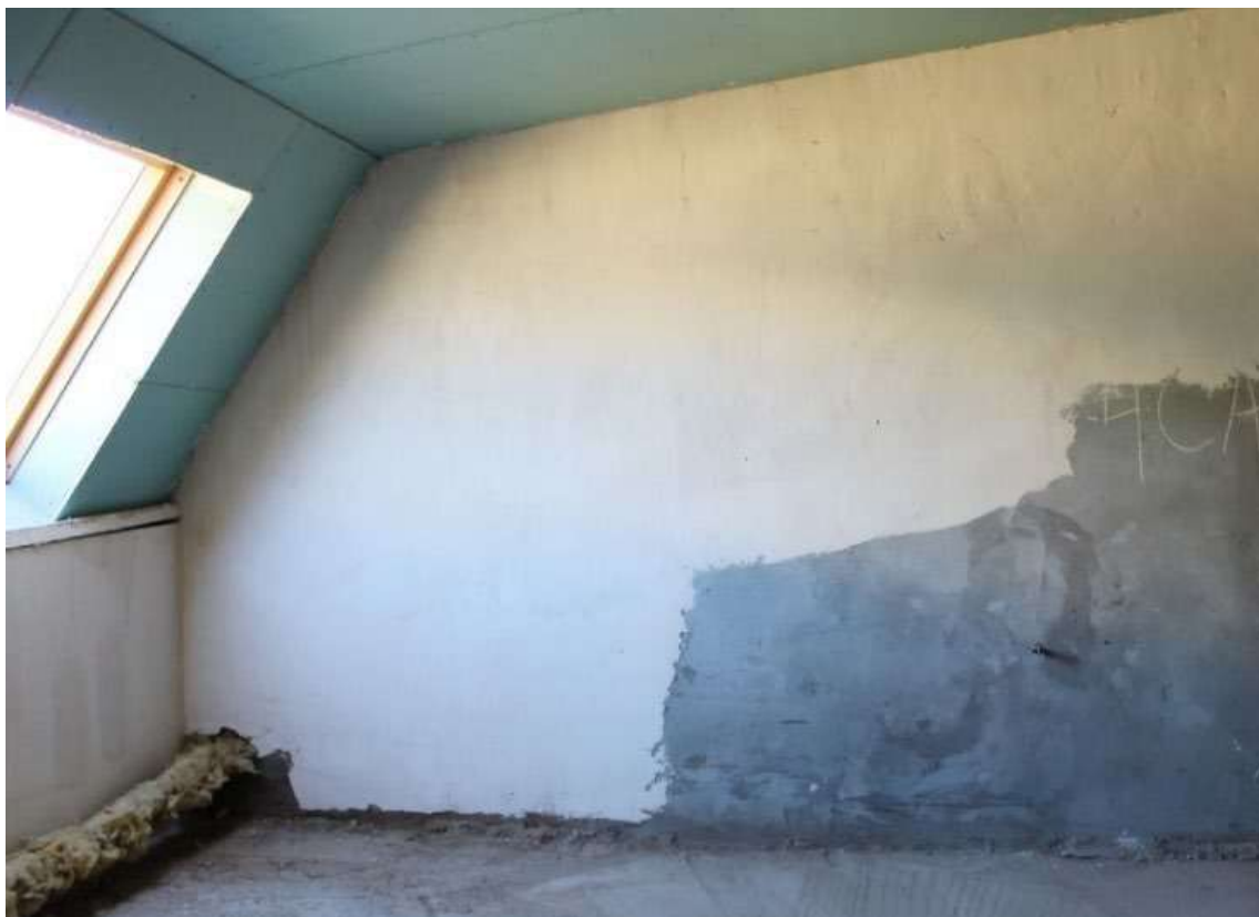
Рис. 71. Вид на помещение 3.175.1
