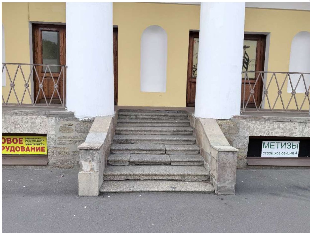
Рис. 94. Общий вид на лестницу со стороны Марата ул.
