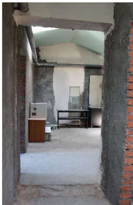
Рис. 70. Вид на помещение 3.172
