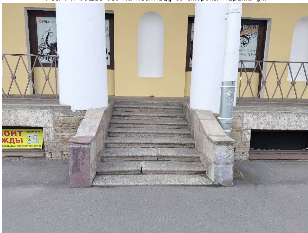
Рис. 95. Общий вид на лестницу со стороны Марата ул.
