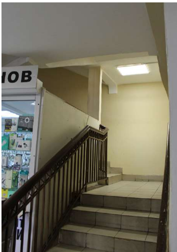
Рис. 21. Вид на лестницу Л-3
