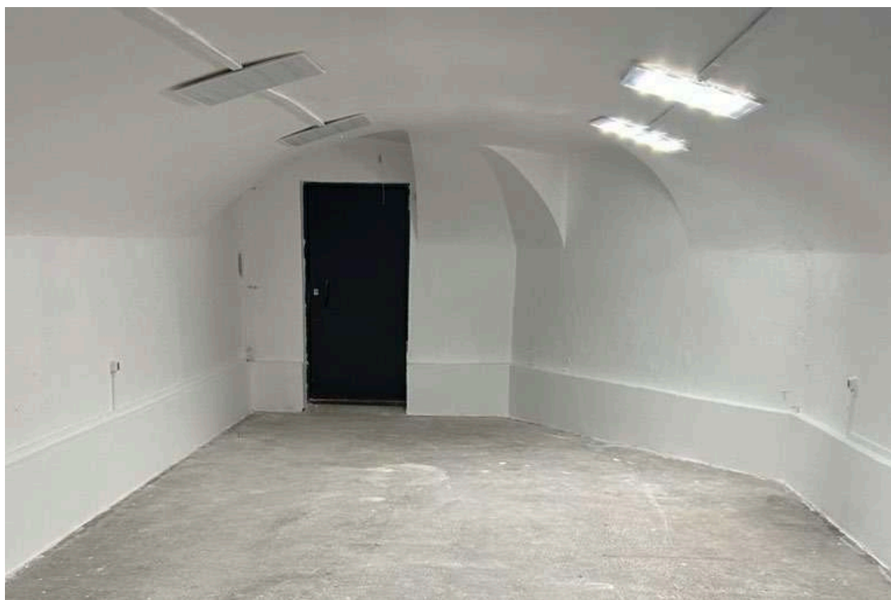
Рис. 15. Помещение 0.22. Вид на стену по оси 12
