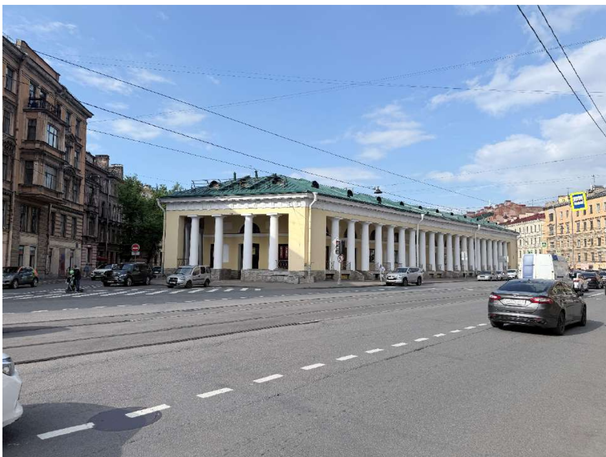
Рис. 75. Общий вид на лицевые фасады со стороны пересечения Марата ул. и Боровой ул.
