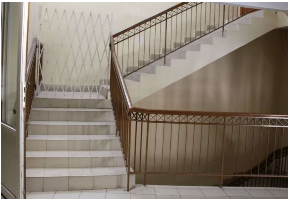
Рис. 62. Помещение 2.124. Вид на лестничный марш Л-4
