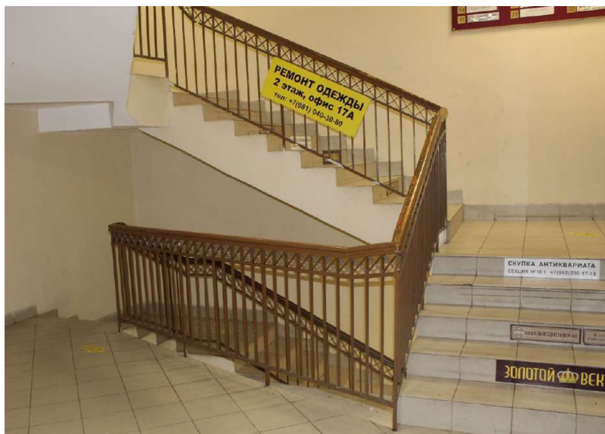
Рис. 48. Помещение 1.47. Вид на лестницу Л-3
