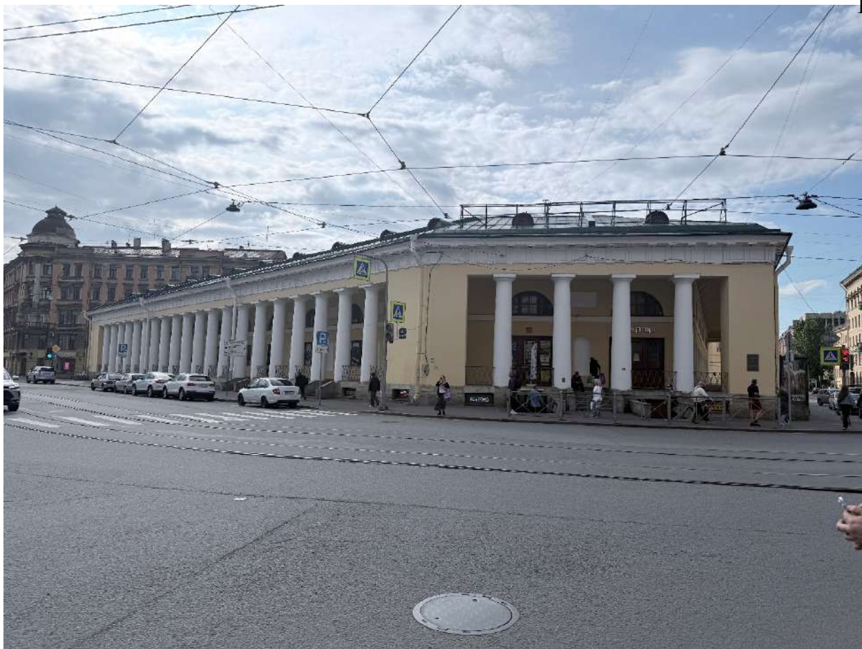
Рис. 76. Общий вид на лицевые фасады со стороны Разъезжей ул.
