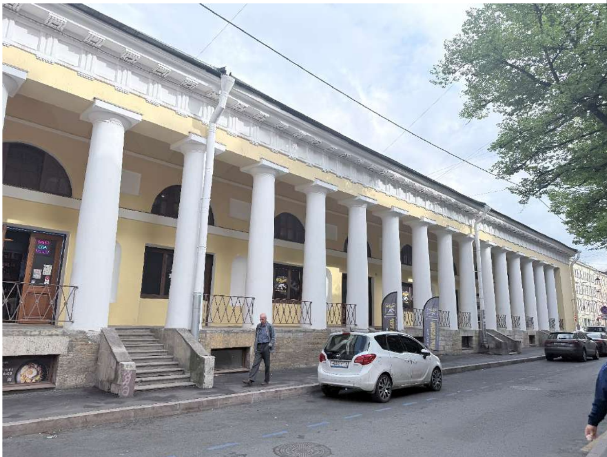
Рис. 82. Общий вид на часть лицевого фасада со стороны Боровой ул.
