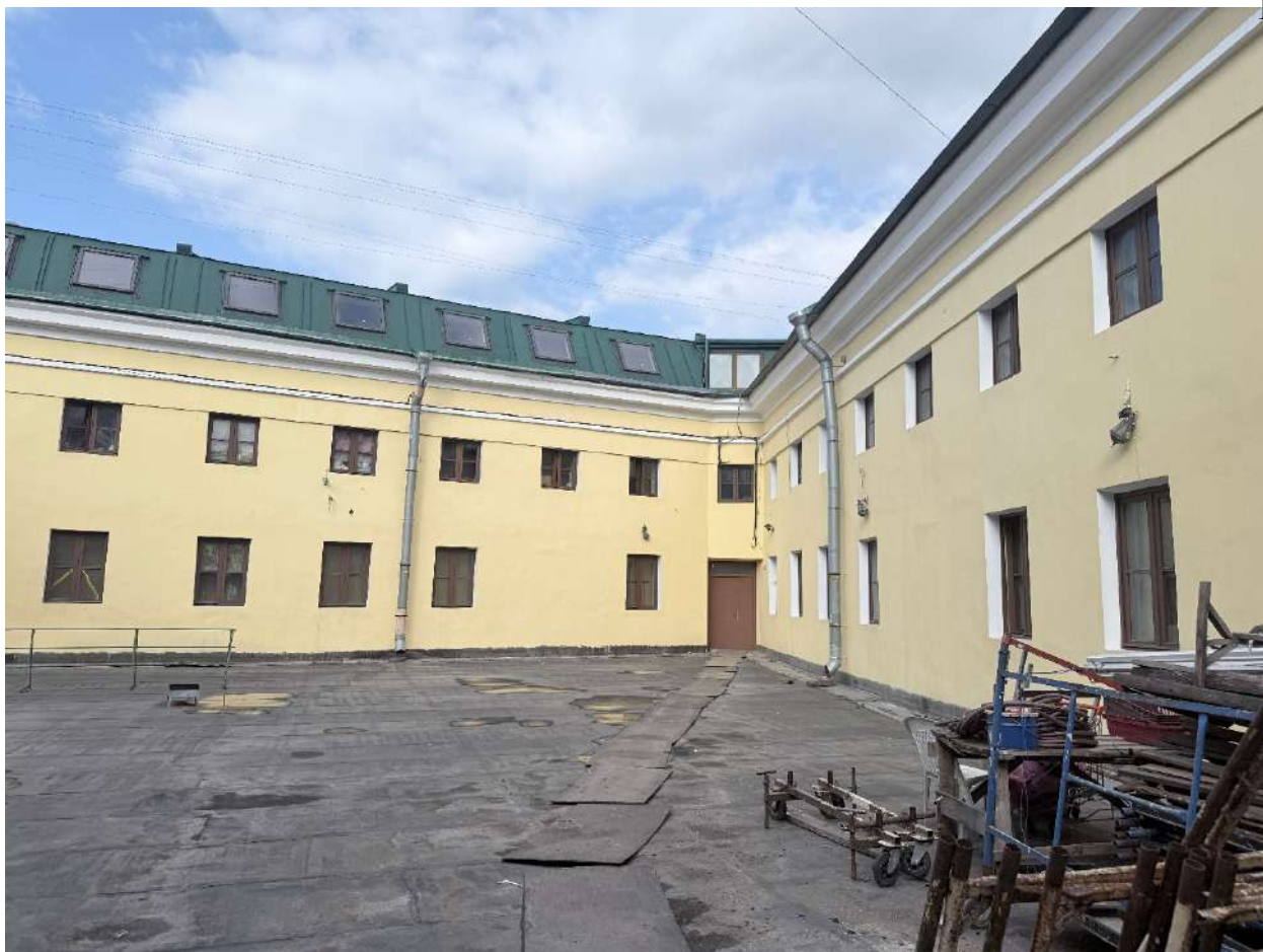
Рис. 116. Общий вид на дворовые фасады объекта.
