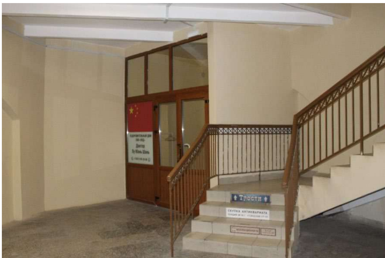
Рис. 34. Помещение 1.94. Вид на дверной проем в помещение 1.93
