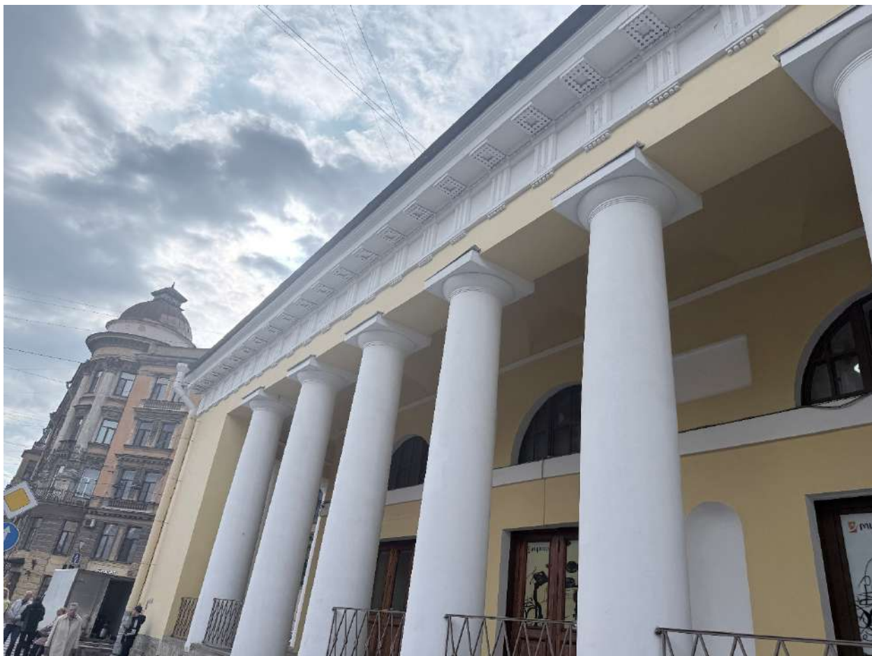
Рис. 106. Общий вид на часть лицевого фасада со стороны Марата ул.
