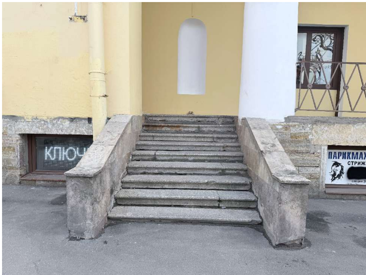
Рис. 101. Общий вид на лестницу со стороны Разъезжей ул.
