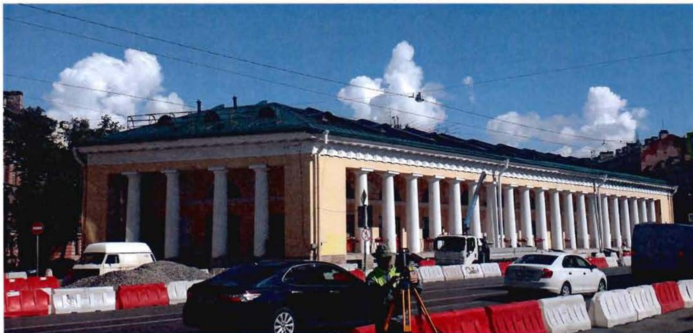
1. Юго-восточный фасад здания
