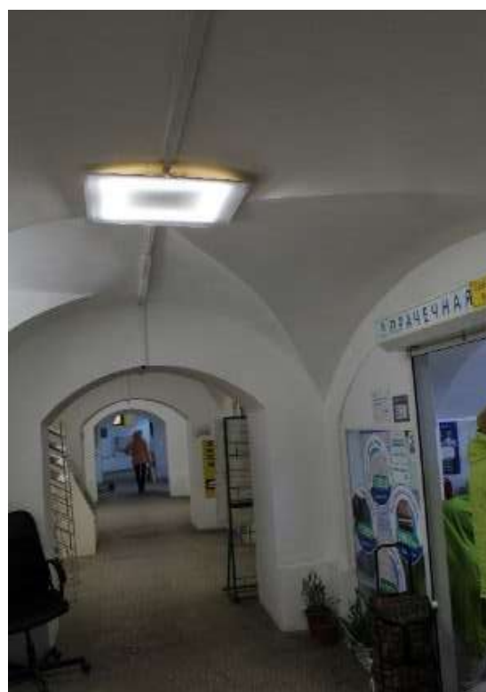
Рис. 6. Помещение 0.12. Арочный проем по оси 8
