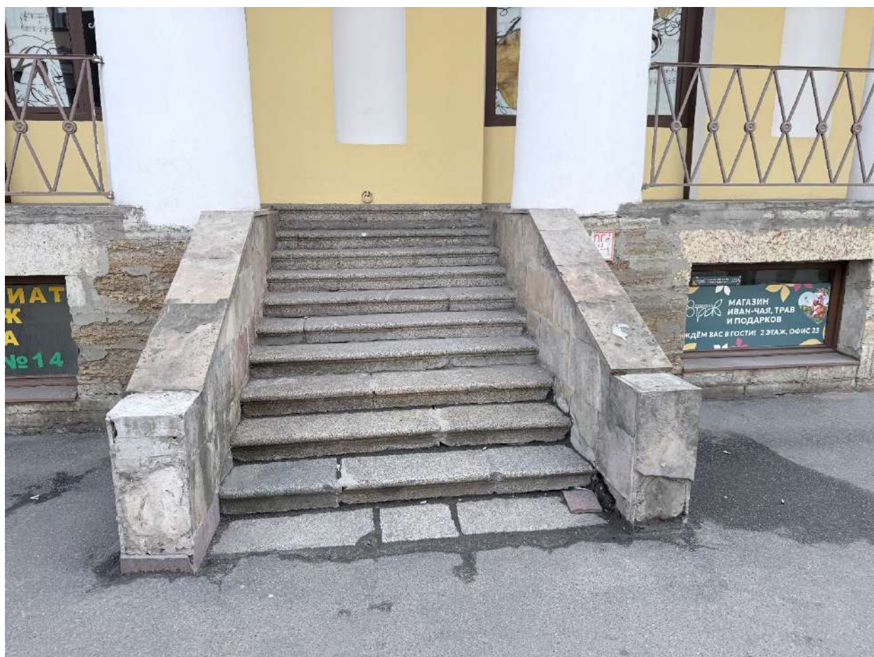
Рис. 103. Общий вид на лестницу со стороны Разъезжей ул.
