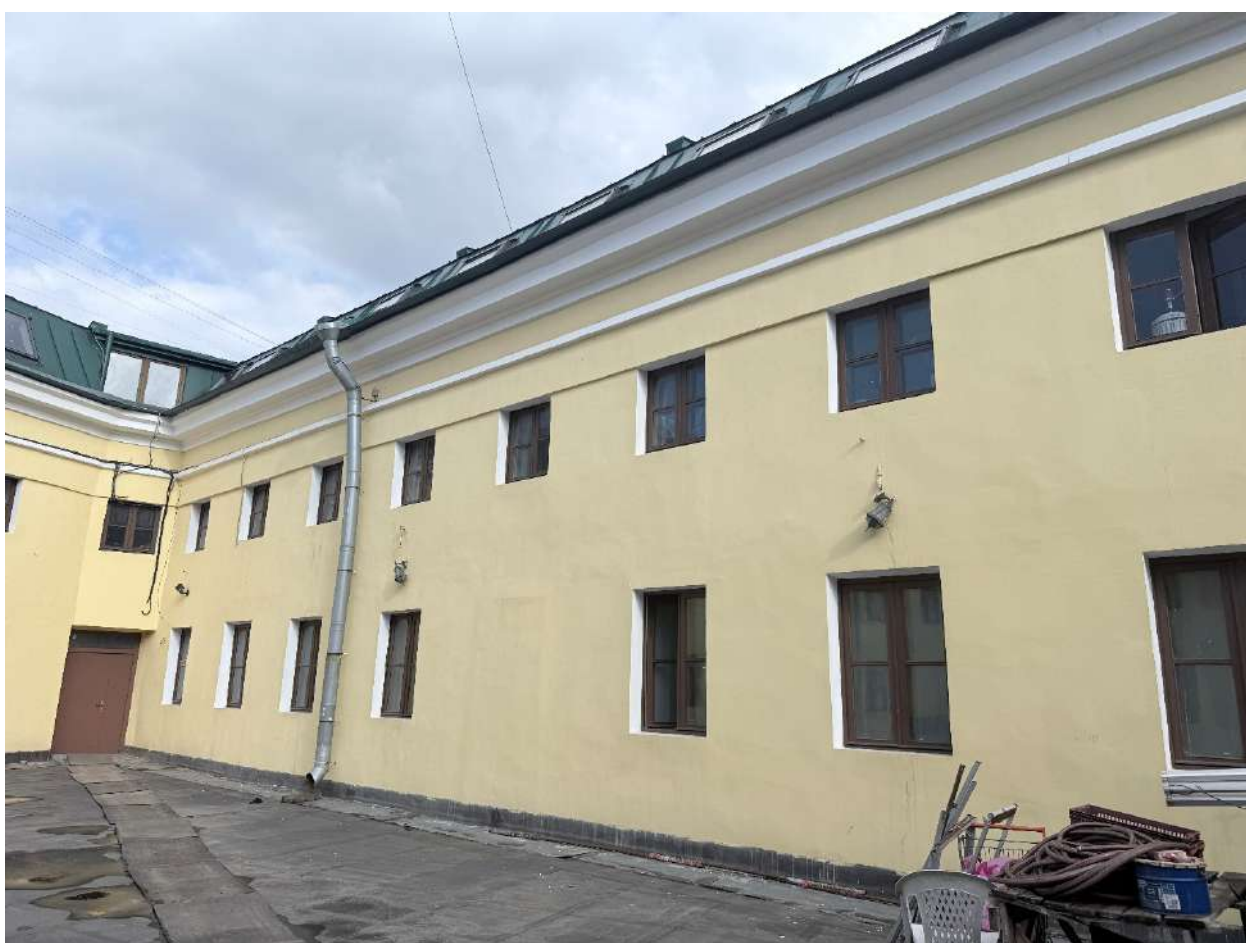
Рис. 121. Общий вид на дворовые фасады объекта.
