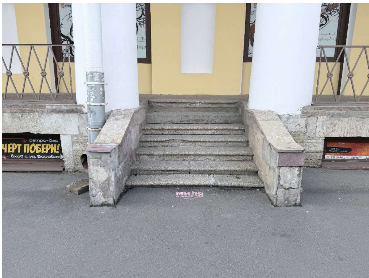
Рис. 97. Общий вид на лестницу со стороны Марата ул.
