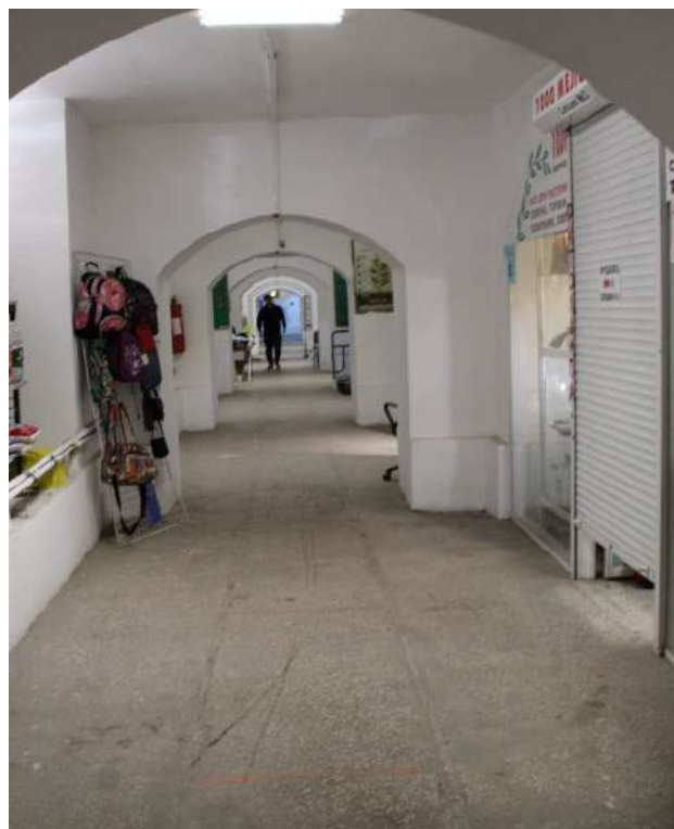
Рис. 2. Вид на помещение 0.12 через арочный проем по оси 4
