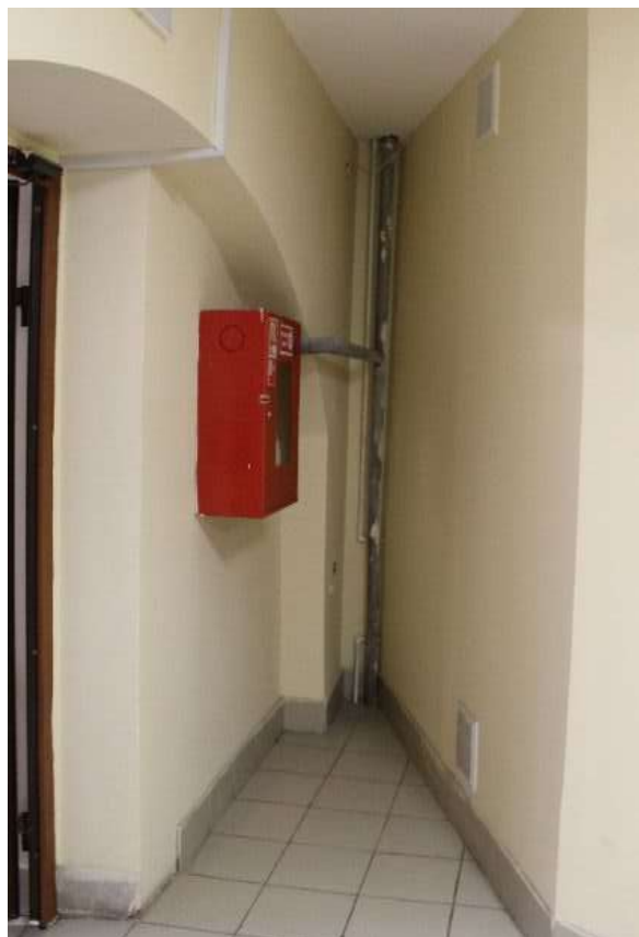
Рис. 55. Помещение 2.111. Вид на пересечение стен по оси 3' и И
