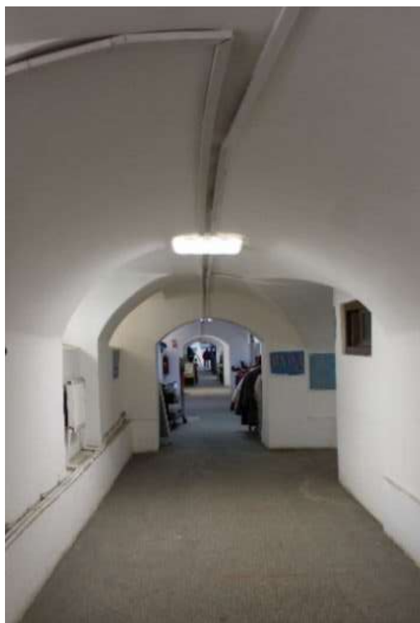
Рис. 11. Помещение 0.12. Фрагмент в осях 14-15
