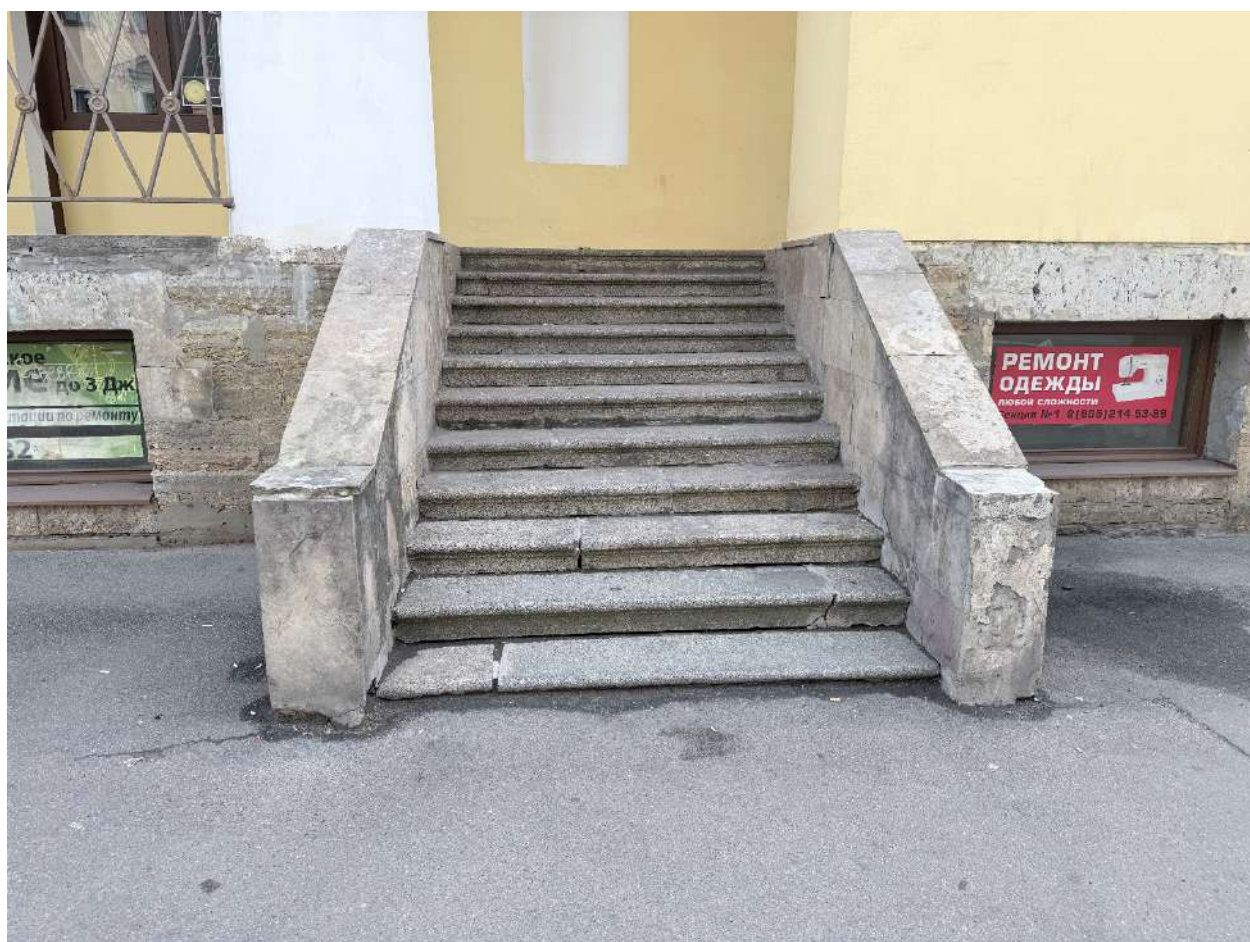
Рис. 105. Общий вид на лестницу со стороны Разъезжей ул.
