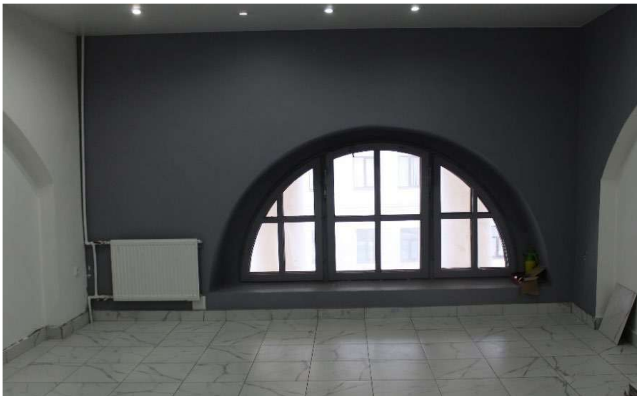
Рис. 64. Общий вид на помещение 2.131
