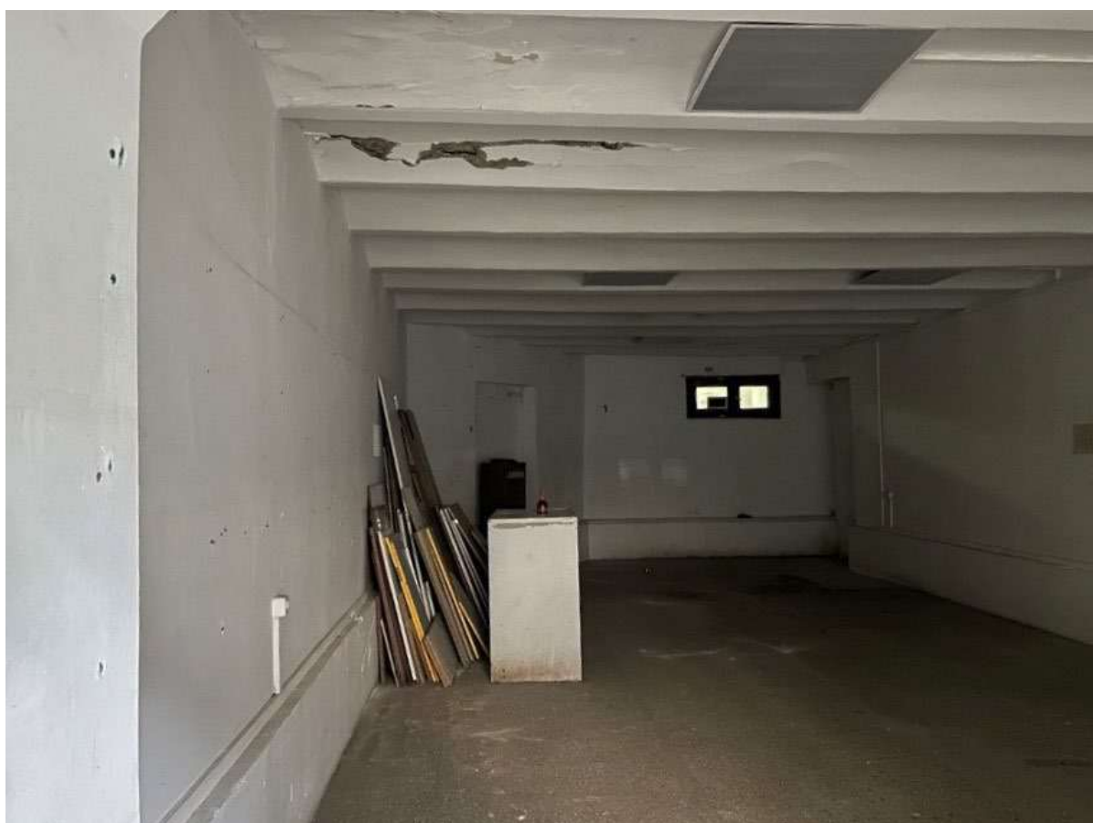
Рис. 17. Вид на помещение 0.17
