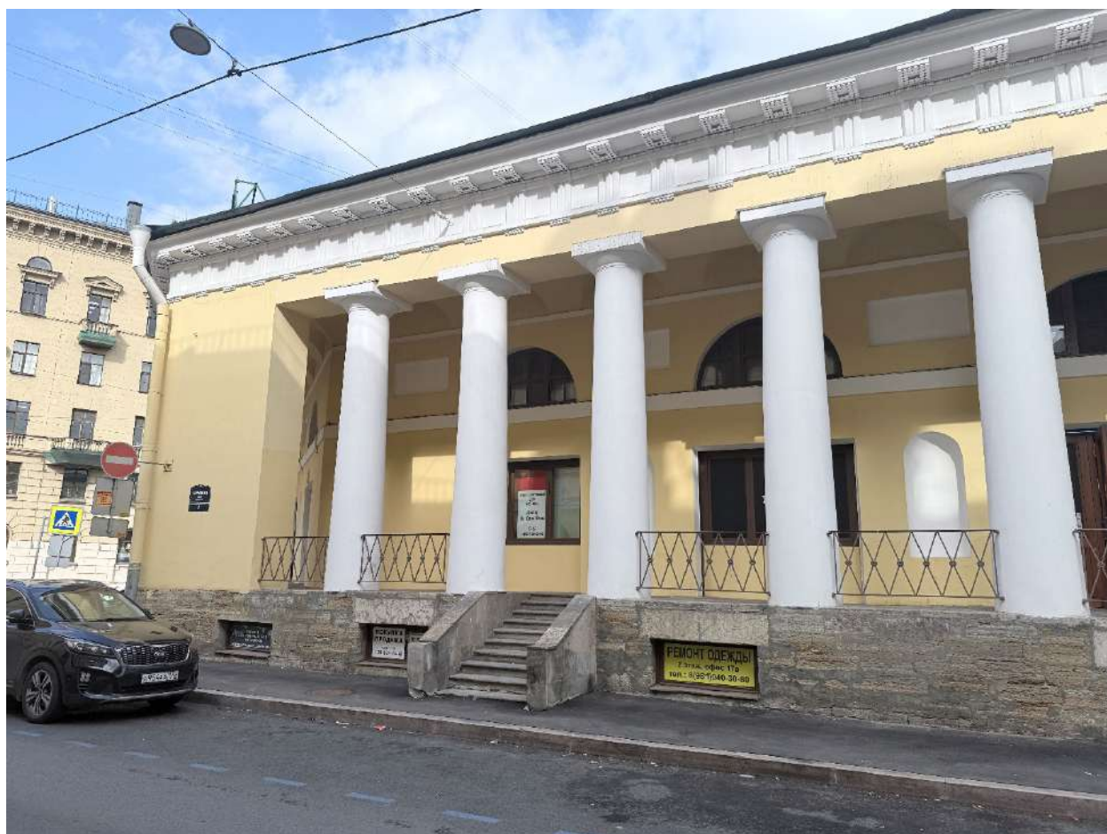
Рис. 81. Общий вид на часть лицевого фасада со стороны Боровой ул.
