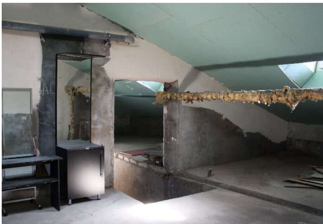
Рис. 72. Помещение 3.172. Вид на лестницу Л-6
