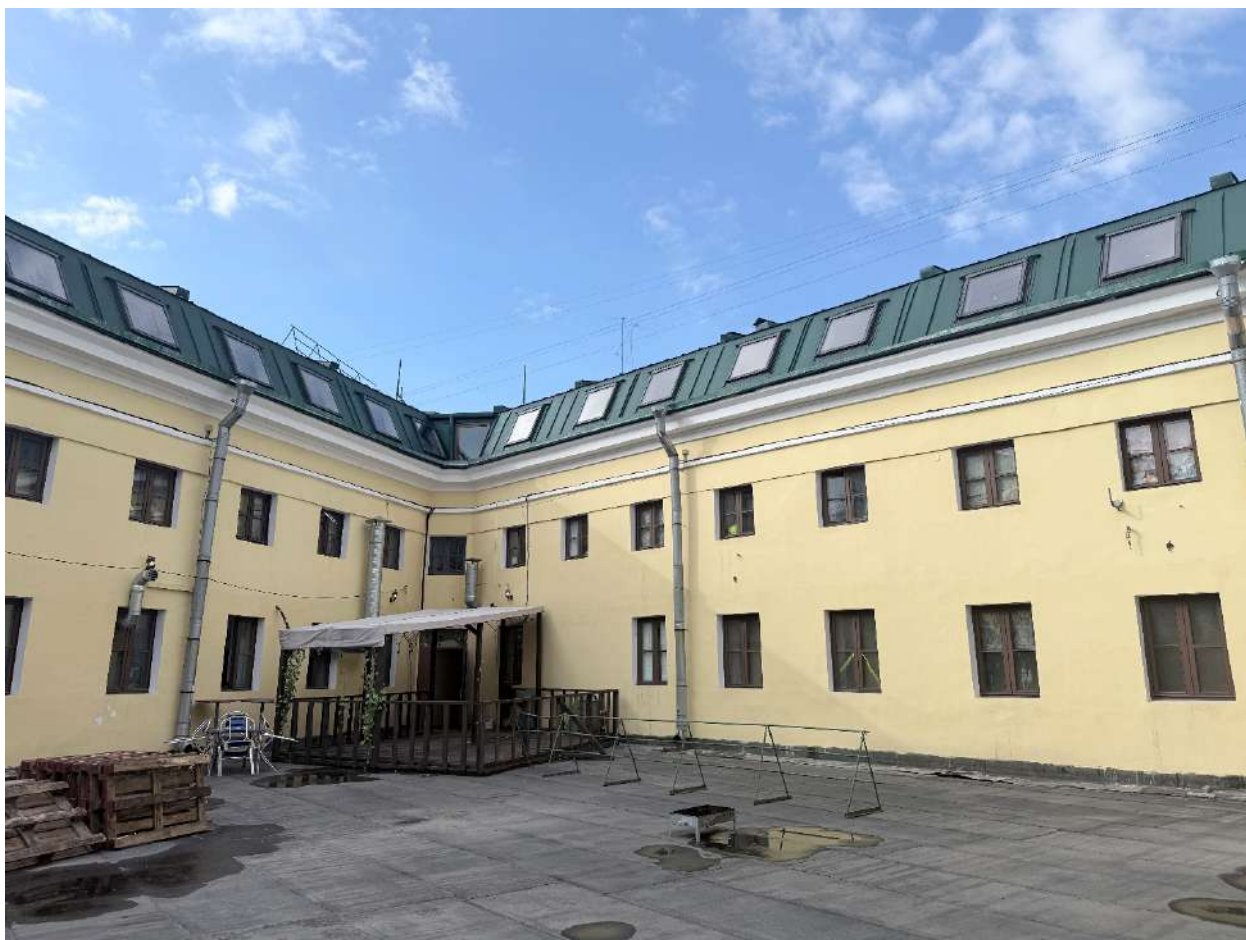
Рис. 117. Общий вид на дворовые фасады объекта.
