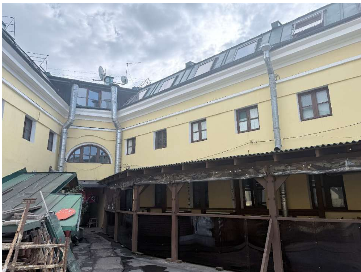
Рис. 119. Общий вид на дворовые фасады объекта.
