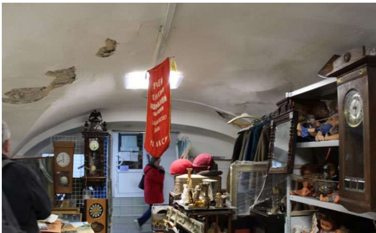
Рис. 19. Вид на помещение 0.24
