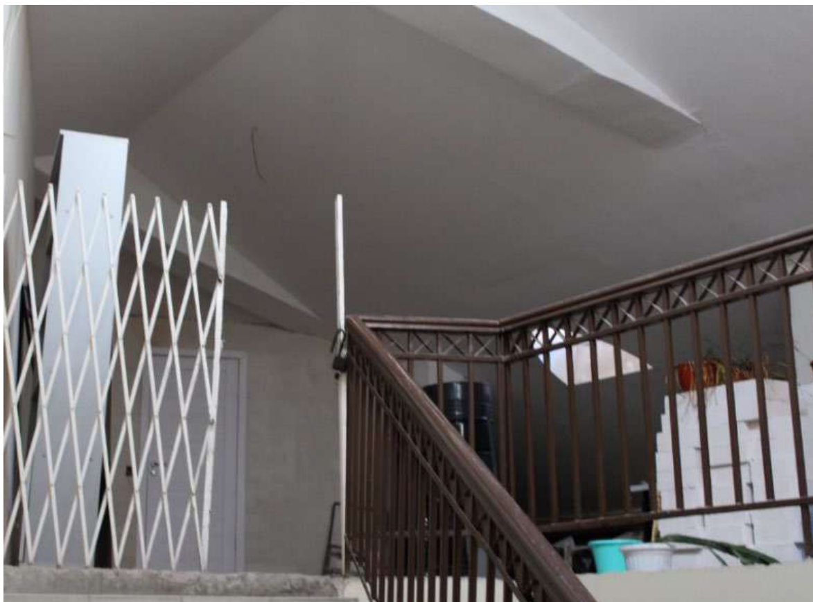
Рис. 66. Общий вид на помещение 3.152 с лестницы Л-1
