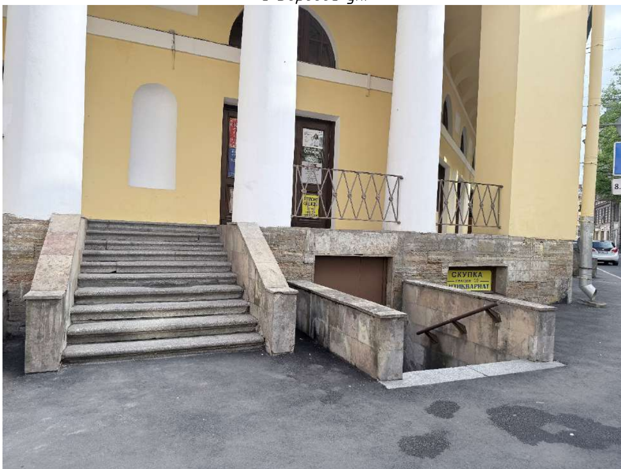
Рис. 85. Общий вид на часть объекта со стороны пересечения Разъезжей ул. и Боровой ул.
