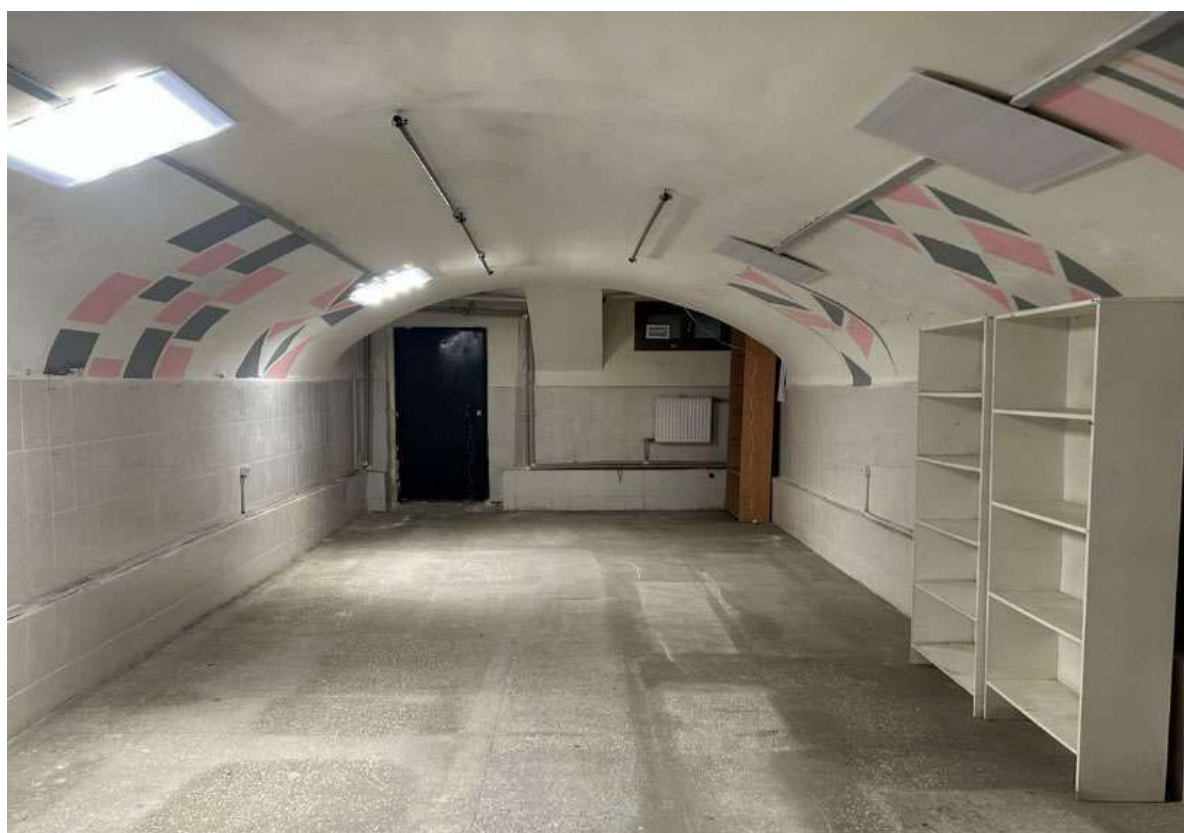
Рис. 9. Помещение 0.27. Общий вид в осях 8'-9'
