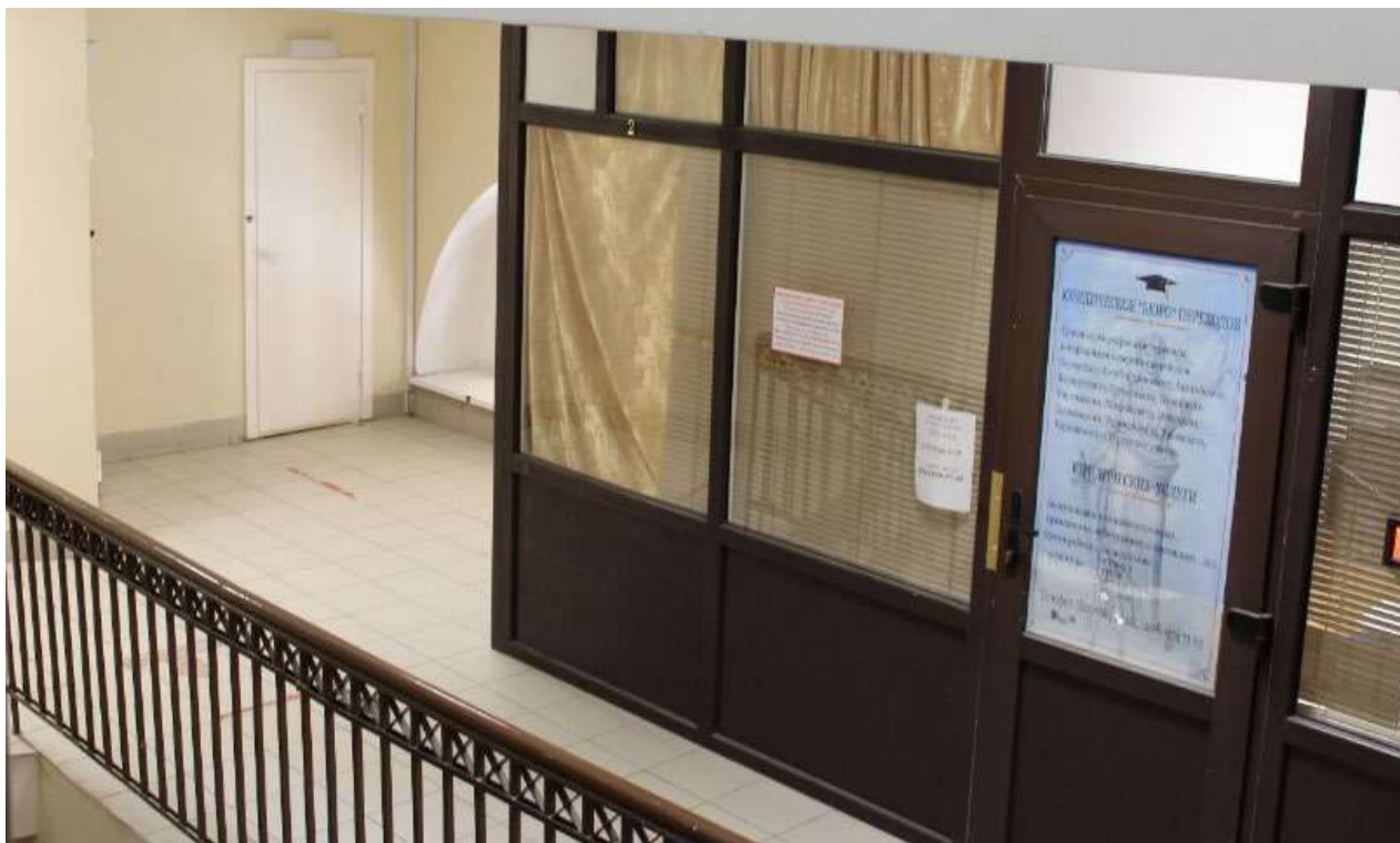
Рис. 53. Общий вид на помещение 2.107 с лестницы Л-1
