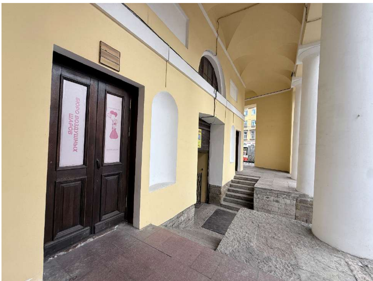
Рис. 115. Общий вид на часть лицевого фасада со стороны пересечения Боровой ул. и Марата ул.
