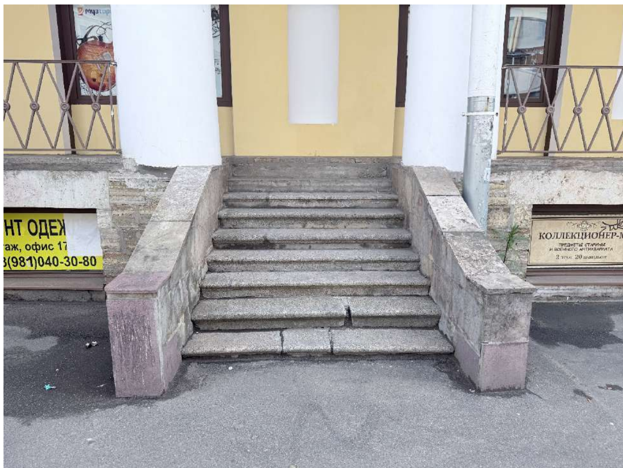
Рис. 102. Общий вид на лестницу со стороны Разъезжей ул.
