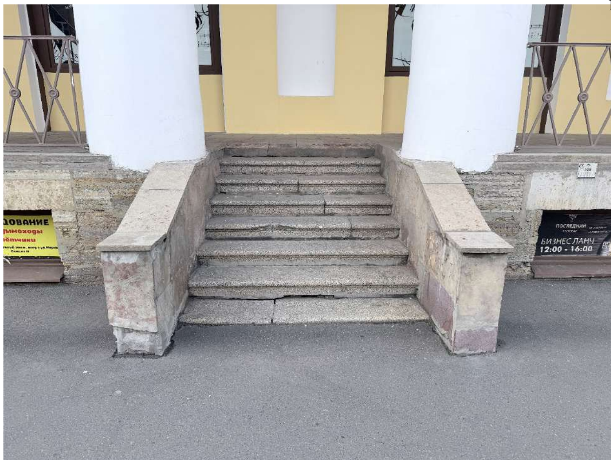
Рис. 96. Общий вид на лестницу со стороны Марата ул.
