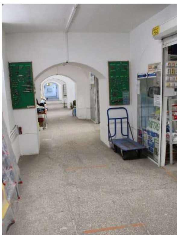
Рис. 5. Помещение 0.12. Арочный проем по оси 6
