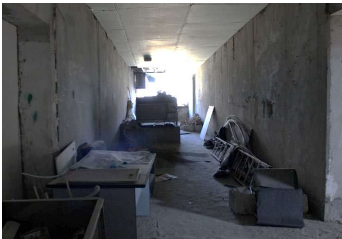
Рис. 67. Общий вид на помещение 3.180
