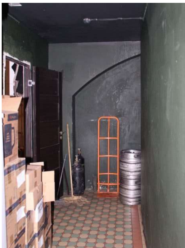
Рис. 31. Помещение 1.80. Вид на заложённый арочный проем по оси 7'
