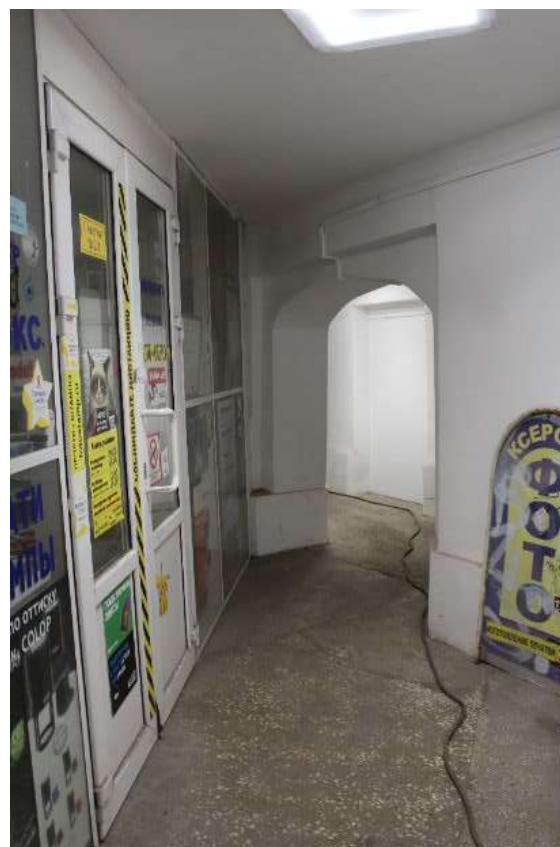
Рис. 14. Помещение 0.12. Фрагмент в осях 12-13
