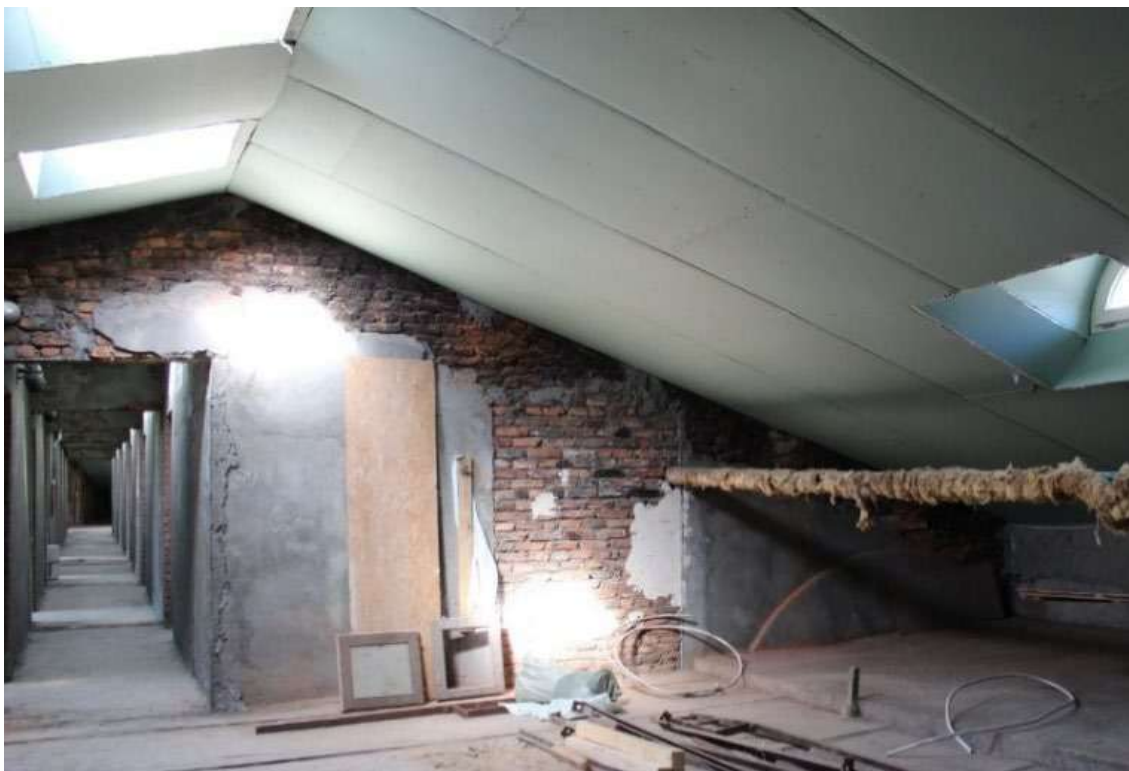
Рис. 73. Помещение 3.171. Вид на пересечение стен по осям В' и 15
