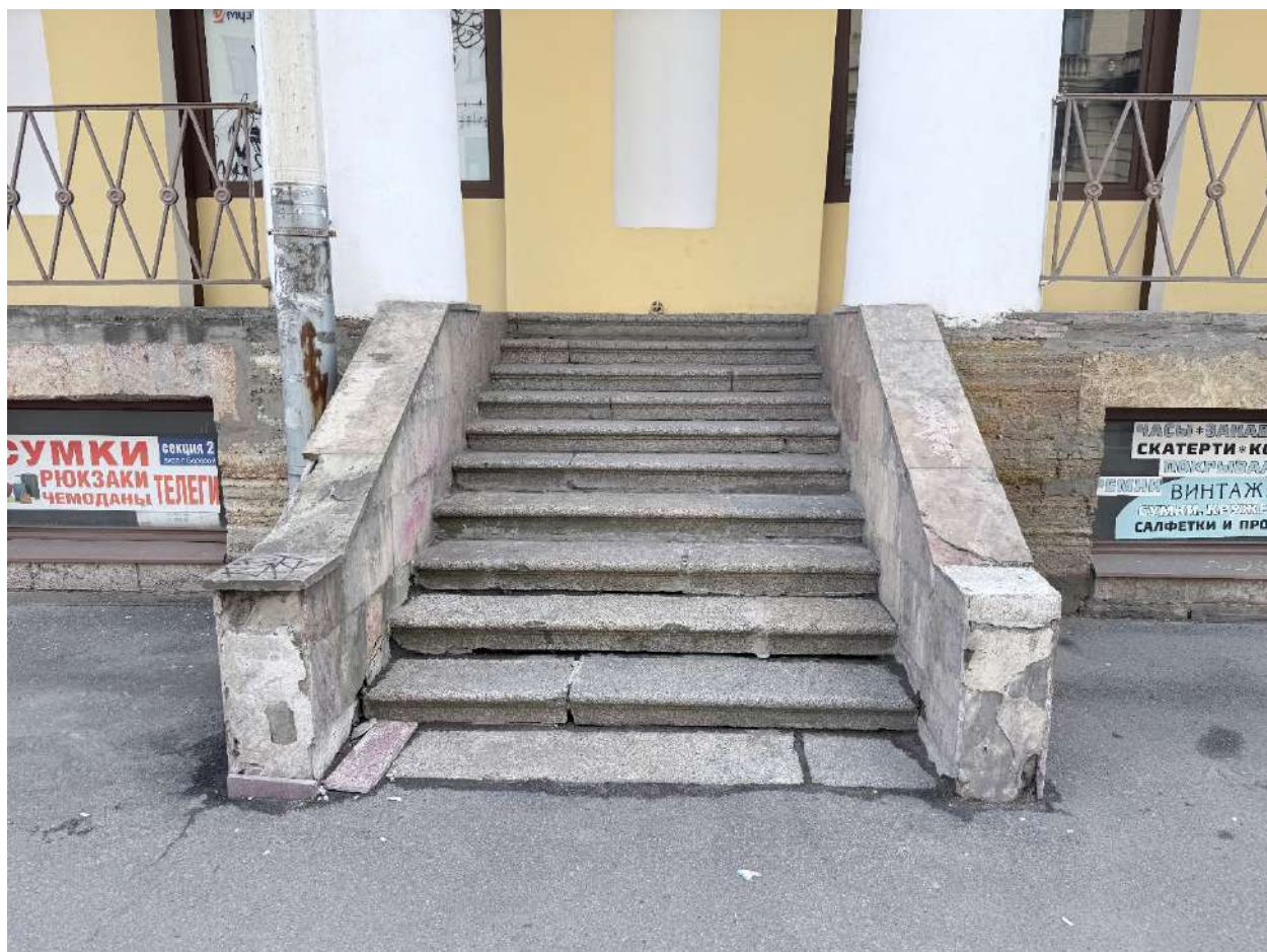
Рис. 104. Общий вид на лестницу со стороны Разъезжей ул.
