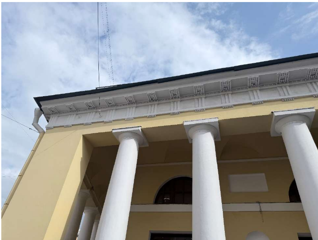
Рис. 83. Общий вид на часть объекта со стороны пересечения Разъезжей ул. и Боровой ул.
