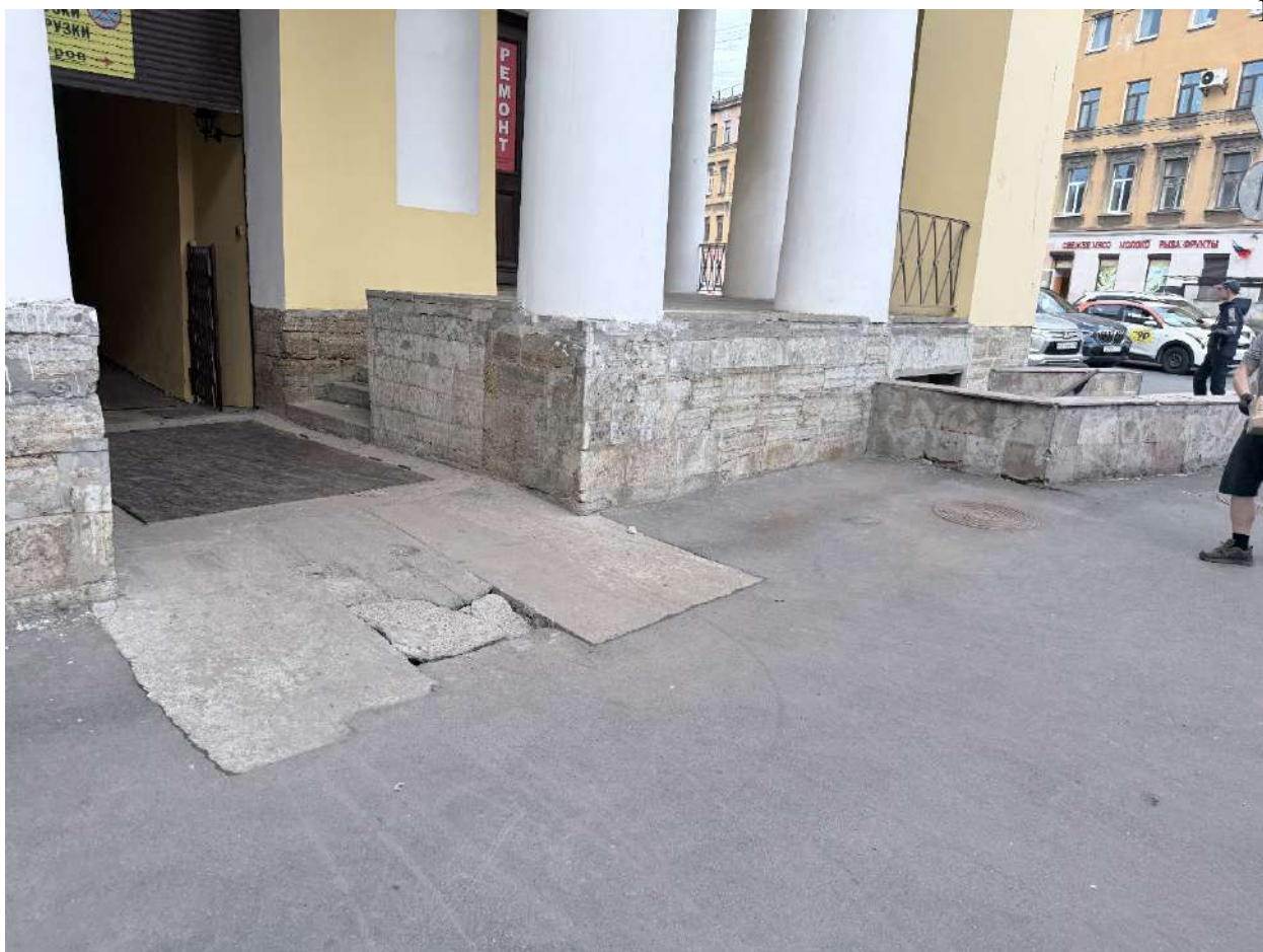
Рис. 92. Общий вид на часть фасада со стороны пересечения Боровой ул. и Марата ул.
