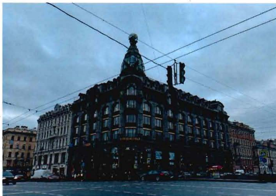
1. Общий вид на объект культурного наследия.
