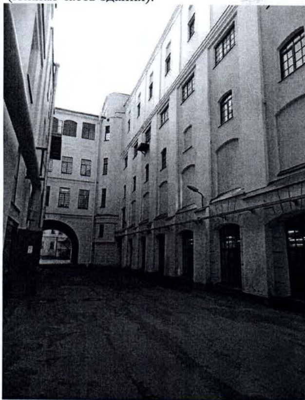
3. Фрагмент восточного дворового фасада (южная часть здания).
