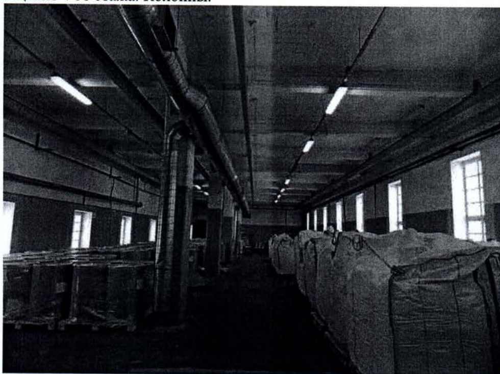
5. Помещение 4-го этажа. Колонны.
