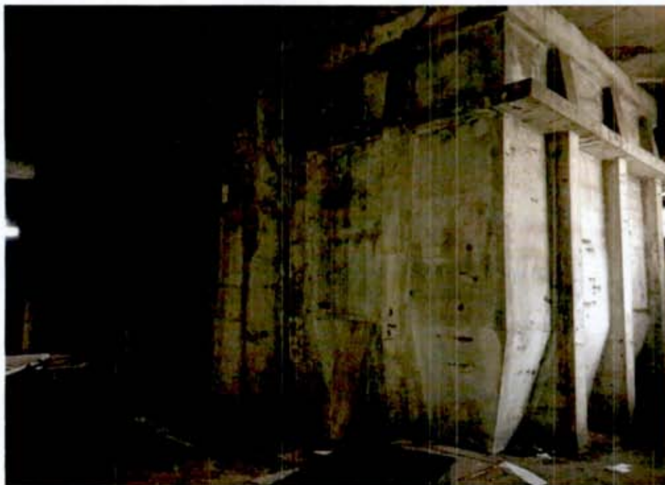
Фото 15. Железобетонный бак в бывш. отделение водоподготовки.
