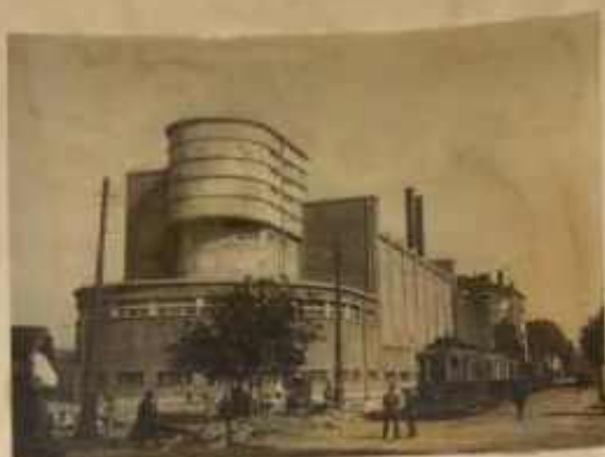
Ф А С А Д "СИЛОВОЙ СТАНЦИИ" со стороны Гребенной ул.
