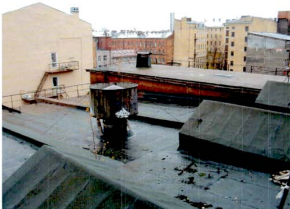
Фото 19. Кровля юго-восточной части здания.
