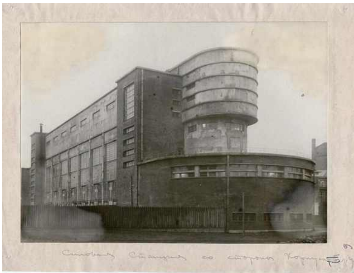
Илл. 46. Силовая станция со стороны Корпусной улицы. Конкурсная комиссия на лучшую стройку при ЛОУСК. 14.07.1929 г. Фотография к пояснительной записке по постройке Силовой станции.
