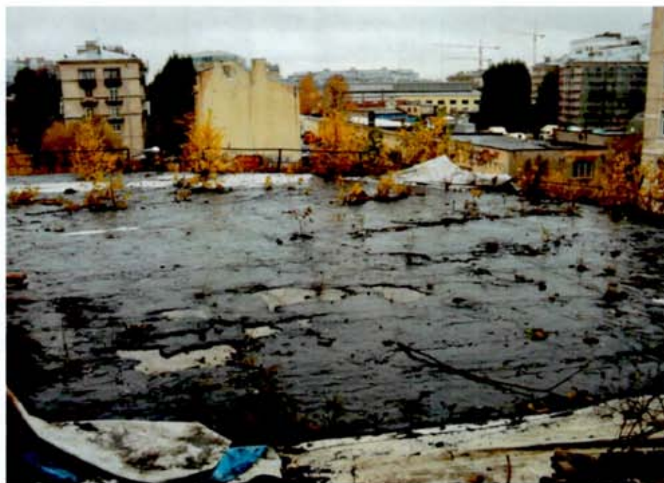
Фото 18. Кровля северо-западной части здания.
