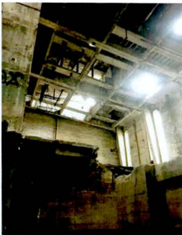
Фото 9. Бывш. котельный зал.
