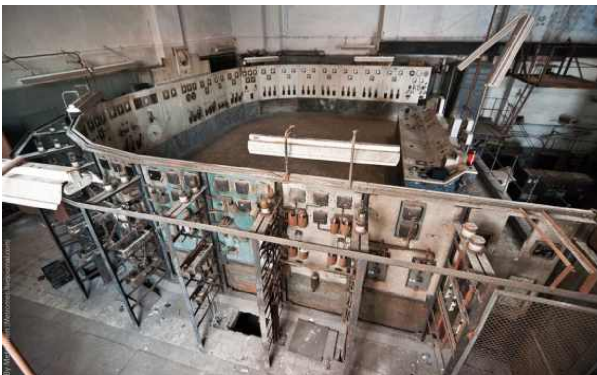
Илл. 65. Пульт управления фидерного распределительного устройства. 2012. https://metromen.livejournal.com/33898.html
