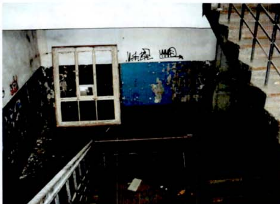
Фото 16. Центральная лестница в южной части здания.
