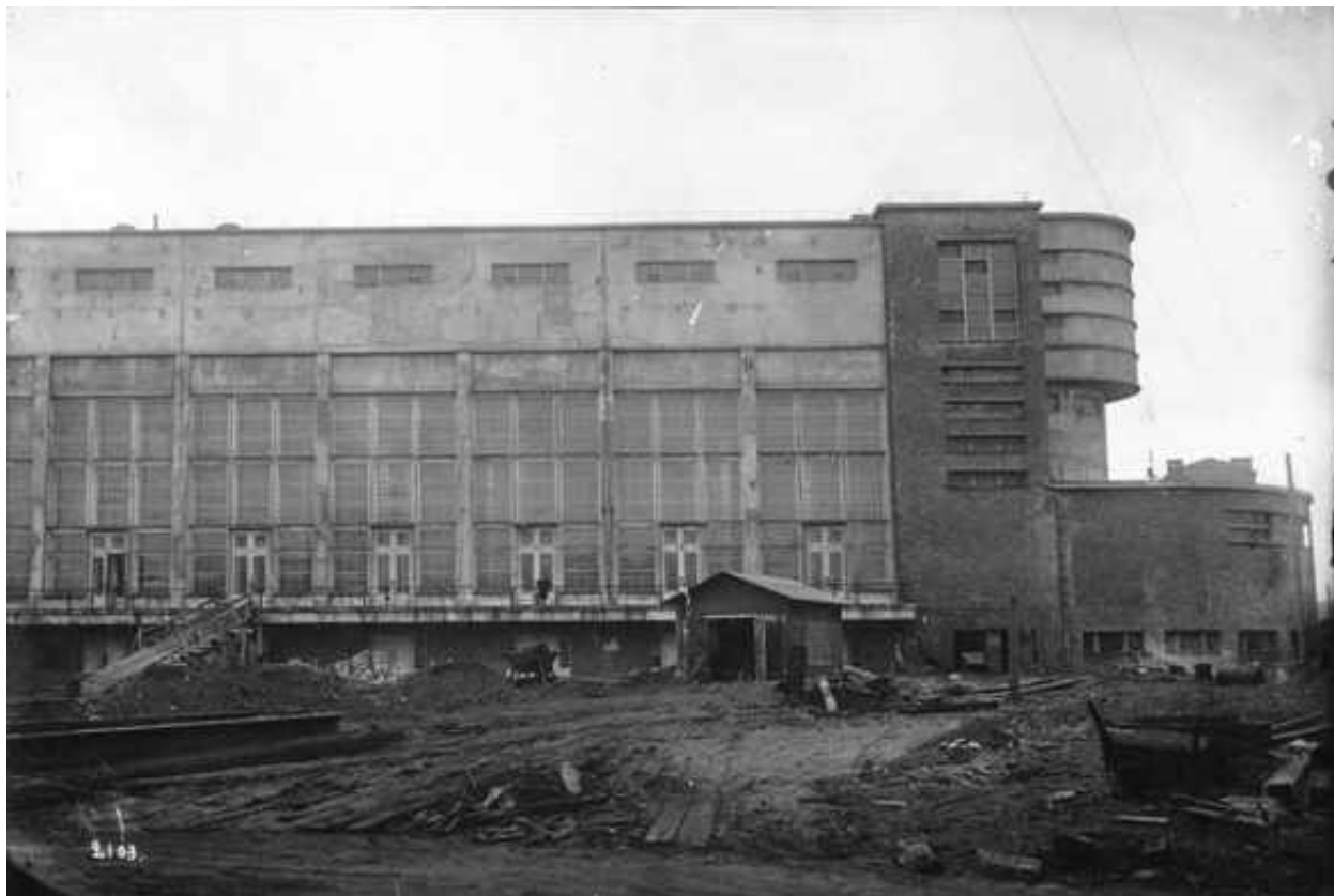
Илл. 31. Строительство станции. 1928 г. Электронный портал: http://wikimapia.org/22447319/ru
