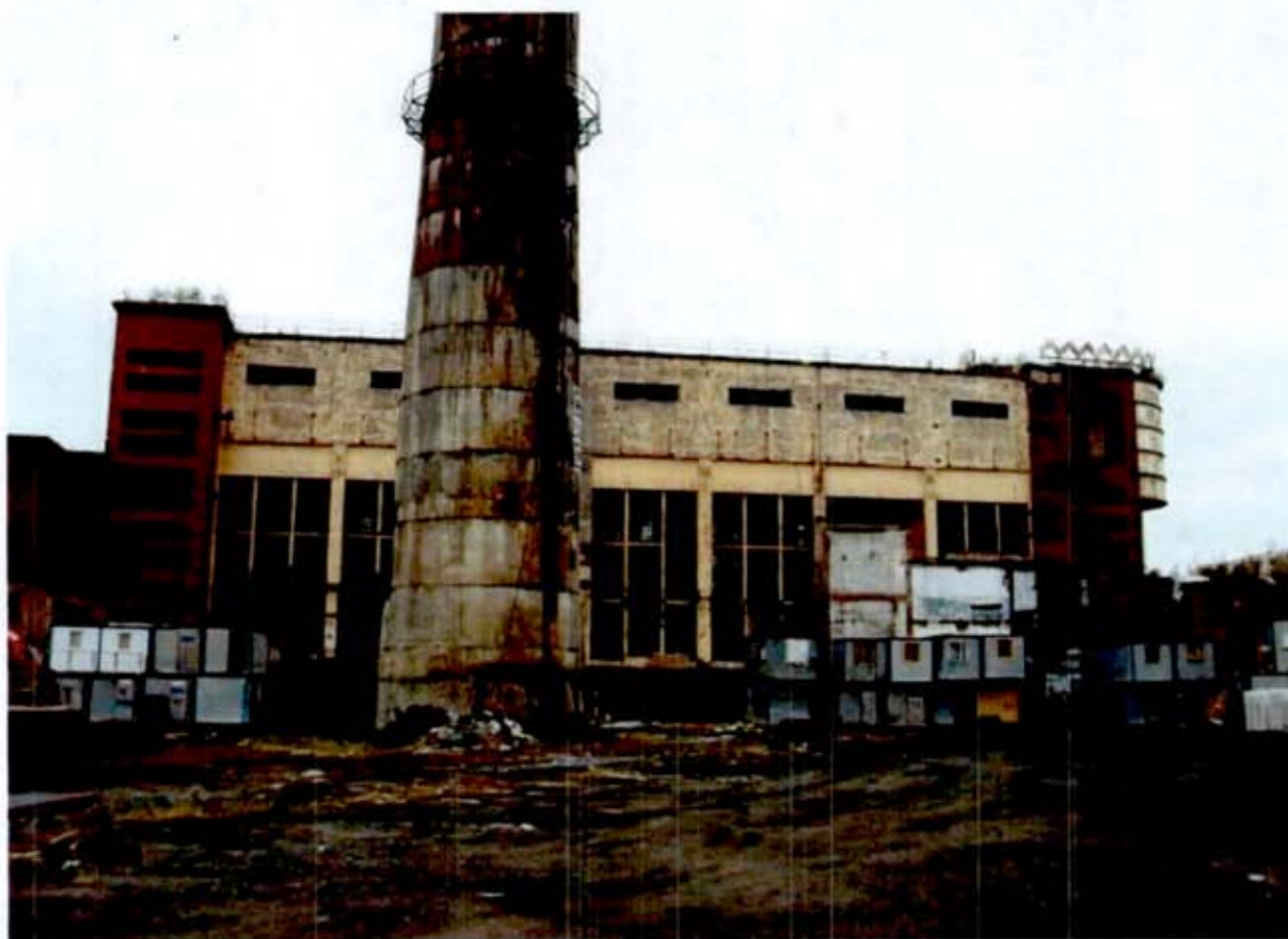
Фото 5. Фрагмент Северо-восточного фасада.
