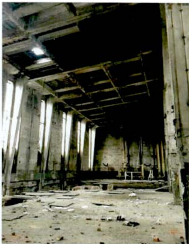
Фото 7. Бывш. котельный зал.
