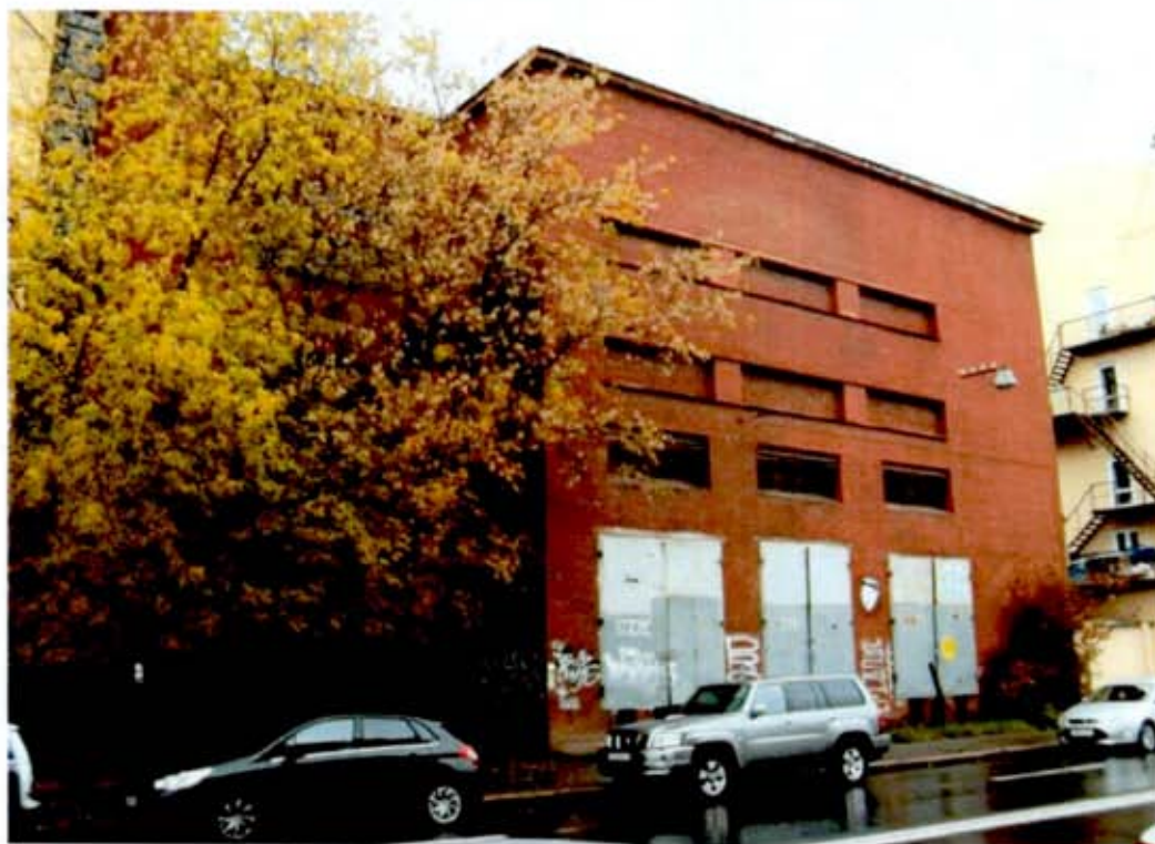
Фото 3. Фрагмент юго-западного фасада.
