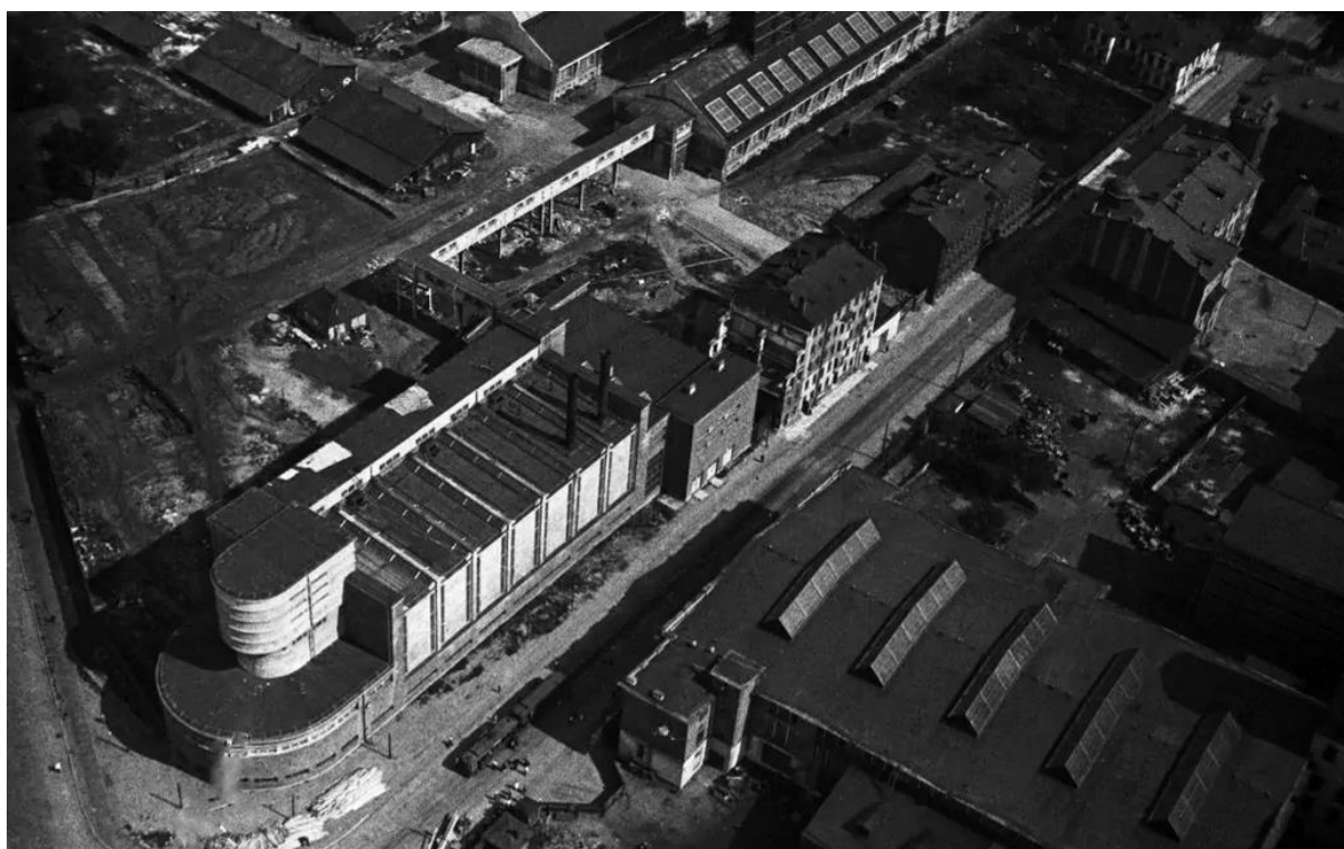
Илл. 47. Новые корпуса и силовая станция чулочно-трикотажной фабрики «Красное Знамя». 1931 г. Серия «Ленинград с аэроплана» для журнала «СССР на стройке». Электронный портал Pastvu.com.
