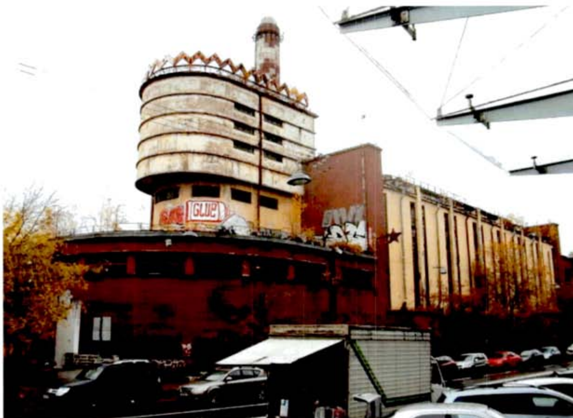
Фото 1. Полуциркульный северо-западный фасад и юго-западный фасад.
