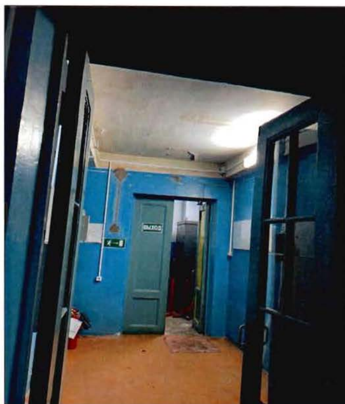
8. Помещения объекта культурного наследия.
