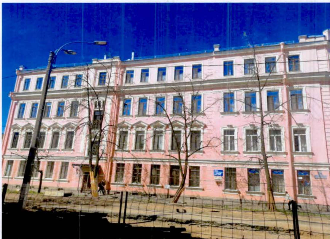
2. Восточный лицевой фасад объекта культурного наследия.
