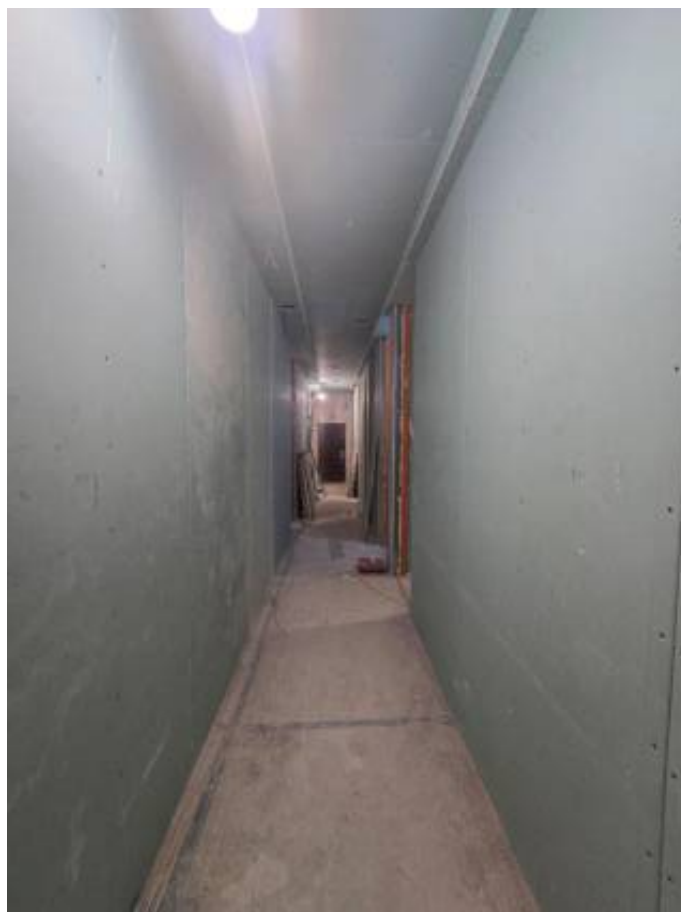
Фото 41. 1 этаж, коридор в северо-восточной части здания.
