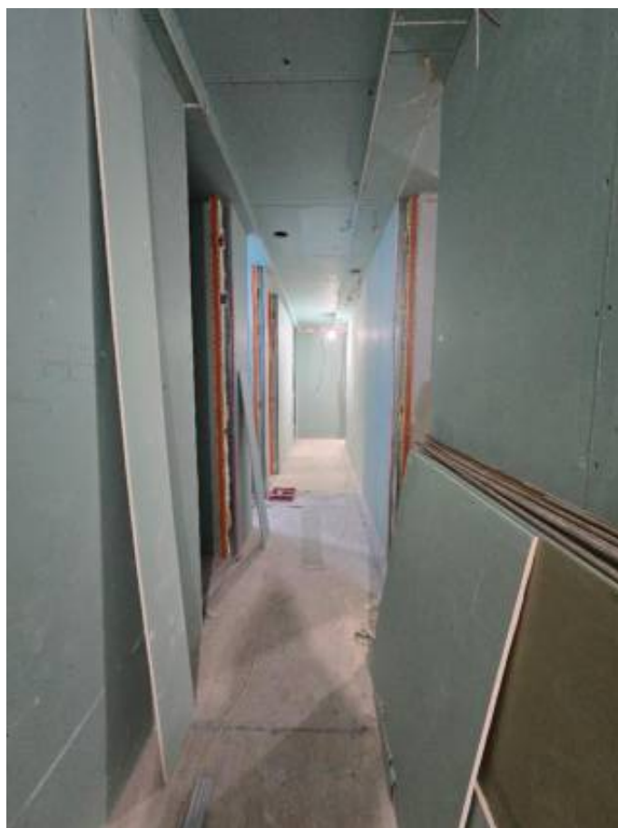
Фото 34. 1 этаж, коридор в северо-восточной части здания.
