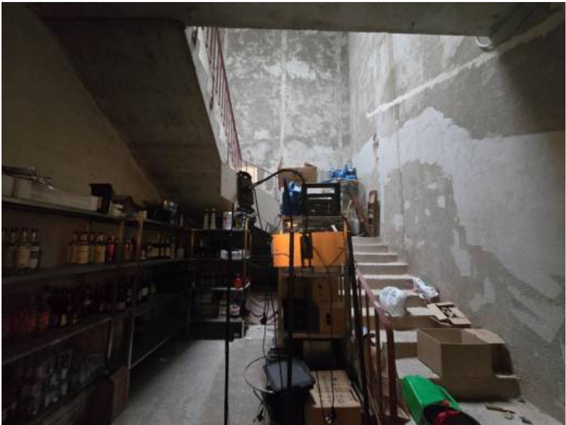
Фото 25. 1 этаж, лестница в южной части здания, помещение 110.
