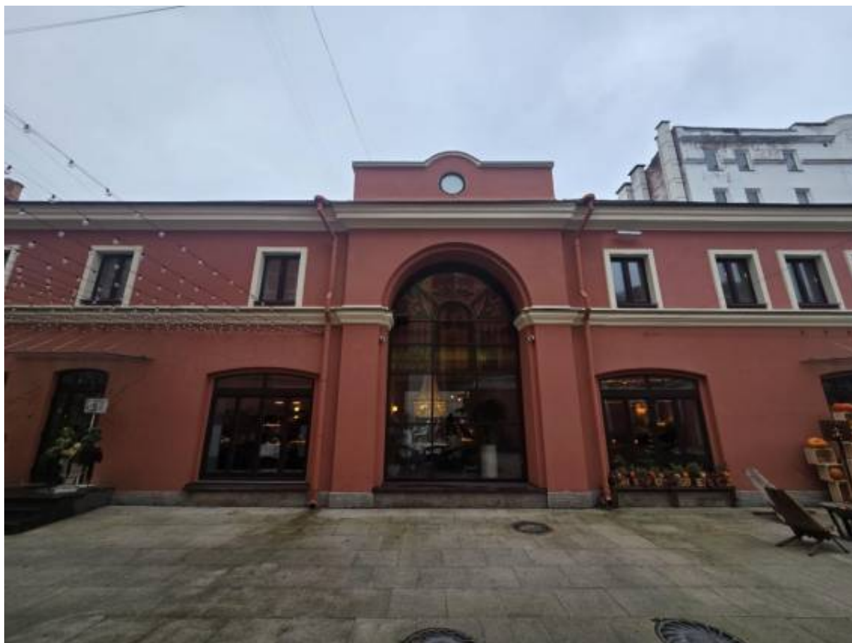
Фото 7. Арочный проем западного дворового фасада.
