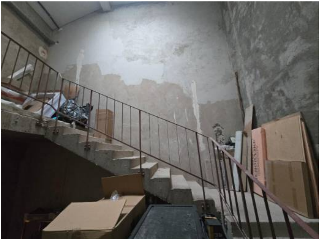
Фото 26. 1 этаж, лестница в южной части здания, помещение 110.
