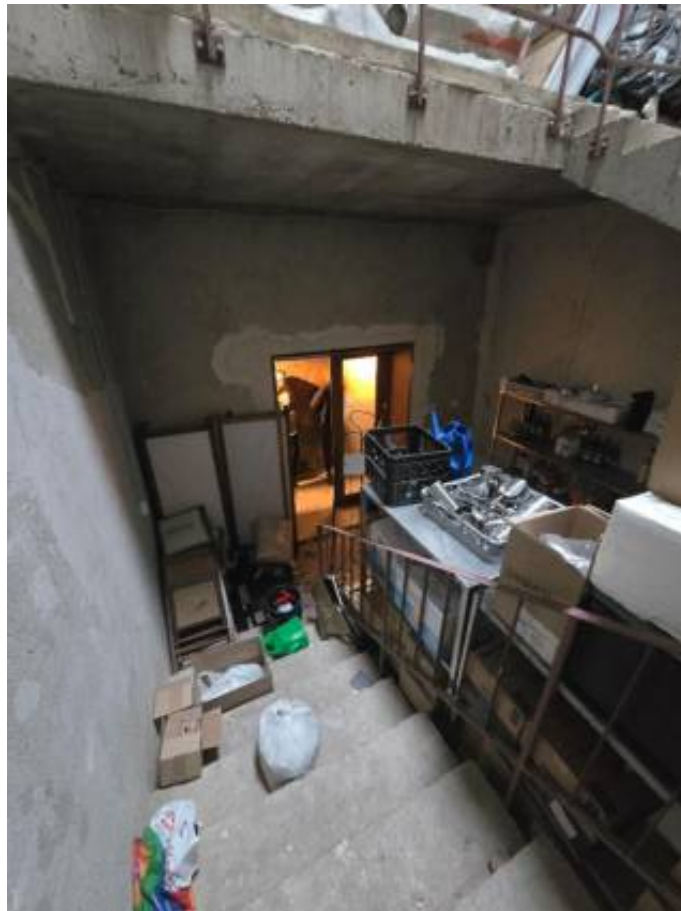
Фото 27. 1 этаж, лестница в южной части здания, помещение 110.
