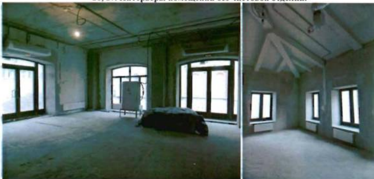
26, 27. Интерьеры помещений без чистовой отделки.
