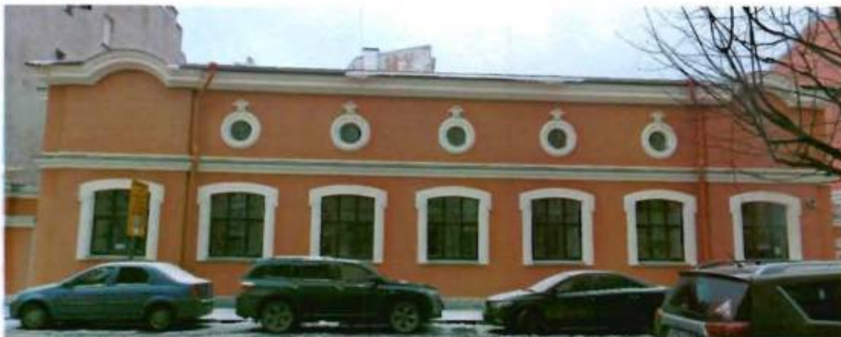
23. Общий вид Флигеля со стороны внутреннего двора.
