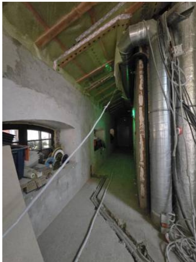
Фото 16. 2 этаж, коридор, южная часть здания.
