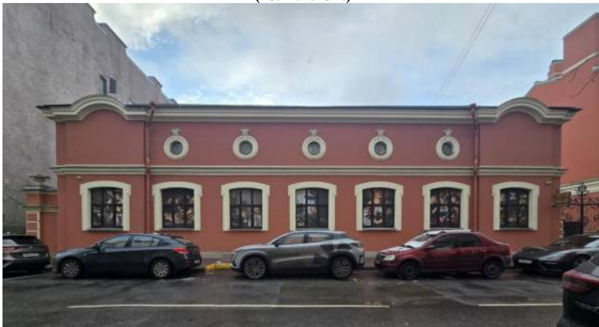
Фото 1. Лицевой фасад, вид с Гродненского переуллка.
