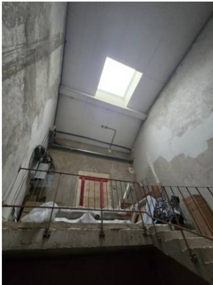
Фото 20. 2 этаж, лестница в южной части здания.
