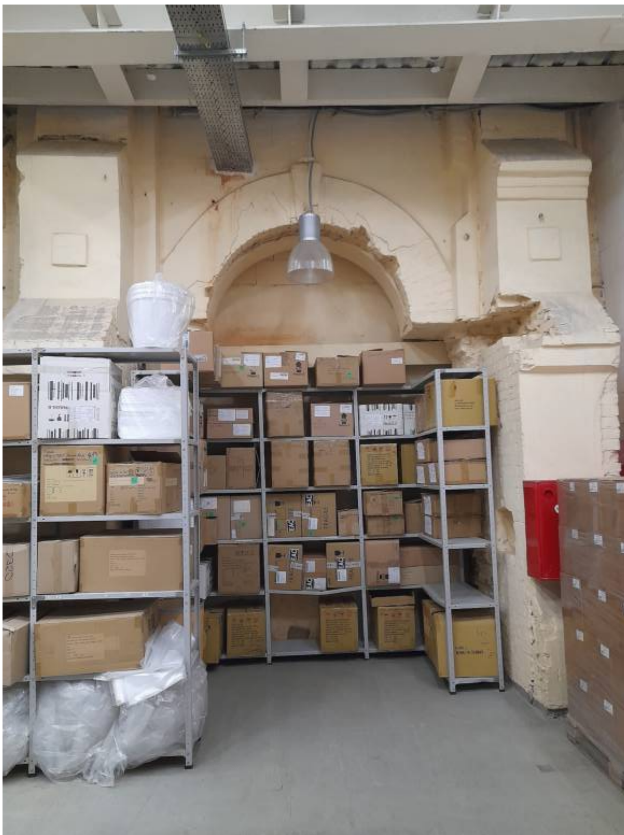
53. ОКН РЗ «Здание инструментального цеха». Литера Н. Ниша на месте дверного проема в центре западной стены с контрфорсами по сторонам от неё. Вид из литеры Н 4. Фотография 2024 г.
