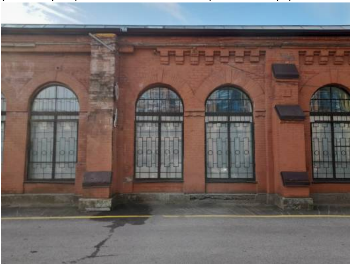
42. ОКН РЗ «Здание инструментального цеха». Литера Н. Фрагмент северного фасада с оконными проемами, лопатками с контрфорсами и поясом кирпичных кронштейнов, под венчающим карниз. Фотография 2024 г.
