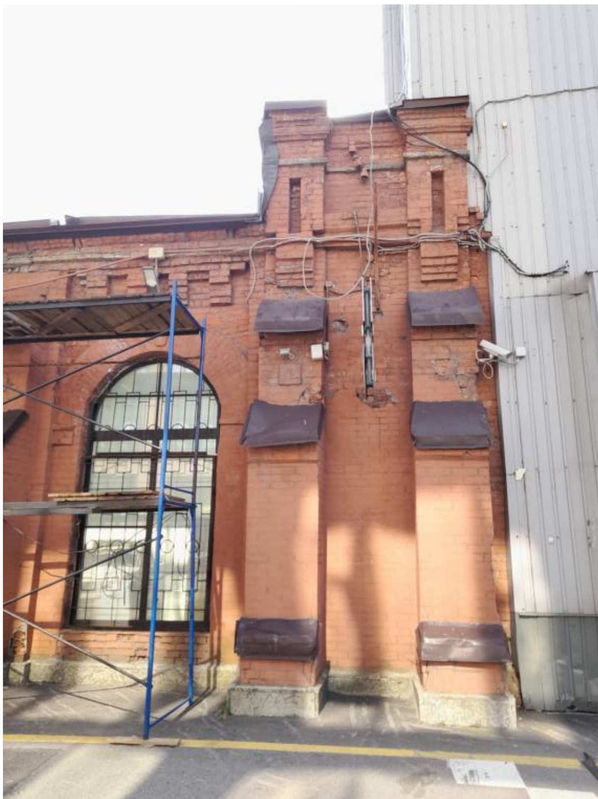
43. ОКН РЗ «Здание инструментального цеха». Литера Н. Западная часть северного фасада с двумя контрфорсами. Фотография 2024 г.
