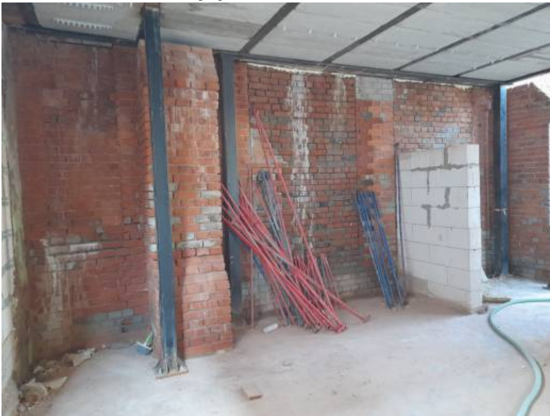
49. ОКН РЗ «Здание инструментального цеха». Литера Н. Южная часть восточной стены с заложенными оконными проемами и контрфорсом. Вид с востока. Фотография 2024 г.
