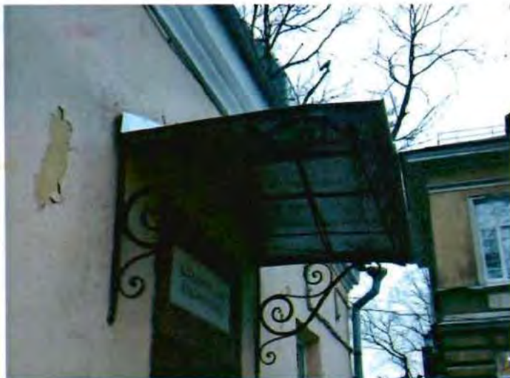
3. Металлический козырёк на фигурных кронштейнах
