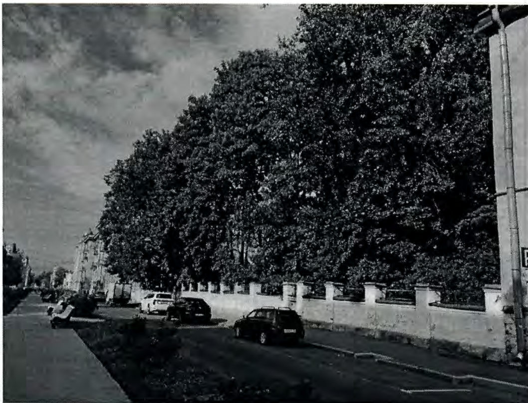
1. Общий вид со стороны 14-й линии В.О.
