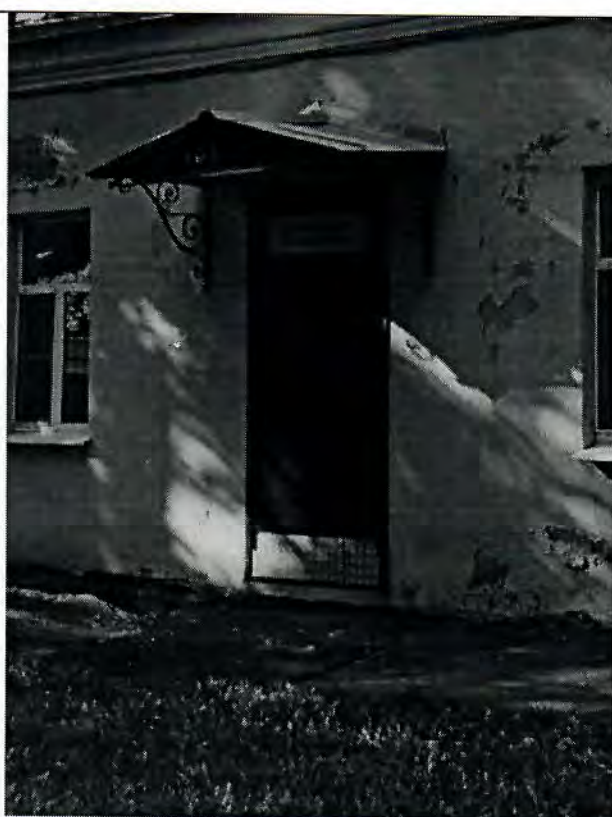
5. Вид на вход с южной стороны фасада
