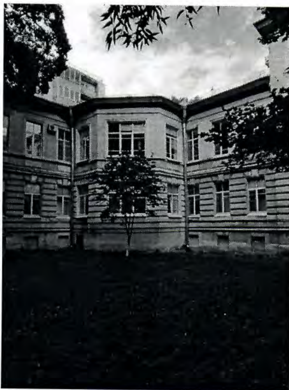
1. Общий вид на Объект со стороны сада
