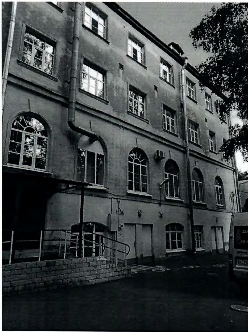
2. Вид на часть фасада с пандусом
