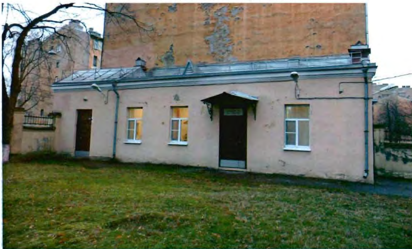
1. Общий вид на южный фасад здания
