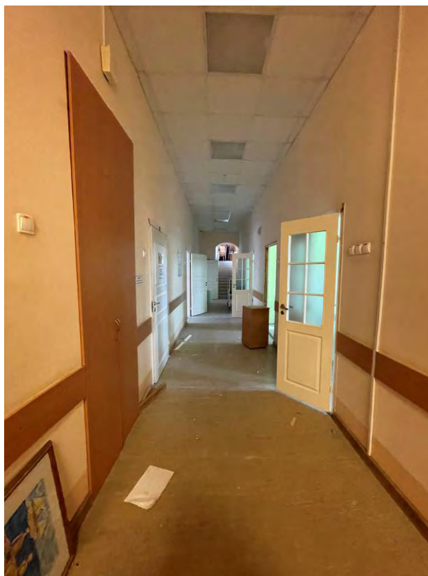
Фото 78. Интерьер 2 этажа объекта культурного наследия регионального значения «Больница», входящего в состав объекта культурного наследия регионального значения «Комплекс зданий Французского благотворительного общества»
