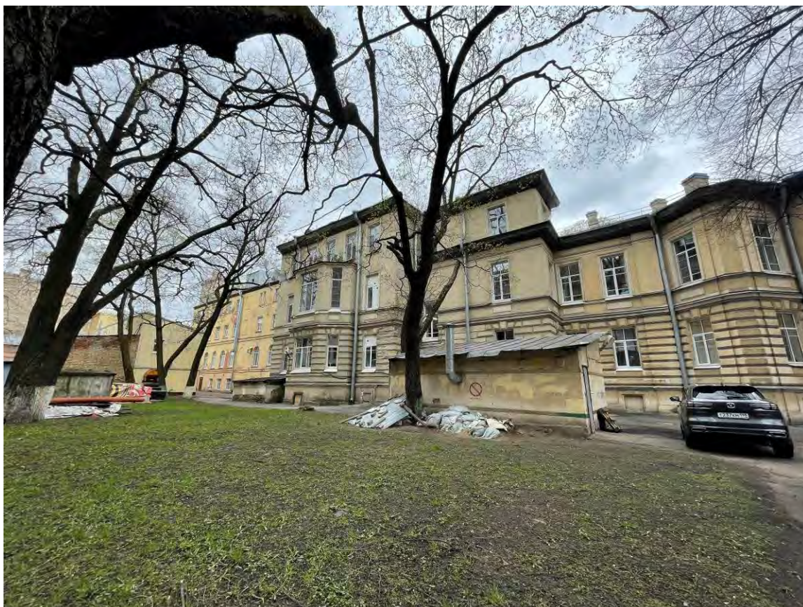
Фото 12. Фрагмент лицевого фасада объекта культурного наследия регионального значения «Больница», входящего в состав объекта культурного наследия регионального значения «Комплекс зданий Французского благотворительного общества»
