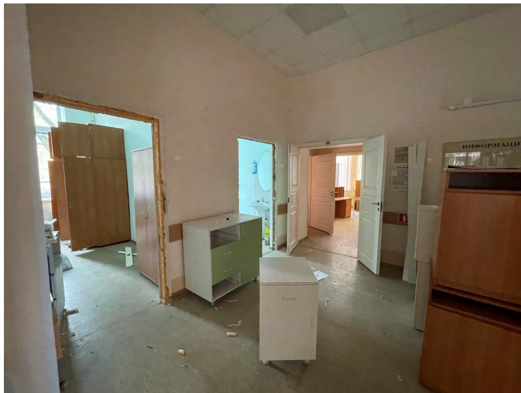
Фото 75. Интерьер 2 этажа объекта культурного наследия регионального значения «Больница», входящего в состав объекта культурного наследия регионального значения «Комплекс зданий Французского благотворительного общества»
