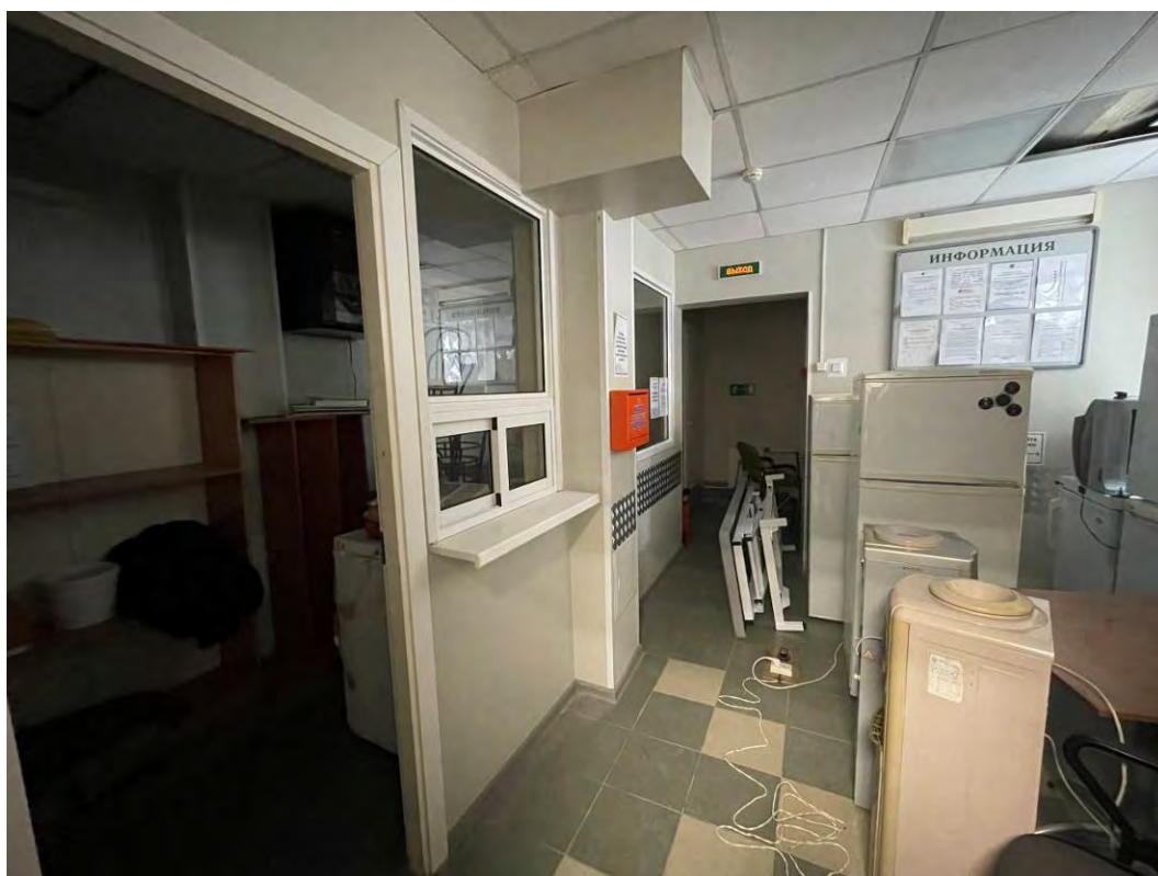
Фото 38. Интерьер 1 этажа объекта культурного наследия регионального значения «Южный корпус», входящего в состав объекта культурного наследия регионального значения «Комплекс зданий Французского благотворительного общества»
