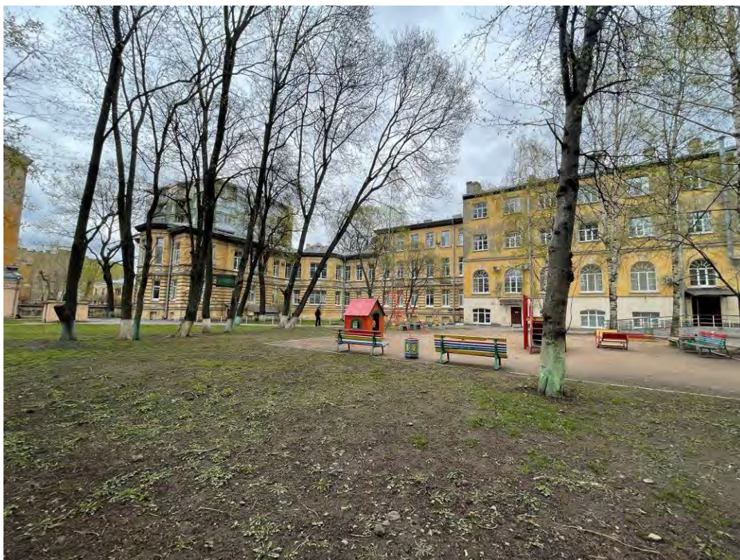
Фото 25. Вид на объекты культурного наследия регионального значения «Сад», «Больница», «Южный корпус», входящие в состав объекта культурного наследия регионального значения «Комплекс зданий Французского благотворительного общества»
