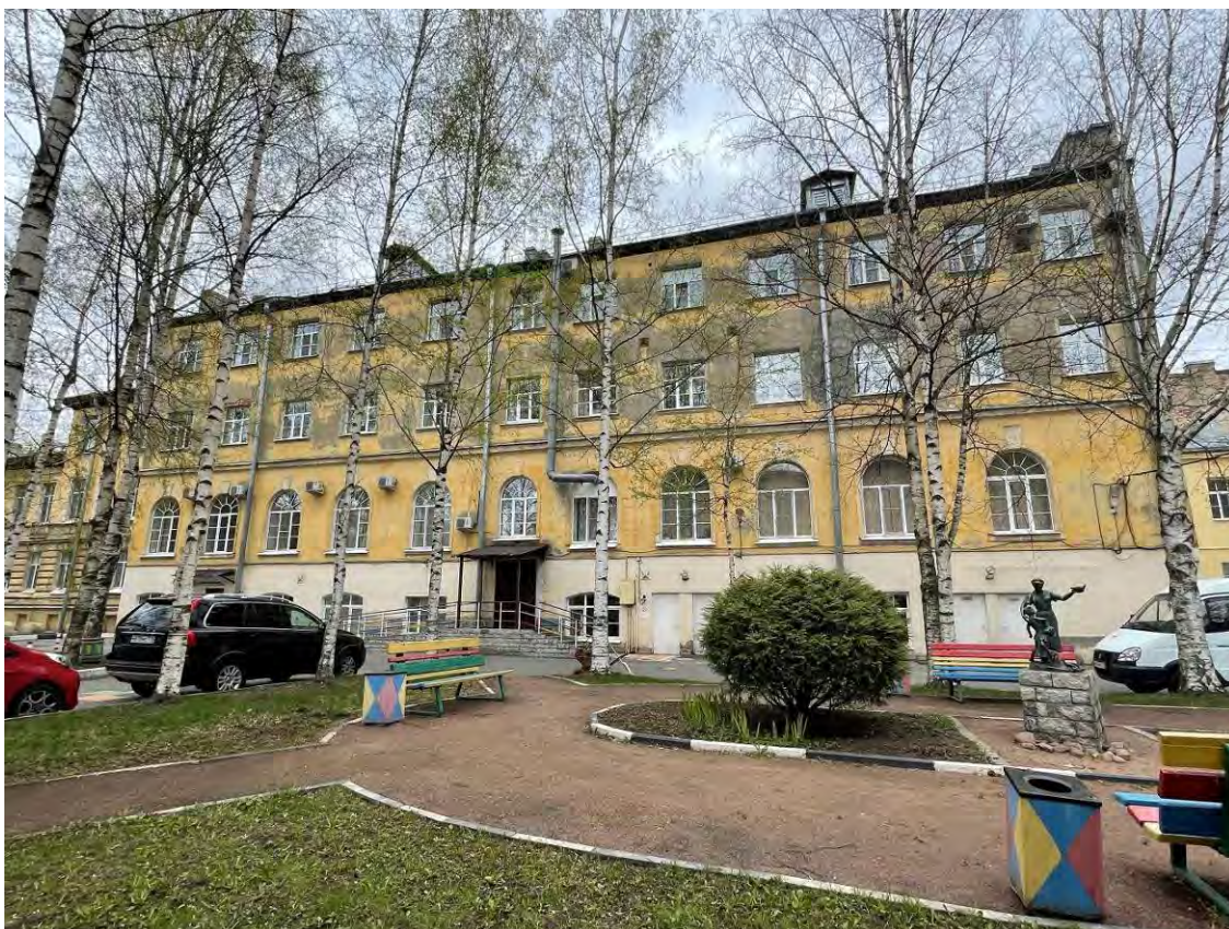
Фото 27. Фрагмент лицевого фасада объекта культурного наследия регионального значения «Южный корпус», входящего в состав объекта культурного наследия регионального значения «Комплекс зданий Французского благотворительного общества»
