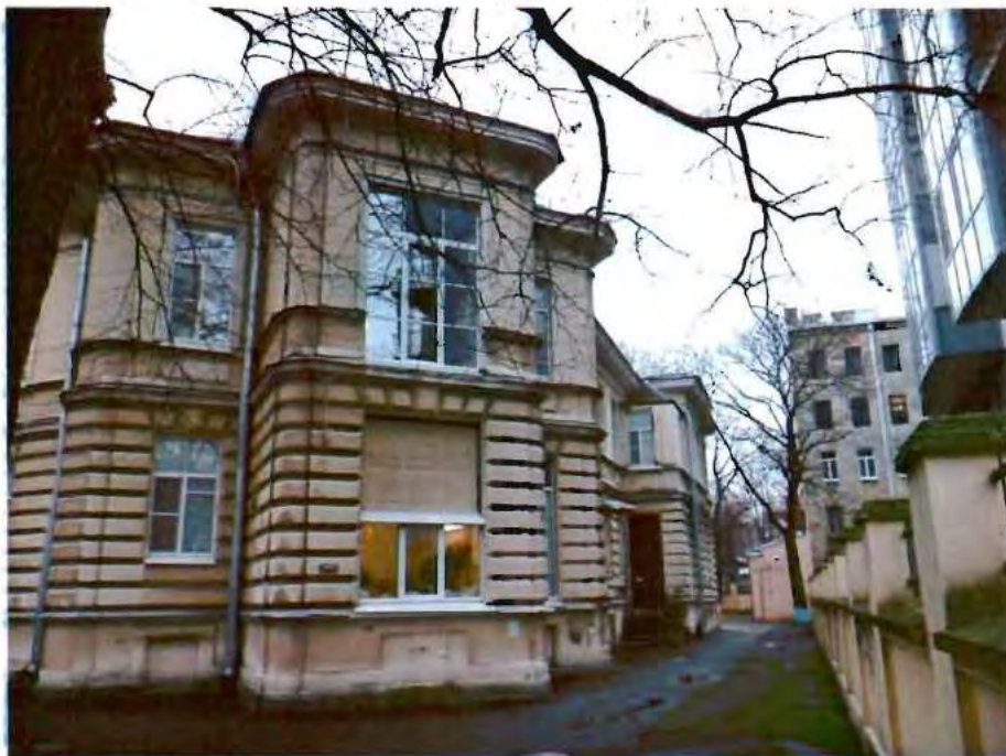
5. Северный фасад здания
