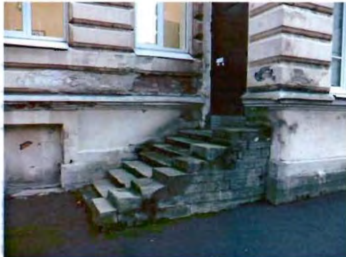
24. Крыльцо северного фасада здания
