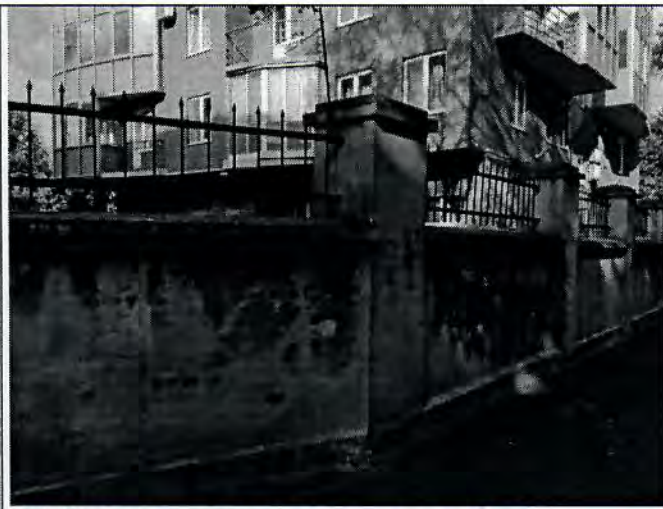
11. Участок ограды с северо-западной стороны
