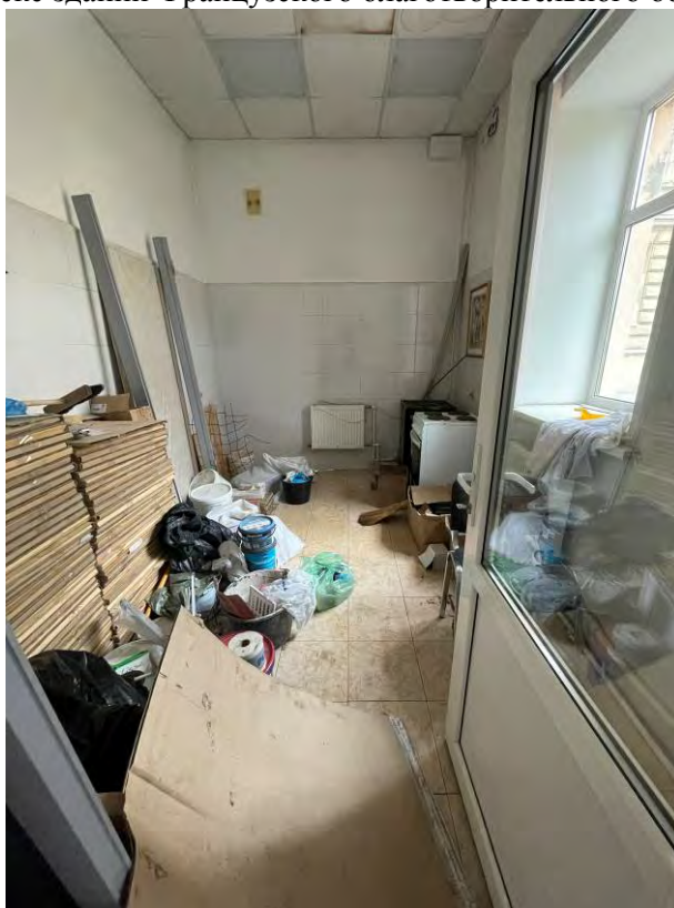
Фото 105. Интерьер 1 этажа объекта культурного наследия регионального значения «Часовня», входящего в состав объекта культурного наследия регионального значения «Комплекс зданий Французского благотворительного общества»
