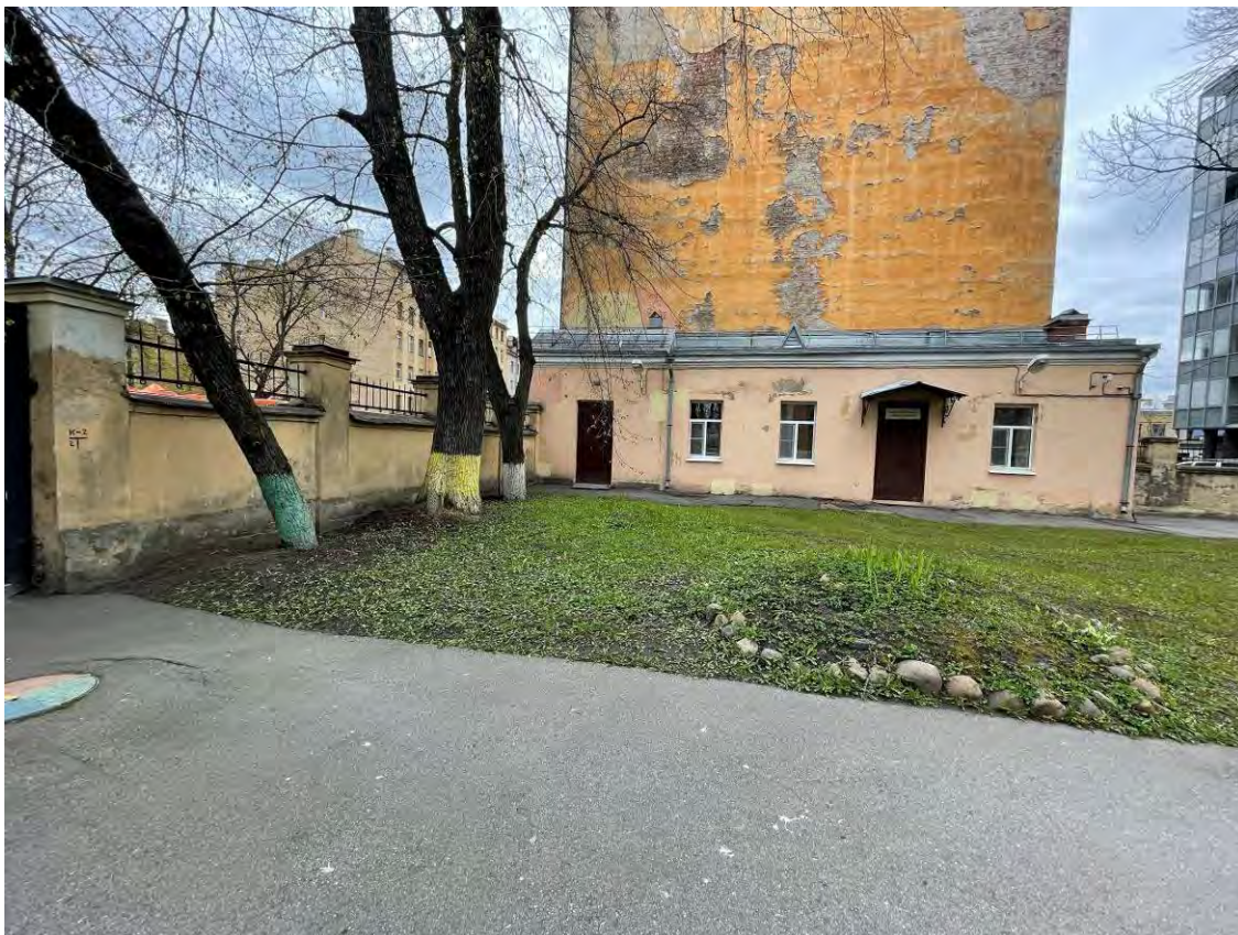
Фото 21. Вид на объекты культурного наследия регионального значения «Сад», «Ограда», «Часовня», входящие в состав объекта культурного наследия регионального значения «Комплекс зданий Французского благотворительного общества»
