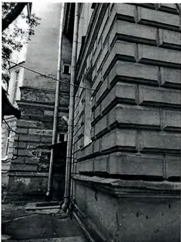
8. Вид на участок фасада с входом
