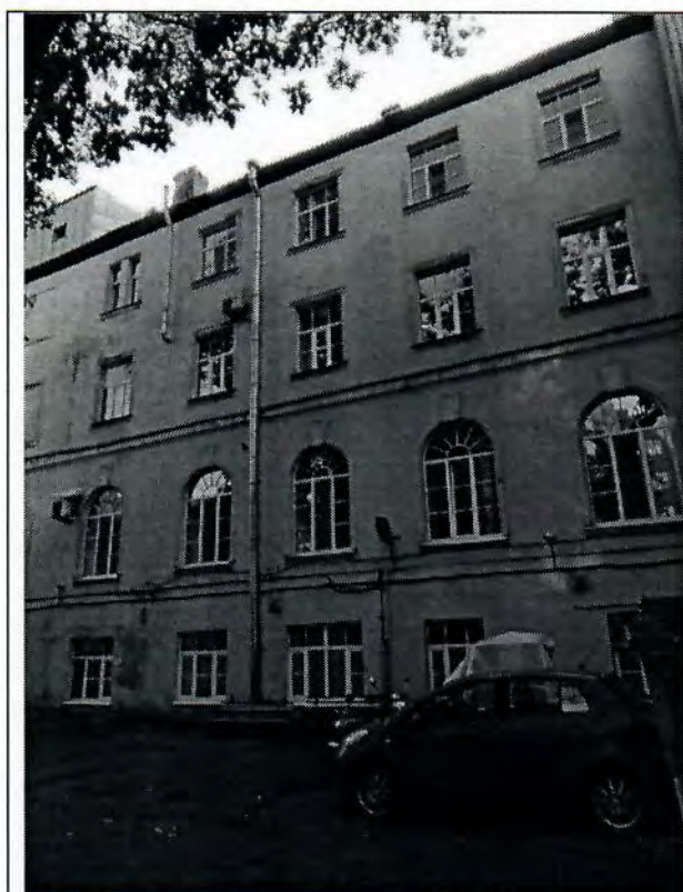
5. Вид на часть западного фасада
