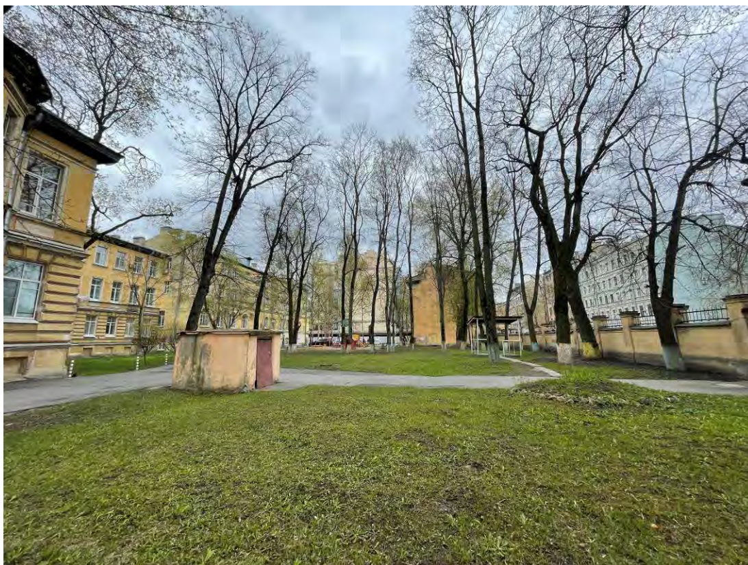
Фото 22. Вид на объекты культурного наследия регионального значения «Ограда», «Сад», входящие в состав объекта культурного наследия регионального значения «Комплекс зданий Французского благотворительного общества»
