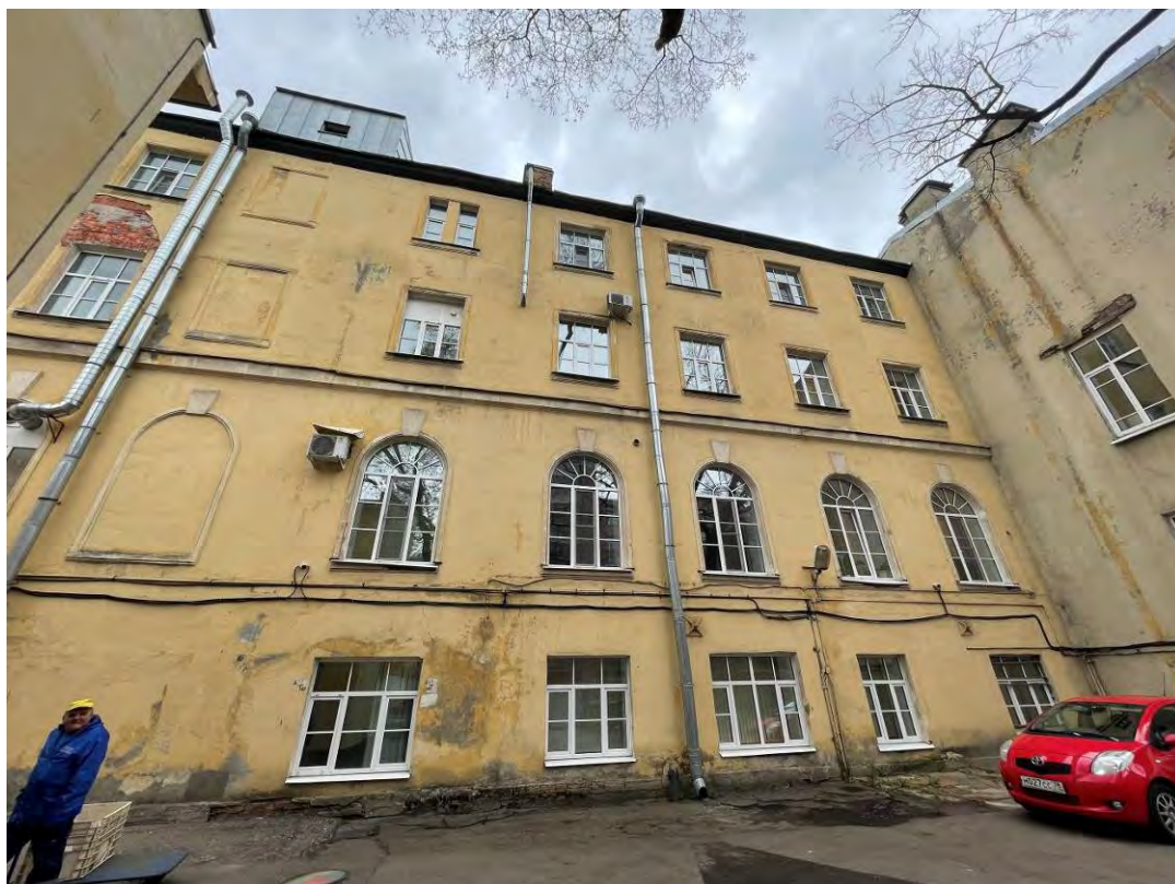
Фото 7. Фрагмент лицевого фасада объекта культурного наследия регионального значения «Южный корпус», входящего в состав объекта культурного наследия регионального значения «Комплекс зданий Французского благотворительного общества»
