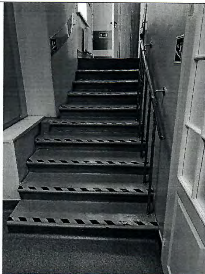
12. Вид на служебную лестницу
