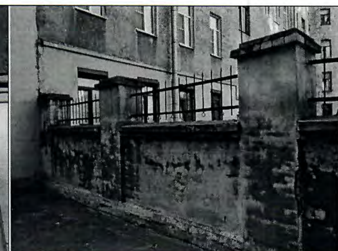
9. Фрагмент ограды с северо-западной стороны (примыкающей к Часовне)
