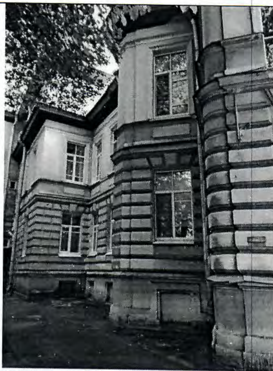
3. Вид на восточный фасад
