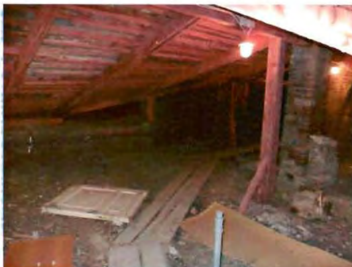
12. Стропильная система кровли
