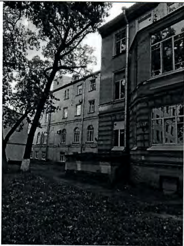
4. Вид на северо-восточный фасад
