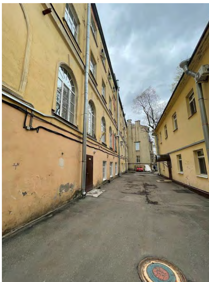
Фото 6. Фрагмент лицевого фасада объекта культурного наследия регионального значения «Южный корпус», входящего в состав объекта культурного наследия регионального значения «Комплекс зданий Французского благотворительного общества»
