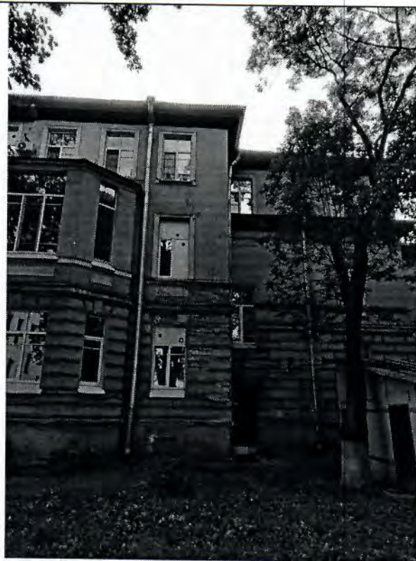
5. Фрагмент северо-восточного фасада
