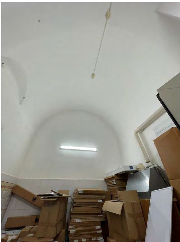
Фото 110. Интерьер 1 этажа объекта культурного наследия регионального значения «Часовня», входящего в состав объекта культурного наследия регионального значения «Комплекс зданий Французского благотворительного общества»
