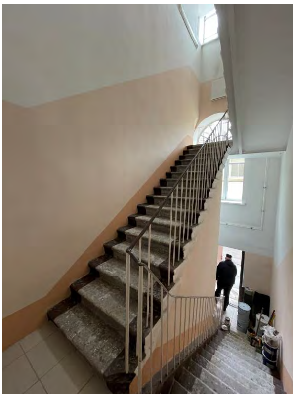
Фото 102. Интерьер 2 этажа объекта культурного наследия регионального значения «Южный корпус», входящего в состав объекта культурного наследия регионального значения «Комплекс зданий Французского благотворительного общества»
