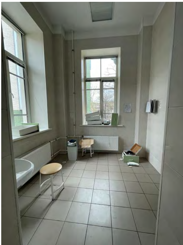
Фото 72. Интерьер 2 этажа объекта культурного наследия регионального значения «Больница», входящего в состав объекта культурного наследия регионального значения «Комплекс зданий Французского благотворительного общества»
