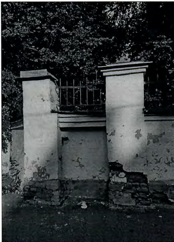
6. Фрагмент ограды со стороны 14-ой линии В.О.
