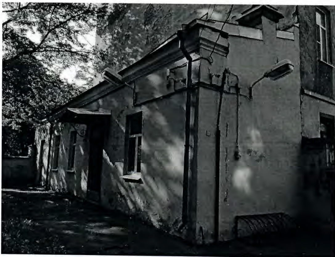
1. Общий вид на Объект южной стороны
