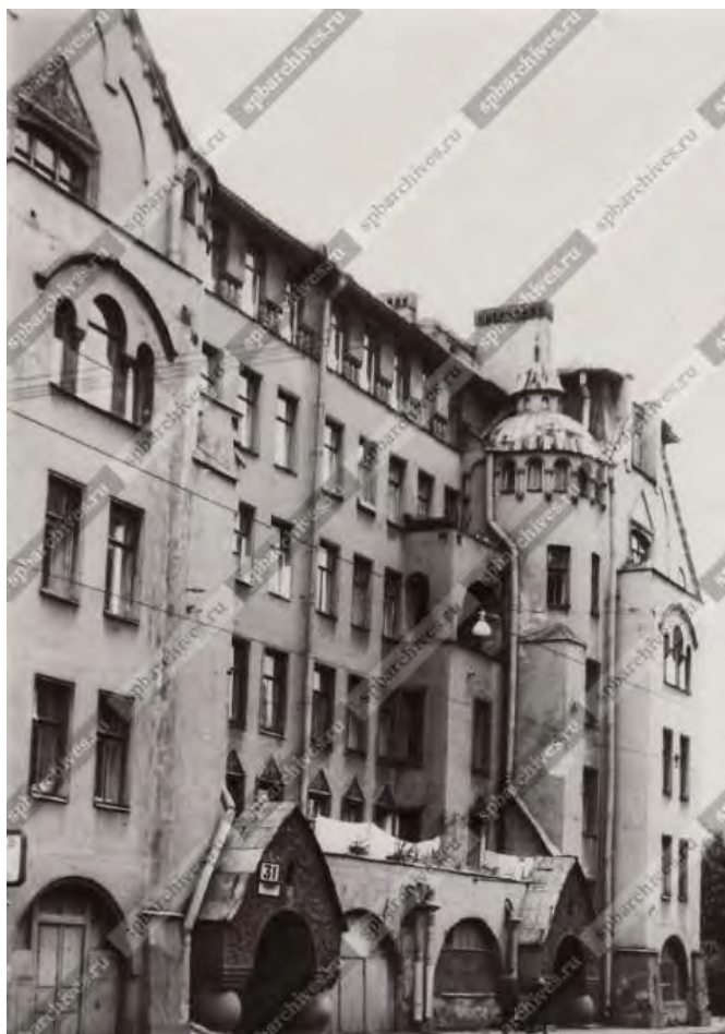
Илл. 11. Вид фасада по Чкаловскому проспекту жилого дома № 31/10 (архитектор А.Л. Лишнеvский, 1912-1913 гг., бывший доходный дом Б.Я. Купермана). Дата съемки: 16.09.1984 г. // ЦГАКФФД СПб. Шифр: Ар 215988.
