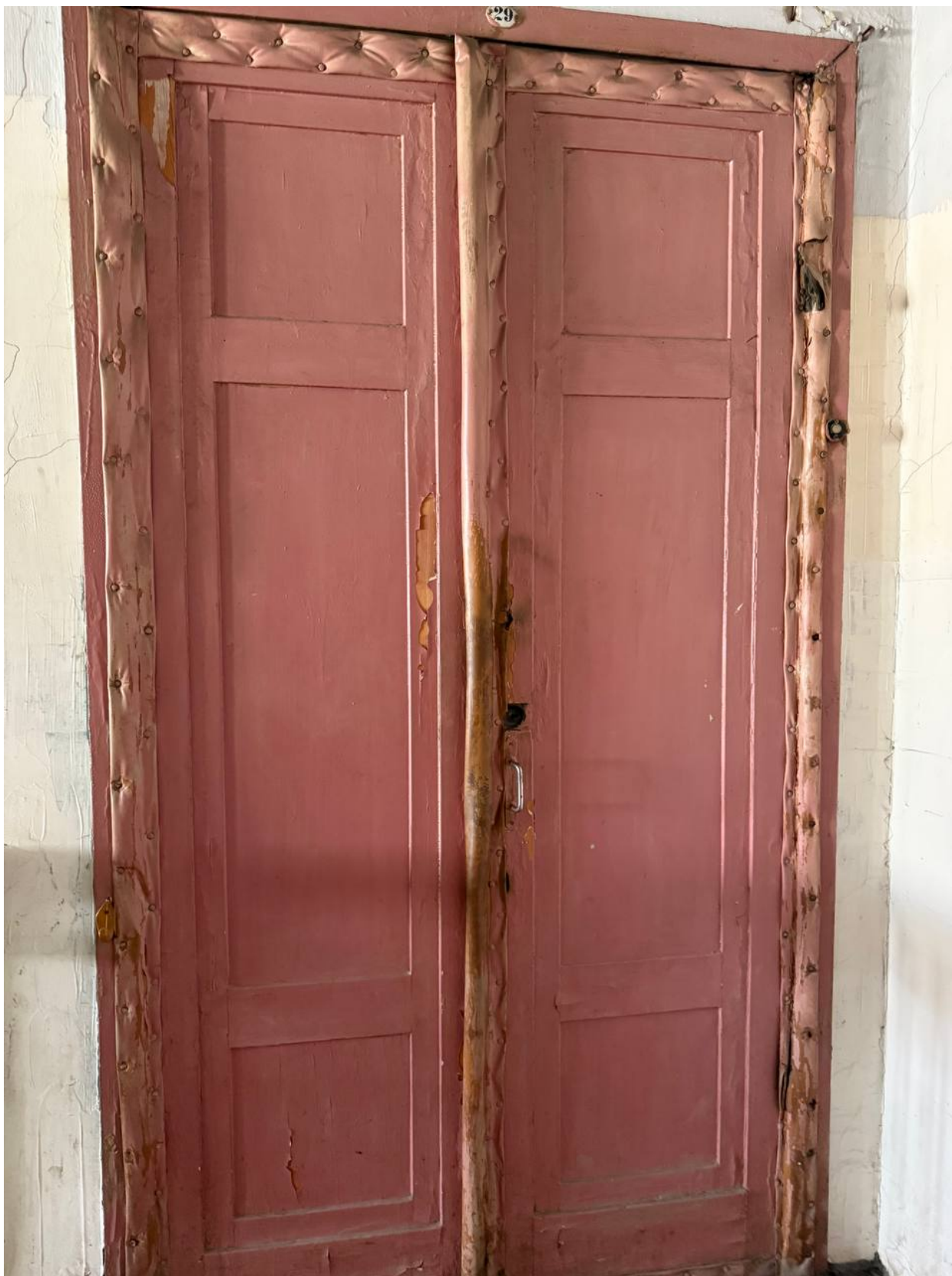
22. Входная дверь со стороны лестницы.
