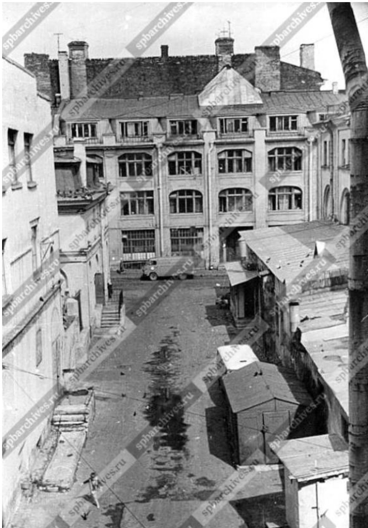
Илл.21. Вид на дом (№6) в Банковском переулке со стороны Москательного переуллка. Фото 1970-е гг. ЦГАКФФД СПб. Фотодокументы. Опись 1АР-149. Ед.хр.200227.
