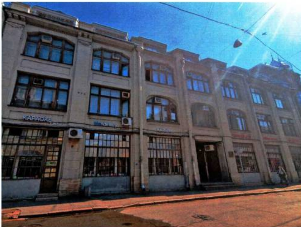
1. Лицевой фасад объекта культурного наследия.
