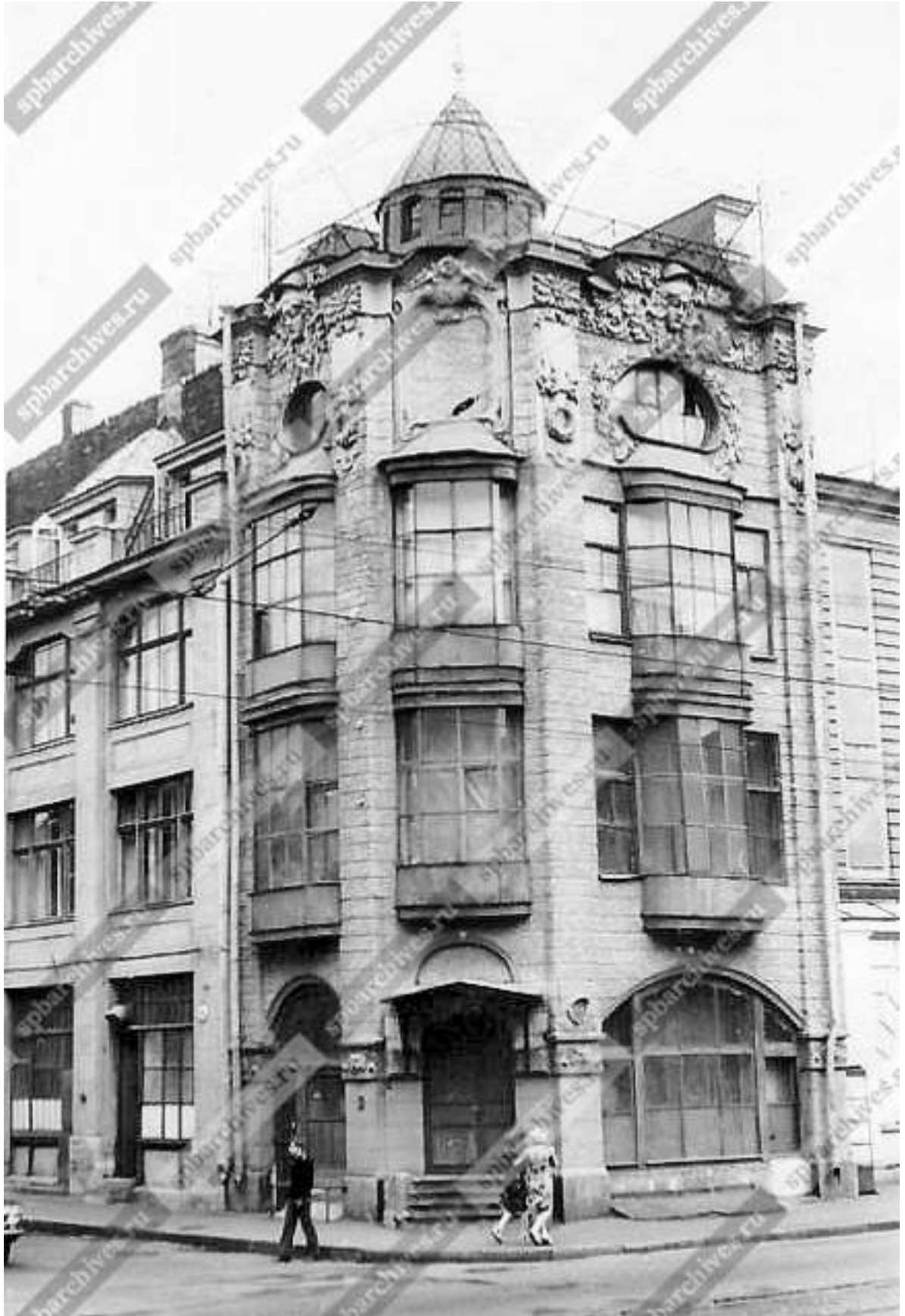
Илл.22. Общий вид дома с большими витринными окнами на углу улицы Садовой и Банковского переулка, 23/6 (бывшая контора завода Э.Э. Новицкого, лавка И.А. Алферова, арх. В.В. Шауб, 1903-1904 гг.). Фото 1979 г. ЦГАКФФД СПб. Фотодокументы. Описание 1АР-157. Ед.хр.225228.
