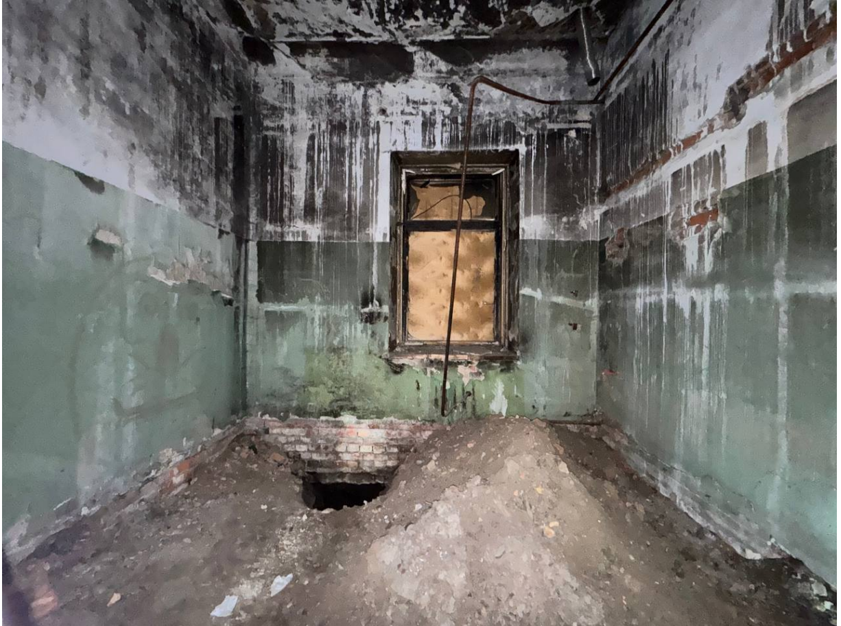
Фото 15. Выявленный объект культурного наследия «Здание товарной станции Московско-Виндаво-Рыбинской железной дороги». Адрес: Санкт-Петербург, Лиговский проспект, дом 240, лит И. Общий вид помещения П4.
