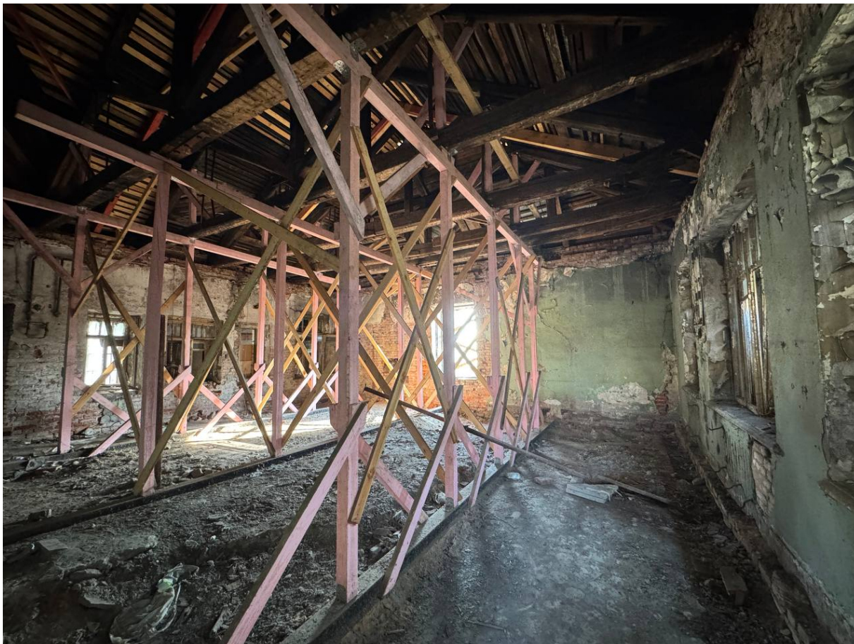
Фото 11. Выявленный объект культурного наследия «Здание товарной станции Московско-Виндаво-Рыбинской железной дороги». Адрес: Санкт-Петербург, Лиговский проспект, дом 240, лит И. Общий вид помещения П1.
