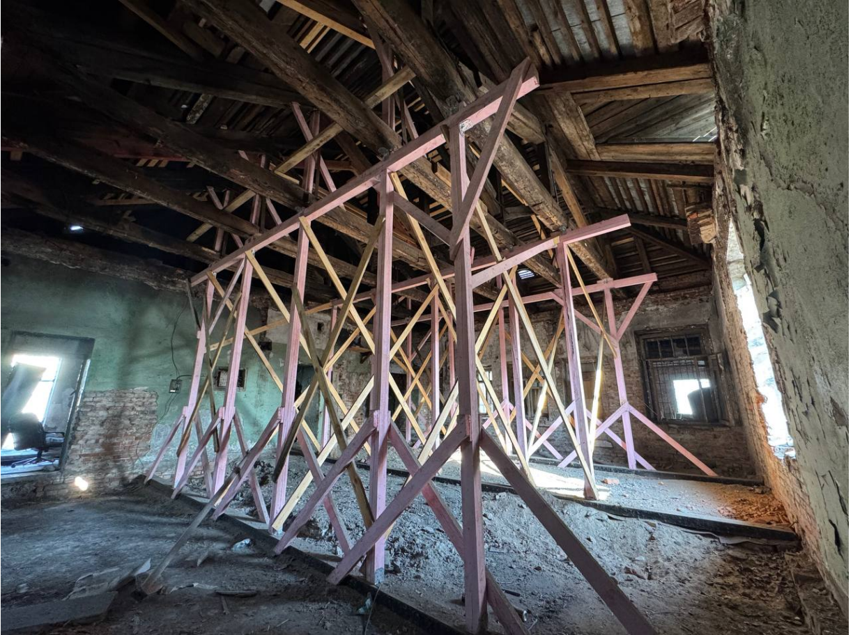
Фото 12. Выявленный объект культурного наследия «Здание товарной станции Московско-Виндаво-Рыбинской железной дороги». Адрес: Санкт-Петербург, Лиговский проспект, дом 240, лит И. Общий вид помещения П1.
