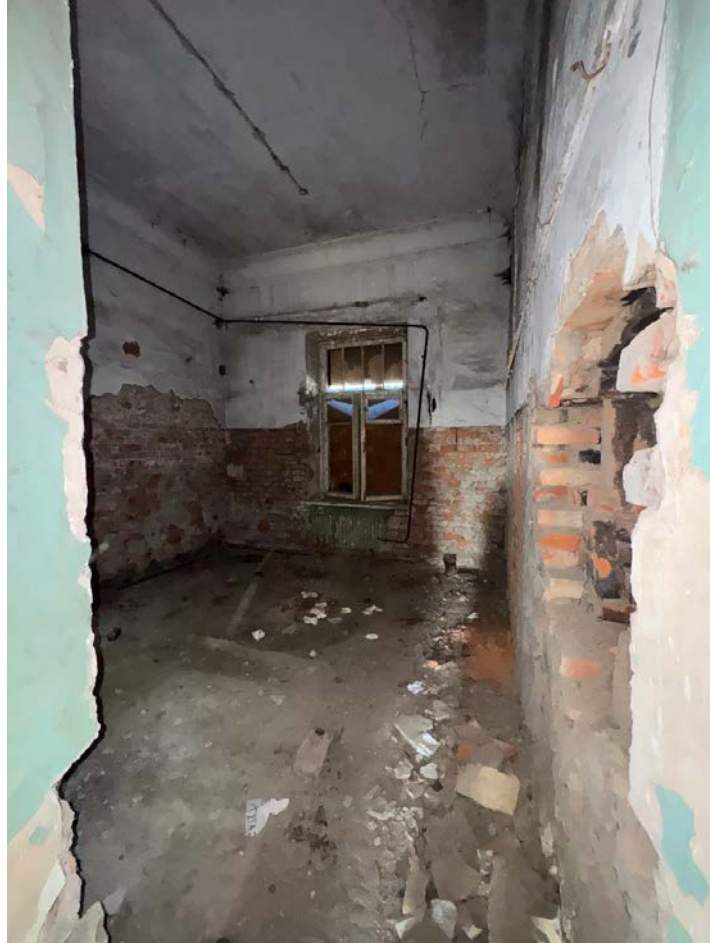
Фото 14. Выявленный объект культурного наследия «Здание товарной станции Московско-Виндаво-Рыбинской железной дороги». Адрес: Санкт-Петербург, Лиговский проспект, дом 240, лит И. Общий вид помещения ПЗ.
