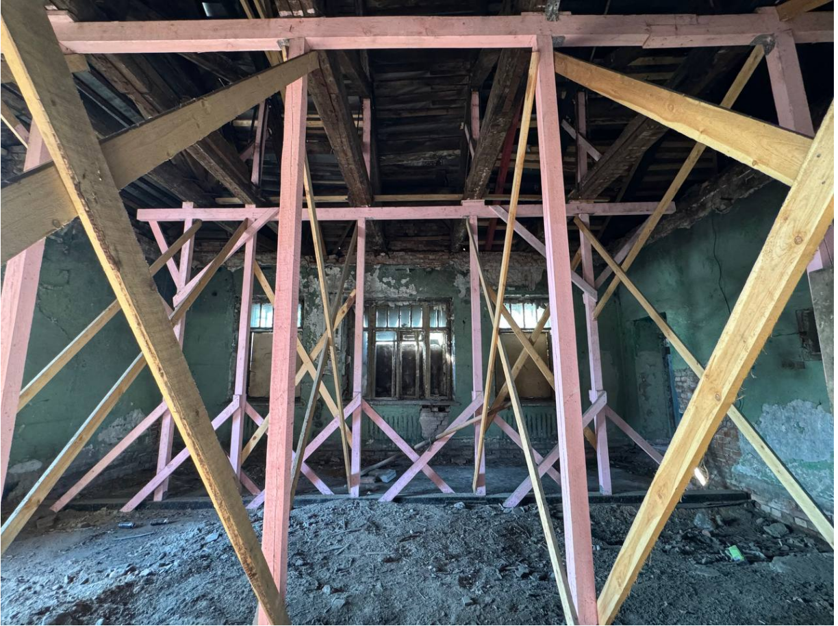
Фото 10. Выявленный объект культурного наследия «Здание товарной станции Московско-Виндаво-Рыбинской железной дороги». Адрес: Санкт-Петербург, Лиговский проспект, дом 240, лит И. Общий вид помещения П1.
