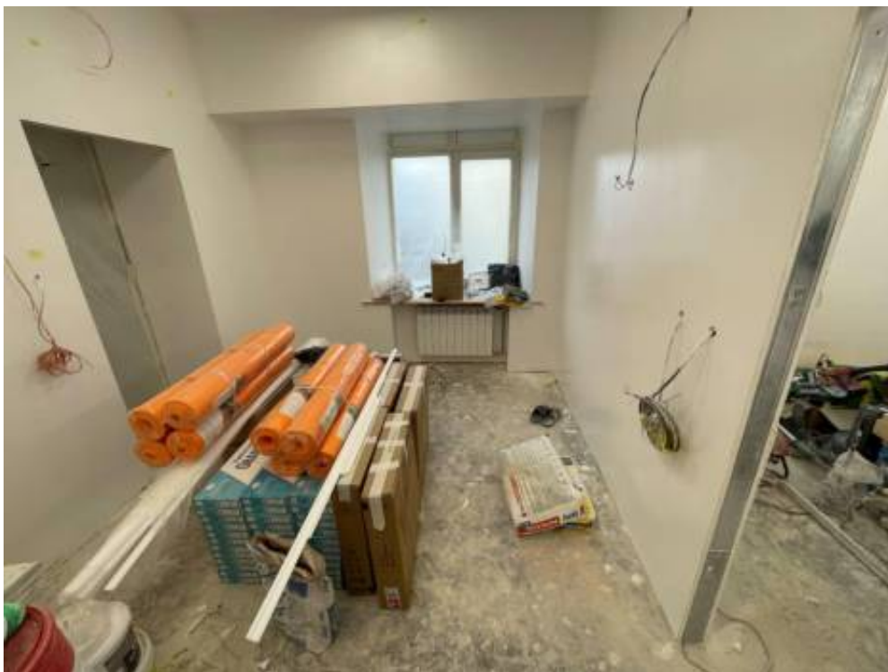
Фото 11. Интерьер помещения 102-Н объекта культурного наследия регионального значения «Лицевой корпус Литера А с двумя дворовыми корпусами», входящего в состав объекта культурного наследия регионального значения «Дома Каменноостровского товарищества для устройства постоянных квартир»
