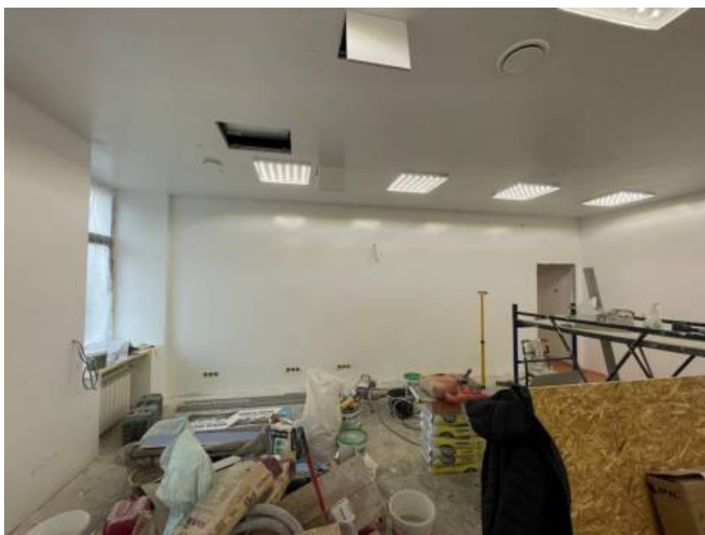
Фото 12. Интерьер помещения 102-Н объекта культурного наследия регионального значения «Лицевой корпус Литера А с двумя дворовыми корпусами», входящего в состав объекта культурного наследия регионального значения «Дома Каменноостровского товарищества для устройства постоянных квартир»
