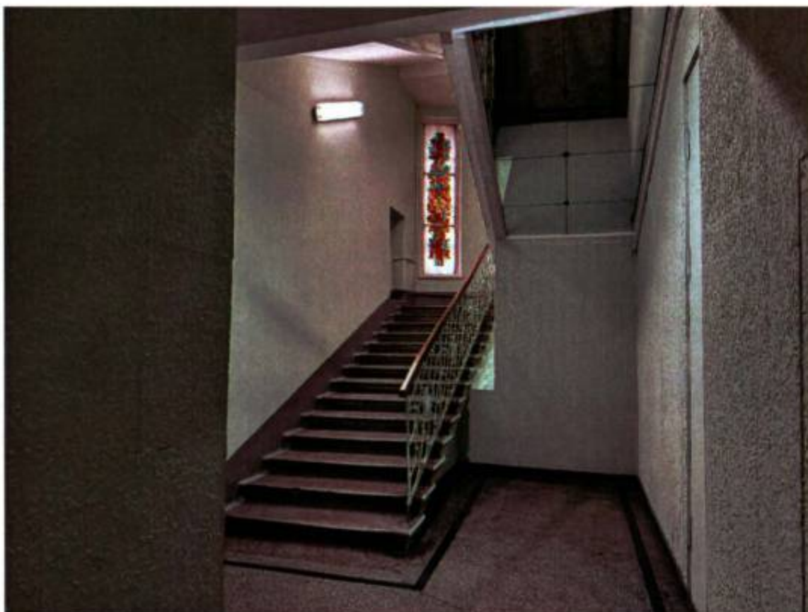
6. Помещение междуэтажной лестницы в центральной части западного корпуса (Л-2). Фото от 13.05.2024.
