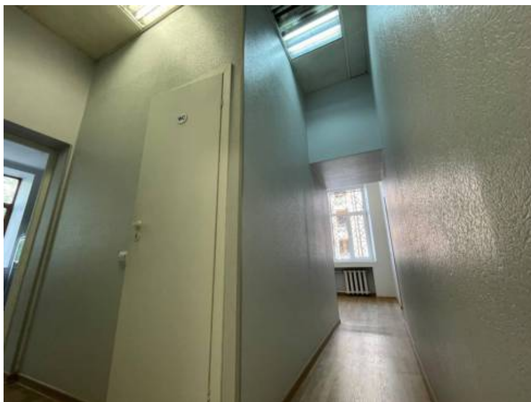
Фото 28. Интерьер помещения 2-Н объекта культурного наследия регионального значения «Лицевой корпус Литера А с двумя дворовыми корпусами», входящего в состав объекта культурного наследия регионального значения «Дома Каменноостровского товарищества для устройства постоянных квартир»
