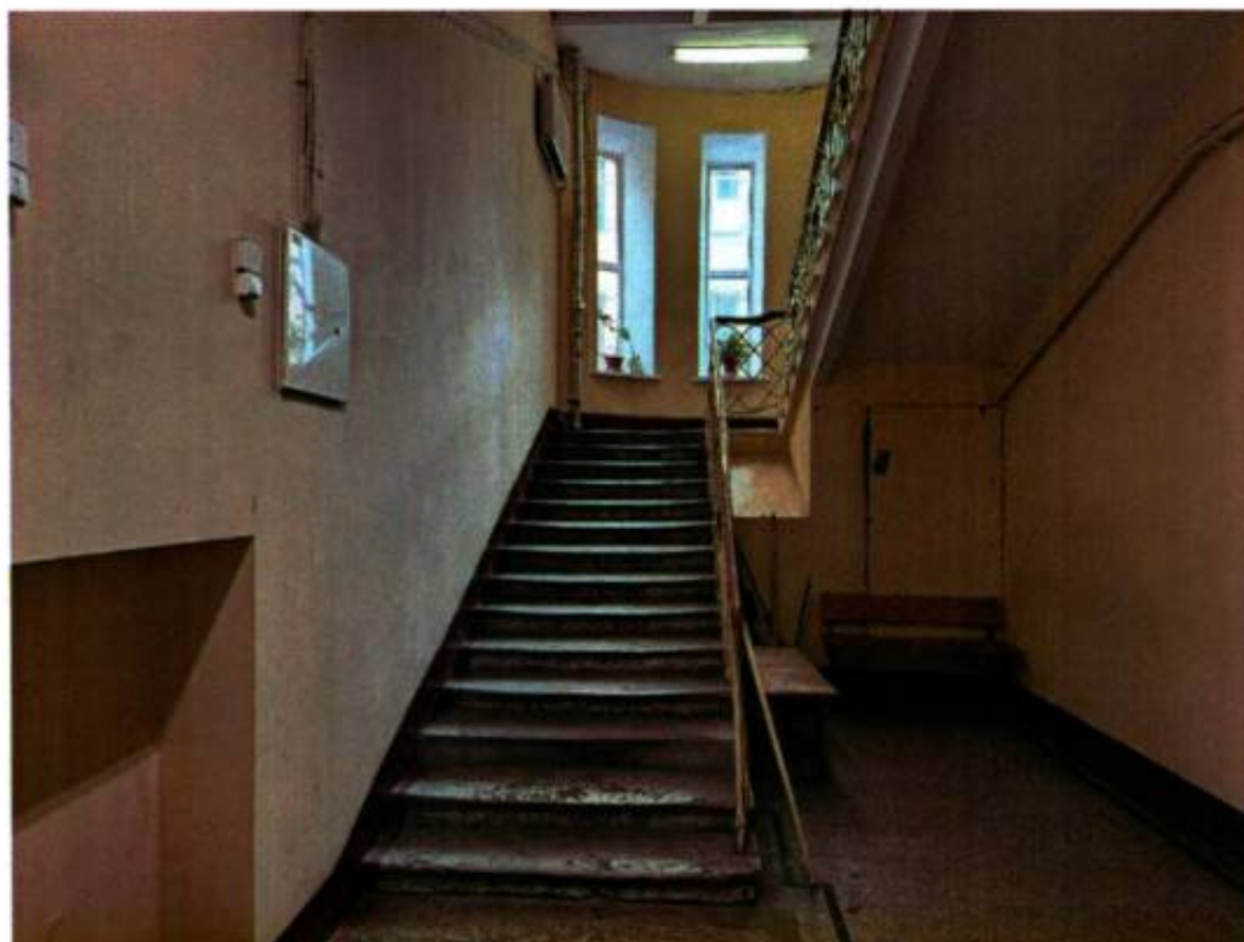
5. Помещение междуэтажной лестницы в центральной части восточного лицевого корпуса (Л-6). Фото от 13.05.2024.
