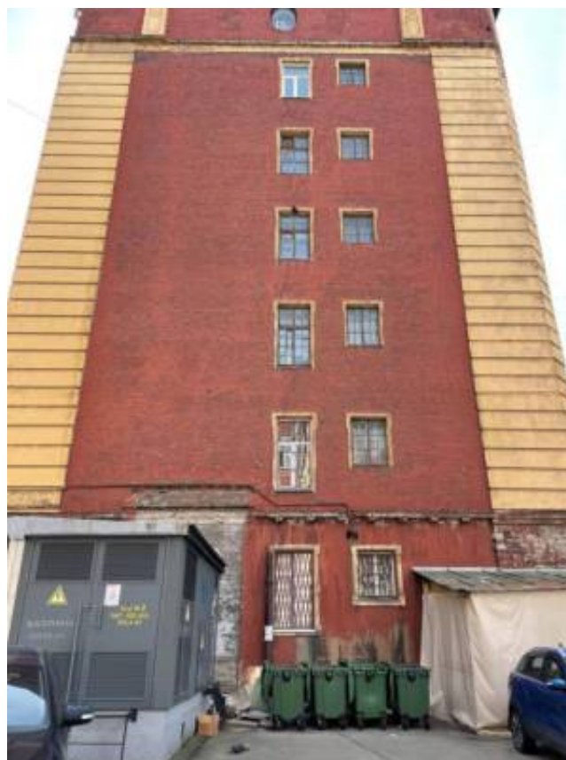
Фото 4. Фрагмент дворового фасада объекта культурного наследия регионального значения «Лицевой корпус Литера А с двумя дворовыми корпусами», входящего в состав объекта культурного наследия регионального значения «Дома Каменноостровского товарищества для устройства постоянных квартир»
