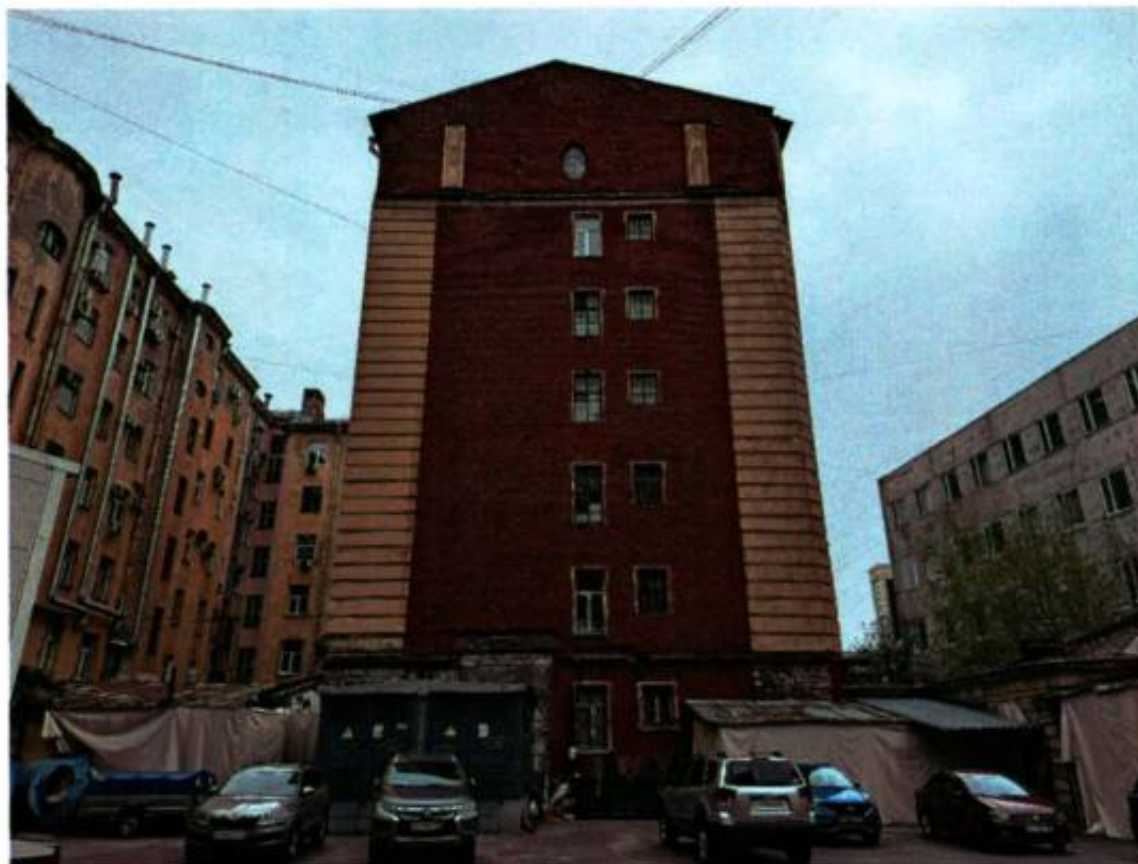
4. Северный фасад западного дворового корпуса. Фото от 13.05.2024.
