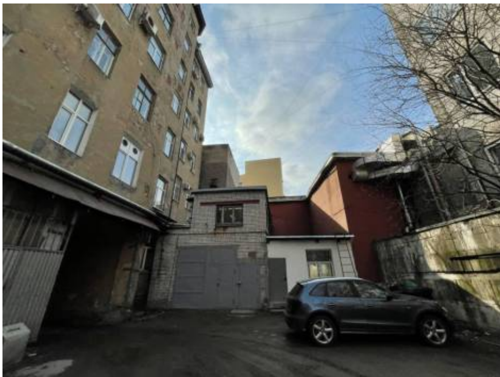
Фото 3. Фрагмент дворового фасада объекта культурного наследия регионального значения «Лицевой корпус Литера А с двумя дворовыми корпусами», входящего в состав объекта культурного наследия регионального значения «Дома Каменноостровского товарищества для устройства постоянных квартир»
