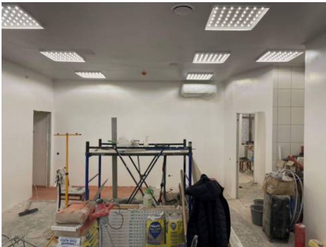
Фото 13. Интерьер помещения 102-Н объекта культурного наследия регионального значения «Лицевой корпус Литера А с двумя дворовыми корпусами», входящего в состав объекта культурного наследия регионального значения «Дома Каменноостровского товарищества для устройства постоянных квартир»
