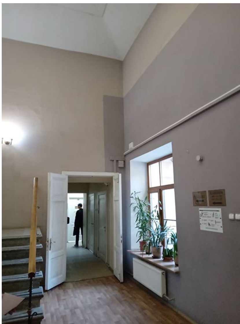
Фото 30. Объект культурного наследия федерального значения «Дом Пашковых», расположенный по адресу: г. Санкт-Петербург, наб. реки Фонтанки, д.18, лит. А.
