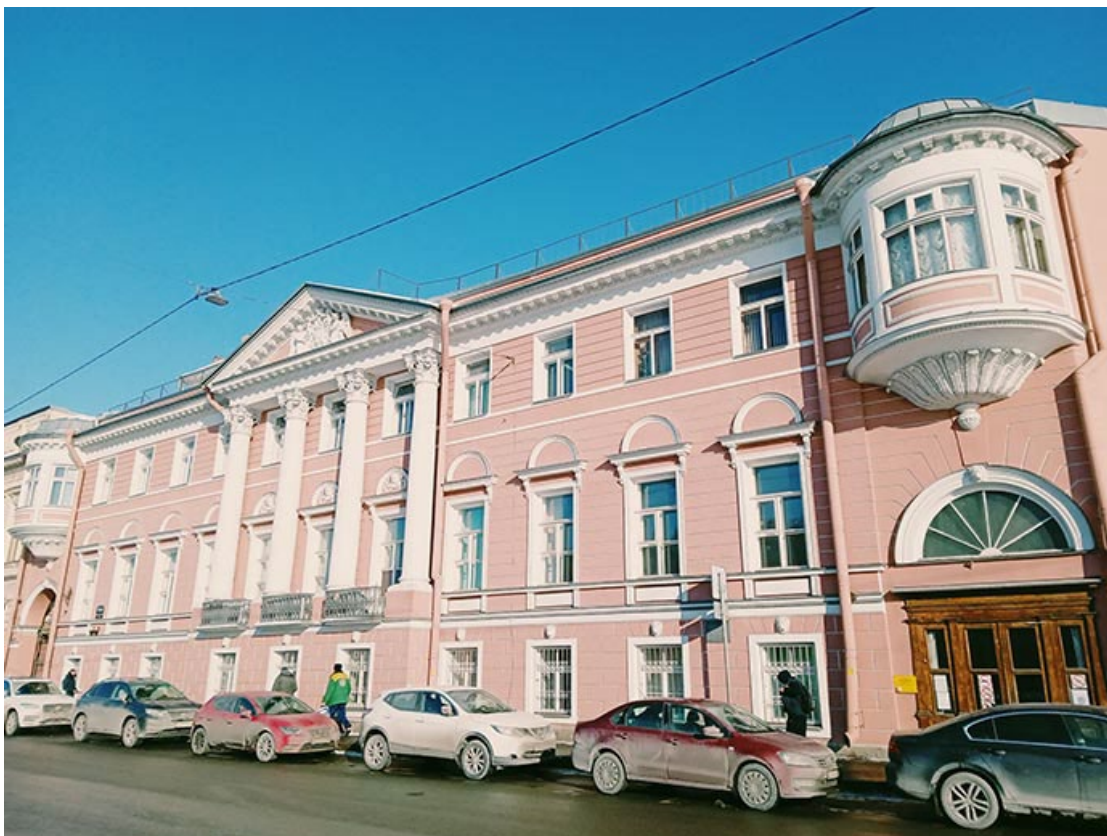
Фото 1. Объект культурного наследия федерального значения «Дом Пашковых», расположенный по адресу: г. Санкт-Петербург, наб. реки Фонтанки, д.18, лит. А.
