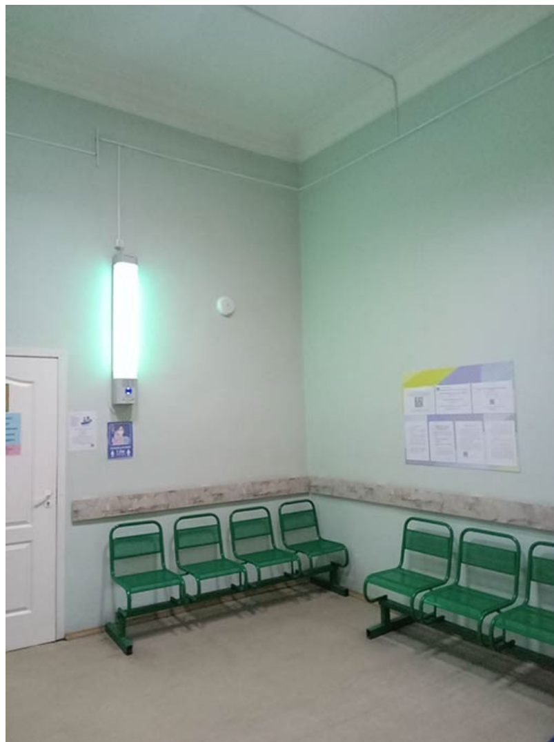
Фото 28. Объект культурного наследия федерального значения «Дом Пашковых», расположенный по адресу: г. Санкт-Петербург, наб. реки Фонтанки, д.18, лит. А.
