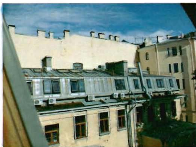
15. Мансардная надстройка над 3-им этажом
