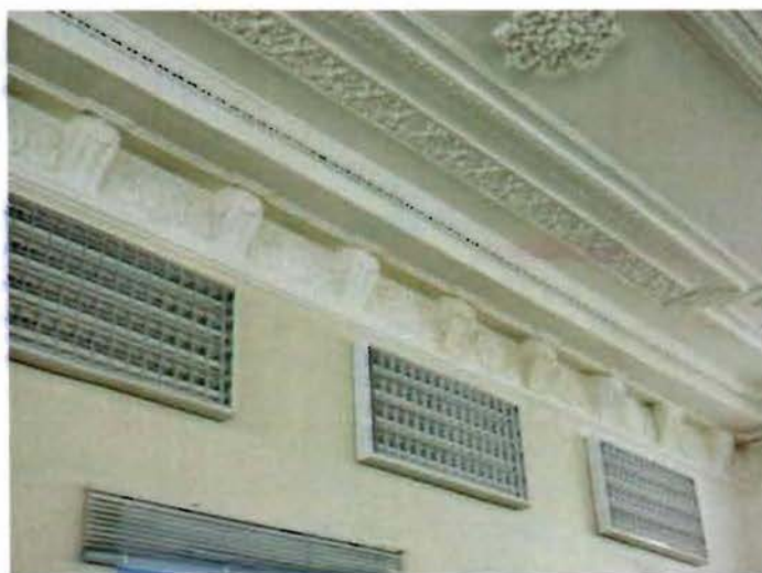
21. Лепной профилированный карниз
