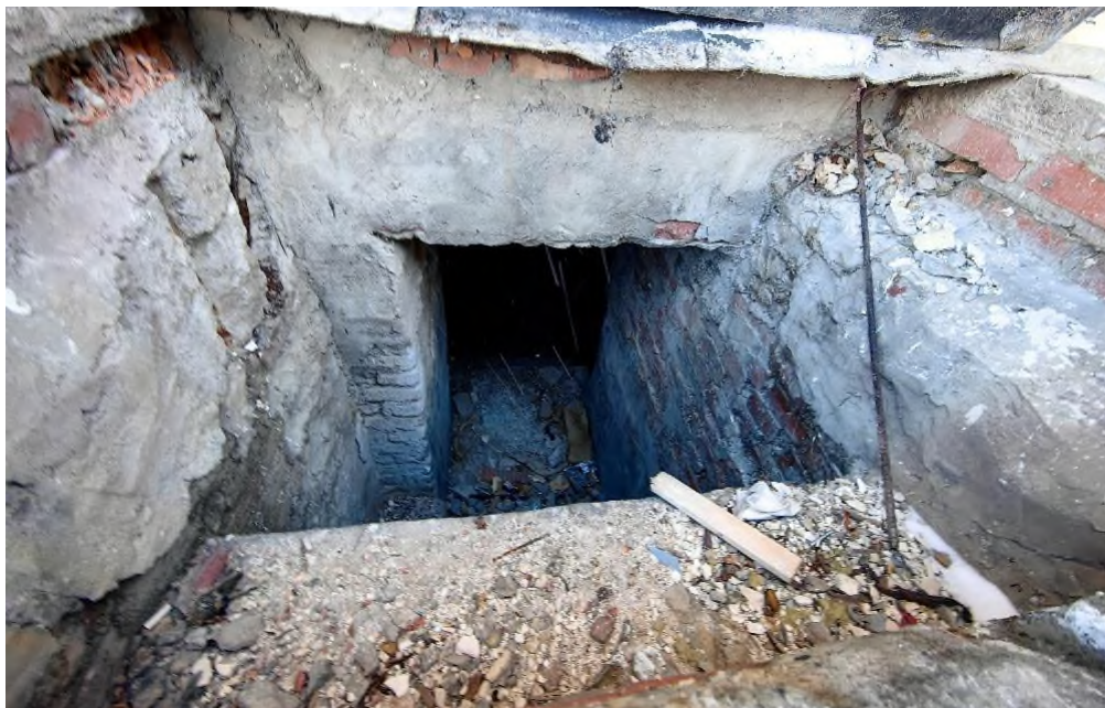
Точка фотофиксации №4. Вид на приямок в помещении 17-Н с дворового фасада (09.02.2026)
