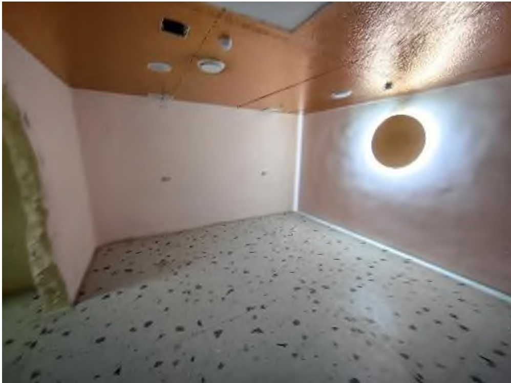
Точка фотофиксации № 15. Вид на помещение подвала (№5) (09.02.2026)
