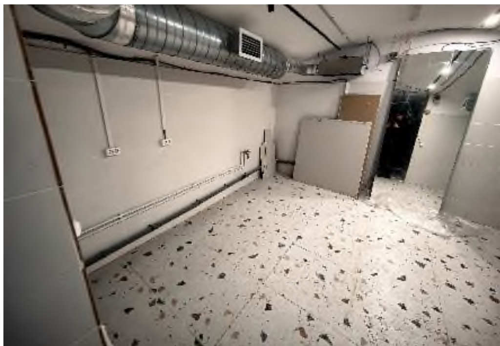
Точка фотофиксации № 18. Вид на помещение подвала (№7) (09.02.2026)
