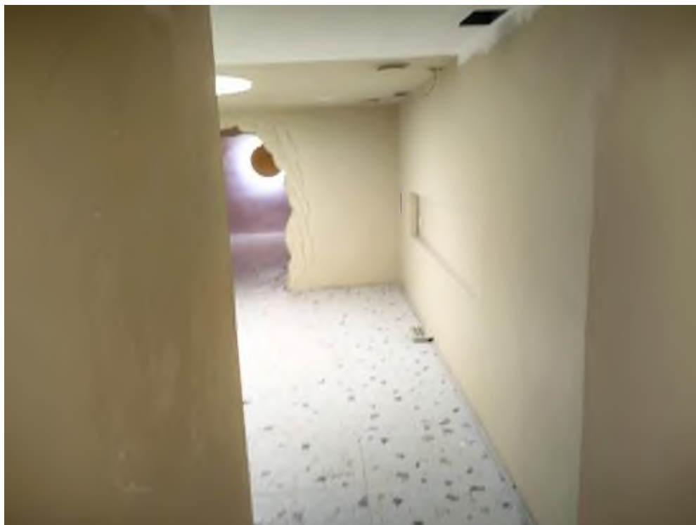
Точка фотофиксации № 13. Вид на помещение подвала (№5) от лестницы (09.02.2026)
