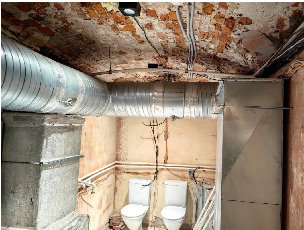
Точка фотофиксации № 11. Вид на помещение подвала (№4) (09.02.2026)
