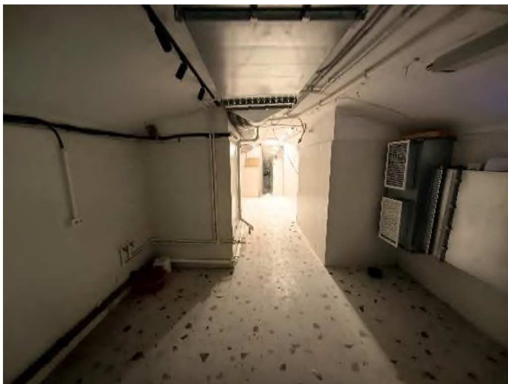
Точка фотофиксации № 17. Вид на помещение подвала (№6) (09.02.2026)
