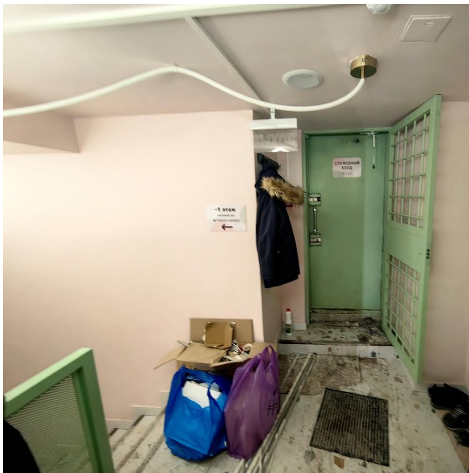
Точка фотофиксации № 9. Вид на выход во двор из лестничного холла (№2) (09.02.2026)
