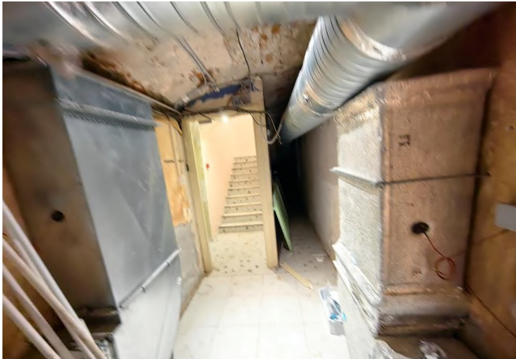
Точка фотофиксации № 12. Вид из помещение подвала (№4) на лестницу (09.02.2026)
