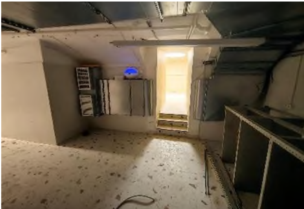
Точка фотофиксации № 16. Вид на помещение подвала (№7) (09.02.2026)
