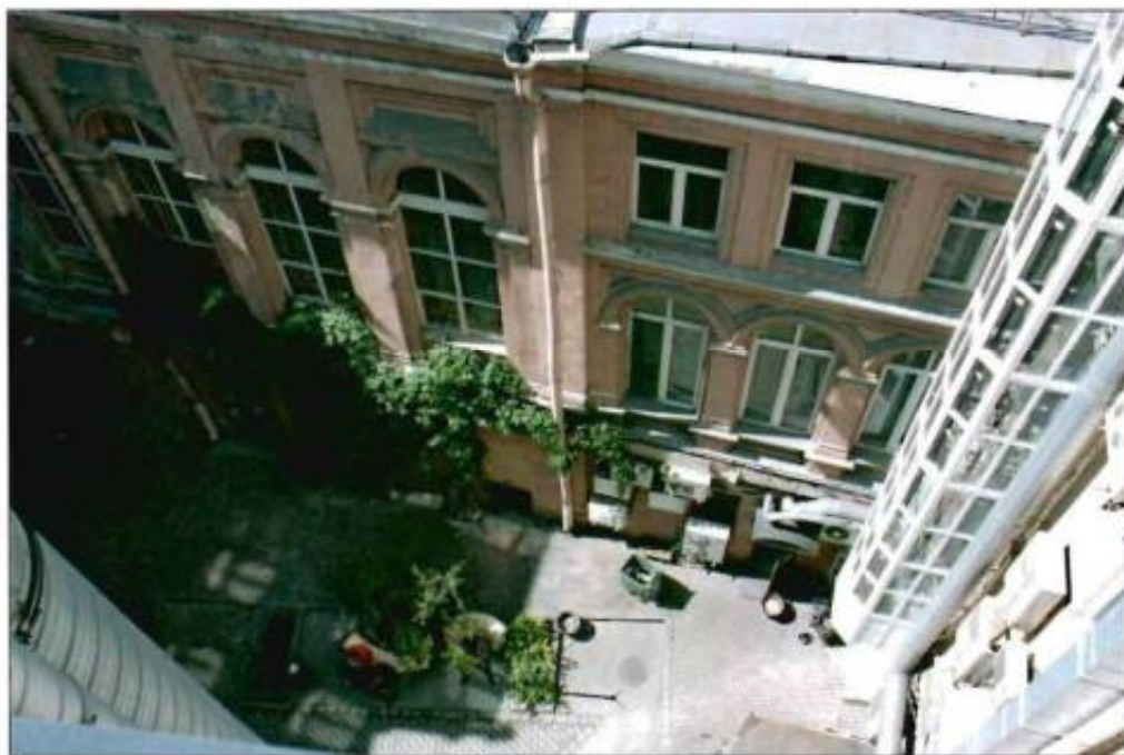
Фото №20. Северный внутренний двор.
