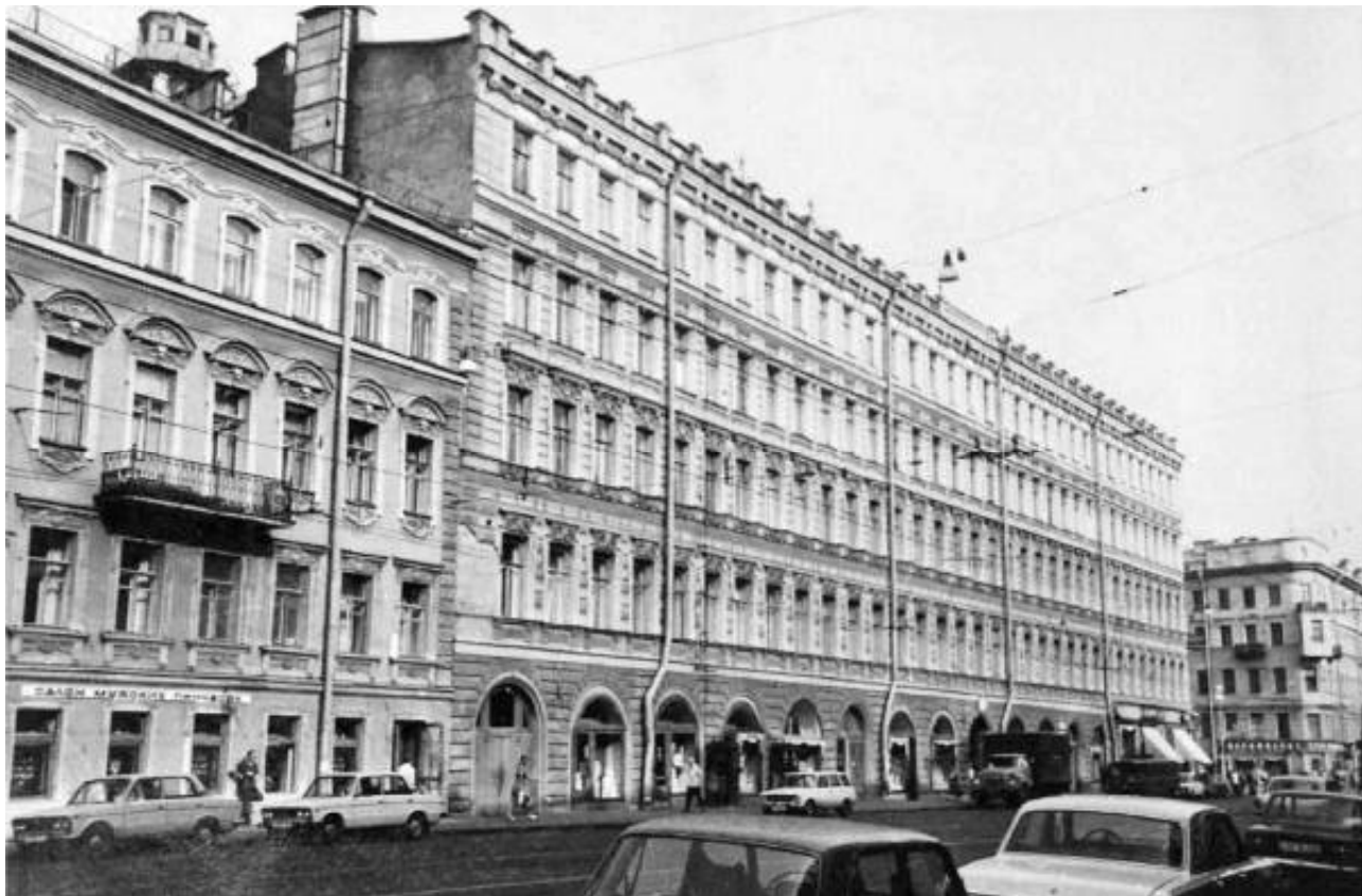
Илл.73. Фасад жилого дома на Владимирском проспекте. Фото 1970-е гг. ЦГАКФФД СПб. Фотодокументы. Опись 1АР-144. Ед.хр.189824.
