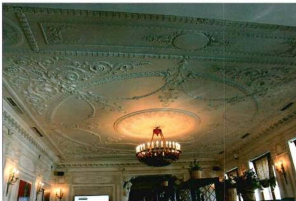
Фото №3, 4. Помещение 58-Н (1) 2-го этажа.
