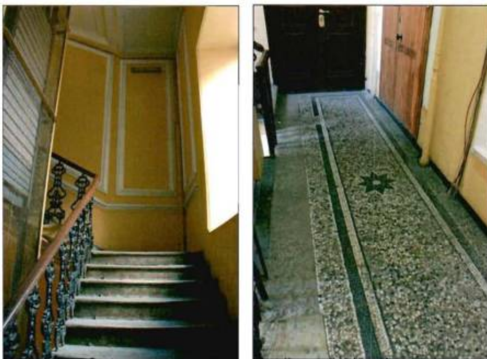
Фото №9, 10. Межэтажная трехмаршевая лестница (1ЛК).
