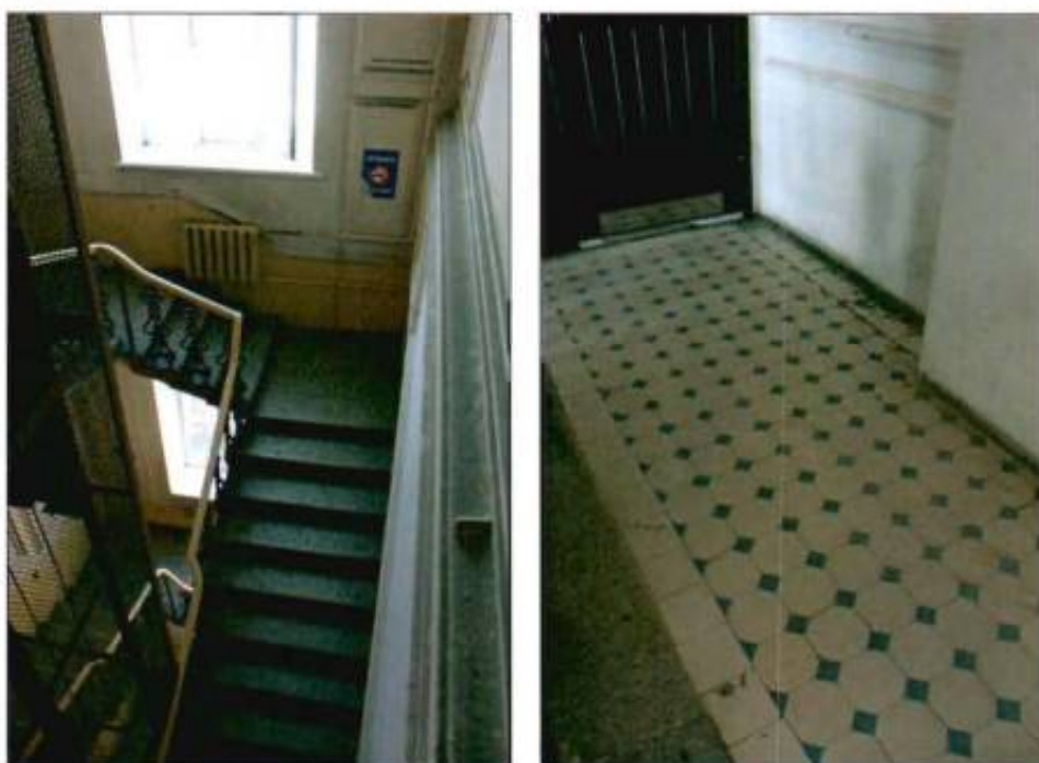
Фото №11, 12. Межэтажная трехмаршевая лестница (2ЛК).
