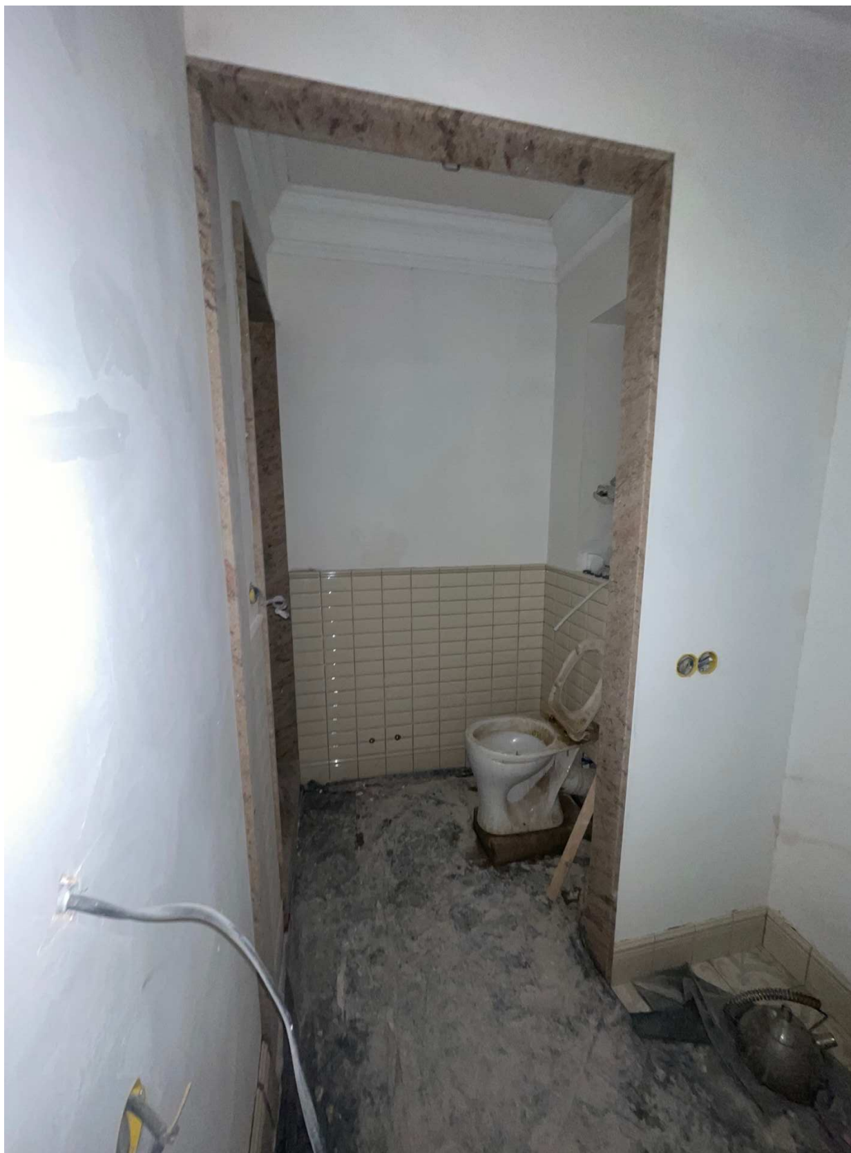
11.Фрагмент интерьера туалета (помещение 5)
