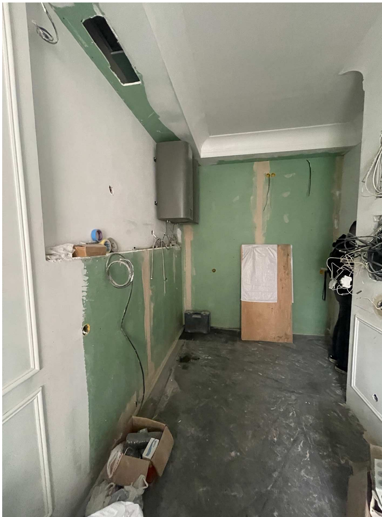
8. Фрагмент интерьера кухни (помещение 6/17.5)
