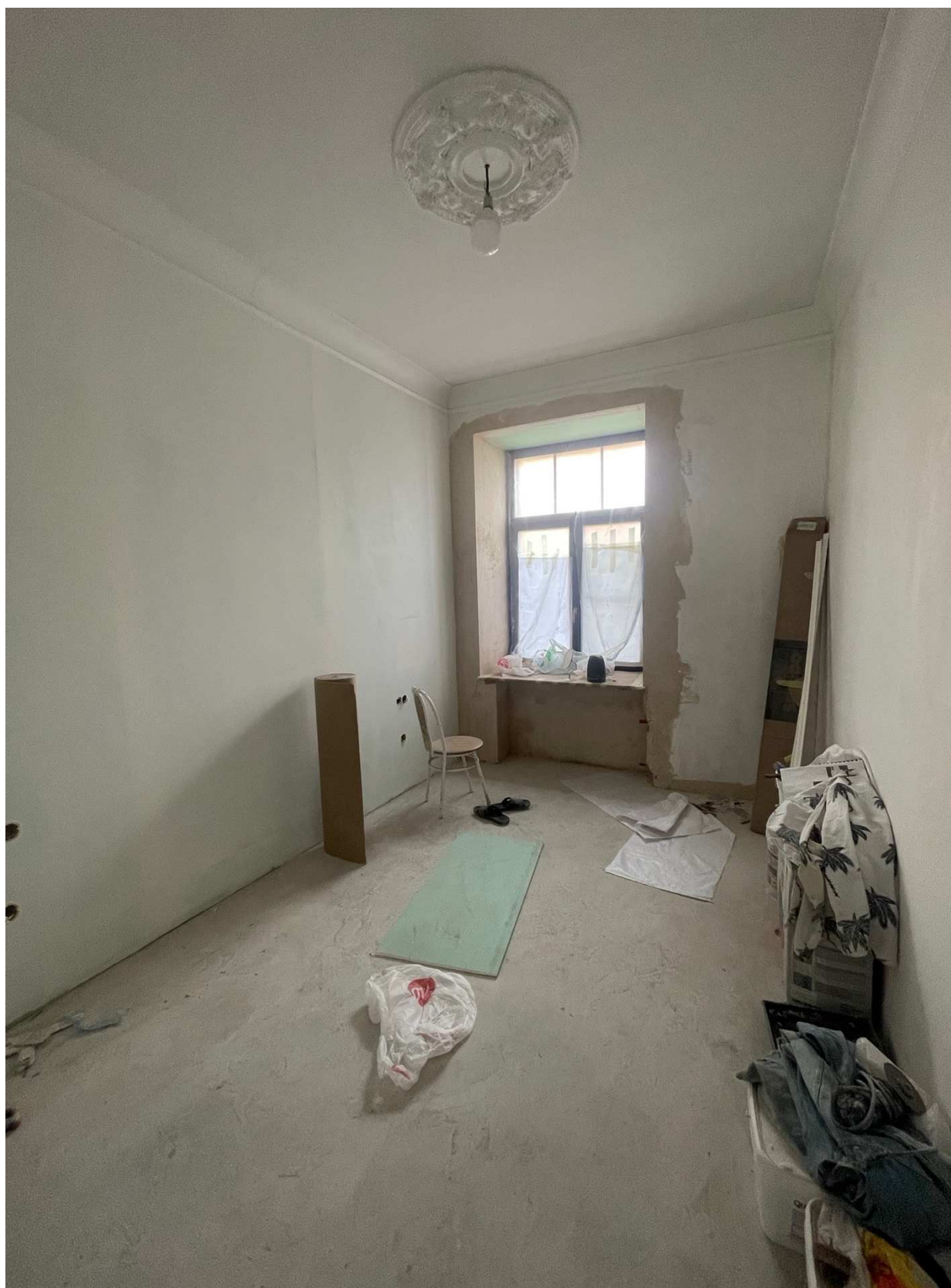
12.Фрагмент интерьера комнаты (помещение 3/14.8)
