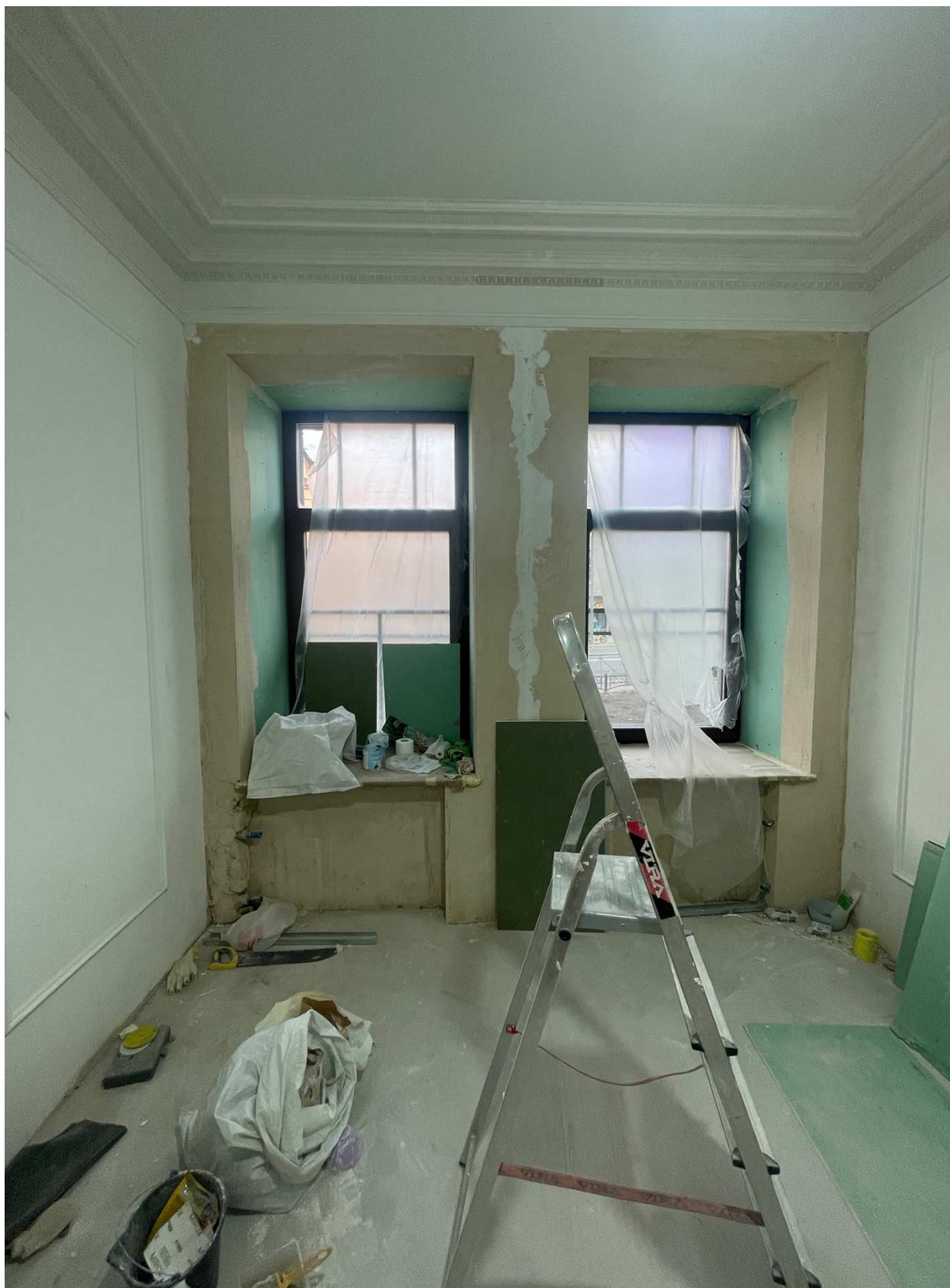
14.Фрагмент интерьера комнаты (помещение 2/14.7)
