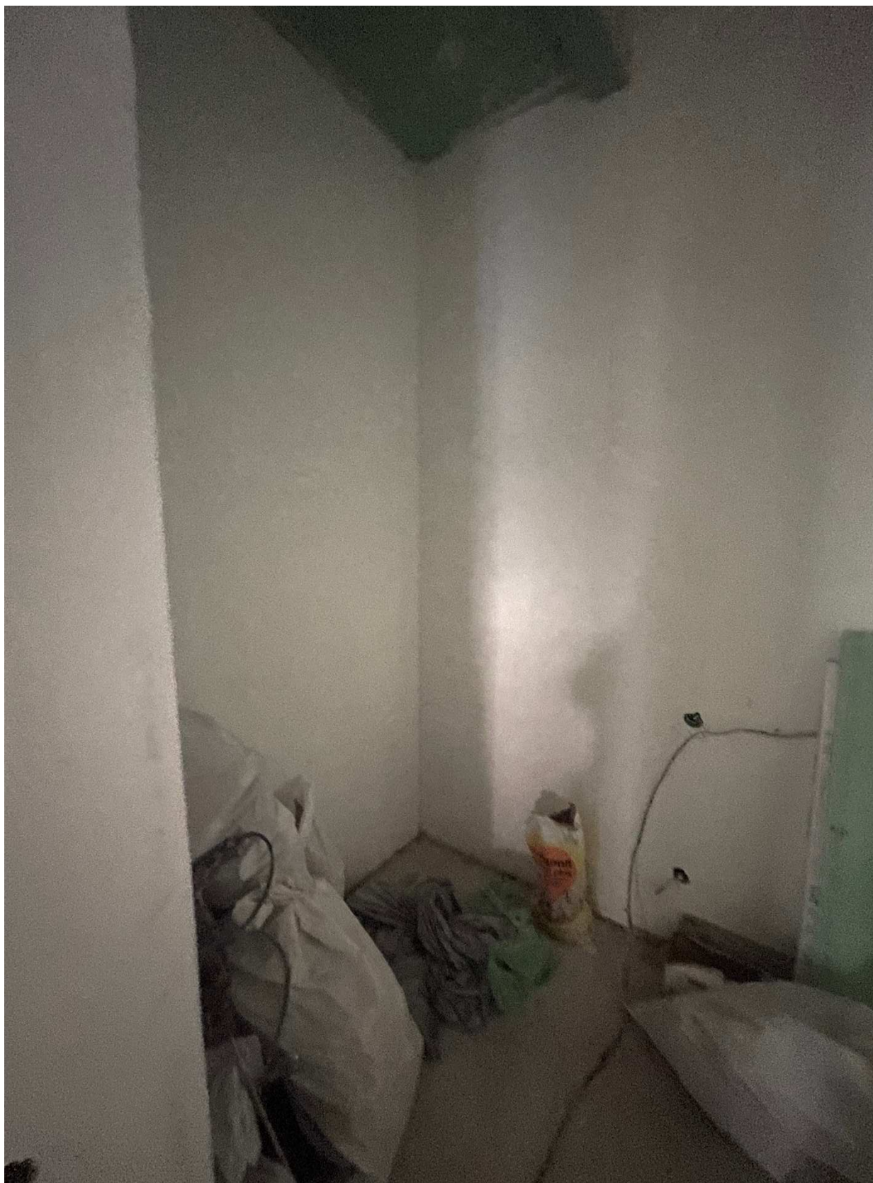
6. Фрагмент интерьера кухни (помещение 6/17.5)
