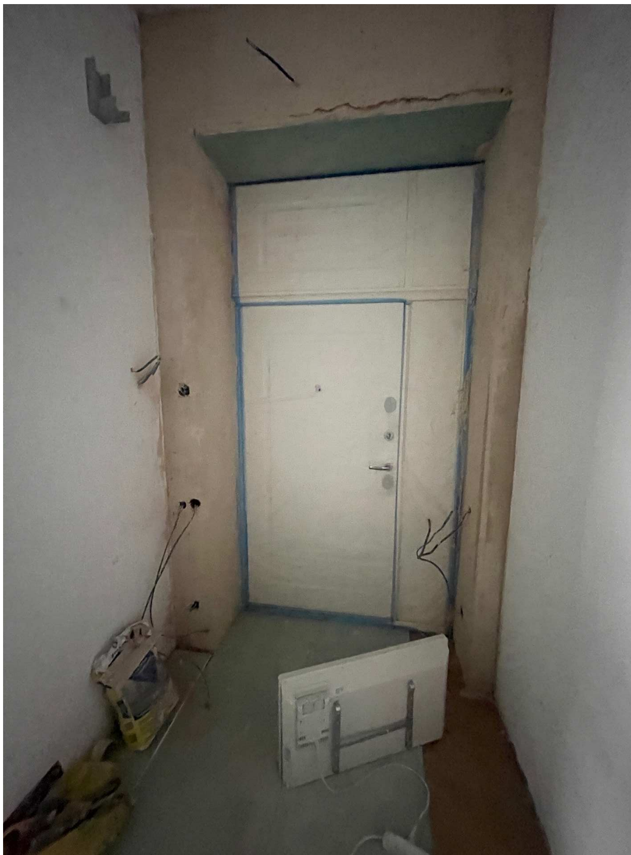
4. Вид на входную дверь в квартире
