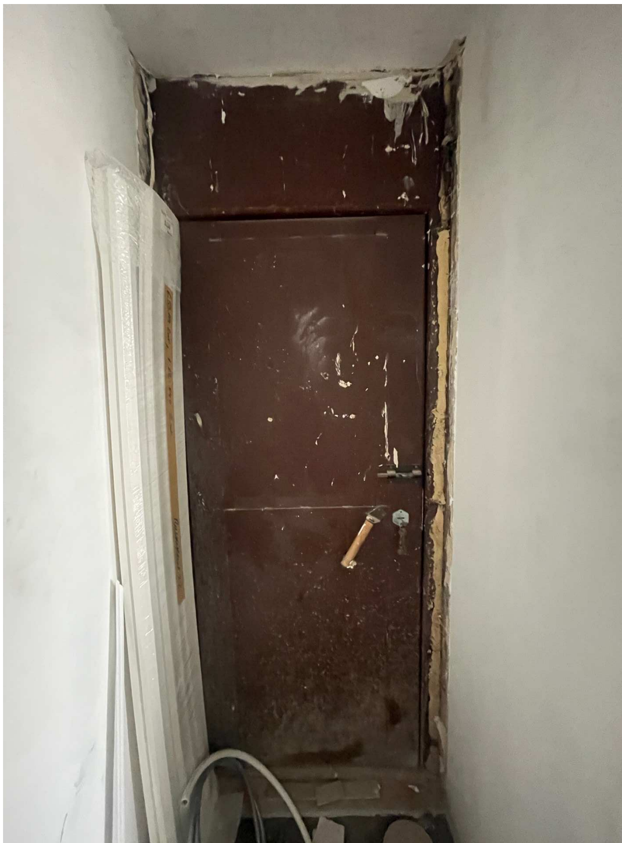
9. Вид на входную дверь в квартире;
