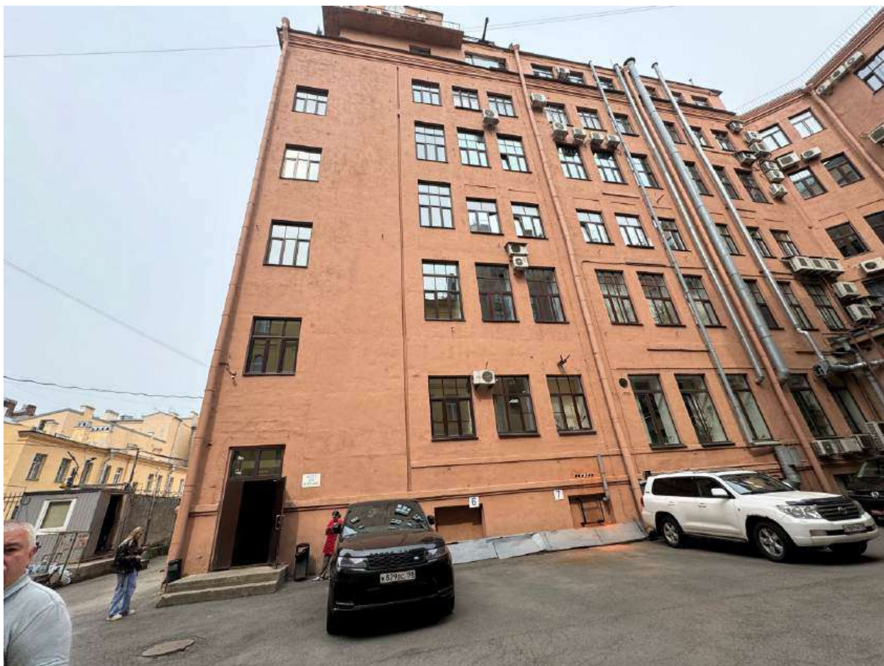
Фото 7. Вид на дворовые фасады объекта культурного наследия.
