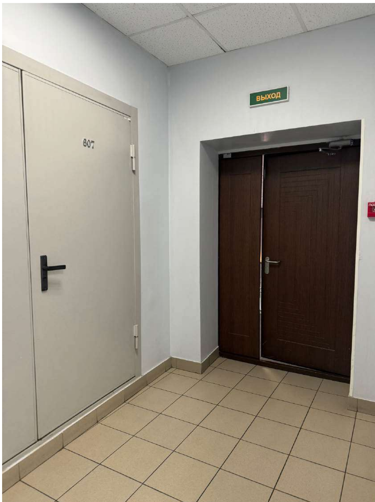
Фото 14. Вид на интерьер помещения объекта культурного наследия.
