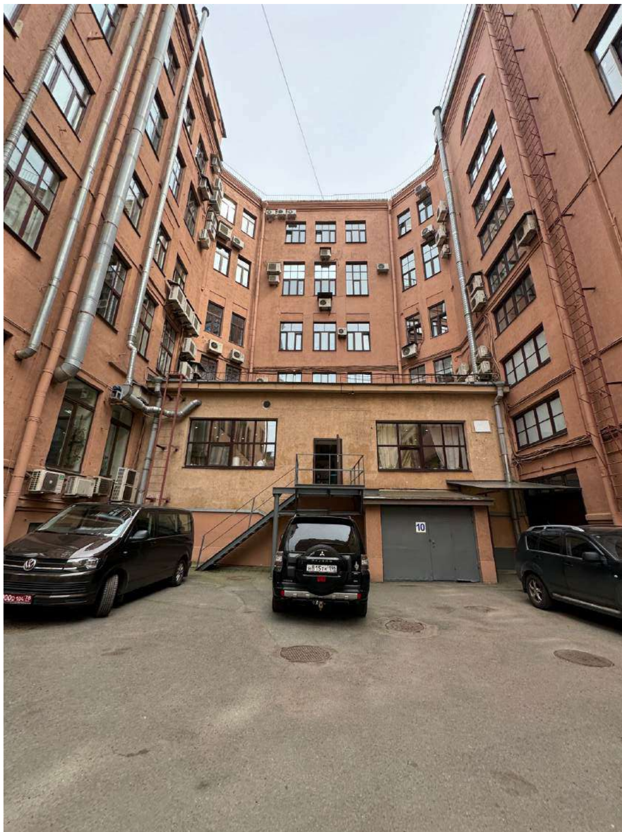
Фото 6. Вид на дворовые фасады объекта культурного наследия.
