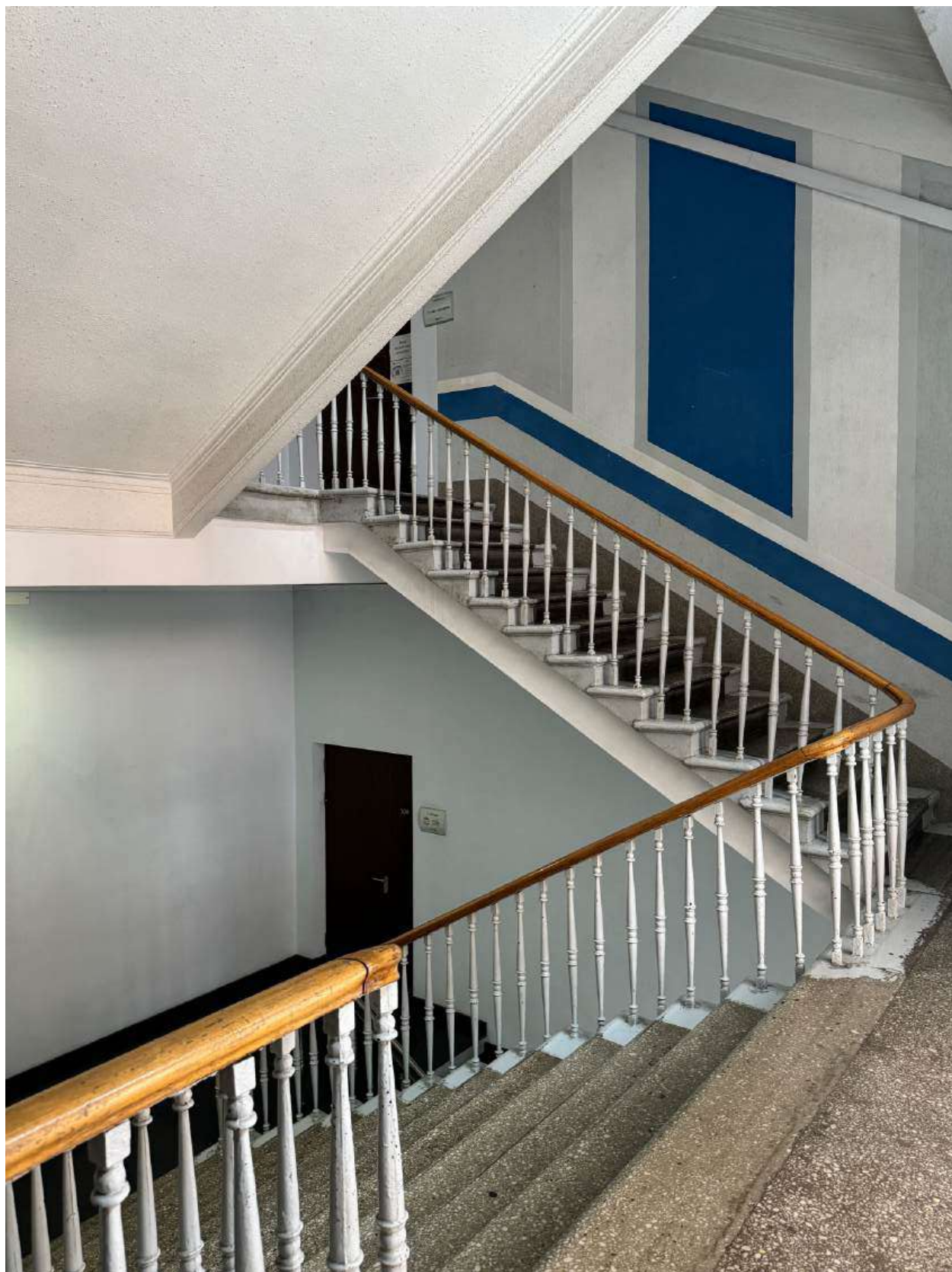
Фото 67. Вид на парадную лестницу объекта культурного наследия.
