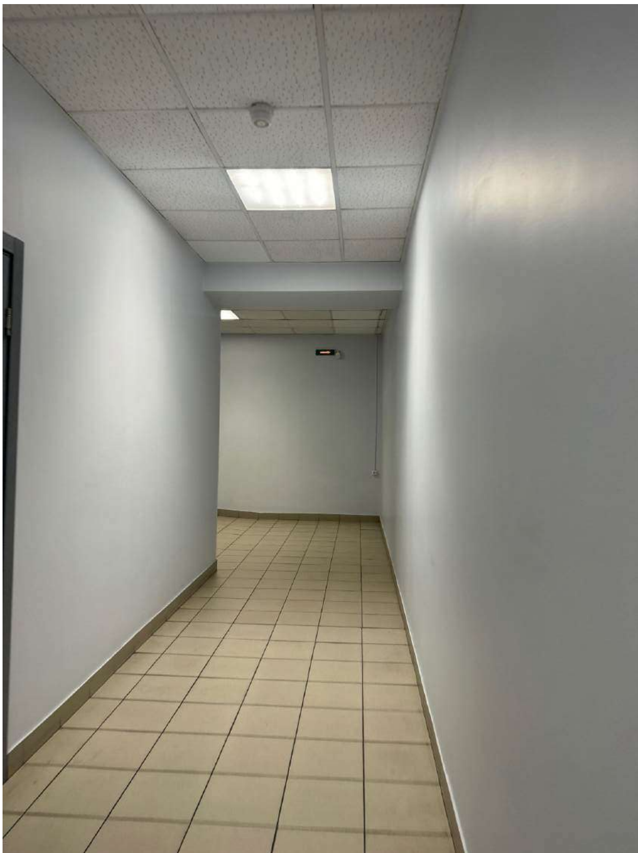
Фото 20. Вид на интерьер помещения объекта культурного наследия.
