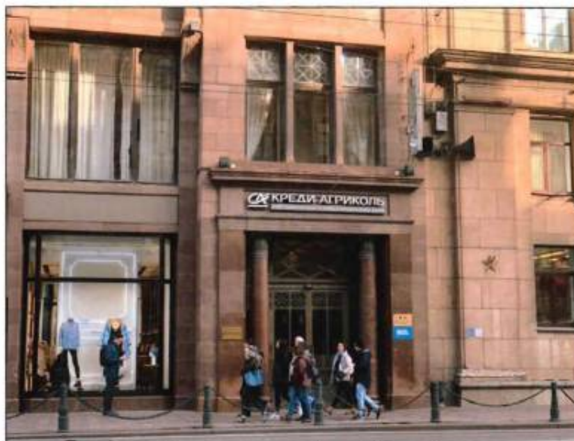
2. Фрагмент южного фасада. Парадный вход.
