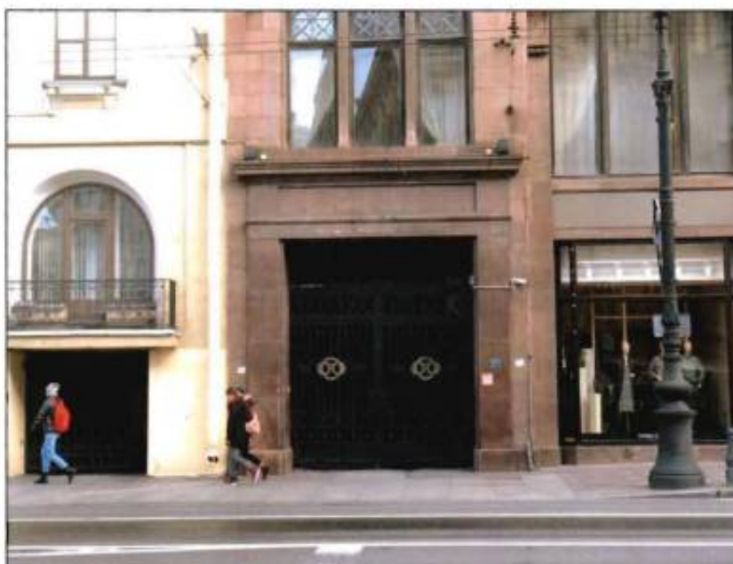
3. Фрагмент южного фасада. Воротный проезд.
