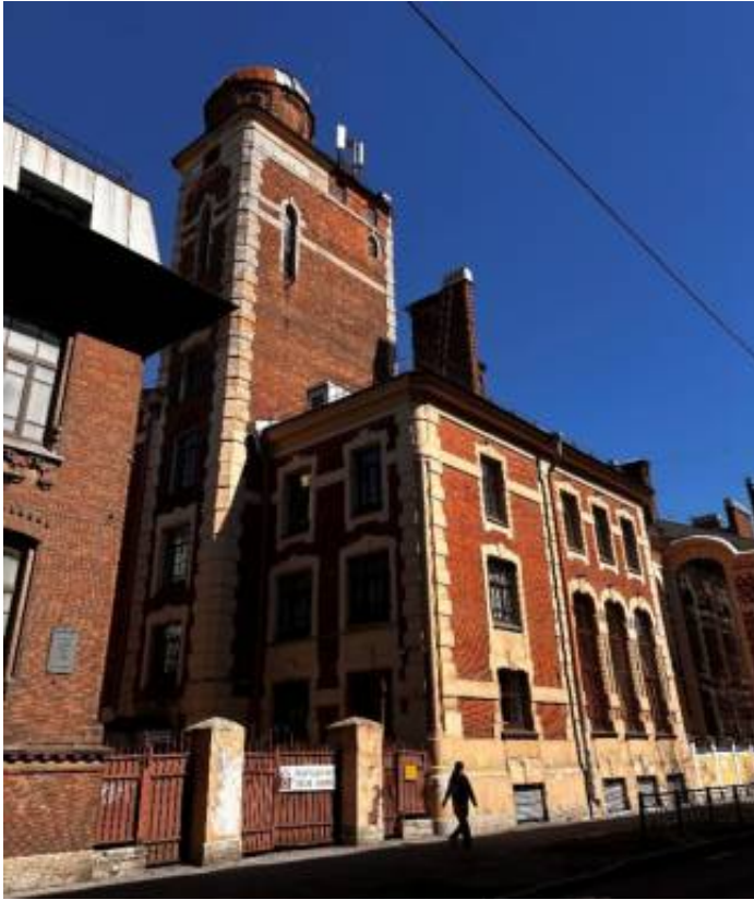
Фото 7. Фрагмент фасада по ул. Прилукская.
