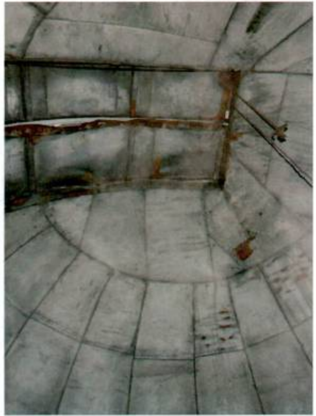
19. Купол обсерватории (вид изнутри).
