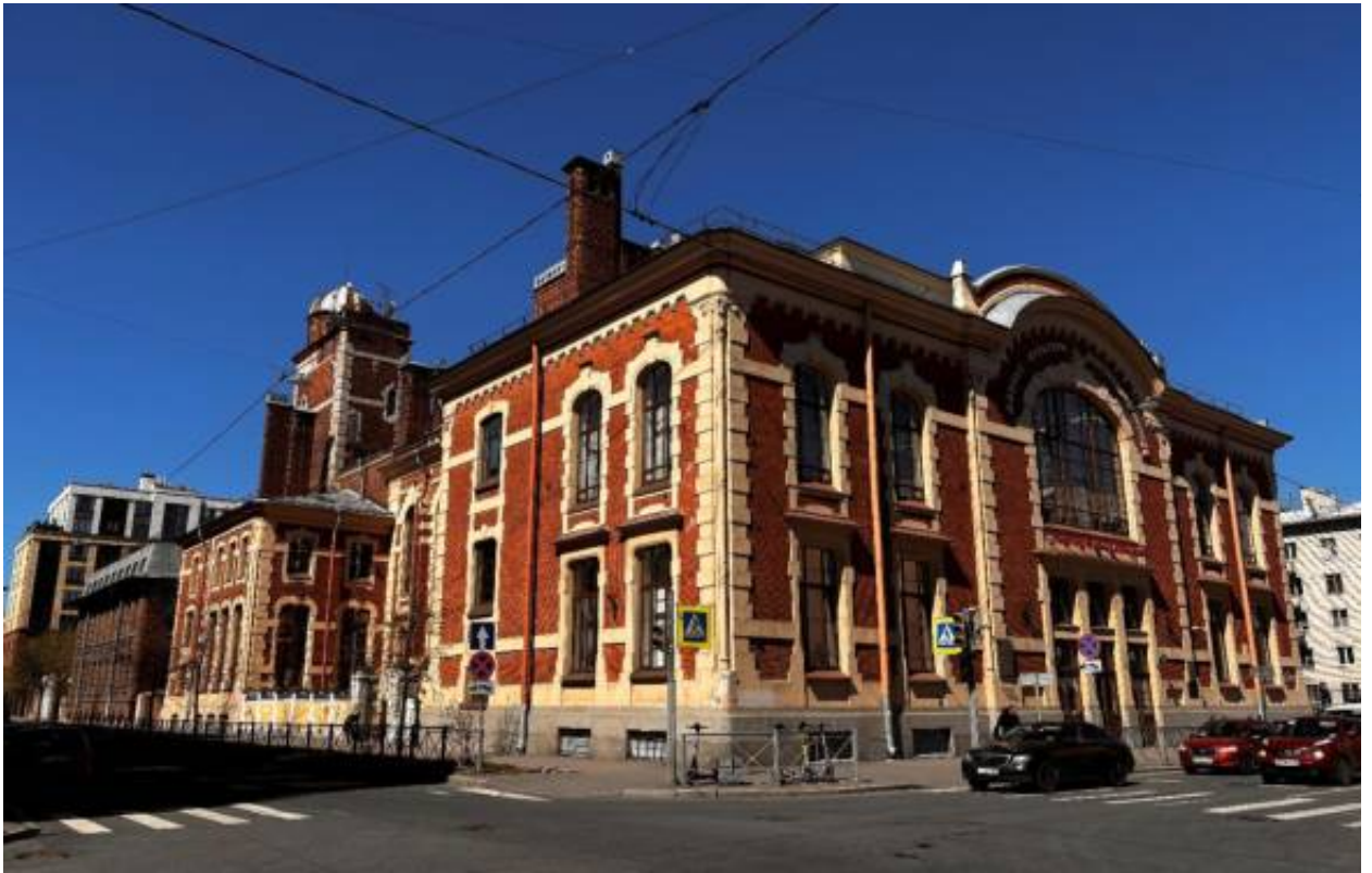
Фото 1. Общий вид на объект с перекрестка.
