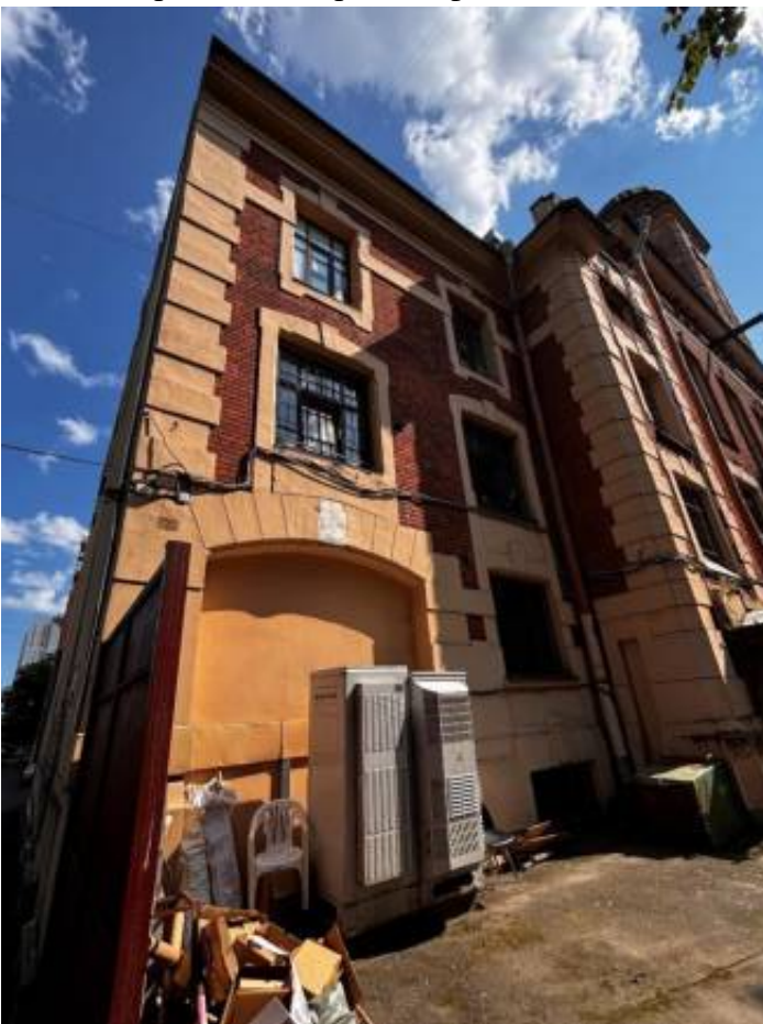
Фото 10. Фрагмент дворового фасада.
