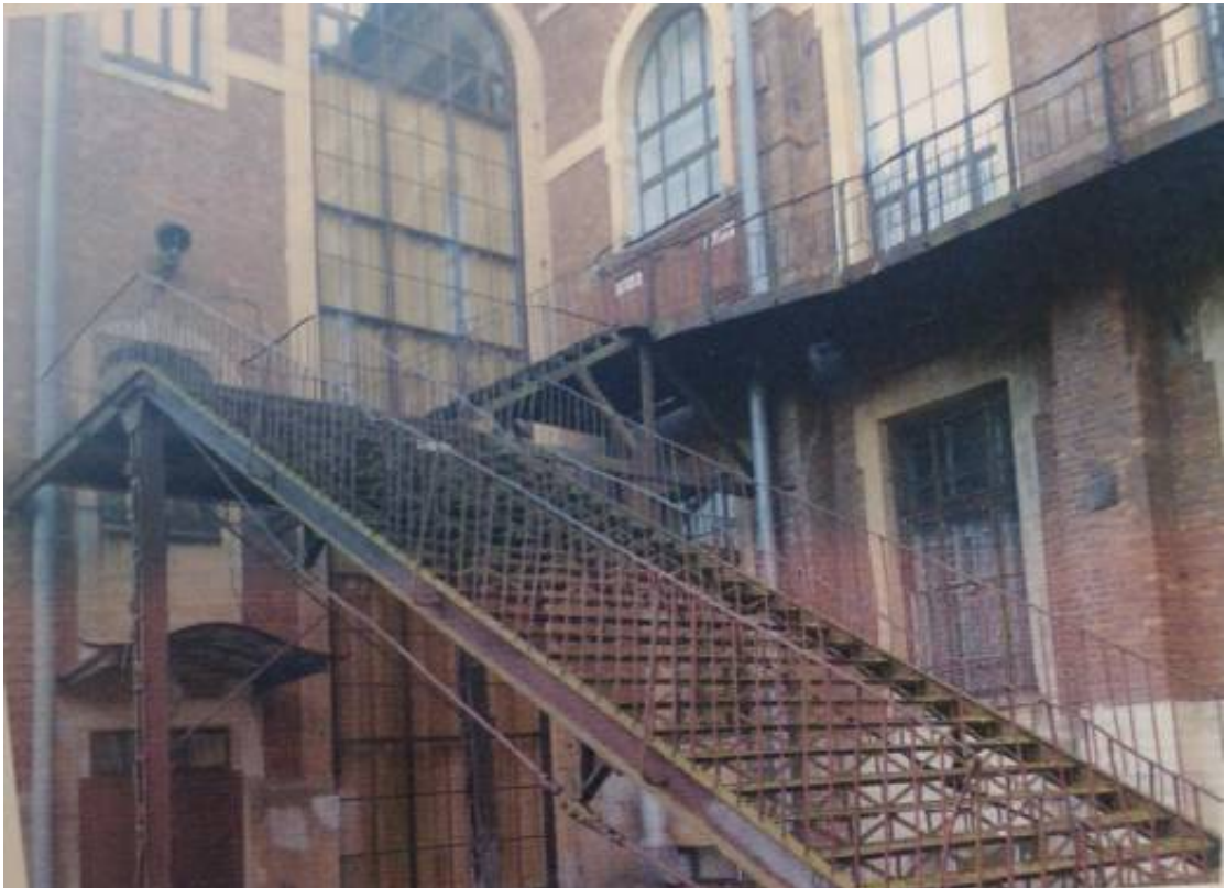
Илл. 80. Народный дом Паниной - ДК железнодорожников. Общий вид дворовой лестницы. 2007 г. // Архив КГИОП. № п. 655 пр.-3. Проект реставрации лестницы, галереи и ограды. Раздел «ОБ». ТОМ №1.2. Фотофиксация. ЗАО «Акме-дек». СПб., 2007 г.
