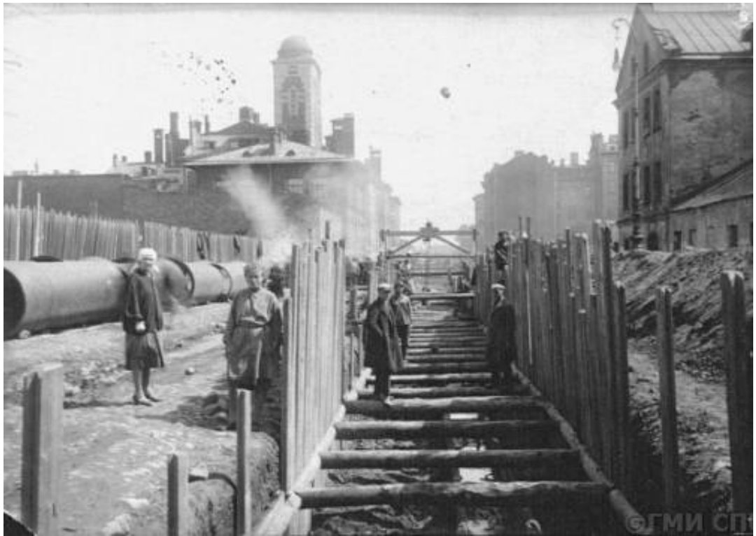
Илл. 47. Прилукская улица. Прокладка канализационных труб. Перспективный вид от Лиговского проспекта в сторону Тамбовской улицы; слева видна обсерватория Лиговского народного дома (Народный дом С. В. Паниной). 1931 г. // https://goskatalog.ru/portal/#/collections?id=34746408 (Номер в Госкаталоге: 34545880. Номер по КП (ГИК): ГМИ СПб 232949. Инвентарный номер: ГМИ СПб Инв.№-П-А-2919 ф)
