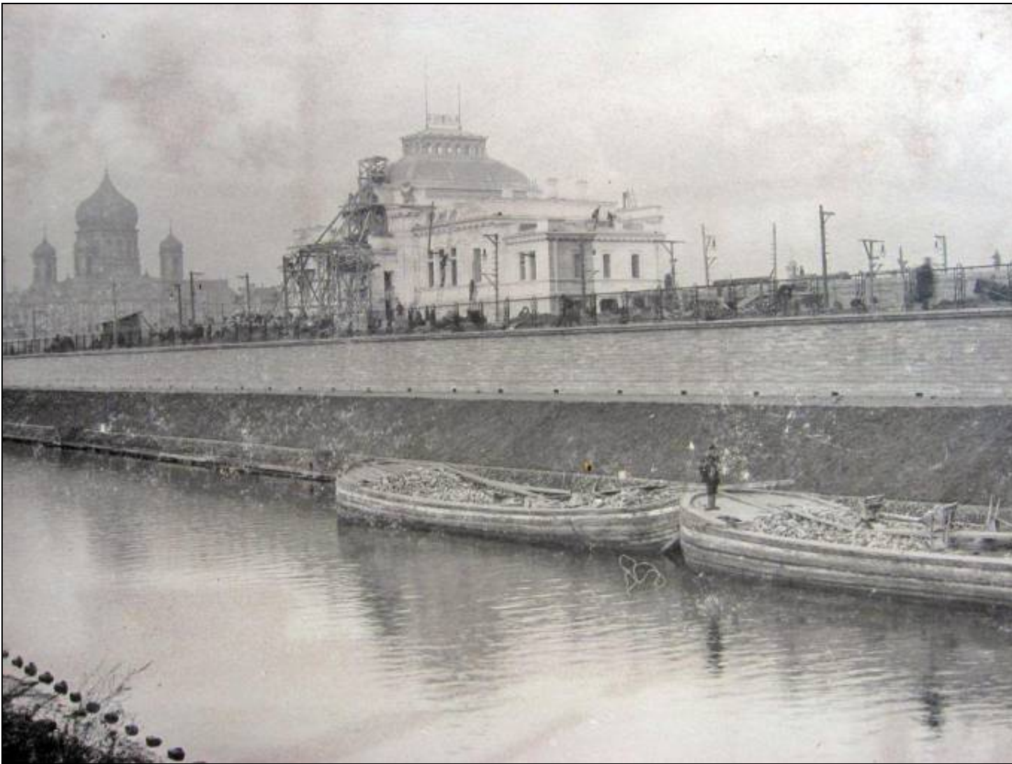
Илл. 19. Вид на Царский павильон со стороны Введенского канала. Фотография. 1900-е гг. Автор съемки: неизвестен. ЦГАКФФД СПб. Шифр: В 4772.
