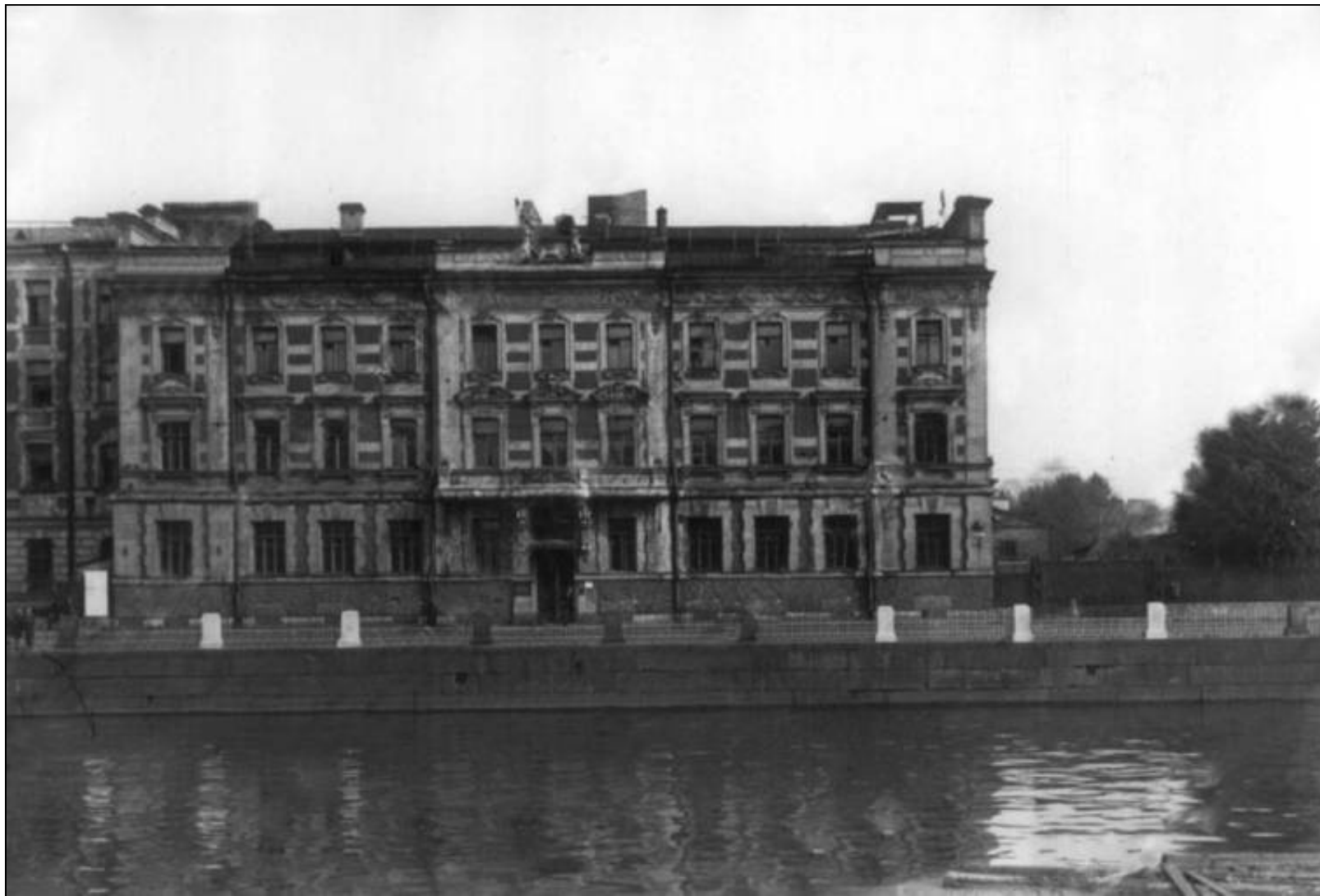
Илл. 24. Часть лицевого фасада дома № 104 на набережной реки Фонтанки. Фотография. 1939 г. Автор съемки: неизвестен. ЦГАКФФД СПб. Шифр: Вр 44309.
