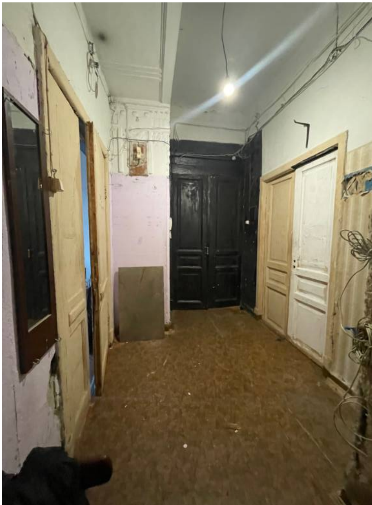
3. Входная дверь квартиры со стороны лестницы ЛК-2.
