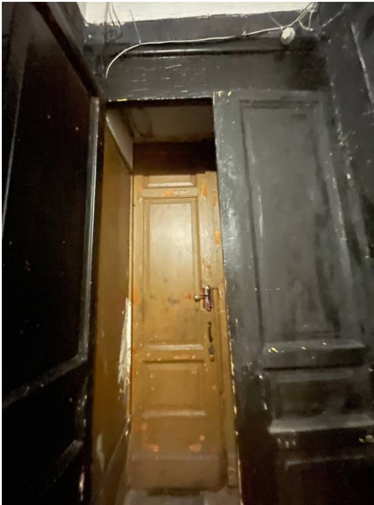
8. Тамбур входной двери со стороны лестницы ЛК-2.
