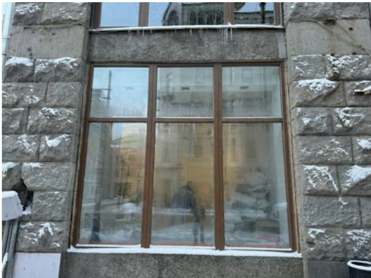
3. Оконный проем со стороны лицевого фасада.
