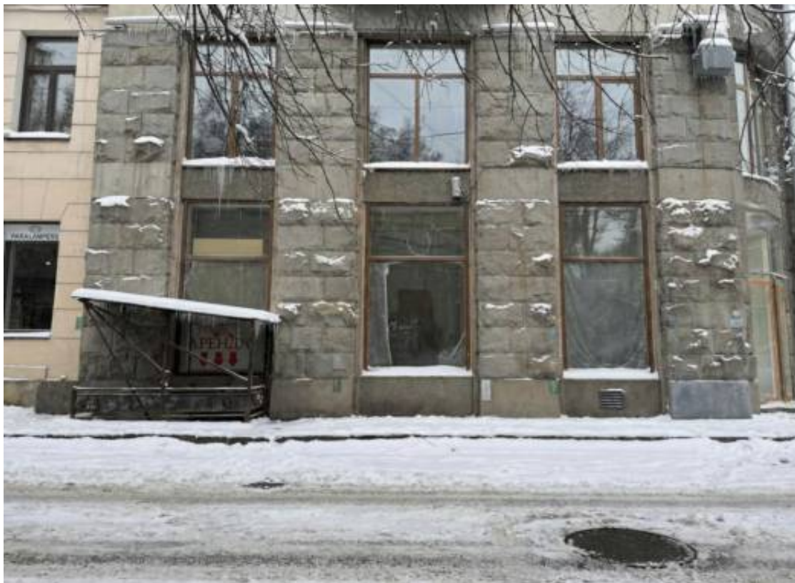
1. Фрагмент лицевого фасада. Оконные проемы помещения.
