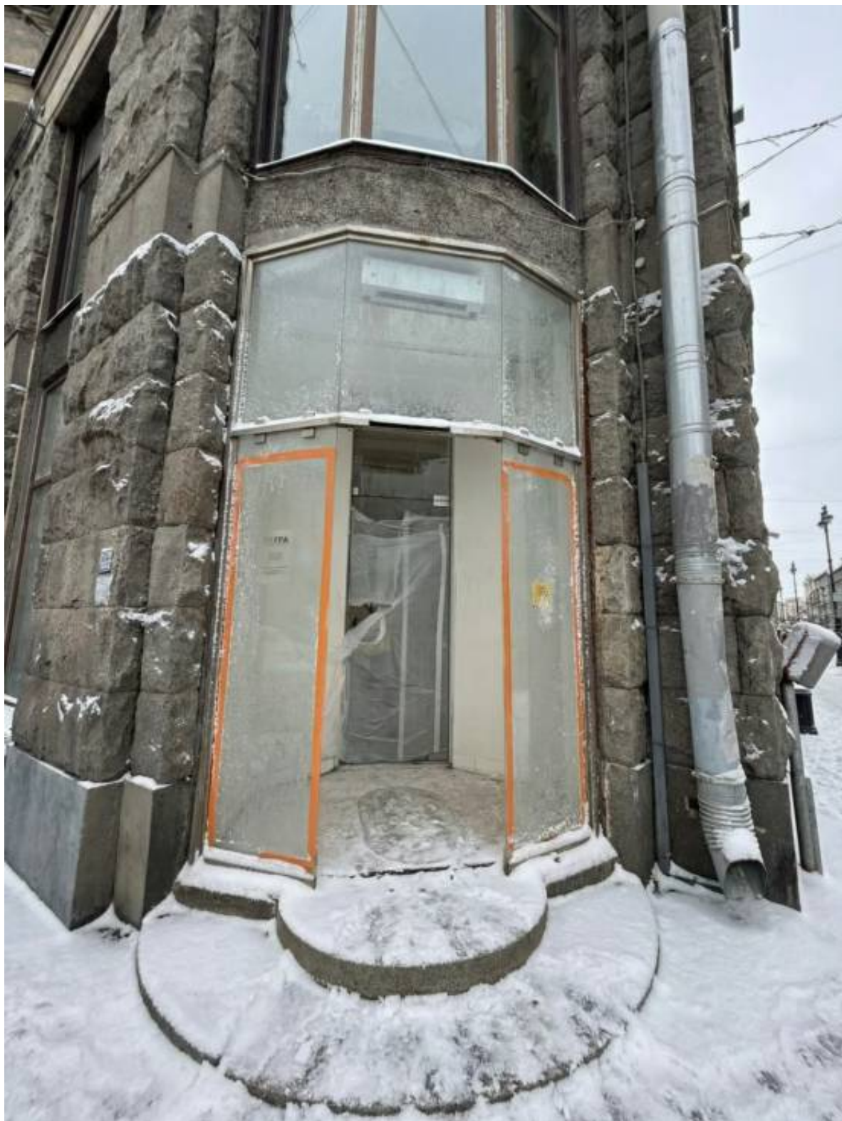
2. Фрагмент лицевого фасада. Дверной проем помещения.
