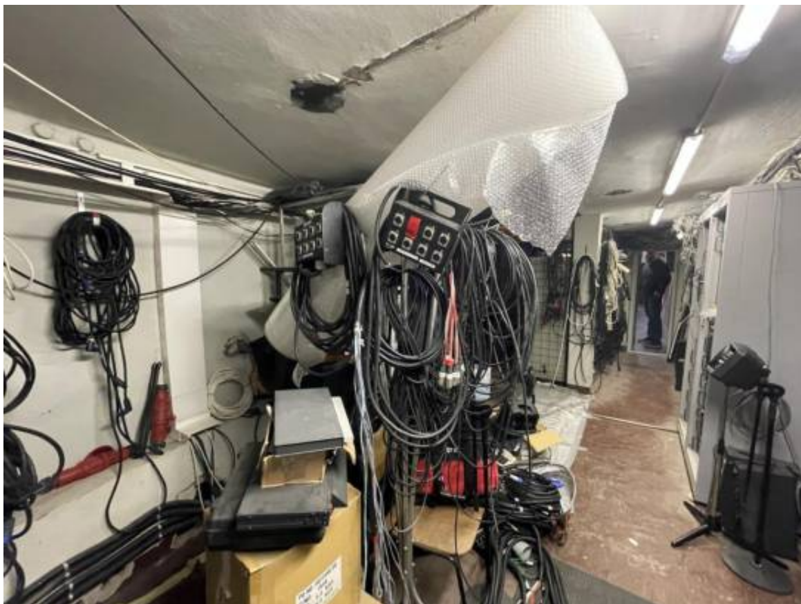
Фото 27. Интерьер подвального этажа объекта культурного наследия федерального значения «Театр Михайловский»
