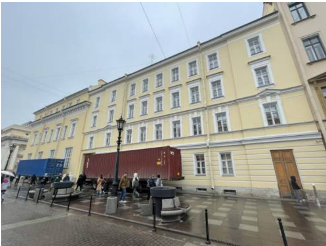
Фото 1. Фрагмент лицевого фасада объекта культурного наследия федерального значения «Театр Михайловский» (по наб. кан. Грибоедова)
