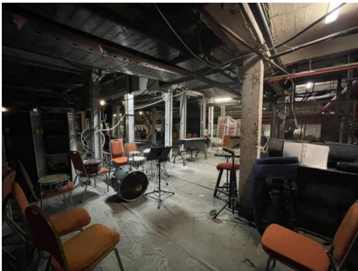
Фото 16. Интерьер подвального этажа объекта культурного наследия федерального значения «Театр Михайловский»
