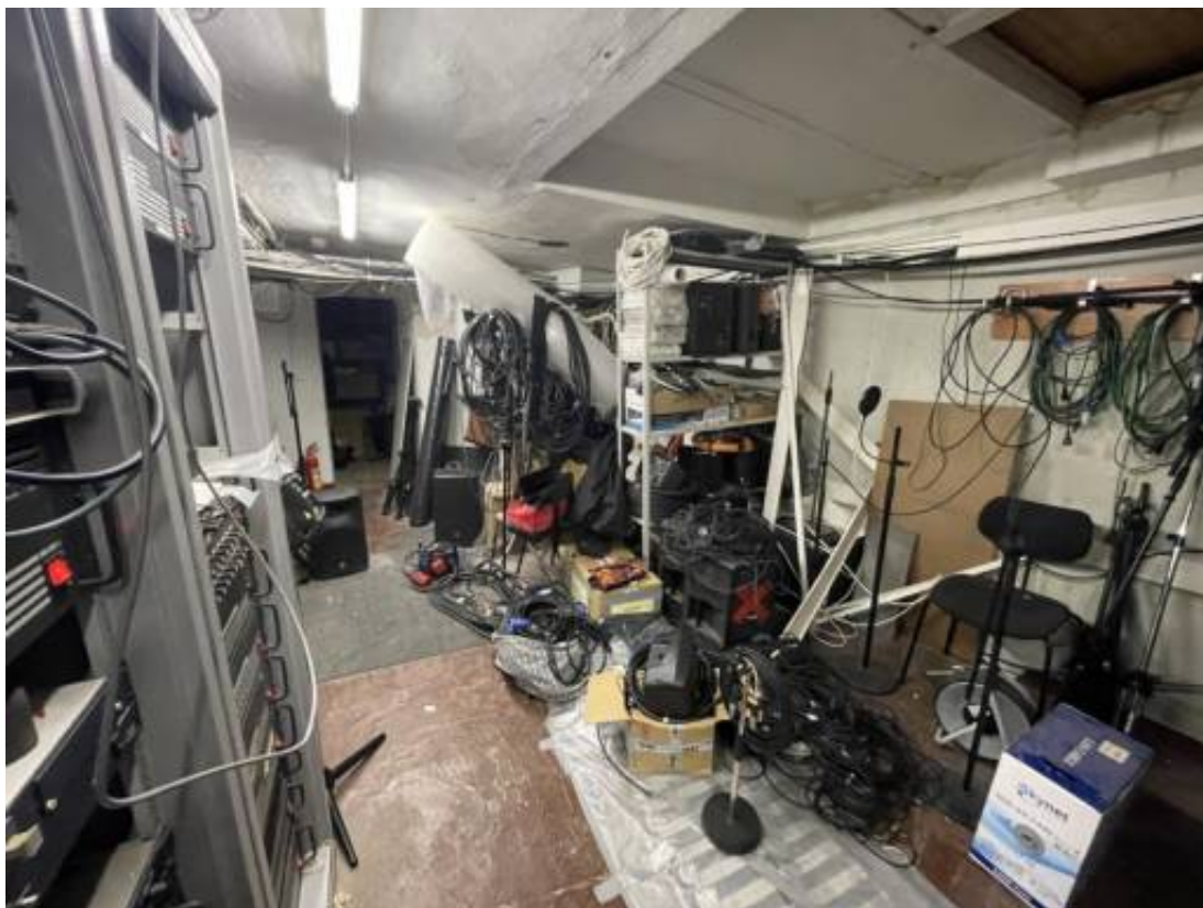
Фото 25. Интерьер подвального этажа объекта культурного наследия федерального значения «Театр Михайловский»
