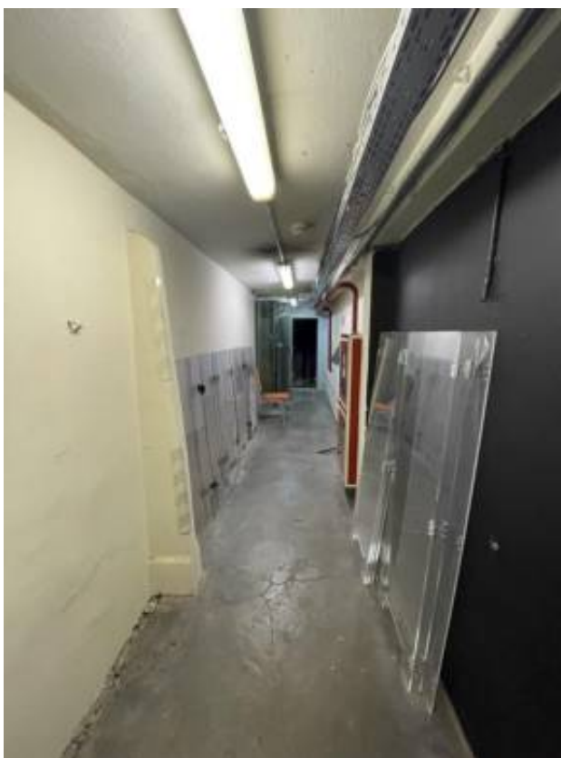
Фото 24. Интерьер подвального этажа объекта культурного наследия федерального значения «Театр Михайловский»
