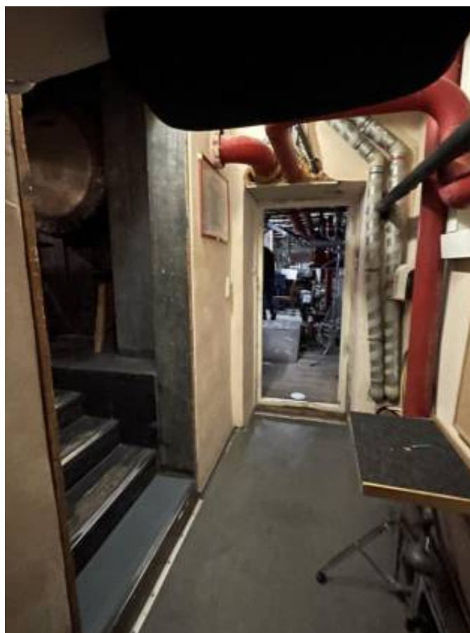
Фото 14. Интерьер подвального этажа объекта культурного наследия федерального значения «Театр Михайловский»
