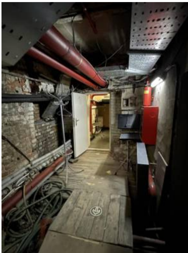
Фото 15. Интерьер подвального этажа объекта культурного наследия федерального значения «Театр Михайловский»
