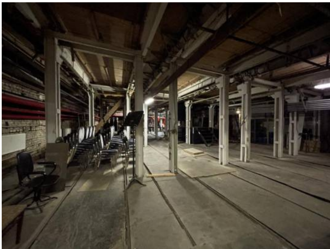
Фото 20. Интерьер подвального этажа объекта культурного наследия федерального значения «Театр Михайловский»
