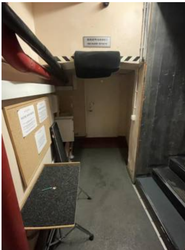
Фото 13. Интерьер подвального этажа объекта культурного наследия федерального значения «Театр Михайловский»
