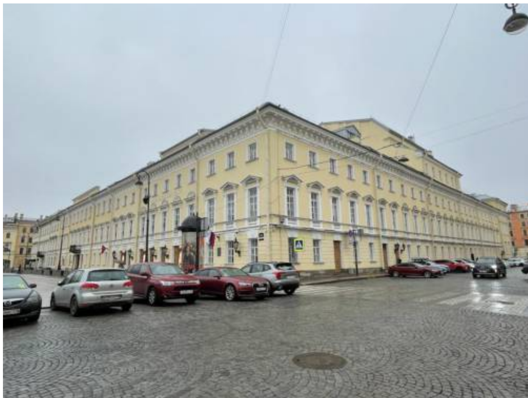
Фото 5. Фрагмент лицевого фасада объекта культурного наследия федерального значения «Театр Михайловский» (по Инженерной ул.)
