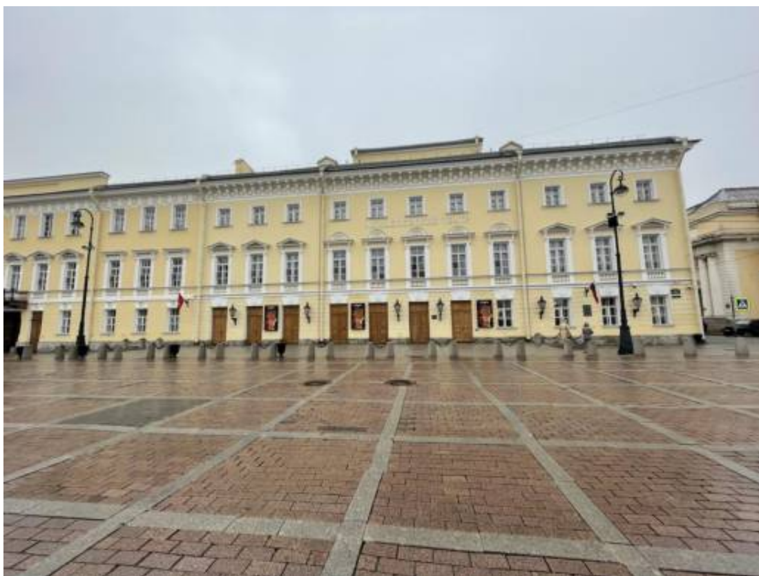
Фото 6. Фрагмент лицевого фасада объекта культурного наследия федерального значения «Театр Михайловский» (по Искусств пл.)
