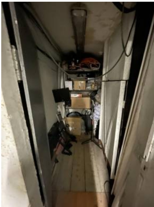
Фото 26. Интерьер подвального этажа объекта культурного наследия федерального значения «Театр Михайловский»
