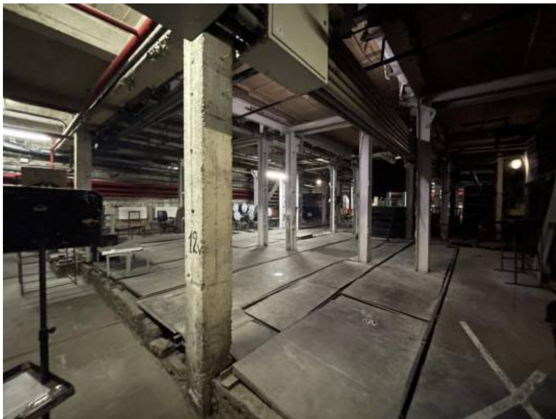
Фото 22. Интерьер подвального этажа объекта культурного наследия федерального значения «Театр Михайловский»
