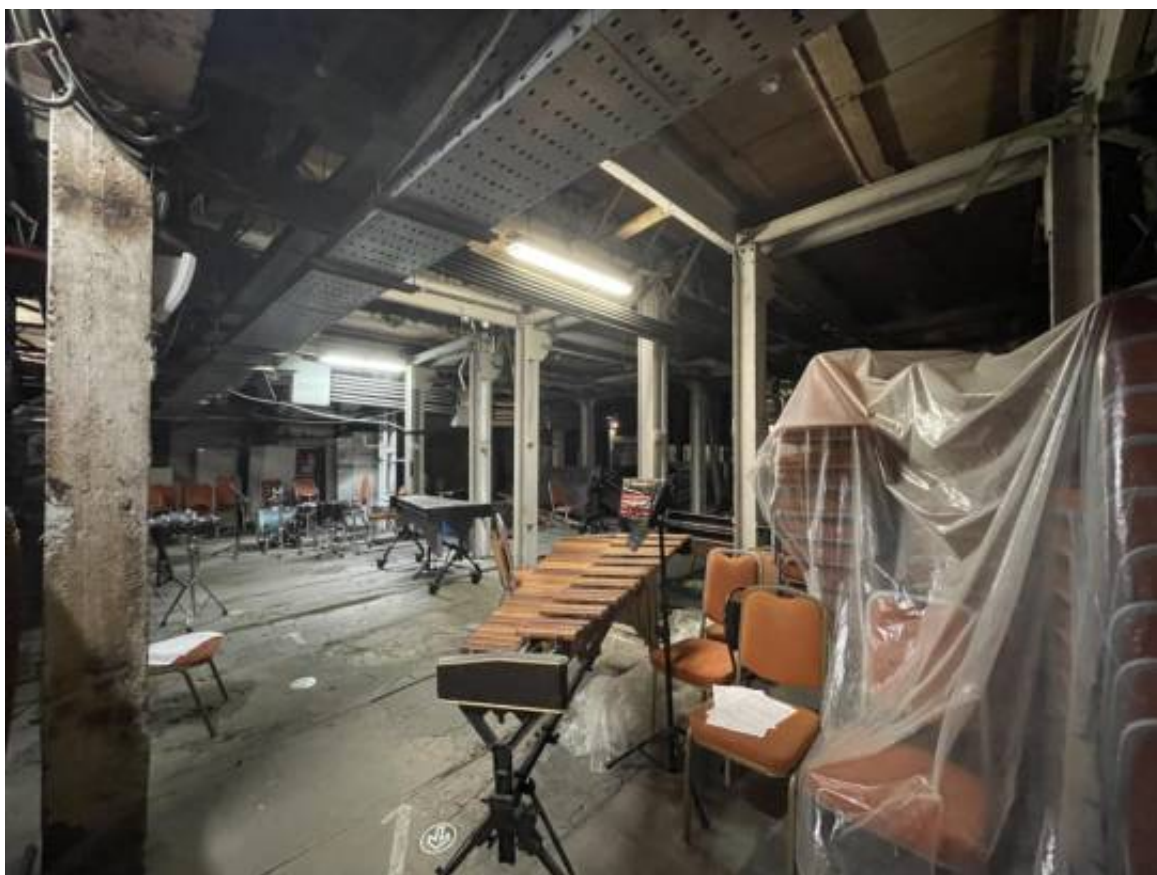
Фото 17. Интерьер подвального этажа объекта культурного наследия федерального значения «Театр Михайловский»
