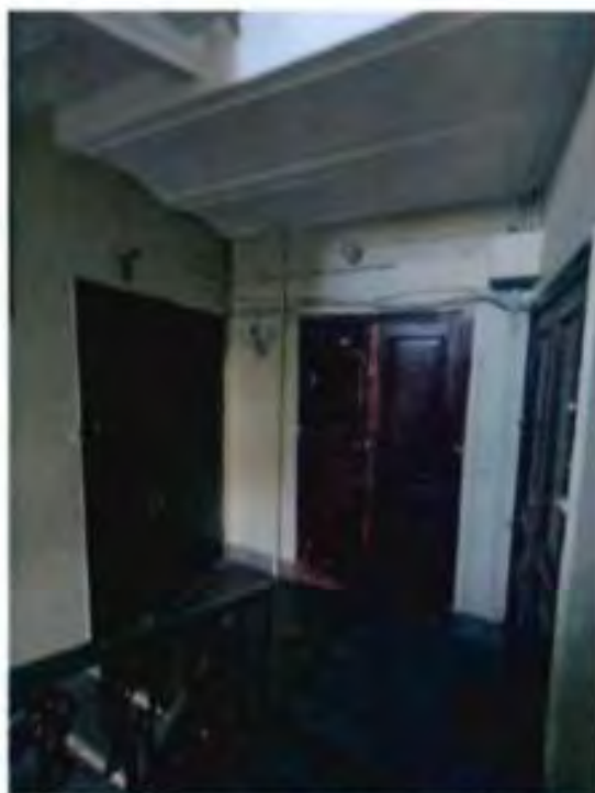
20. Лестничная клетка 1-ЛК. (25.09.2023)
