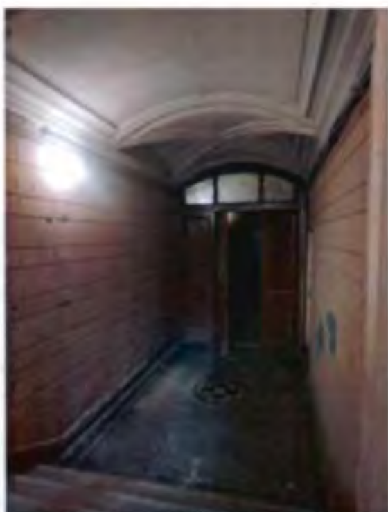
21. Вестибюль 3-ЛК (парадная в которой расположены квартиры с 1 по 6). (25.09.2023)
