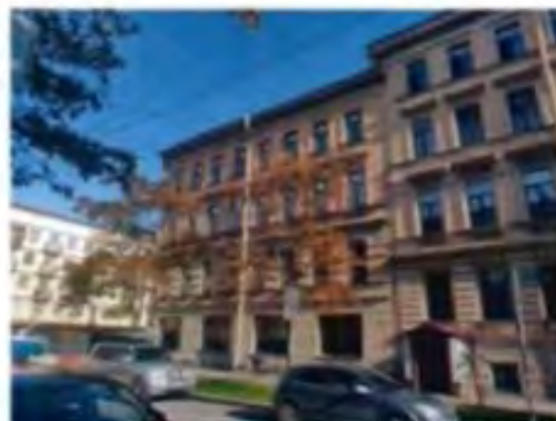
4. Западный фасад объекта культурного наследия. (25.09.2023)
