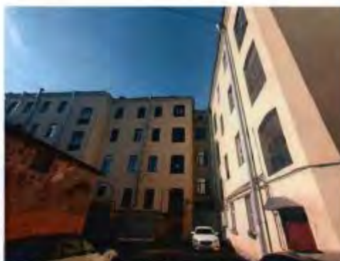
9. Дворовые фасады объекта культурного наследия. (25.09.2023)
