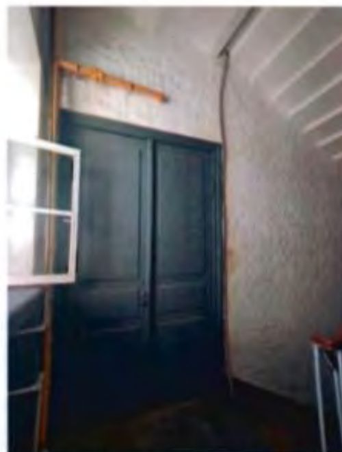
31. Лестничная клетка 2-ЛК. (25.09.2023)
