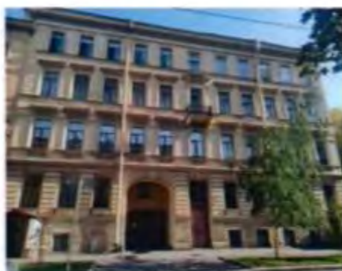
6. Западный фасад объекта культурного наследия. (25.09.2023)
