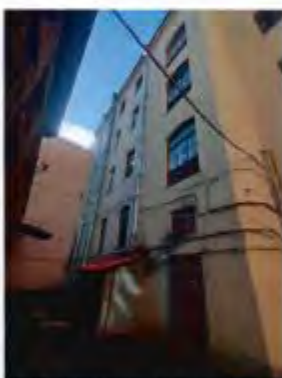
10. Фрагмент дворового фасада. (25.09.2023)
