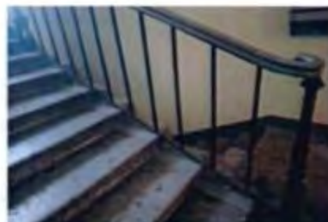
17. Лестничная клетка 1-ЛК. (25.09.2023)
