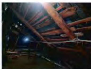
13. Фрагмент стропильной системы. Подпорки под стропилами. (25.09.2023)
