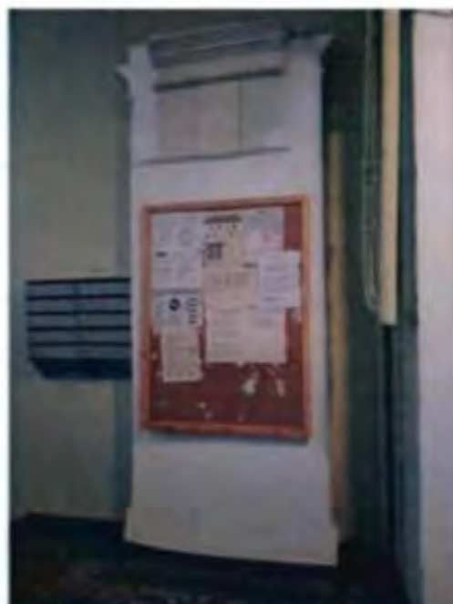
15. Печка вестибюля 1-ЛК (парадная в которой расположены квартиры с 9 по 17). Утрата большей части изразцов. (25.09.2023)
