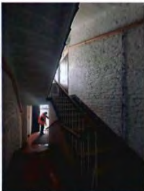
30. Лестничная клетка 2-ЛК. (25.09.2023)
