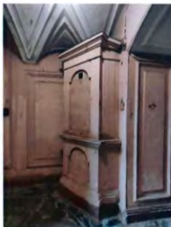
22. Печь-камин вестибюля 3-ЛК (парадная в которой расположены квартиры с 1 по 6). (25.09.2023)
