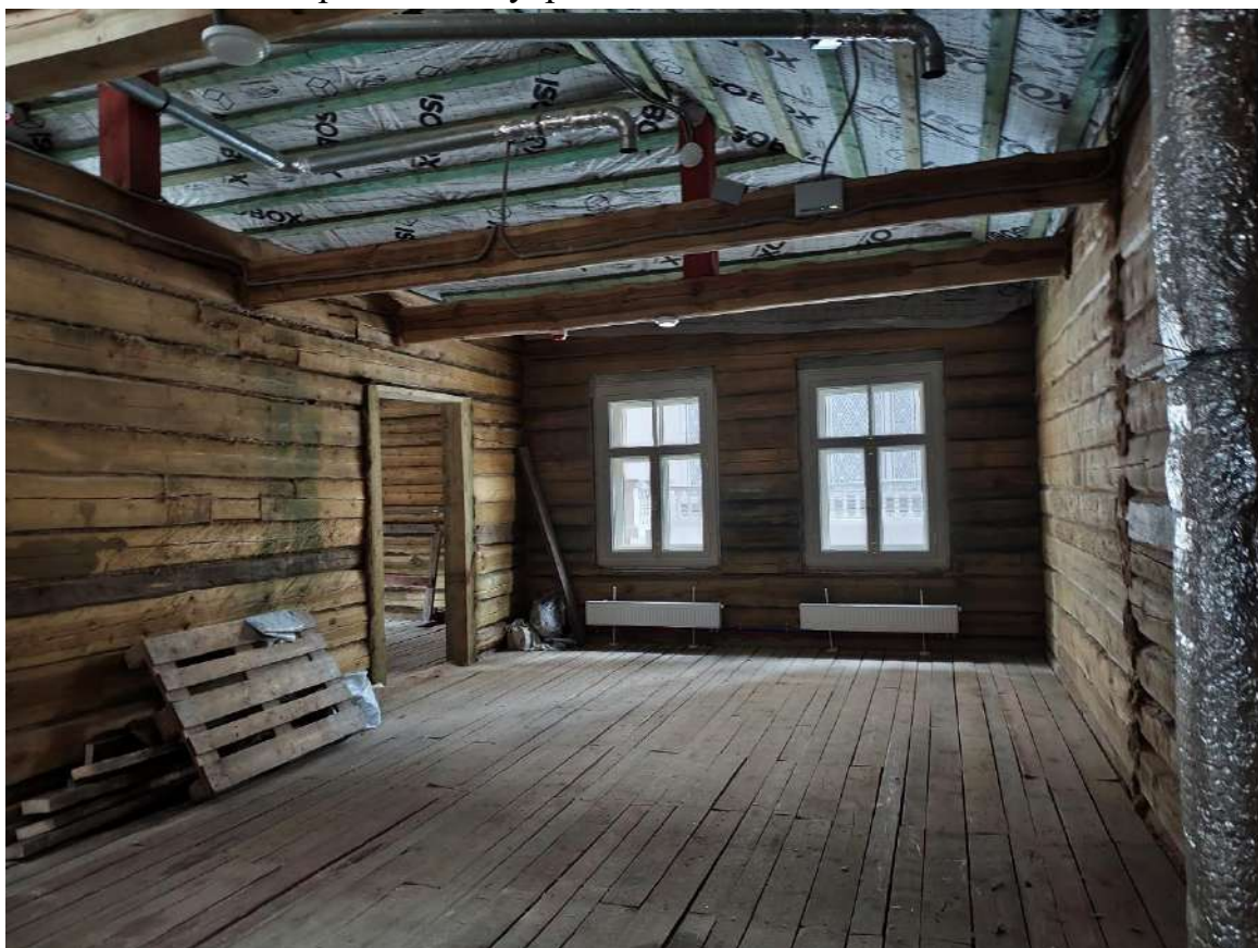
Фото 35. Объект культурного наследия регионального значения «Особняк Э.Э. Бремме». Внутренние помещения 2-го этажа.
