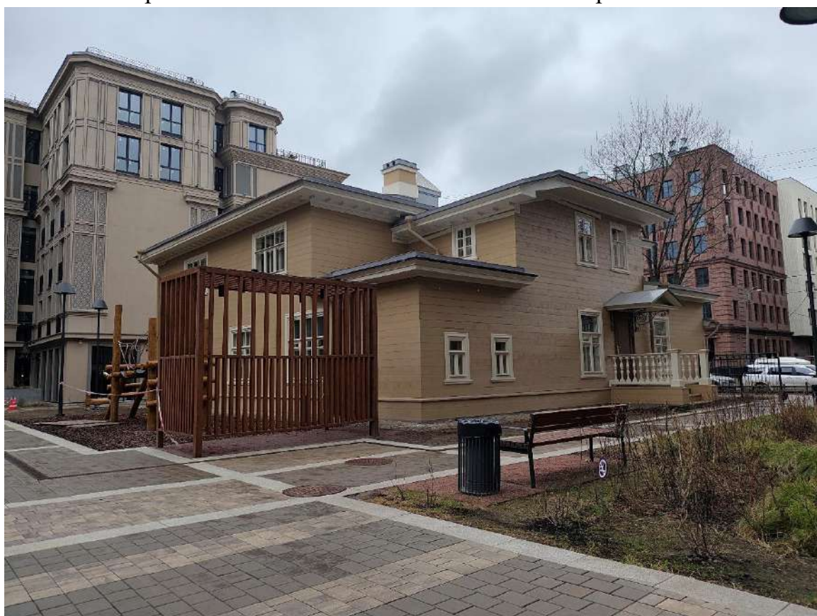
Фото 9. Вид на северо-западный фасад объекта культурного наследия регионального значения «Особняк Э.Э. Бремме».
