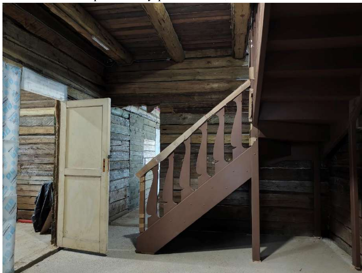
Фото 17. Объект культурного наследия регионального значения «Особняк Э.Э. Бремме». Внутренние помещения 1-го этажа.
