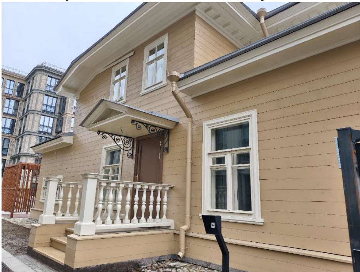
Фото 11. Вид на северо-западный фасад объекта культурного наследия регионального значения «Особняк Э.Э. Бремме».
