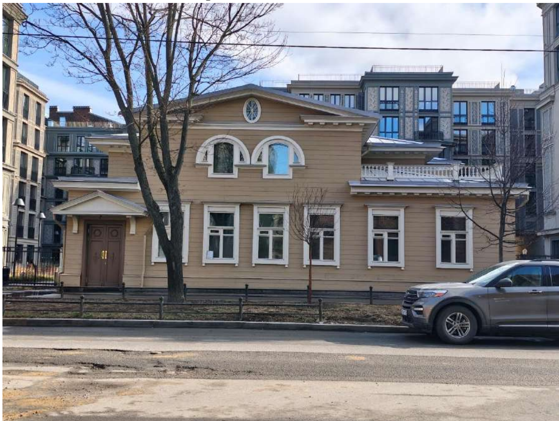
Фото 1. Вид на юго-западный фасад объекта культурного наследия регионального значения «Особняк Э.Э. Бремме».
