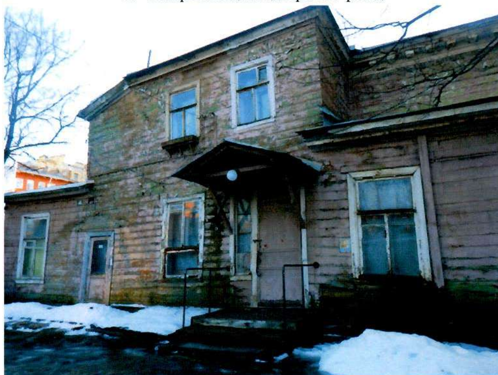
2. Северо-западный дворовый фасад
