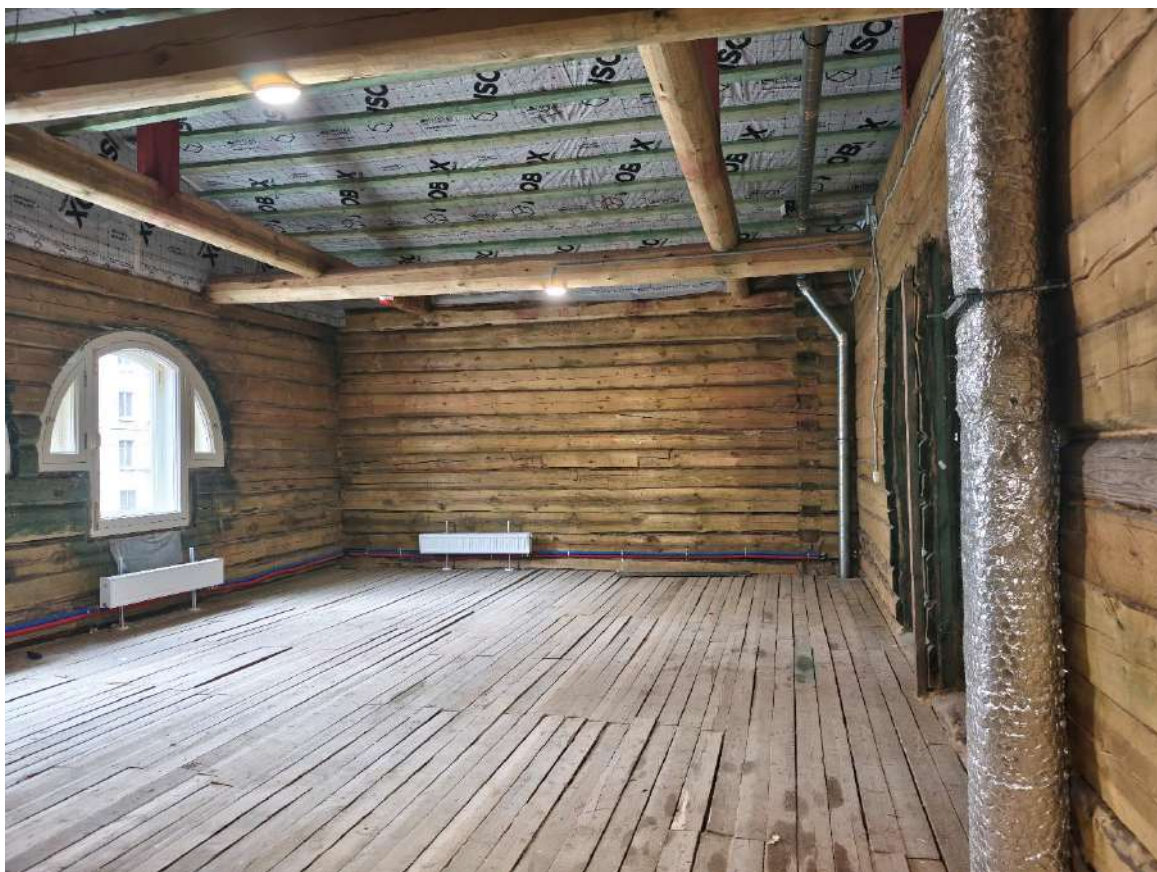
Фото 40. Объект культурного наследия регионального значения «Особняк Э.Э. Бремме». Внутренние помещения 2-го этажа.
