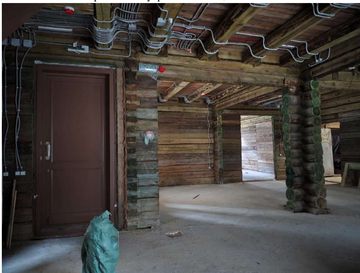
Фото 28. Объект культурного наследия регионального значения «Особняк Э.Э. Бремме». Внутренние помещения 1-го этажа.
