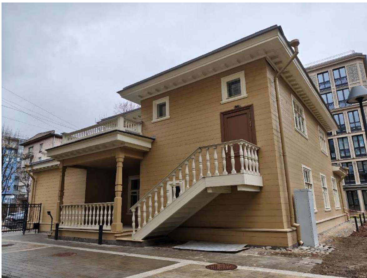
Фото 6. Вид на юго-восточный фасад объекта культурного наследия регионального значения «Особняк Э.Э. Бремме».
