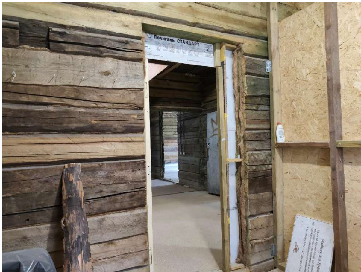
Фото 21. Объект культурного наследия регионального значения «Особняк Э.Э. Бремме». Внутренние помещения 1-го этажа.
