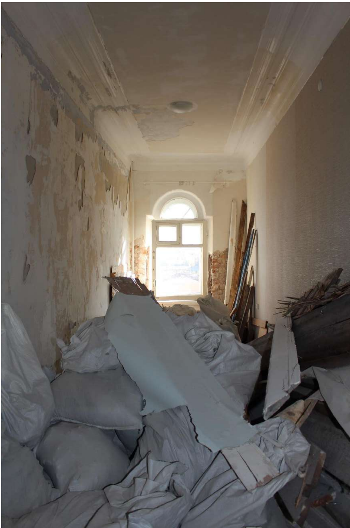
Фото 17. Объект культурного наследия регионального значения «Дом П.М. Станового». Квартира № 20, ч.п. 10.
