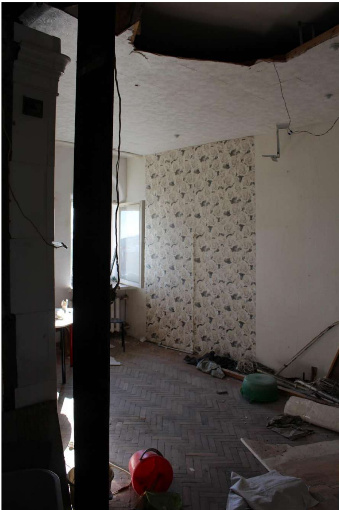
Фото 33. Объект культурного наследия регионального значения «Дом П.М. Станового». Квартира № 20, ч.п. 8, 14.
