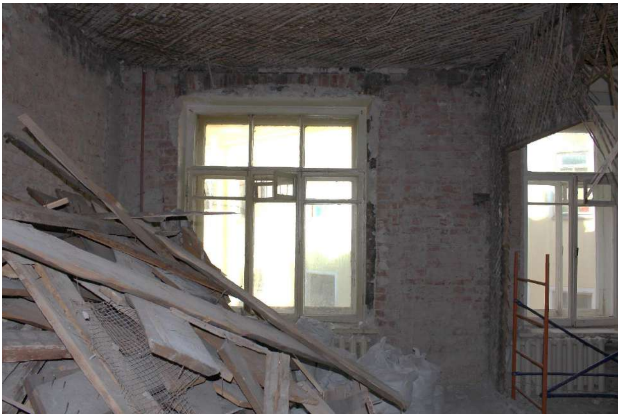
Фото 19. Объект культурного наследия регионального значения «Дом П.М. Станового». Квартира № 20, ч.п. 12.
