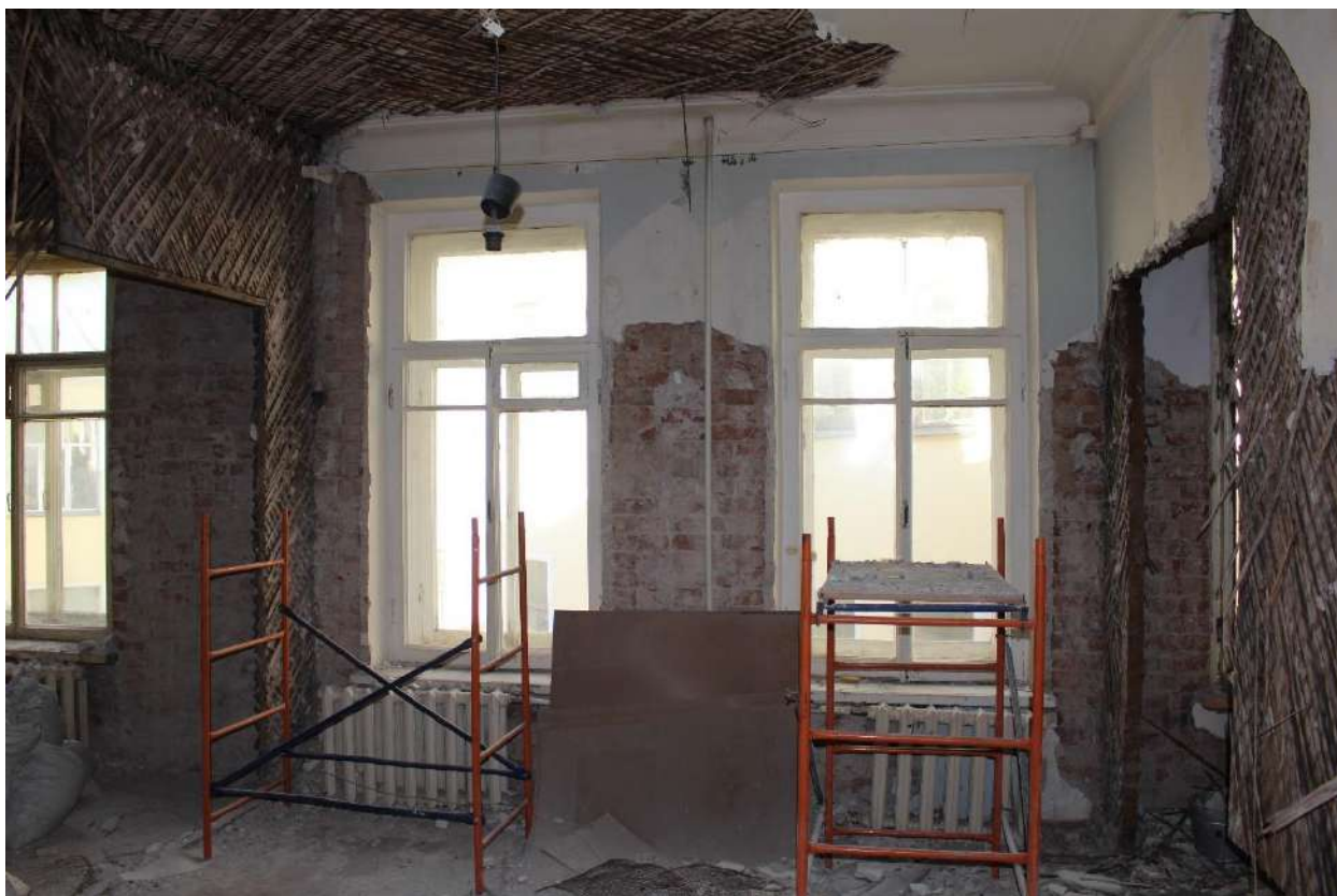
Фото 21. Объект культурного наследия регионального значения «Дом П.М. Станового». Квартира № 20, ч.п. 9.
