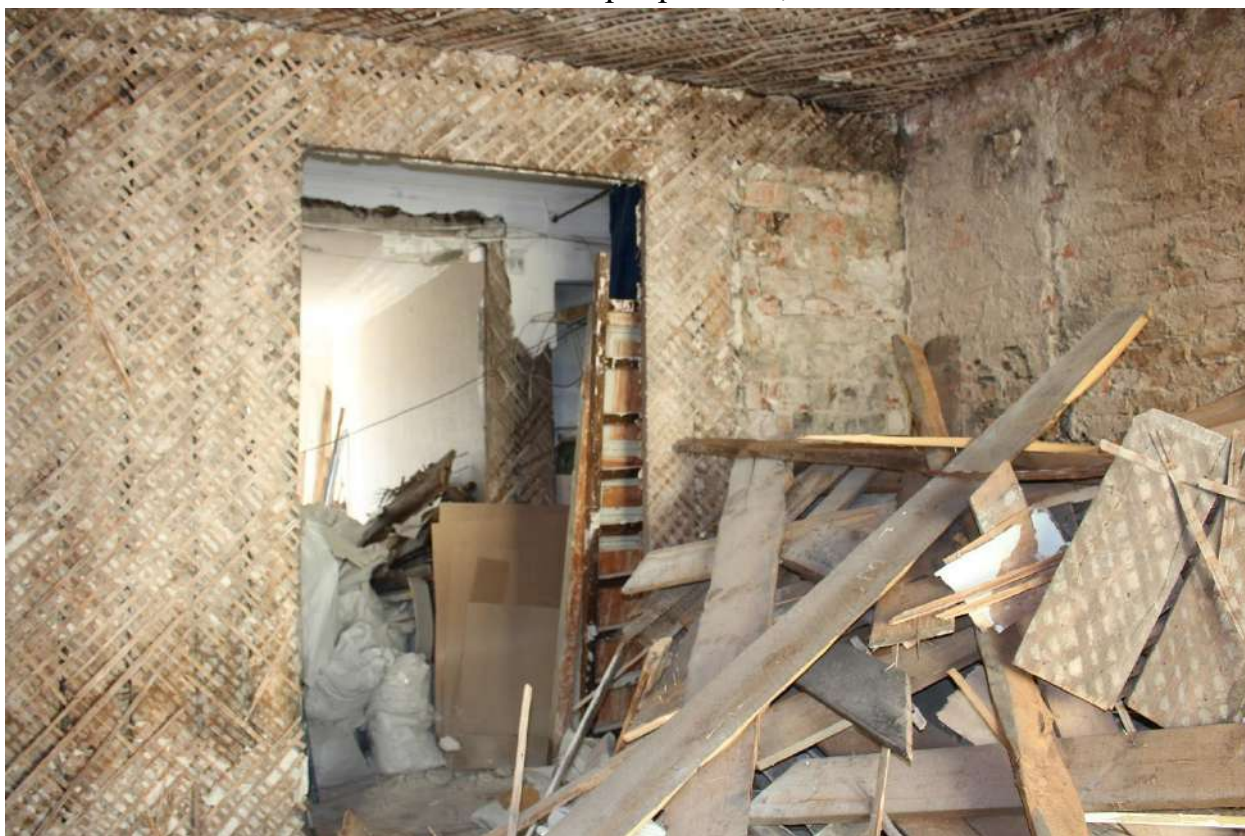
Фото 20. Объект культурного наследия регионального значения «Дом П.М. Станового». Квартира № 20, ч.п. 12.
