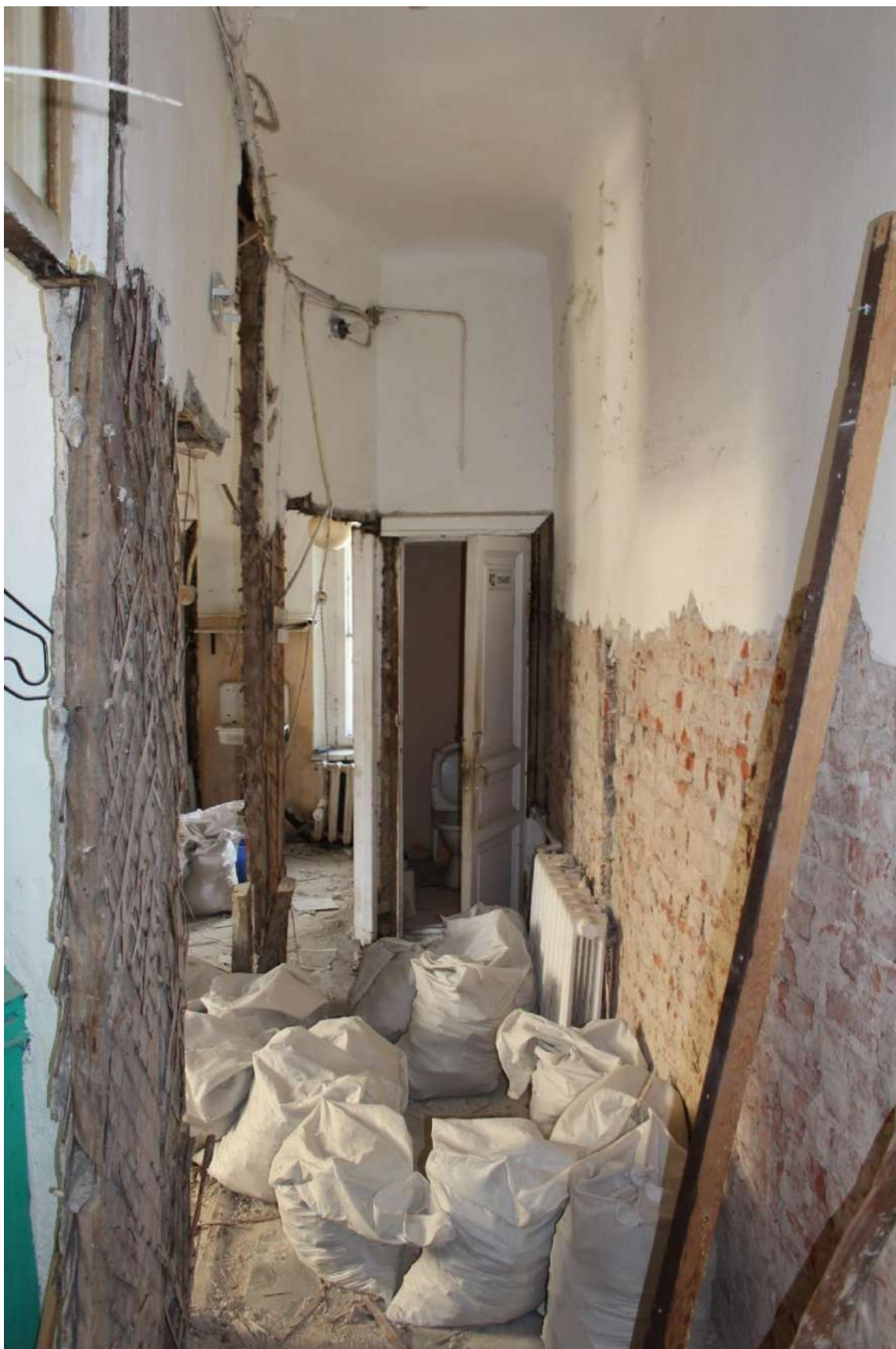
Фото 26. Объект культурного наследия регионального значения «Дом П.М. Станового». Квартира № 20, ч.п. 4.
