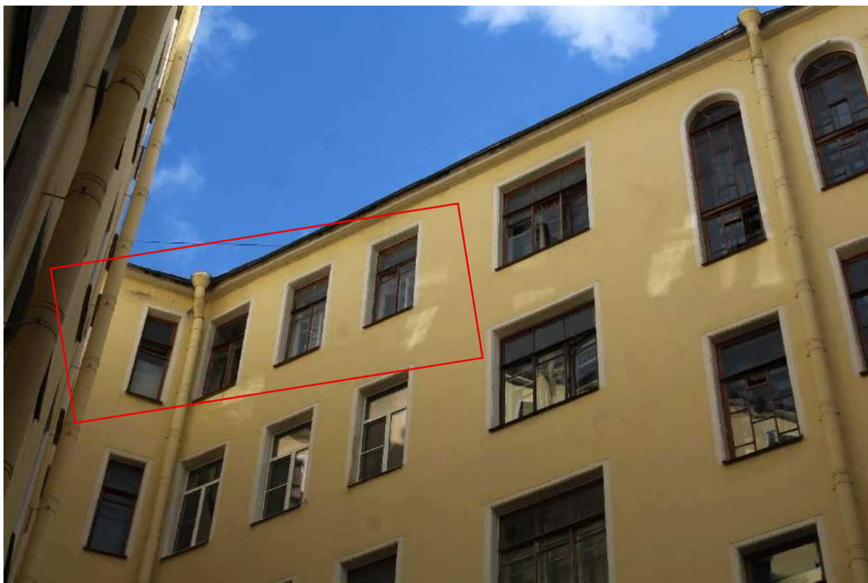
Фото 12. Вид на дворовые фасады объекта культурного наследия регионального значения «Дом П.М. Станового». Красным отмечены оконные проемы квартиры № 20.
