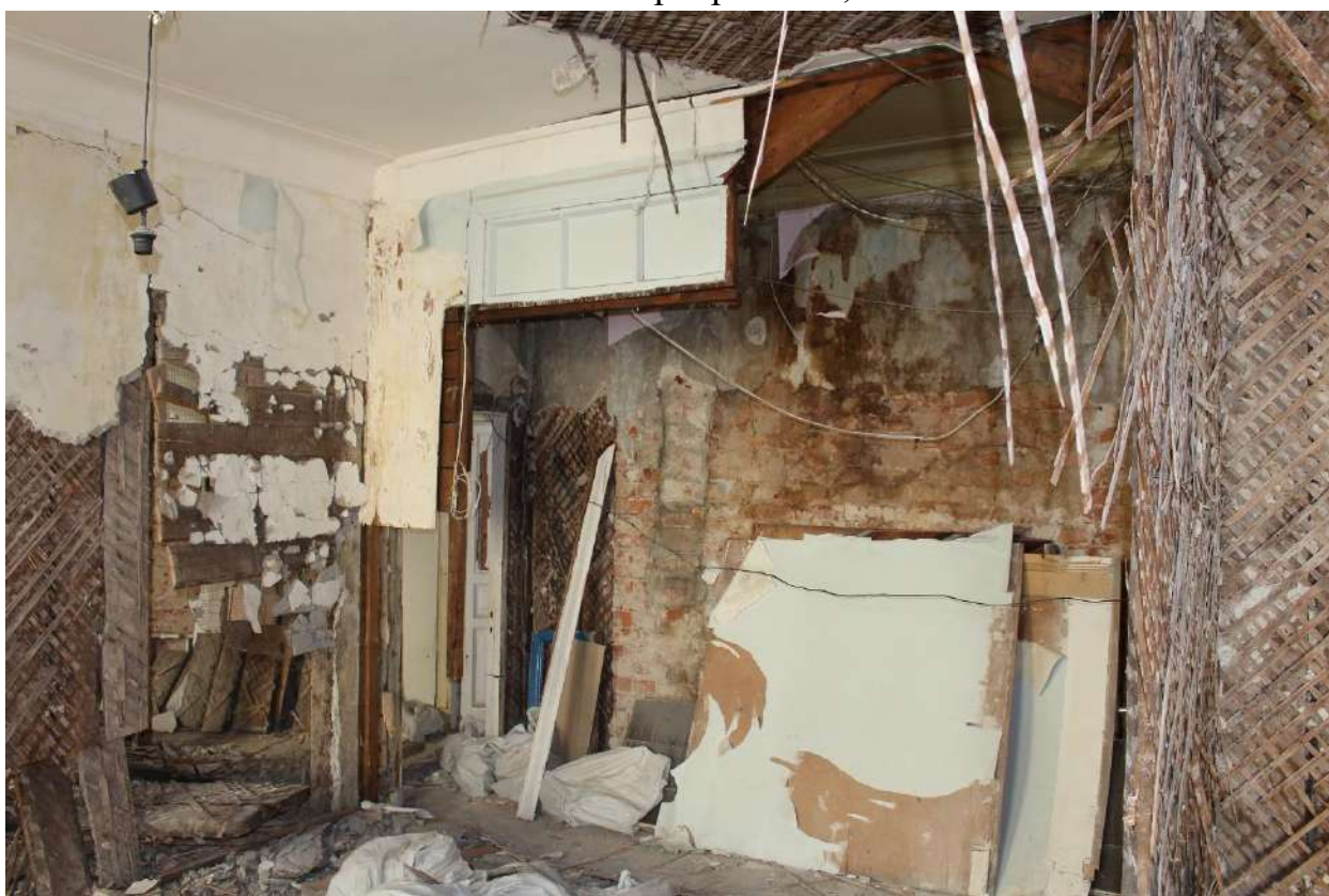
Фото 22. Объект культурного наследия регионального значения «Дом П.М. Станового». Квартира № 20, ч.п. 9.
