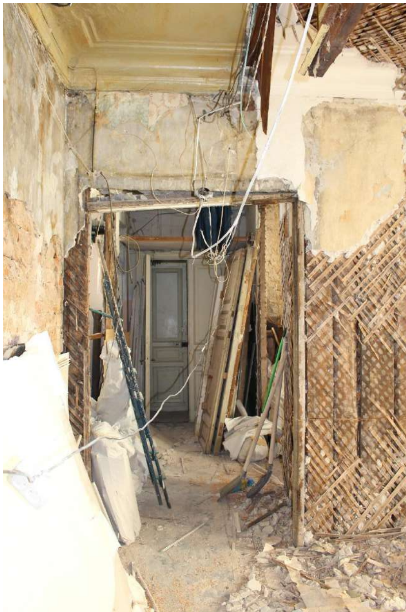
Фото 23. Объект культурного наследия регионального значения «Дом П.М. Станового». Квартира № 20, ч.п. 13.
