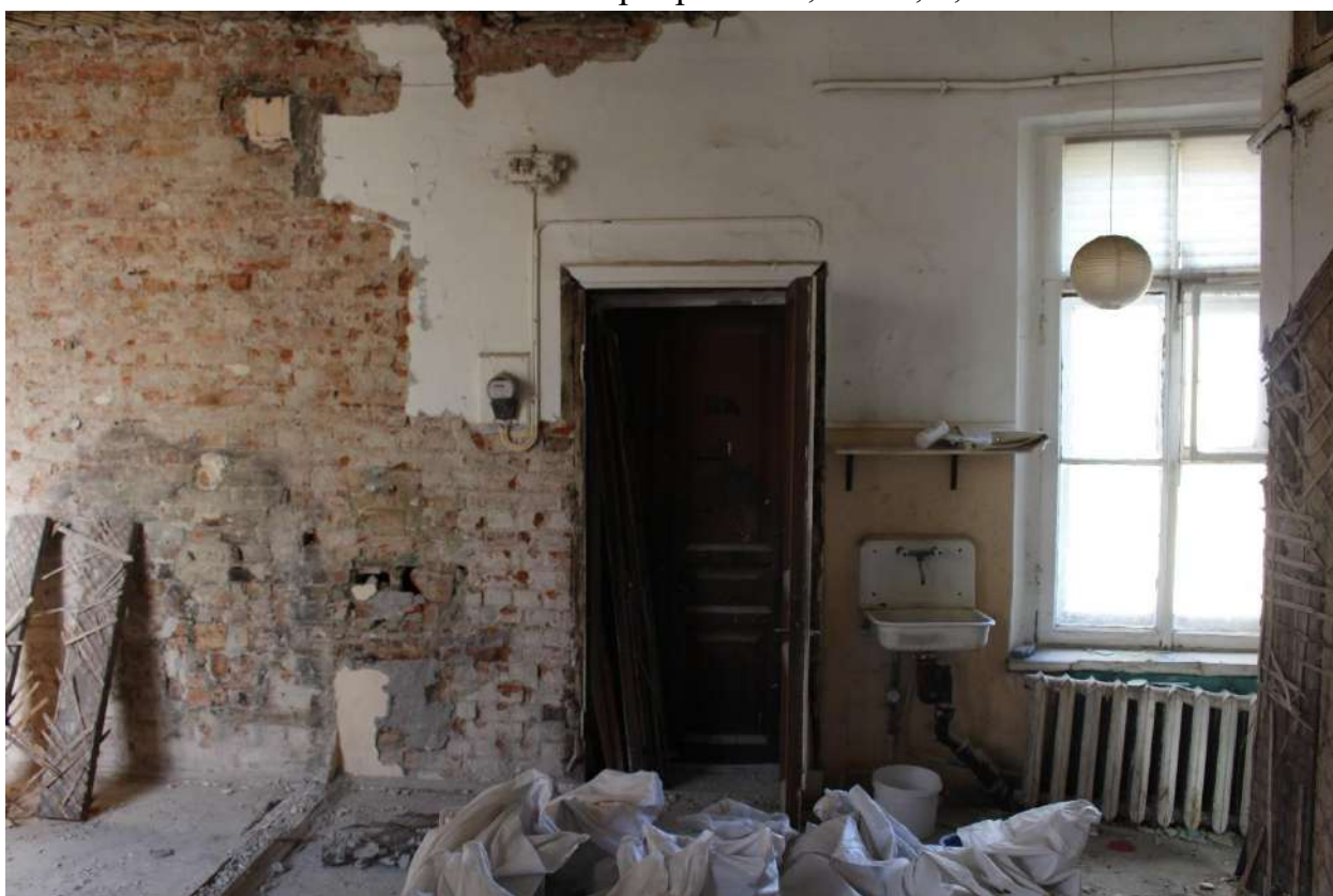
Фото 29. Объект культурного наследия регионального значения «Дом П.М. Станового». Квартира № 20, ч.п. 1.
