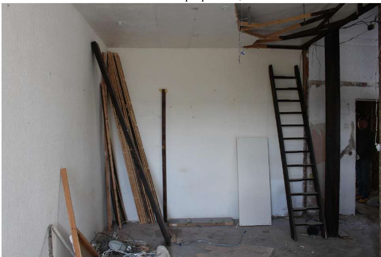
Фото 35. Объект культурного наследия регионального значения «Дом П.М. Станового». Квартира № 20, ч.п. 8, 14.
