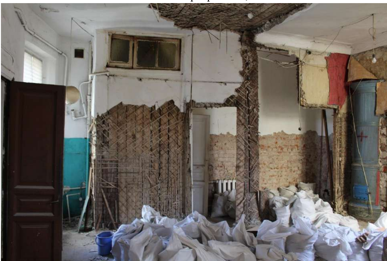
Фото 31. Объект культурного наследия регионального значения «Дом П.М. Станового». Квартира № 20, ч.п. 1, 2, 5.
