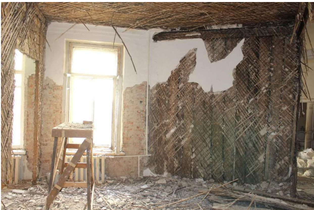
Фото 24. Объект культурного наследия регионального значения «Дом П.М. Станового». Квартира № 20, ч.п. 7.
