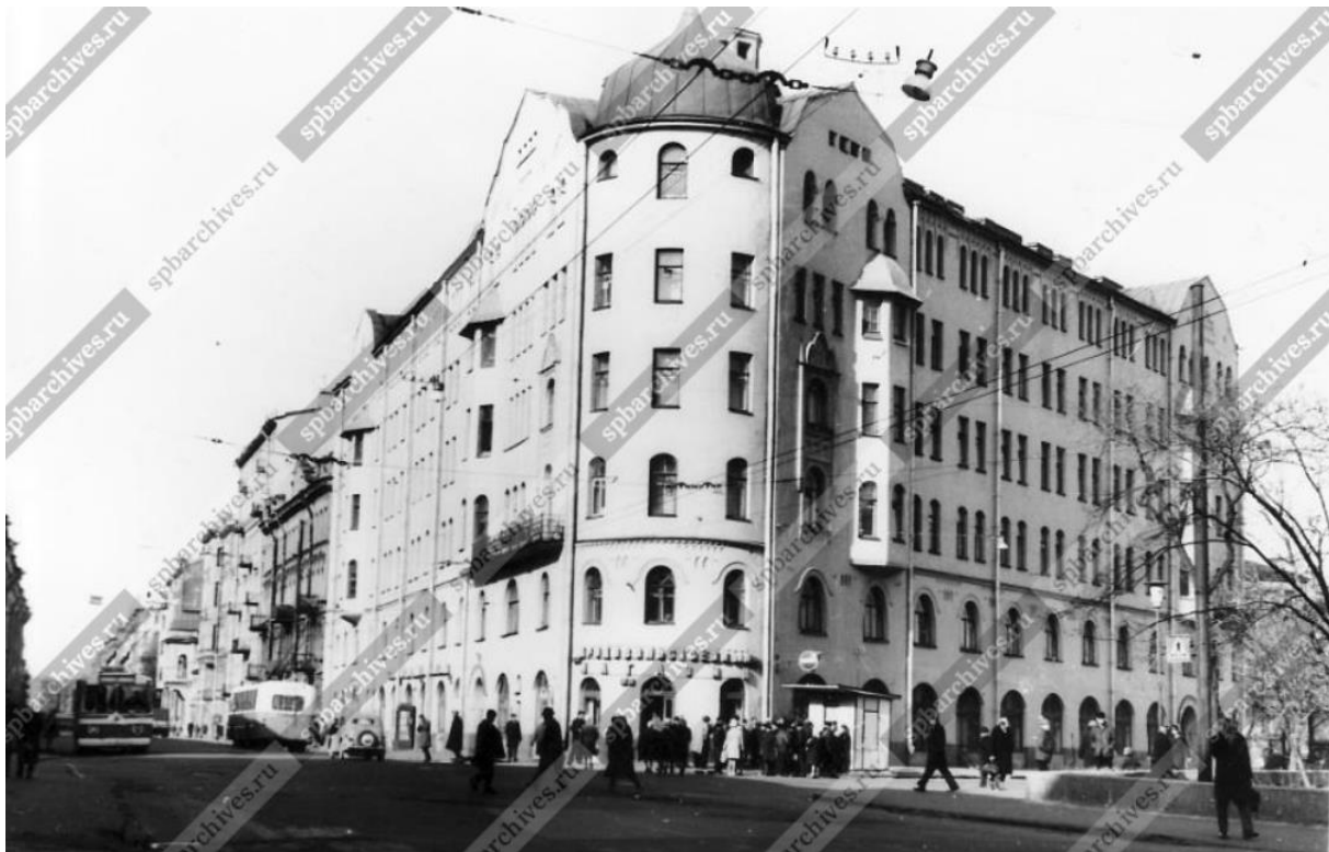
Илл. 21. Общий вид жилого дома № 5/2 на углу улиц Мытнинской и Старорусской. 1974 г. (источник: ЦГАКФФД СПб. Фотодокументы. Опись 1АР-159. Ед.хр.230705).
