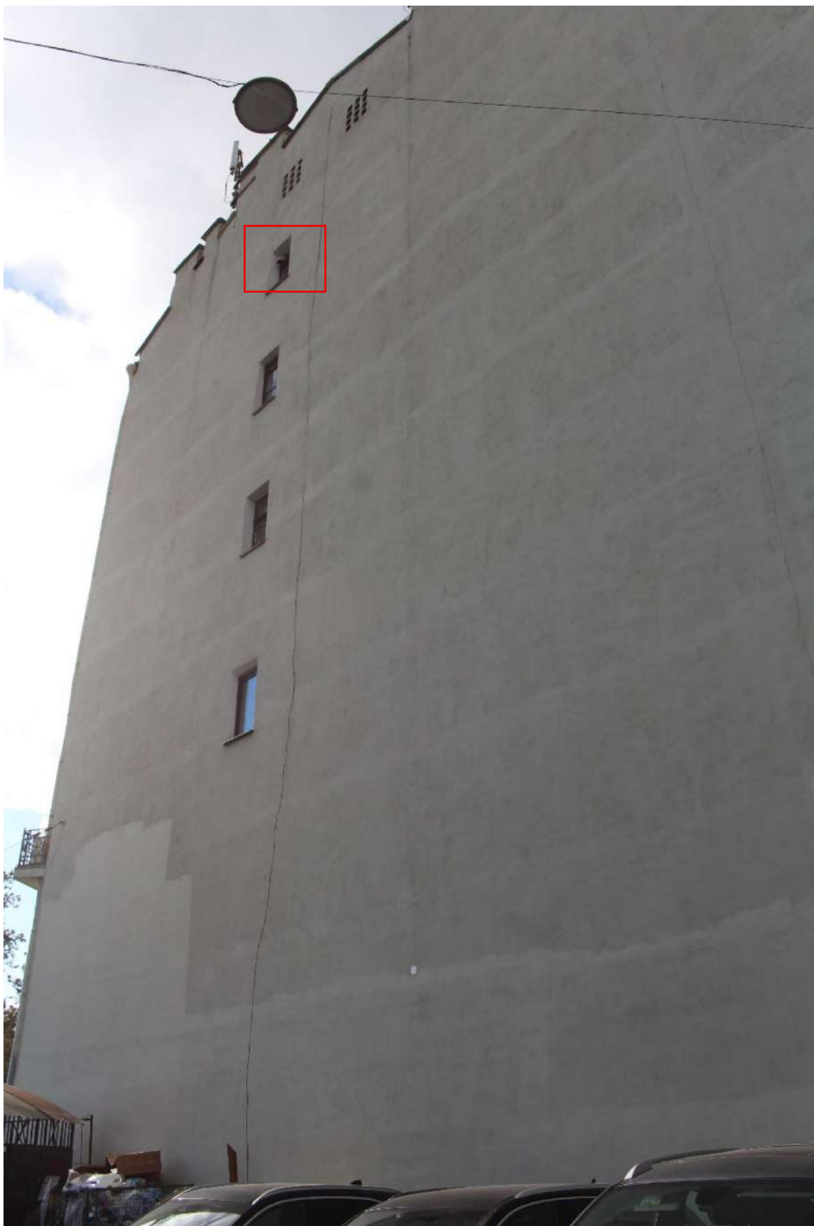
Фото 7. Вид на брандмауэр объекта культурного наследия регионального значения «Дом П.М. Станового» по Старорусской улице. Красным отмечены оконные проемы квартиры № 20.
