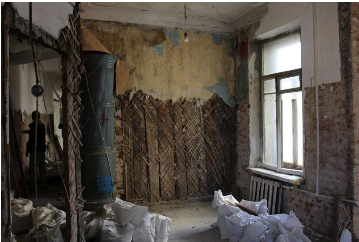
Фото 30. Объект культурного наследия регионального значения «Дом П.М. Станового». Квартира № 20, ч.п. 5.
