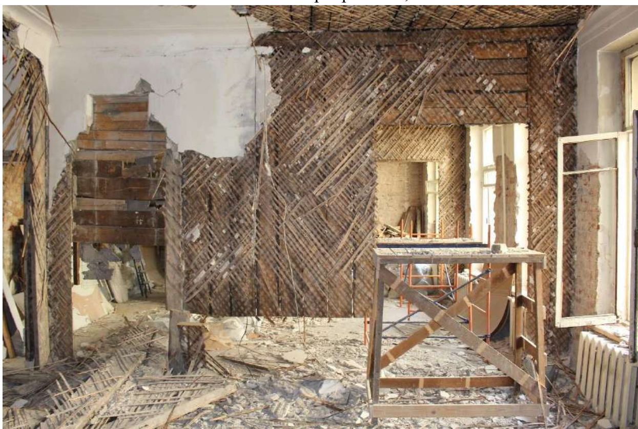
Фото 25. Объект культурного наследия регионального значения «Дом П.М. Станового». Квартира № 20, ч.п. 7.
