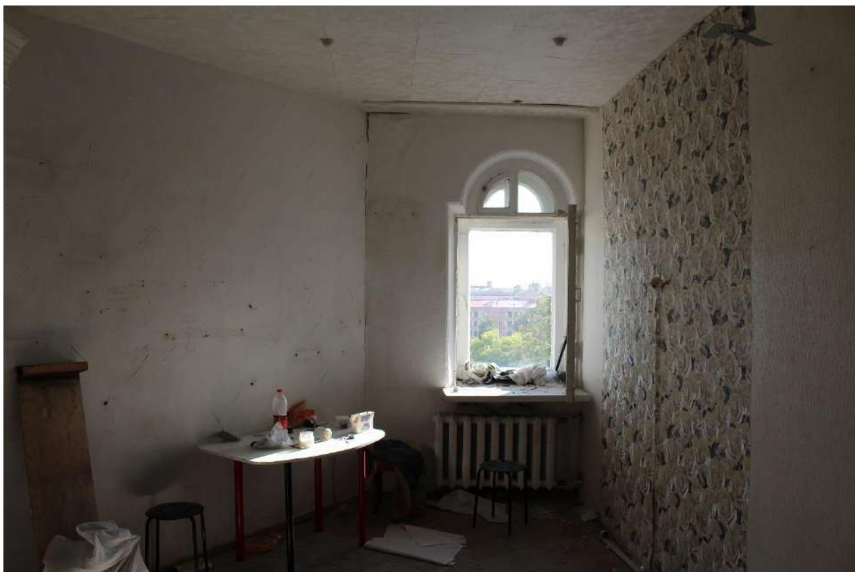
Фото 34. Объект культурного наследия регионального значения «Дом П.М. Станового». Квартира № 20, ч.п. 14.
