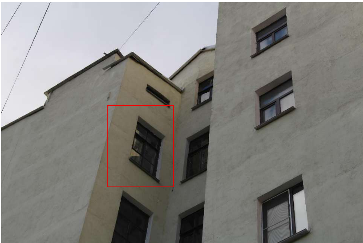
Фото 9. Вид на брандмауэр объекта культурного наследия регионального значения «Дом П.М. Станового» по Старорусской улице. Красным отмечены оконные проемы квартиры № 20.
