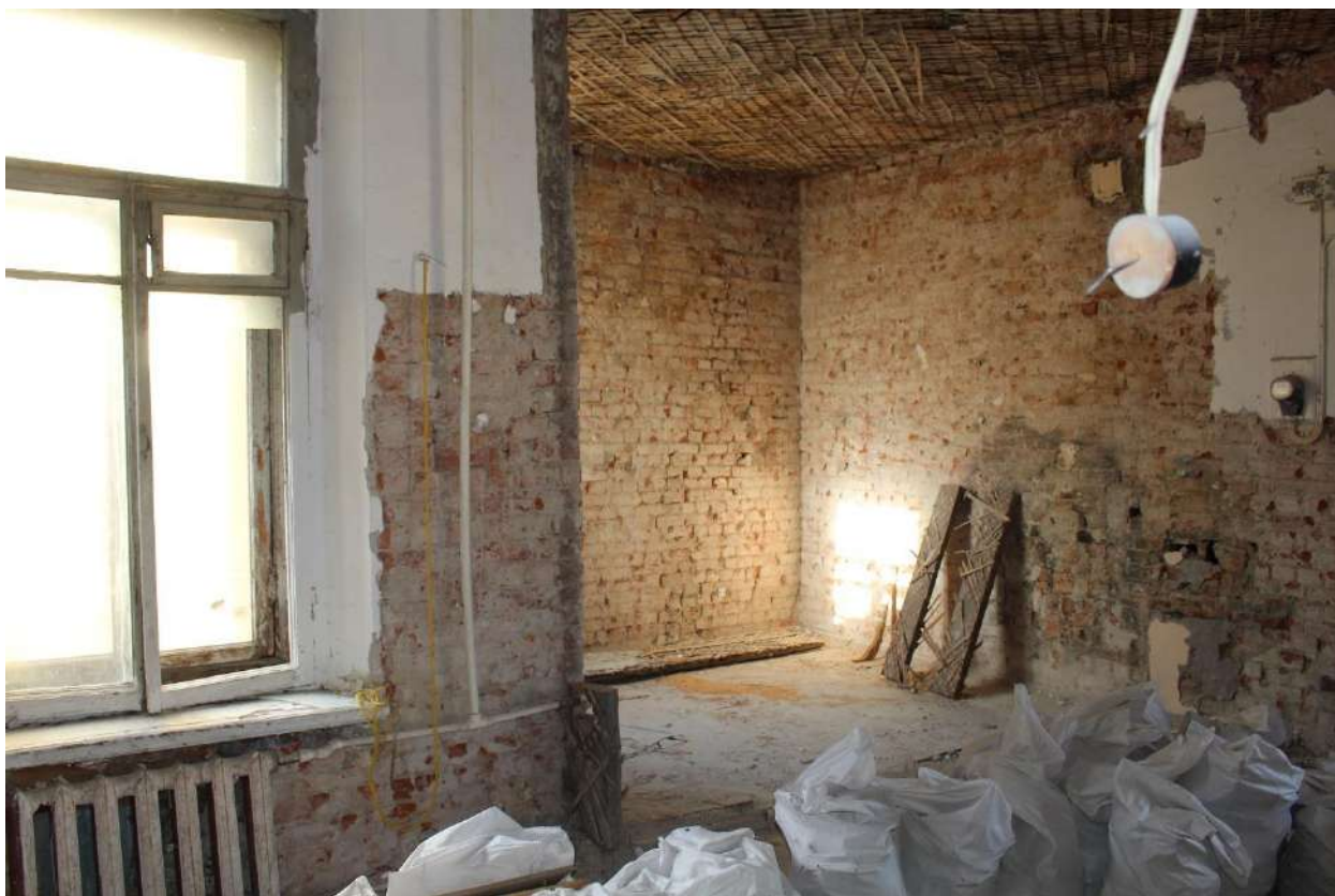
Фото 28. Объект культурного наследия регионального значения «Дом П.М. Станового». Квартира № 20, ч.п. 1, 2, 5.
