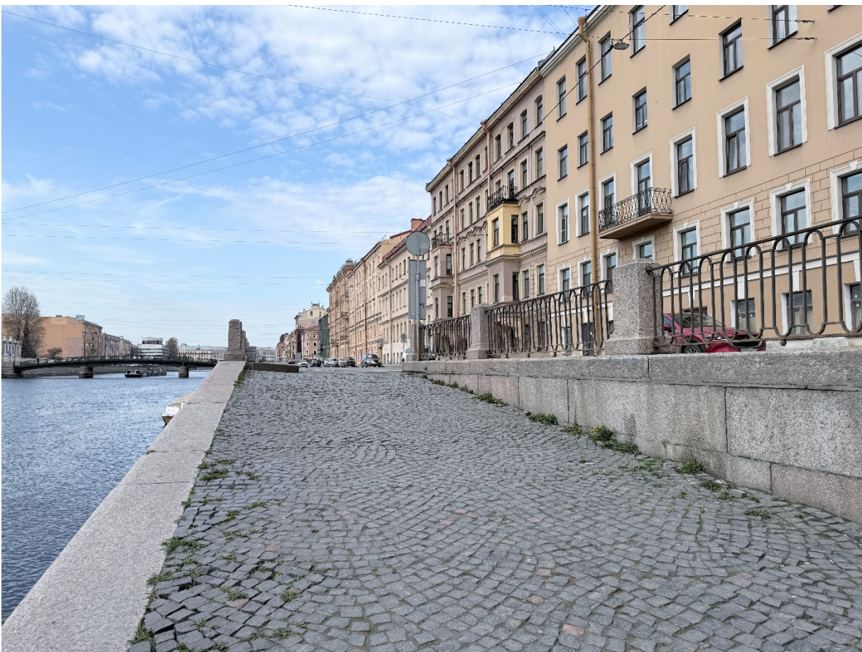
Фото 9. Общий вид на спуск № 13 в границах объекта культурного наследия федерального значения «Набережные и мосты реки Фонтанки».
