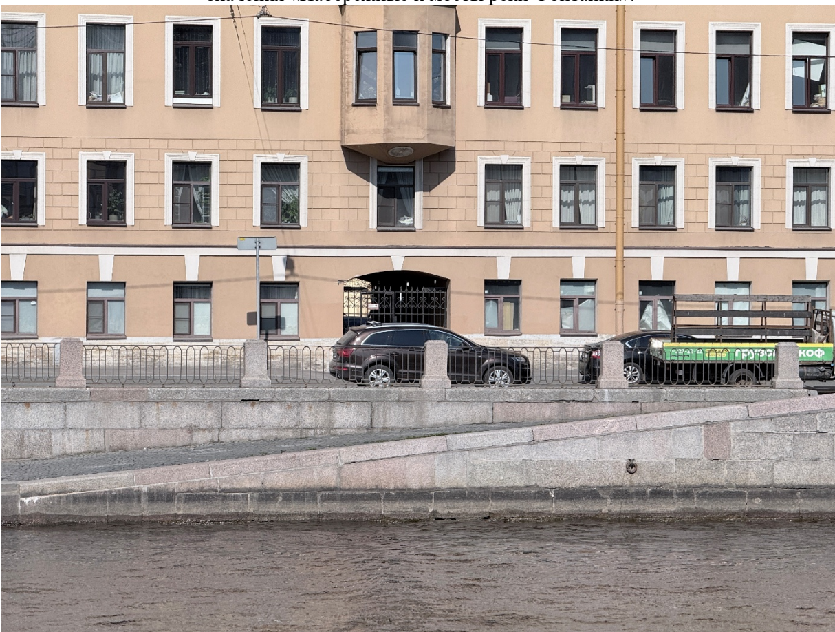
Фото 4. Общий вид на спуск № 13 в границах объекта культурного наследия федерального значения «Набережные и мосты реки Фонтанки».
