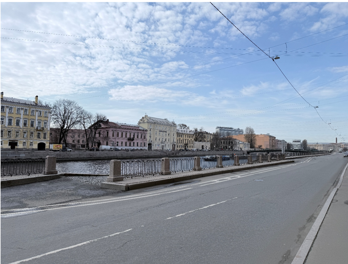
Фото 11. Общий вид на спуск № 13 в границах объекта культурного наследия федерального значения «Набережные и мосты реки Фонтанки».
