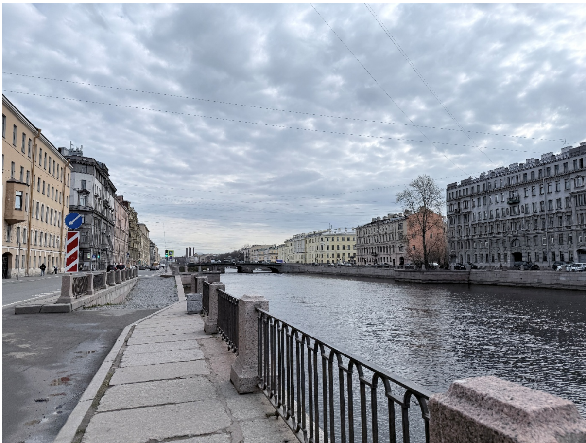
Фото 5. Общий вид на спуск № 13 в границах объекта культурного наследия федерального значения «Набережные и мосты реки Фонтанки».
