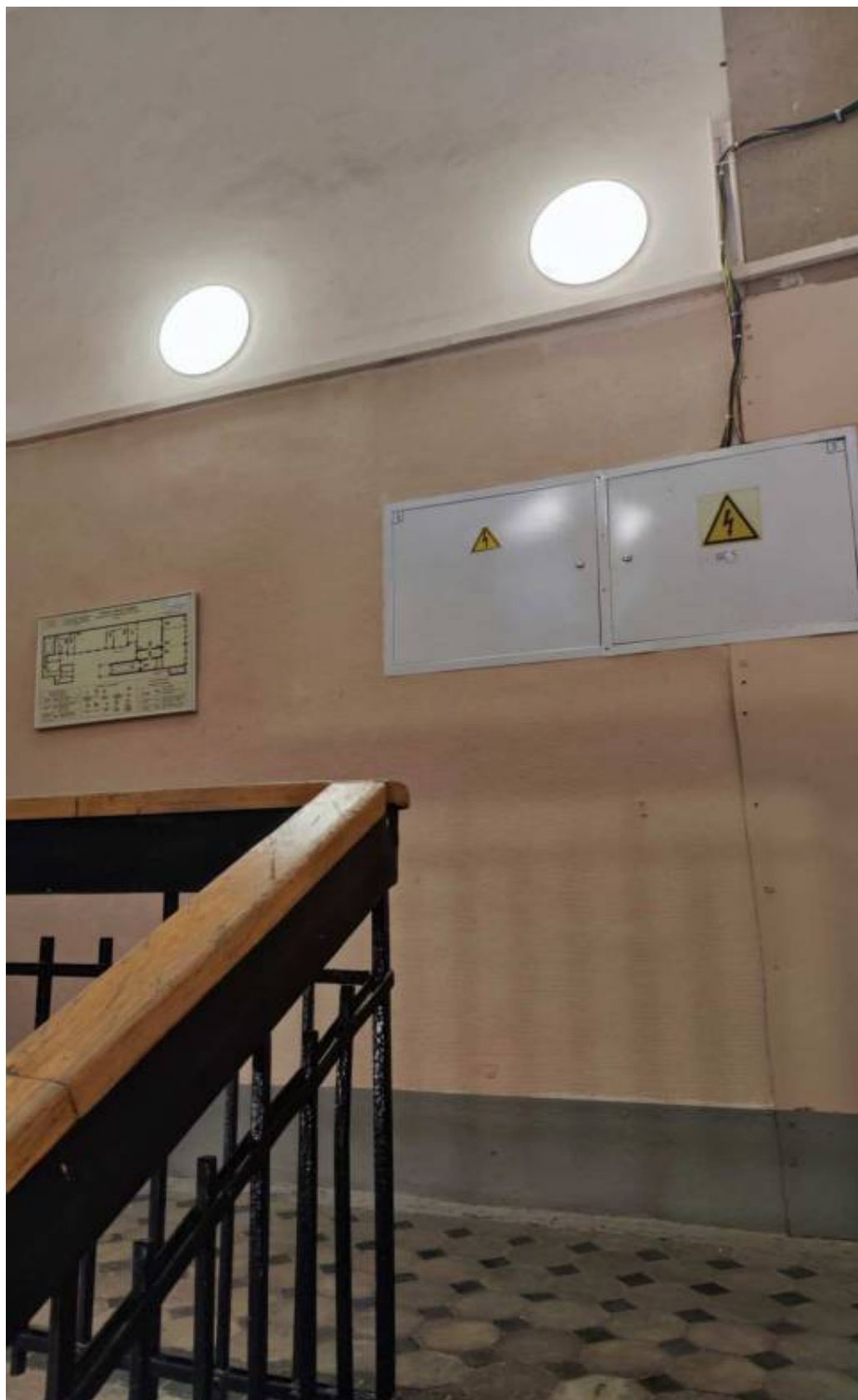
3. Вид на лестничную клетку
