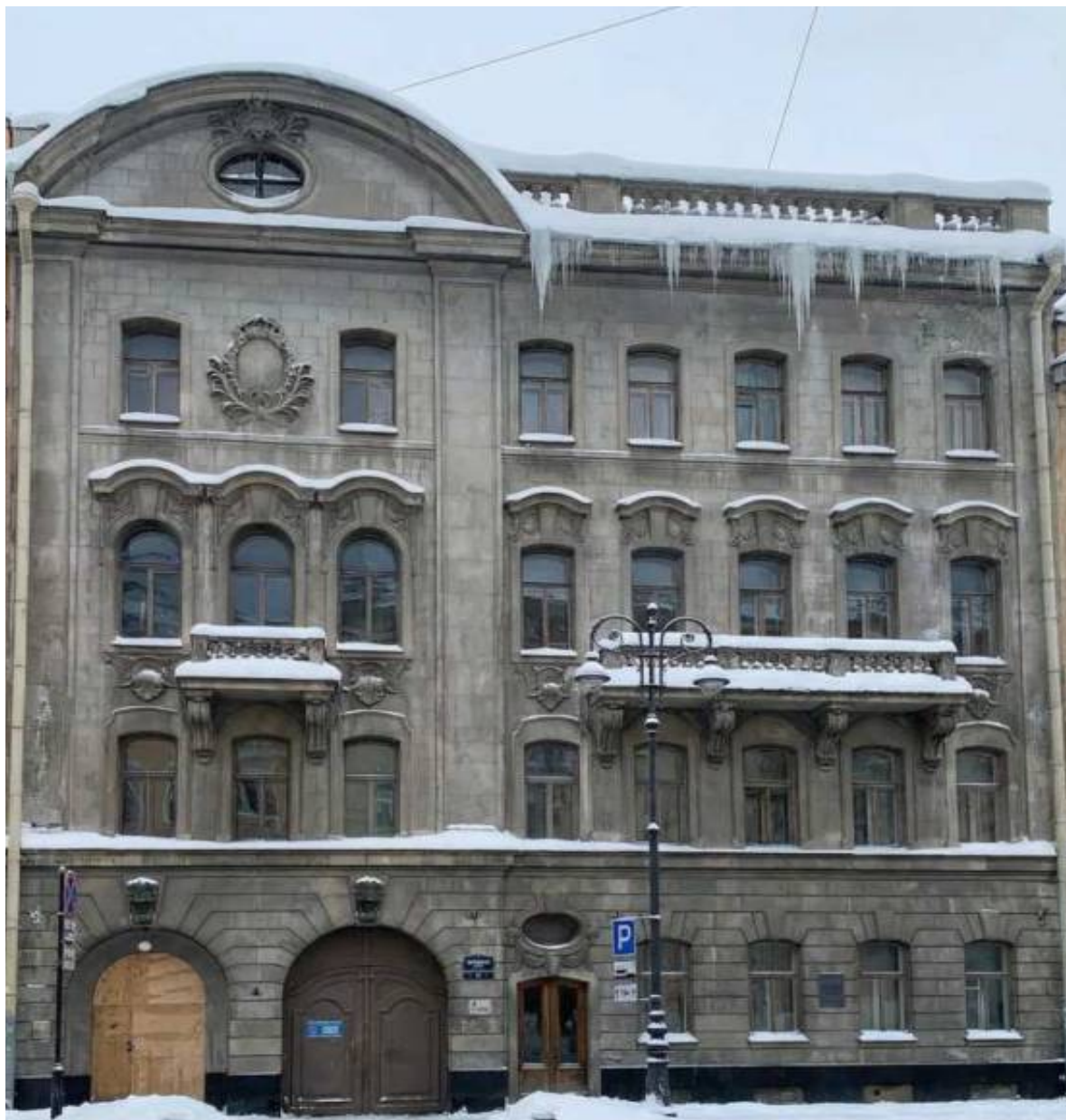
1. Вид на лицевой фасад здания №15
