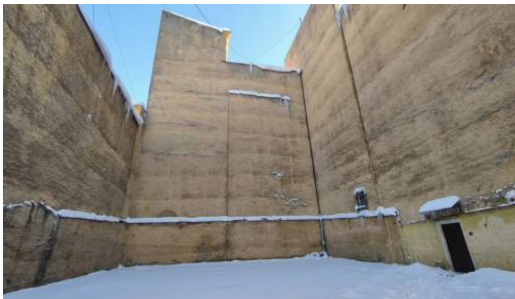
2. Вид на брандмауэрные стены здания
