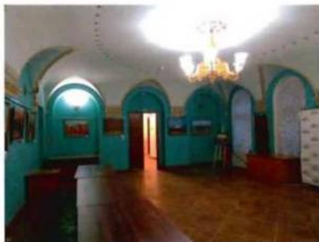
9. Помещение 2-го этажа (8-Н).
