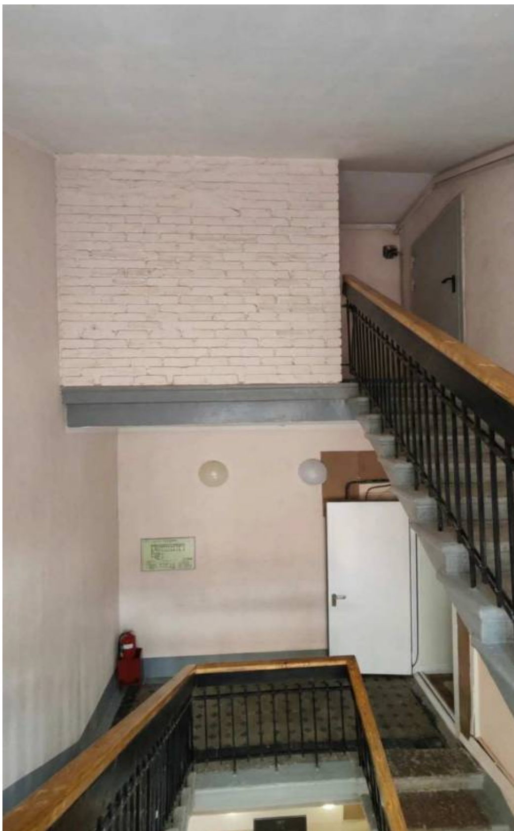
5. Вид на лестничную клетку
