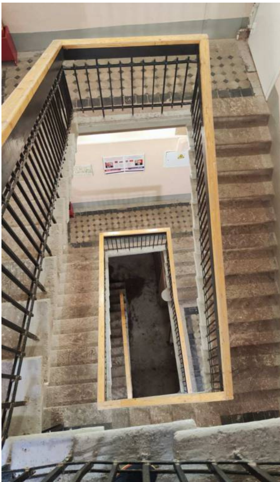
4. Вид на лестничную клетку
