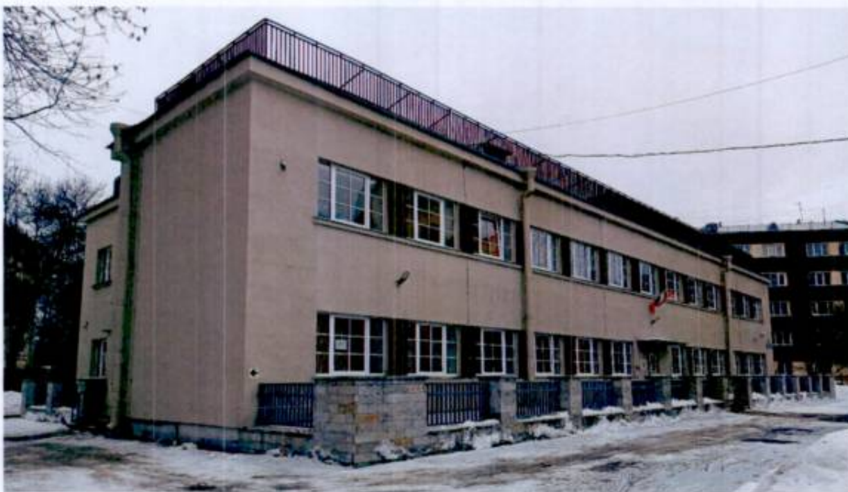
1. Общий вид объекта культурного наследия с юго-восточной стороны.
