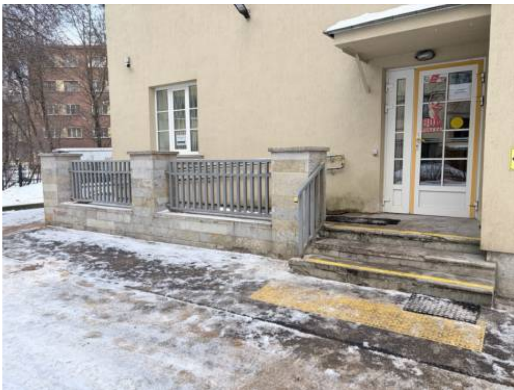
7. Общий вид крыльца К-2.
