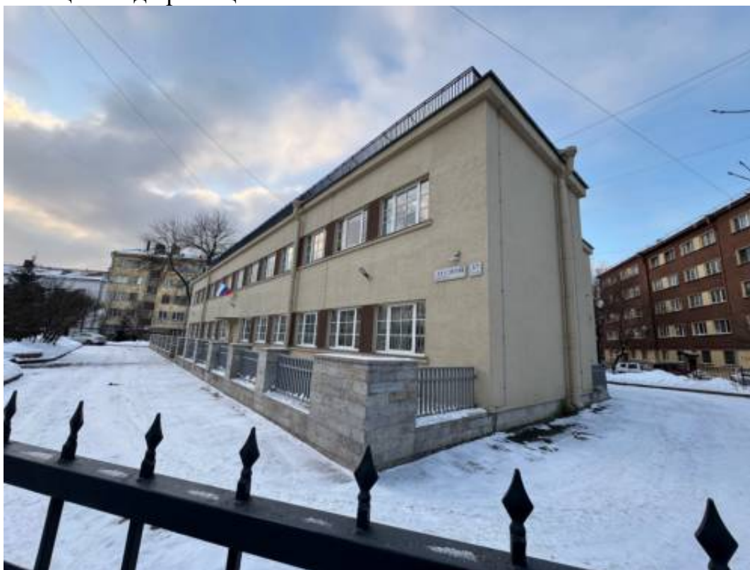
8. Общий вид объекта культурного наследия регионального значения «Здание механической прачечной», 1929–1933 гг., входящего в состав объекта культурного наследия регионального значения «Батенинский жилмассив», 1929–1933 гг., расположенного по адресу: Санкт–Петербург, Лесной проспект, дом 37, литера К.
