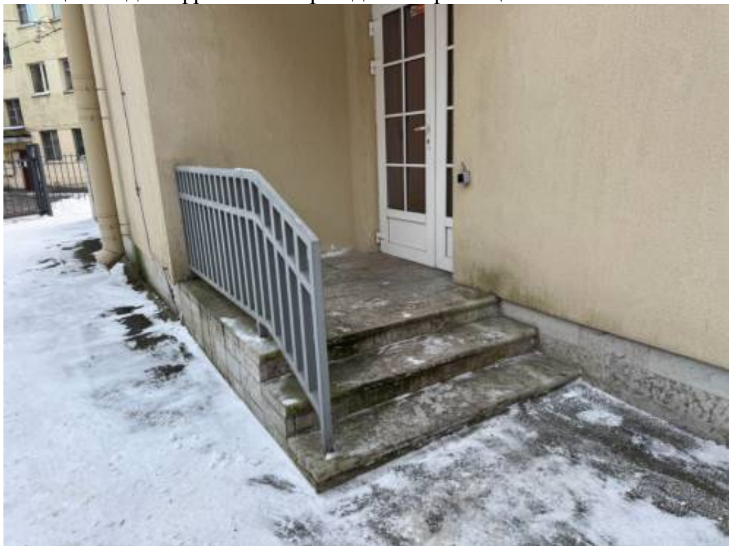
6. Общий вид крыльца К-3.
