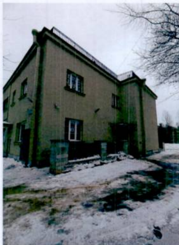
4. Вид на юго-западный фасад объекта культурного наследия.
