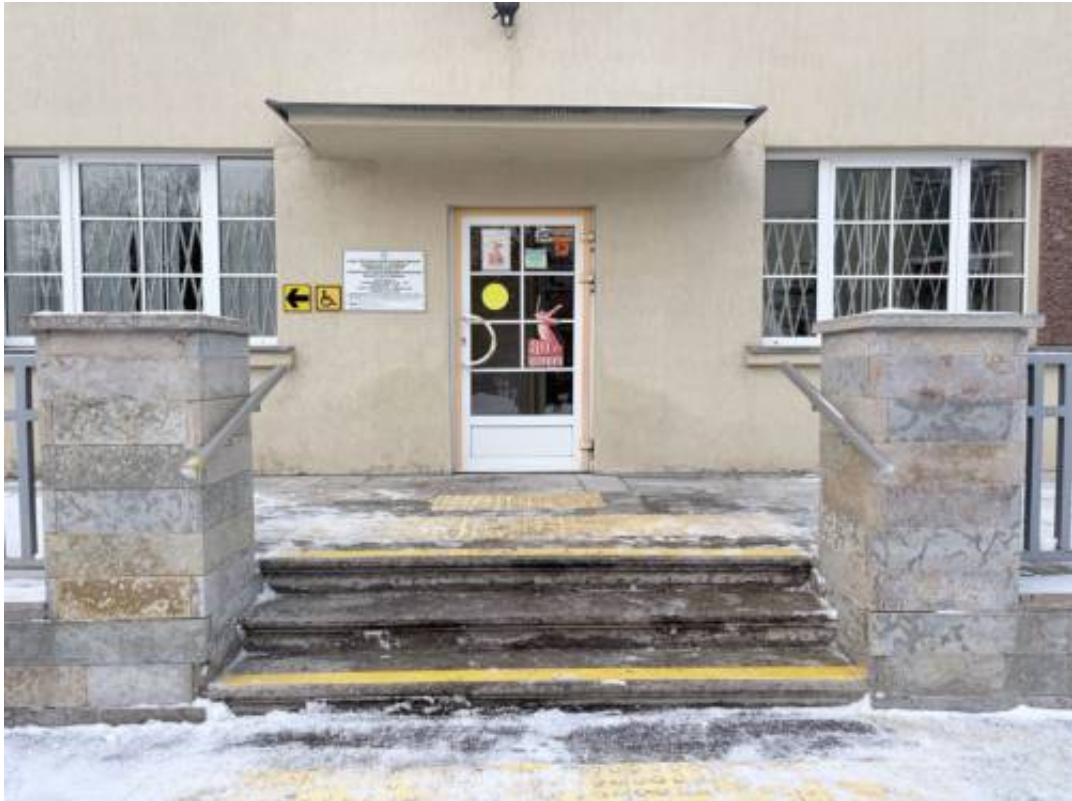
1. Общий вид на фрагмент ограждения крыльца К-1 и на ступени.
