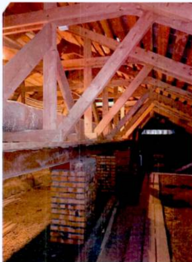
7. Конструкции крыши объекта культурного наследия.
