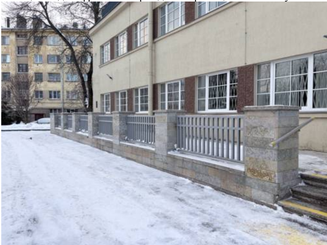
2. Общий вид на фрагмент ограждения крыльца К-1.
