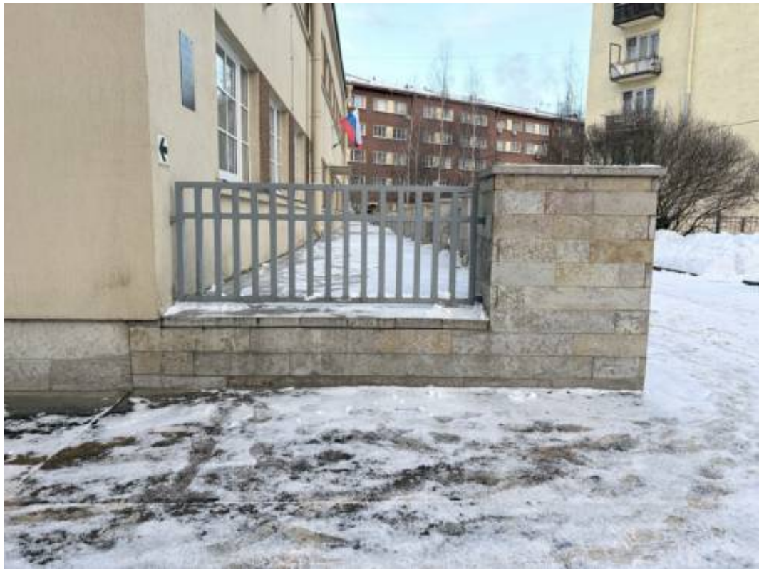
5. Общий вид на фрагмент ограждения крыльца К-1.
