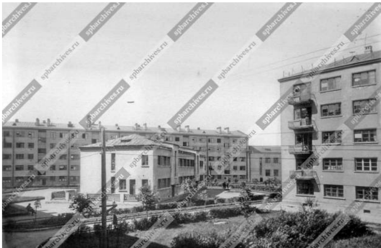
Илл.15. Вид на дома Батенинского жилмассива. 1938 г. ЦГАКФФД СПб. Фотодокументы. Опись 1ГР-52. Ед.хр.78440.
