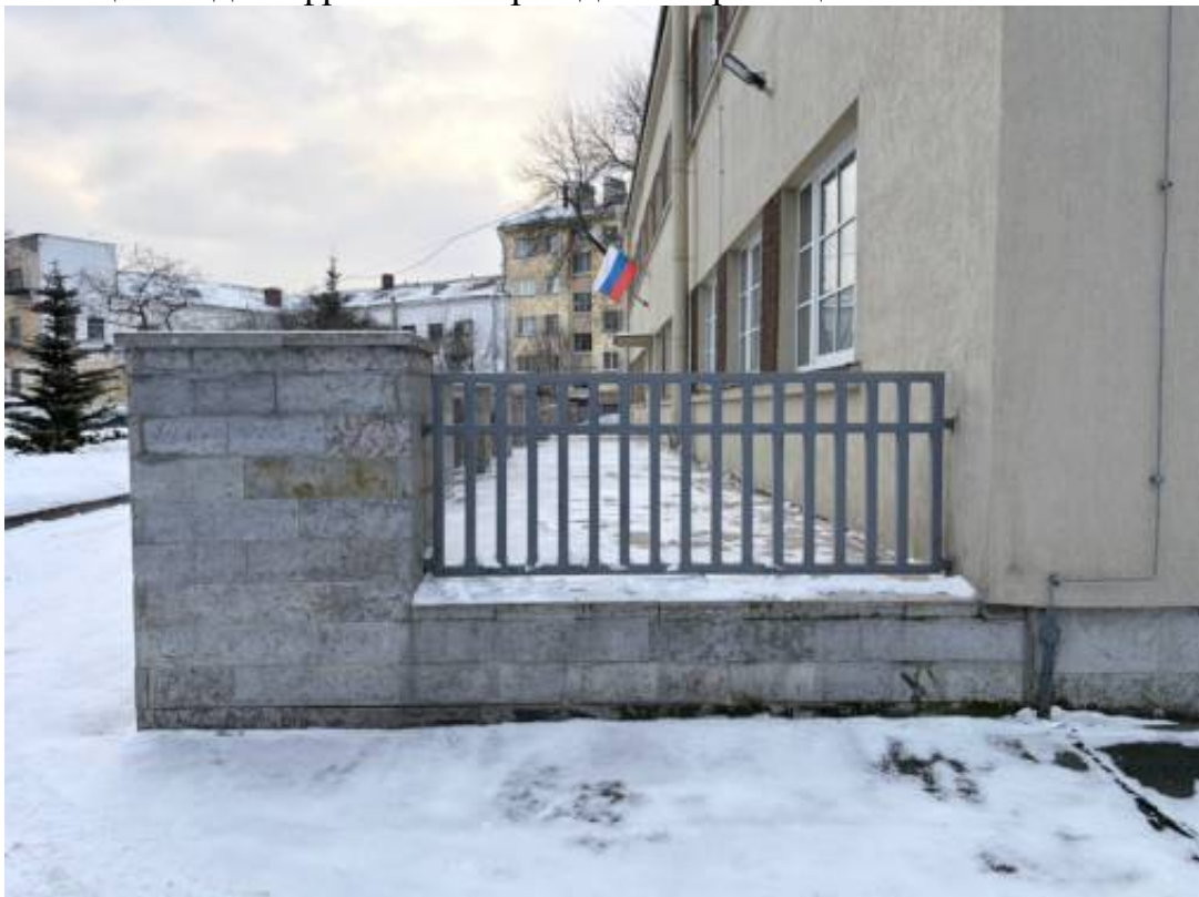
4. Общий вид на фрагмент ограждения крыльца К-1.
