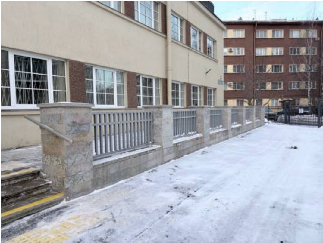
3. Общий вид на фрагмент ограждения крыльца К-1.
