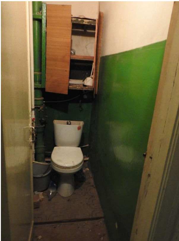
21. «Дом Чехихина», наб. Крюкова кан., д. 9. Первый этаж. Помещение №5 (согласно «Техническому паспорту на квартиру» с инв. №2770/18 от 13.08.2018). Общий вид. Фото 19.11.2025г.
