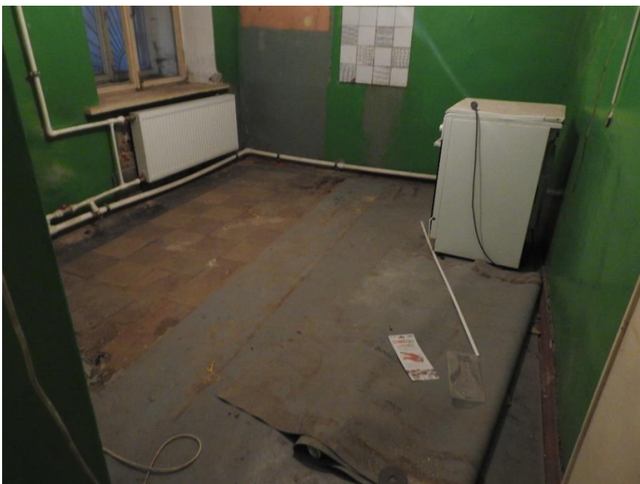
23. «Дом Чехихина», наб. Крюкова кан., д. 9. Первый этаж. Помещение №6 (согласно «Техническому паспорту на квартиру» с инв. №2770/18 от 13.08.2018). Фрагмент. Фото 19.11.2025г.
