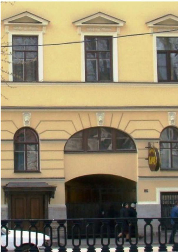
6. Адрес дома: Крюкова наб. канала, дом 9, Фото 12.2012 г. photo_174-178857
