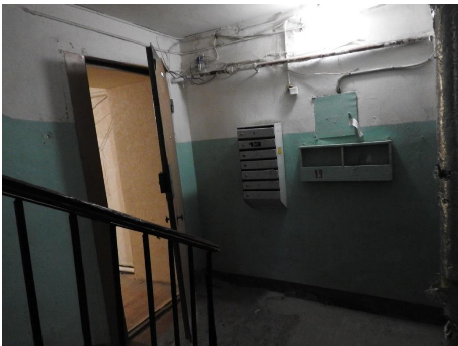
5. «Дом Чешихина», наб. Крюкова кан., д. 9. Первый этаж. Вход в квартиру со стороны лестничной клетки. Общий вид. Фото 19.11.2025г.
