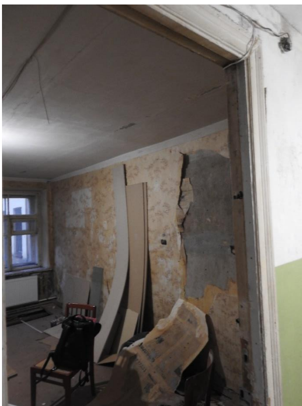
14. «Дом Чешихина», наб. Крюкова кан., д. 9. Первый этаж. Помещение №3 (согласно «Техническому паспорту на квартиру» с инв. №2770/18 от 13.08.2018). Фрагмент. Фото 19.11.2025г.
