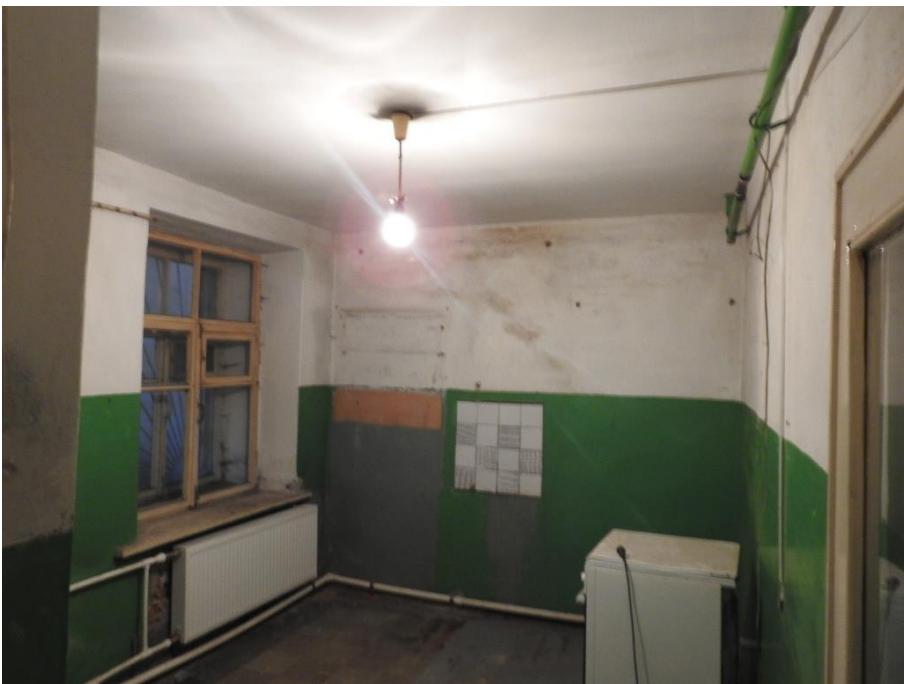
22. «Дом Чехихина», наб. Крюкова кан., д. 9. Первый этаж. Помещение №6 (согласно «Техническому паспорту на квартиру» с инв. №2770/18 от 13.08.2018). Общий вид. Фото 19.11.2025г.
