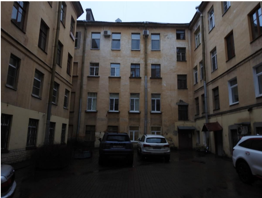
2. «Дом Чешихина», наб. Крюкова кан., д. 9. Дворовый фасад. Общий вид. Фото 19.11.2025г.
