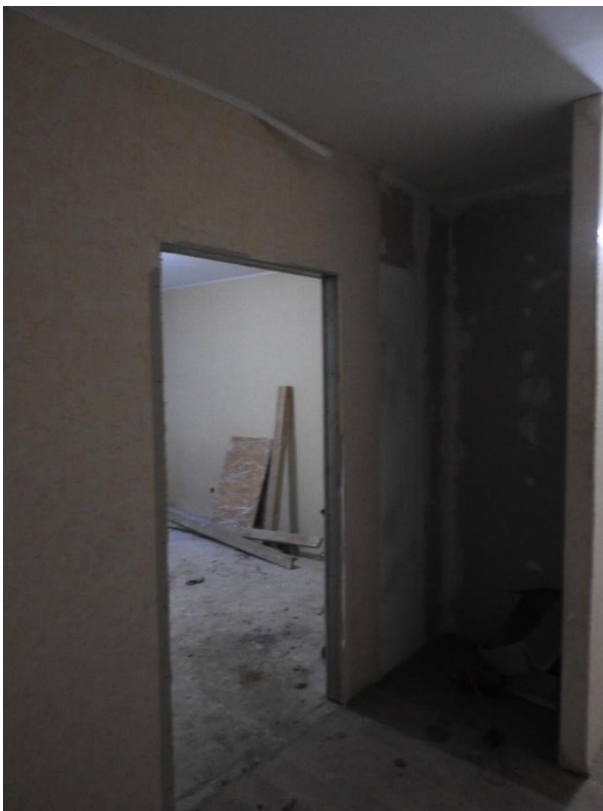
12. «Дом Чешихина», наб. Крюкова кан., д. 9. Первый этаж. Помещение №1 (согласно «Техническому паспорту на квартиру» с инв. №2770/18 от 13.08.2018). Фрагмент. Фото 19.11.2025г.
