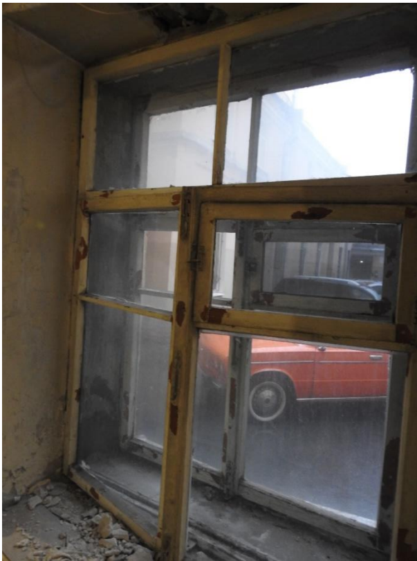
11. «Дом Чешихина», наб. Крюкова кан., д. 9. Первый этаж. Помещение №1 (согласно «Техническому паспорту на квартиру» с инв. №2770/18 от 13.08.2018). Фрагмент. Фото 19.11.2025г.
