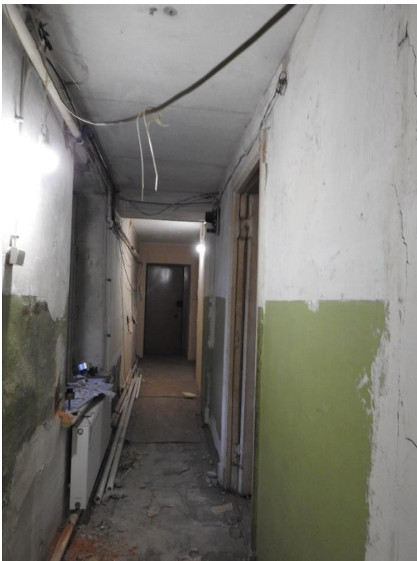
8. «Дом Чехихина», наб. Крюкова кан., д. 9. Первый этаж. Помещение №1 (согласно «Техническому паспорту на квартиру» с инв. №2770/18 от 13.08.2018). Общий вид. Фото 19.11.2025г.
