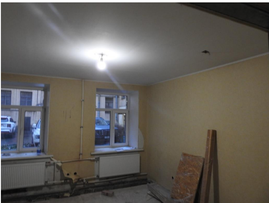
13. «Дом Чешихина», наб. Крюкова кан., д. 9. Первый этаж. Помещение №2 (согласно «Техническому паспорту на квартиру» с инв. №2770/18 от 13.08.2018). Общий вид. Фото 19.11.2025г.
