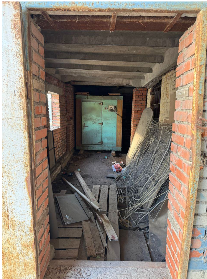
Фото 13. Выявленный объект культурного наследия №1 «Здание товарной станции Московско-Виндаво-Рыбинской железной дороги». Адрес: Санкт-Петербург, Лиговский проспект, дом 240, лит И. Общий вид помещения П7 (пристройка).
