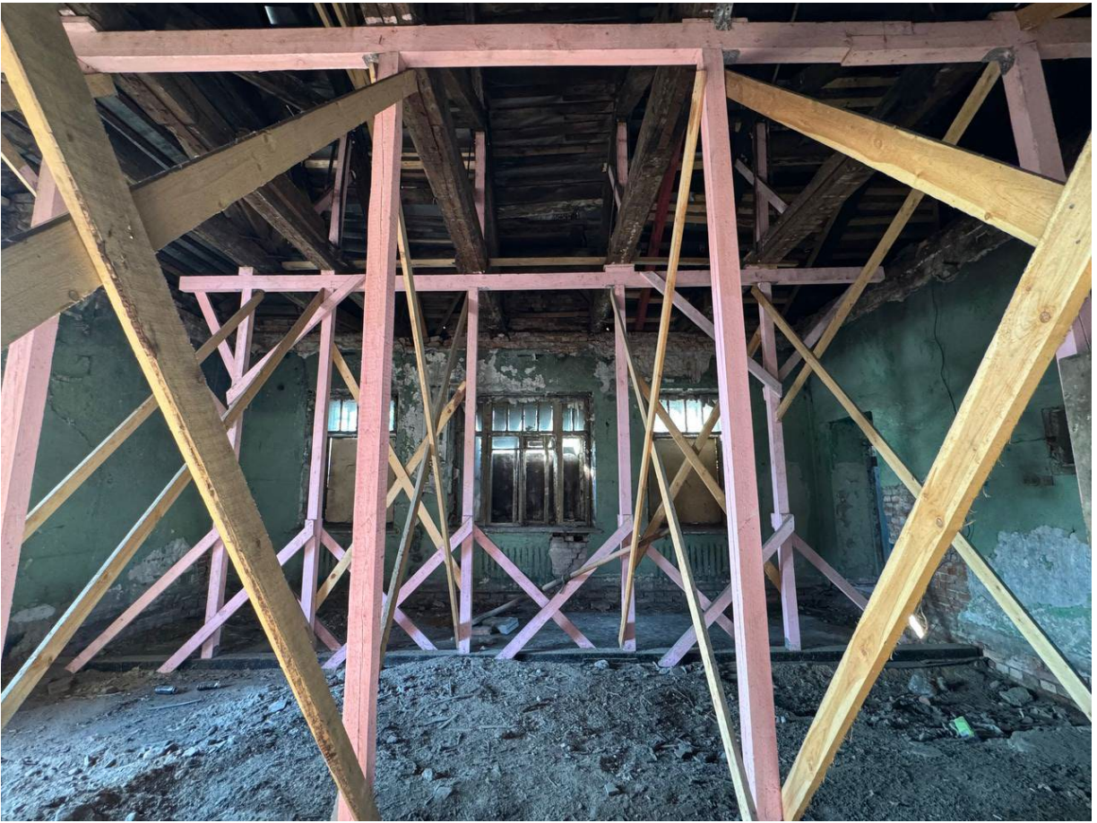
Фото 6. Выявленный объект культурного наследия №1 «Здание товарной станции Московско-Виндаво-Рыбинской железной дороги». Адрес: Санкт-Петербург, Лиговский проспект, дом 240, лит И. Общий вид помещения П1.
