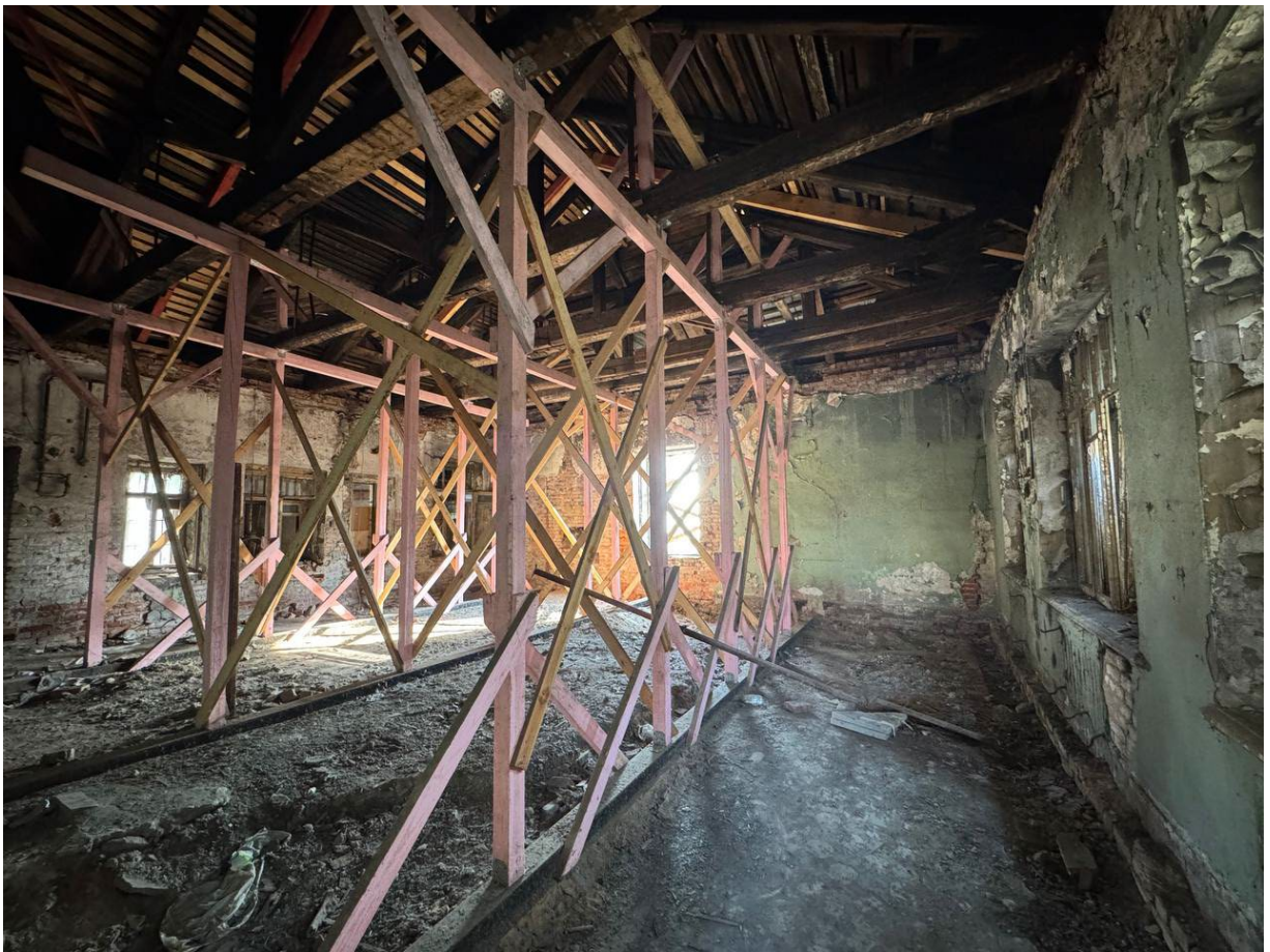
Фото 7. Выявленный объект культурного наследия №1 «Здание товарной станции Московско-Виндаво-Рыбинской железной дороги». Адрес: Санкт-Петербург, Лиговский проспект, дом 240, лит И. Общий вид помещения П1.
