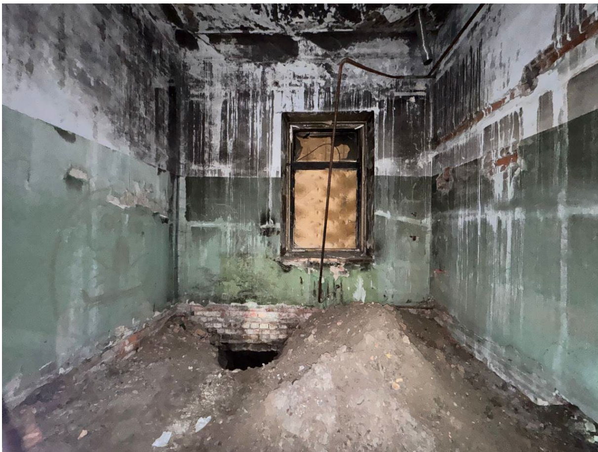
Фото 11. Выявленный объект культурного наследия №1 «Здание товарной станции Московско-Виндаво-Рыбинской железной дороги». Адрес: Санкт-Петербург, Лиговский проспект, дом 240, лит И. Общий вид помещения П4.
