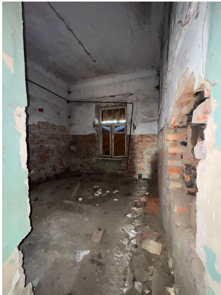
Фото 10. Выявленный объект культурного наследия №1 «Здание товарной станции Московско-Виндаво-Рыбинской железной дороги». Адрес: Санкт-Петербург, Лиговский проспект, дом 240, лит И. Общий вид помещения ПЗ.
