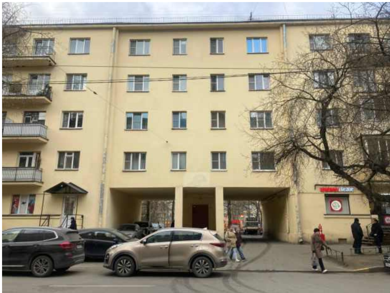
10. Выявленный объект культурного наследия «Жилой дом», входящий в состав выявленного объекта культурного наследия «Комплекс зданий Бабуриного жилмассива» по адресу: Санкт-Петербург, Выборгский район, ул. Смольяčkова, дом 14, корп. 1, лит. Б Вид со стороны ул. Смольяčkова
