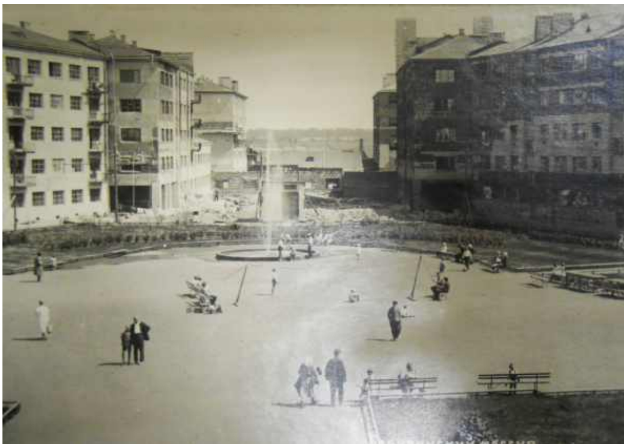
Ил. 9 Бабури́нский жилмассив. Общий вид части жилмассива. 1934 г. ЦГА КФФД. Гр 49835.
