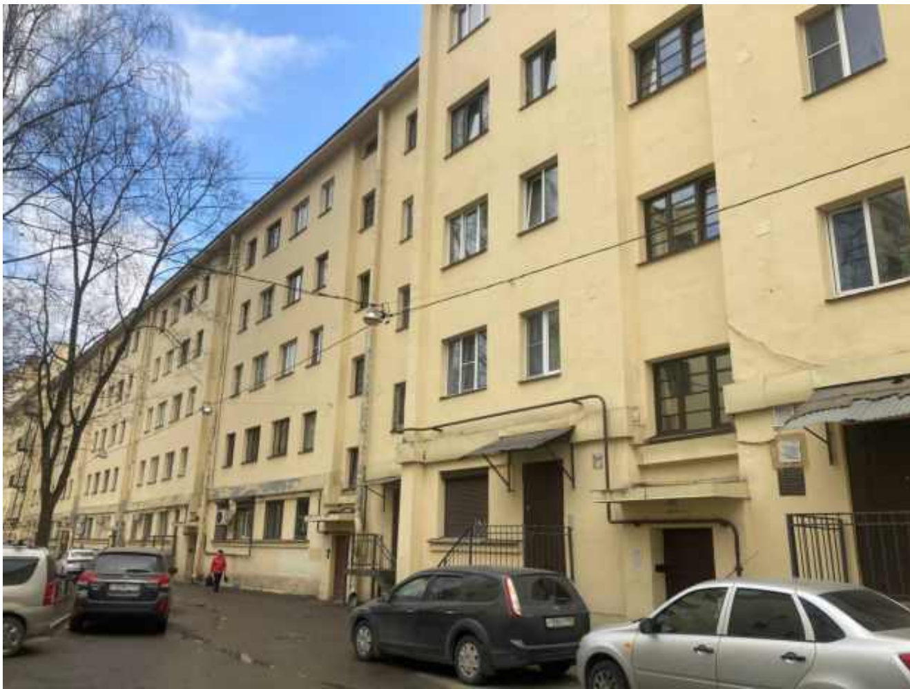
16. Выявленный объект культурного наследия «Жилой дом», входящий в состав выявленного объекта культурного наследия «Комплекс зданий Бабуриного жилмассива» по адресу: Санкт-Петербург, Выборгский район, ул. Смолячкова, дом 14, корп. 1, лит. Б Вид со стороны двора
