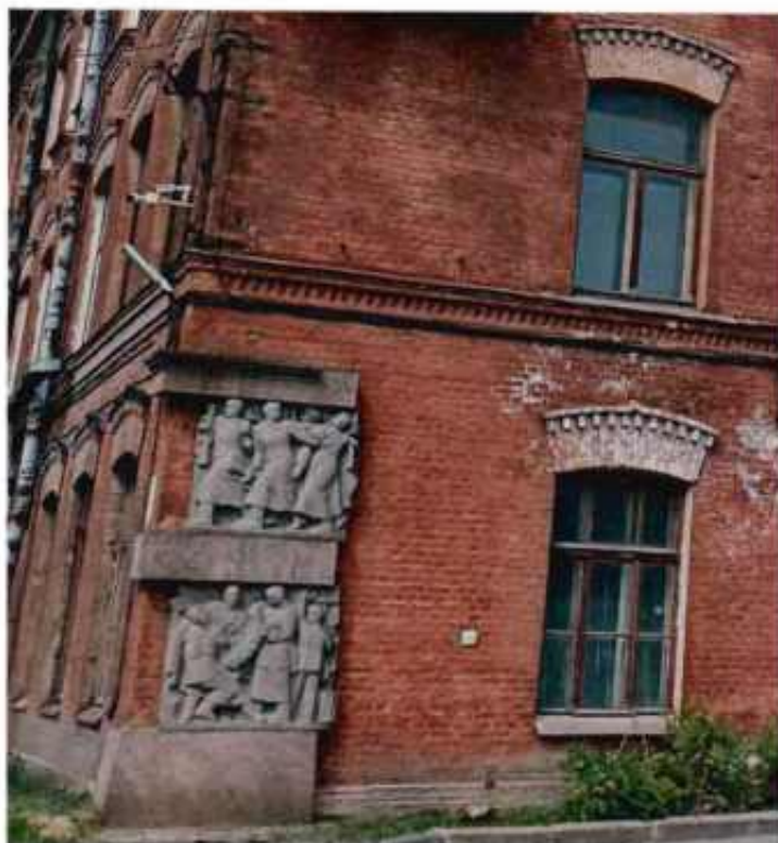
7. Фрагмент. Восточный фасад объекта культурного наследия, барельеф.
