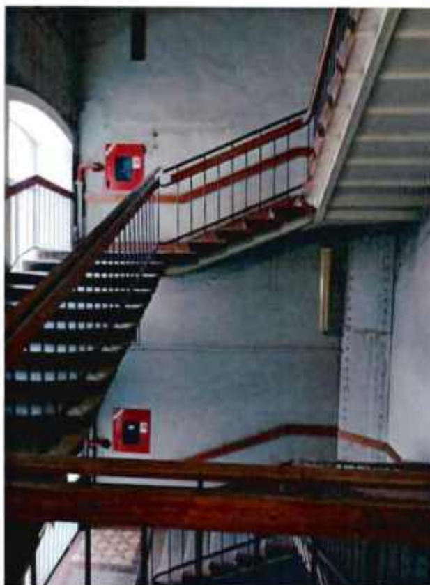
11. Интерьер объекта культурного наследия. Помещение 1ЛК(7) в уровне второго этажа.
