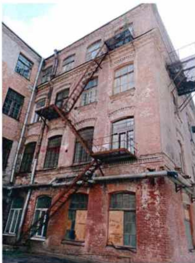
6. Общий вид. Западная часть северного фасада объекта культурного наследия.
