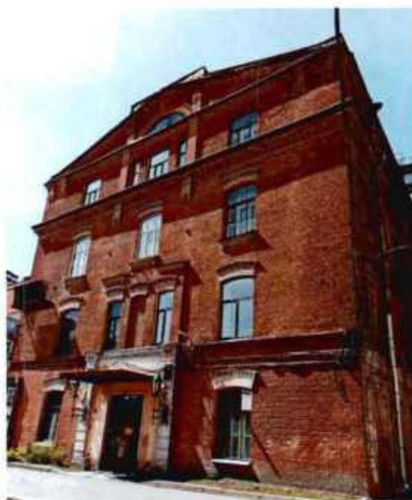
2. Общий вид. Восточный фасад объекта культурного наследия.
