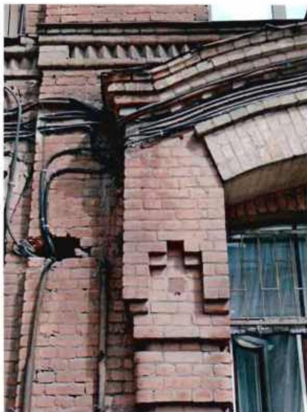
9. Фрагмент. Южный фасад объекта культурного наследия.
