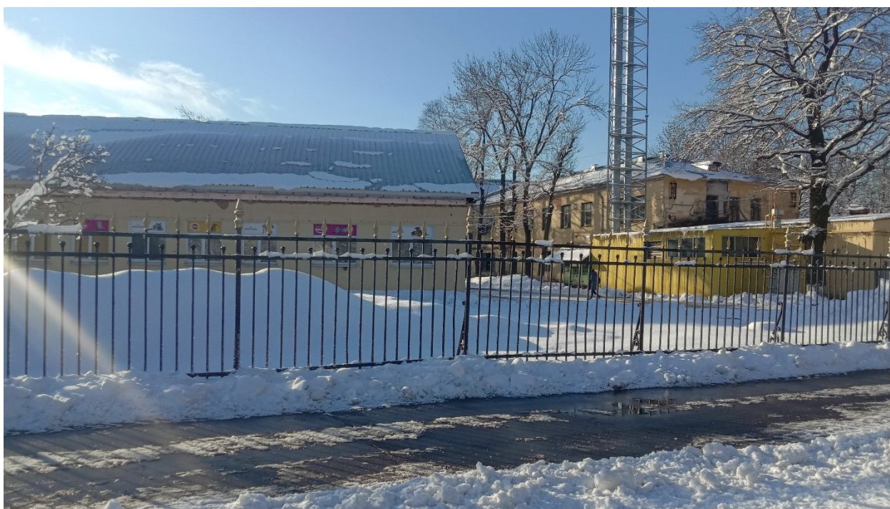
Фото 4. Общий вид на объект культурного наследия регионального значения «Ограда».
