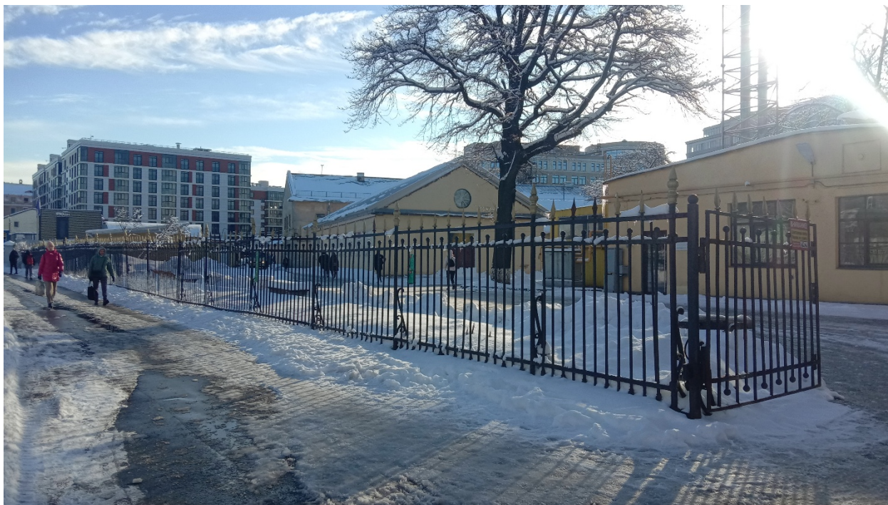
Фото 1. Общий вид на объект культурного наследия регионального значения «Ограда».
