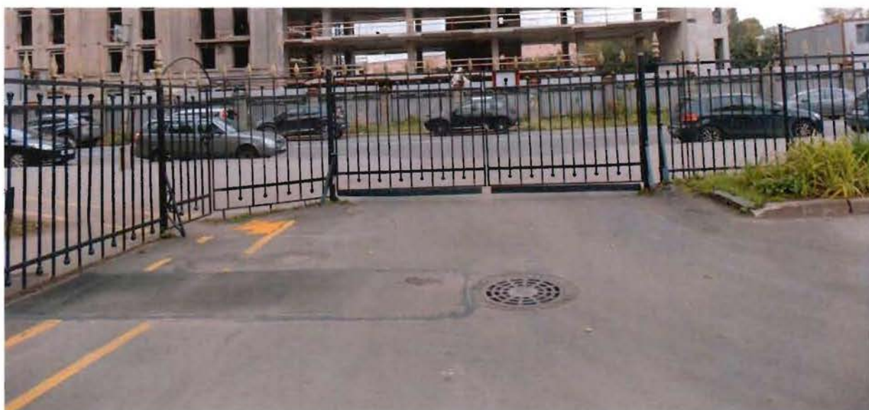
2. Фрагмент объекта культурного наследия. Вид с дворовой территории.
