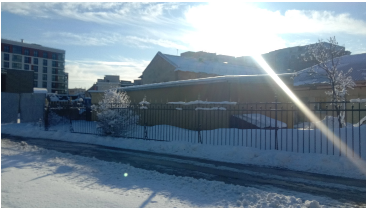
Фото 5. Общий вид на объект культурного наследия регионального значения «Ограда».
