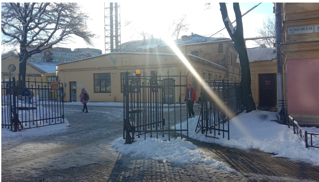
Фото 2. Общий вид на объект культурного наследия регионального значения «Ограда».
