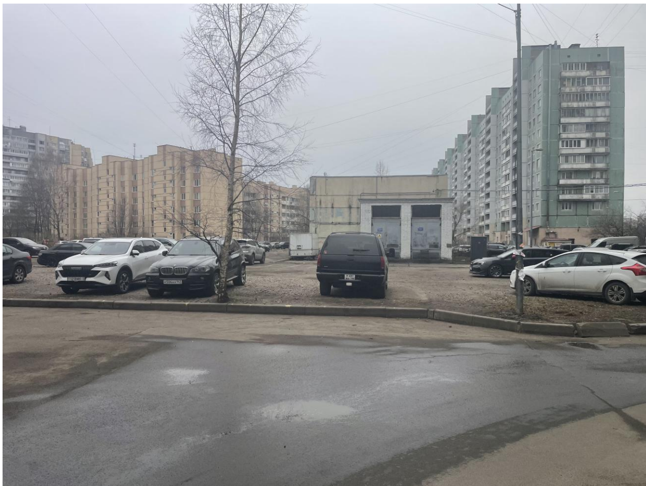
Фото № 8. Зона производства работ. Территория реконструкции двух участков водопроводных магистралей.
