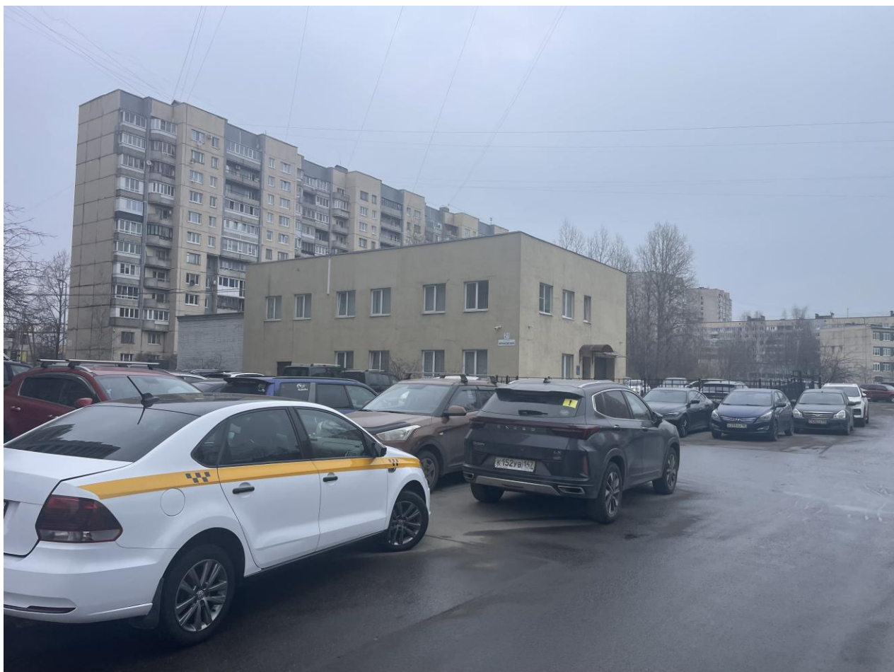
Фото № 3. Зона производства работ. Территория реконструкции двух участков водопроводных магистралей.
