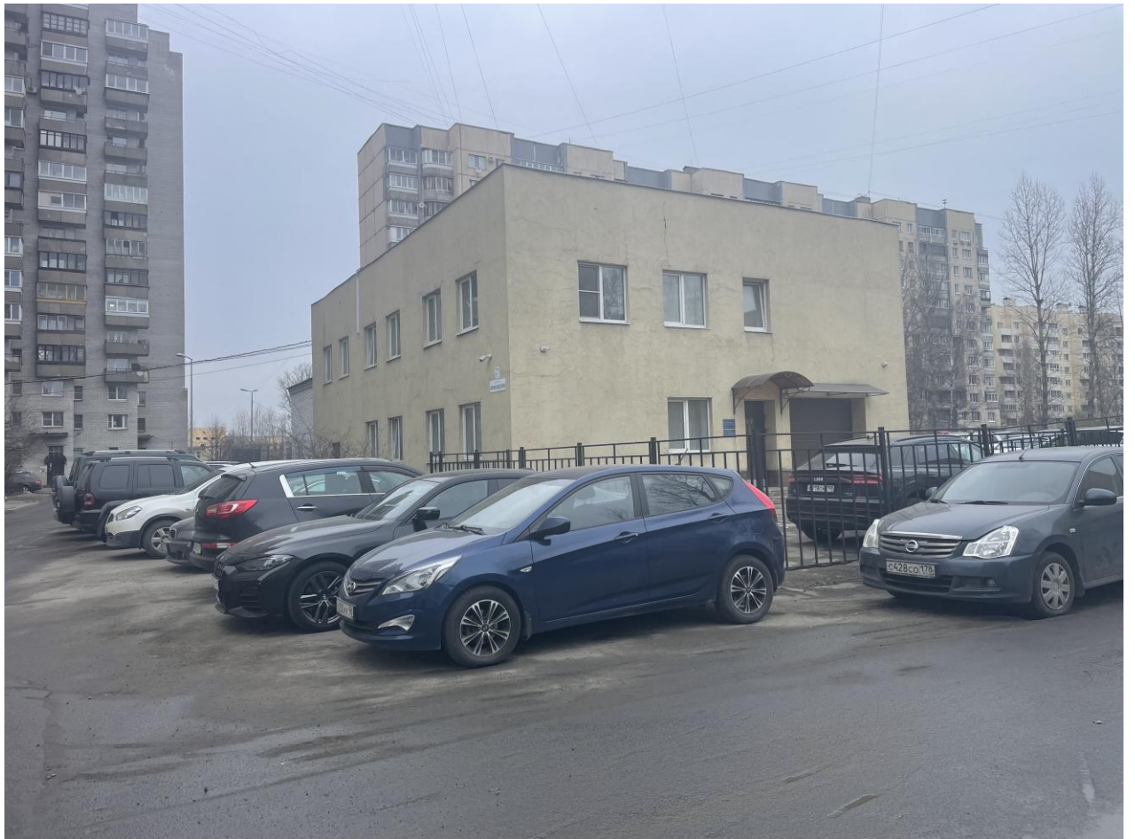
Фото № 4. Зона производства работ. Территория реконструкции двух участков водопроводных магистралей. Фото Лобановой Н. В. (13.03.2026 г.)
