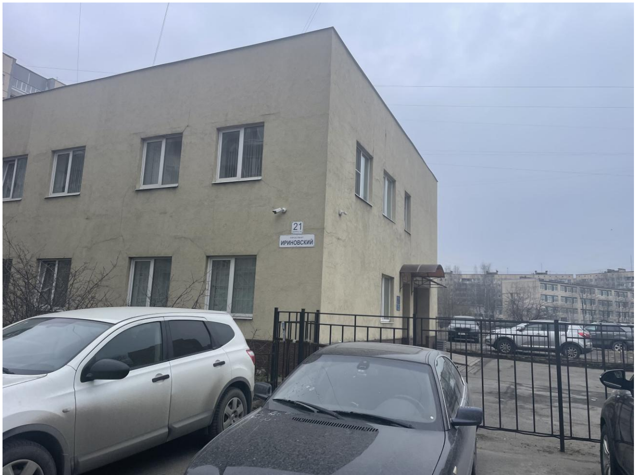
Фото № 6. Зона производства работ. Территория реконструкции двух участков водопроводных магистралей. Фото Лобановой Н. В. (13.03.2026 г.)
