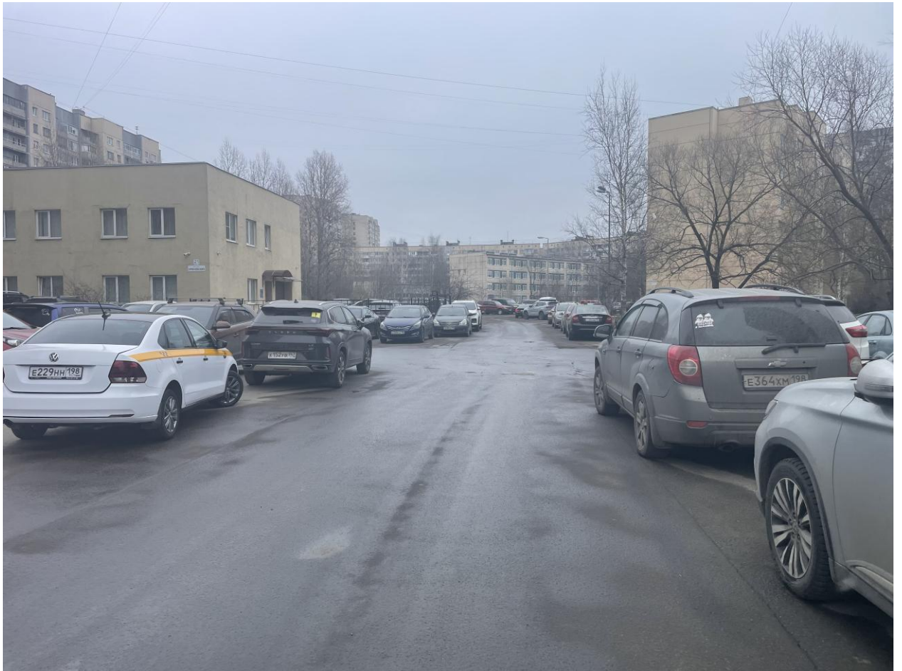
Фото № 2. Зона производства работ. Территория реконструкции двух участков водопроводных магистралей. Фото Лобановой Н. В. (13.03.2026 г.)
