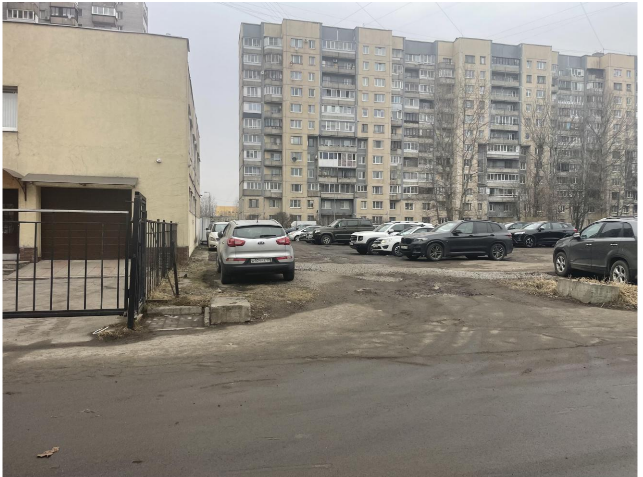
Фото № 7. Зона производства работ. Территория реконструкции двух участков водопроводных магистралей.
