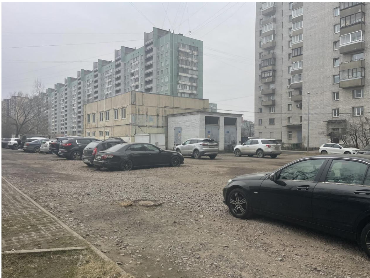
Фото № 10. Зона производства работ. Территория реконструкции двух участков водопроводных магистралей.
