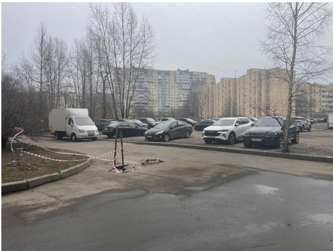
Фото № 9. Зона производства работ. Территория реконструкции двух участков водопроводных магистралей. Фото Лобановой Н. В. (13.03.2026 г.)
