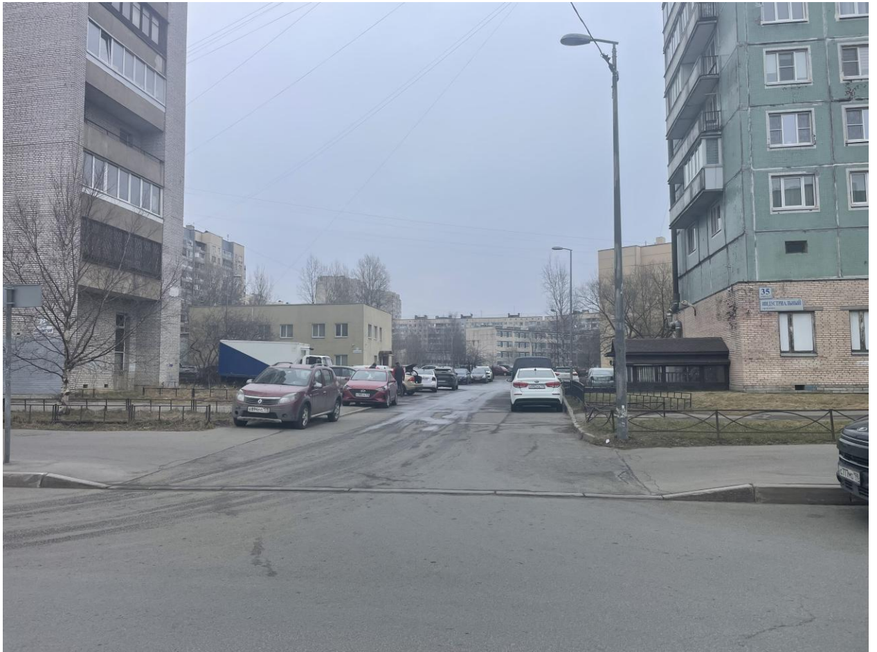
Фото № 1. Зона производства работ. Территория реконструкции двух участков водопроводных магистралей. Фото Лобановой Н. В. (13.03.2026 г.)
