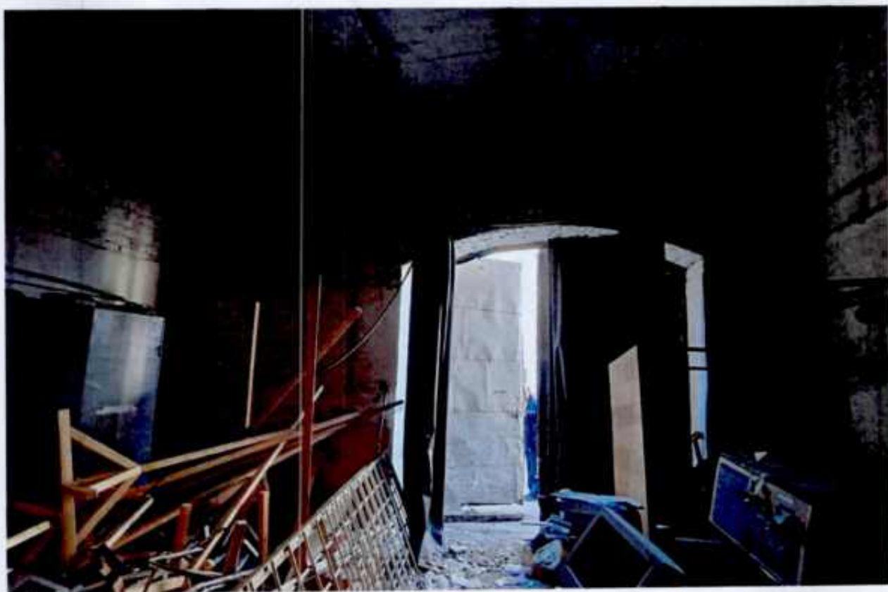
3. Помещение 1-го этажа.
