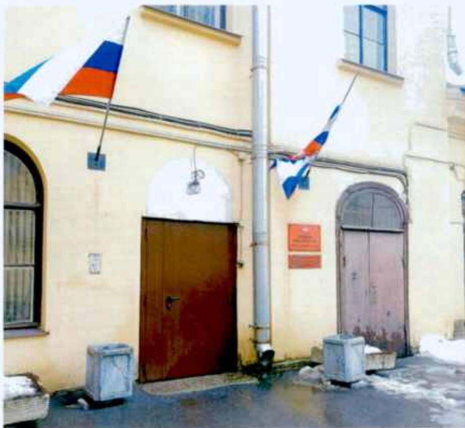
5. Фрагмент. Западный фасад объекта культурного наследия.
