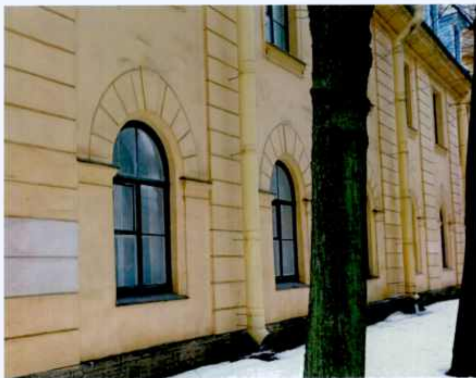
6. Фрагмент. Северный фасад объекта культурного наследия.
