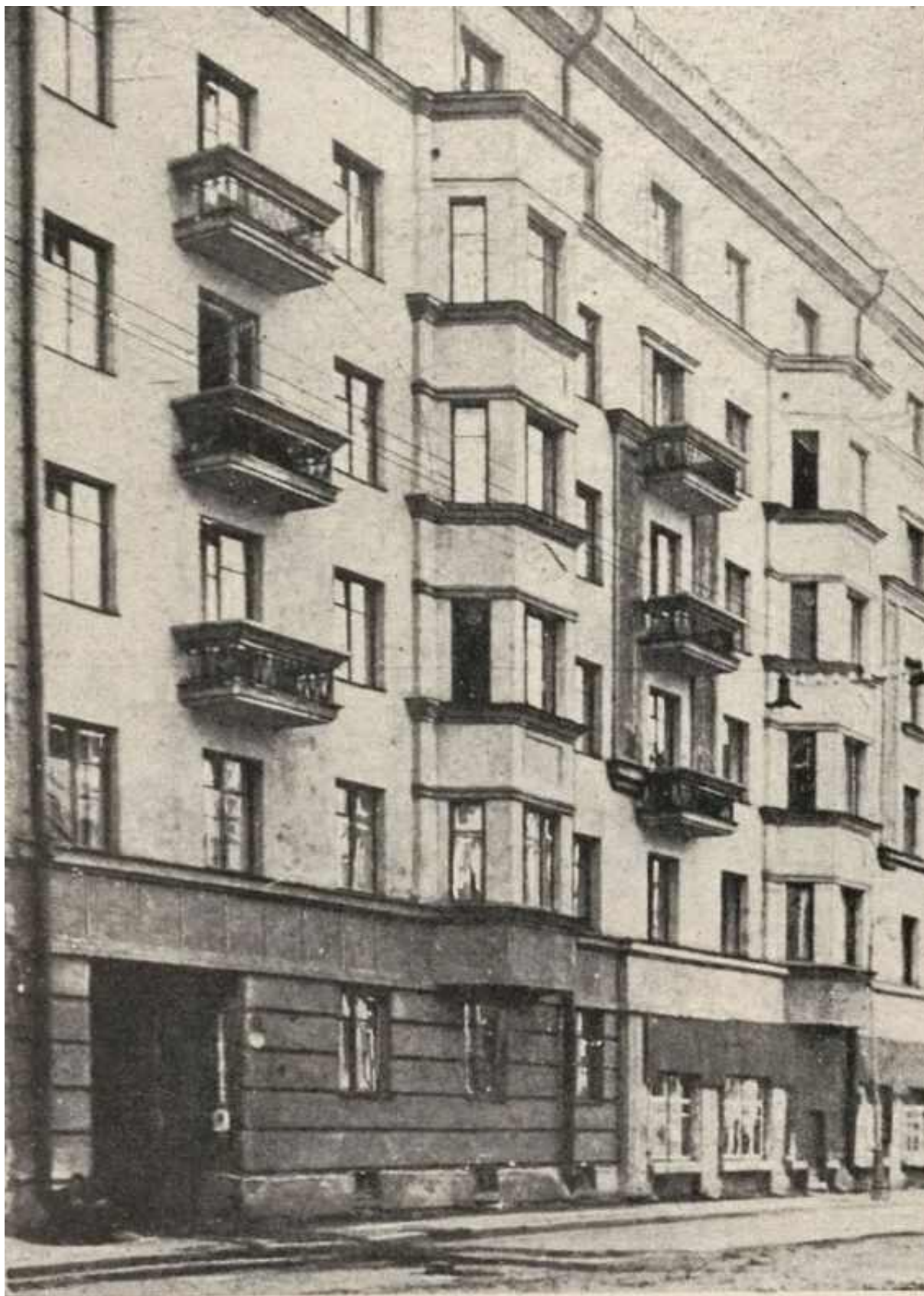
4. Жилой дом театральных работников на Бородинской улице. Авторы: инженер В.Г. Гевирц и Н.И. Смирнов. Фасад (обработка проф. А.А. Оль) со стороны Бородинской улицы
