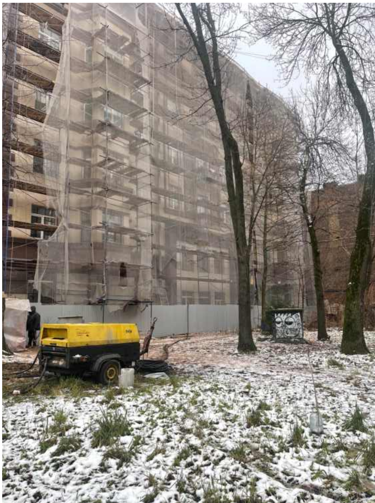
1. Вид на западный лицевой фасад
