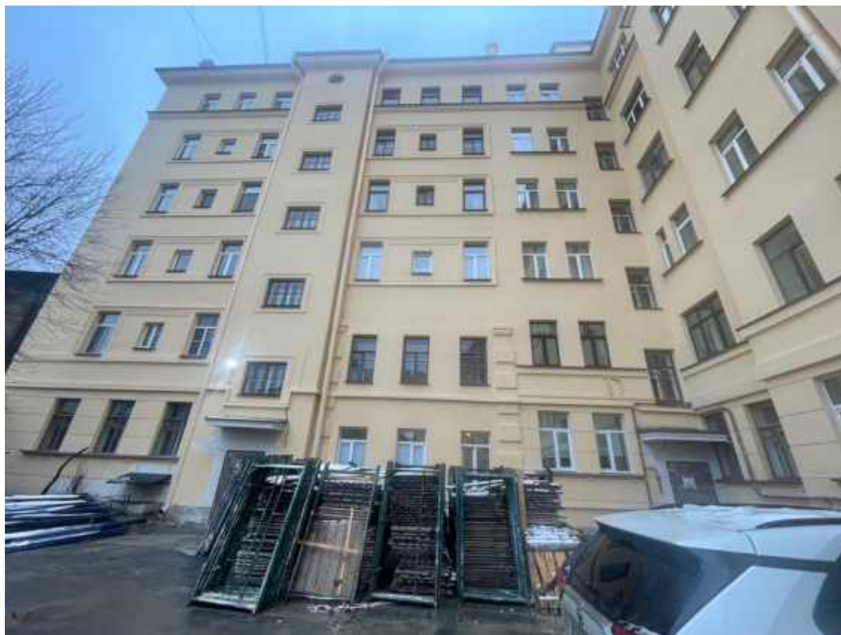
2. Вид на дворовой фасад здания
