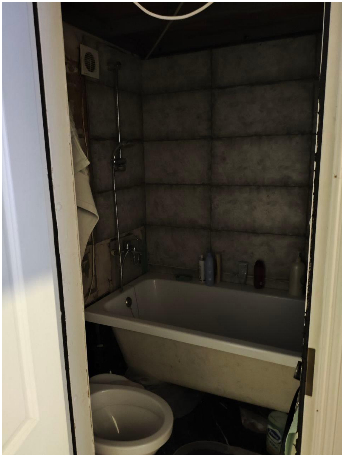
13. Объект культурного наследия регионального значения «Дом К.Я. Маевского» г. Санкт-Петербург, наб. реки Фонтанки, д. 110, лит. А. Квартира 38. Санузел жилой комнаты №3.
