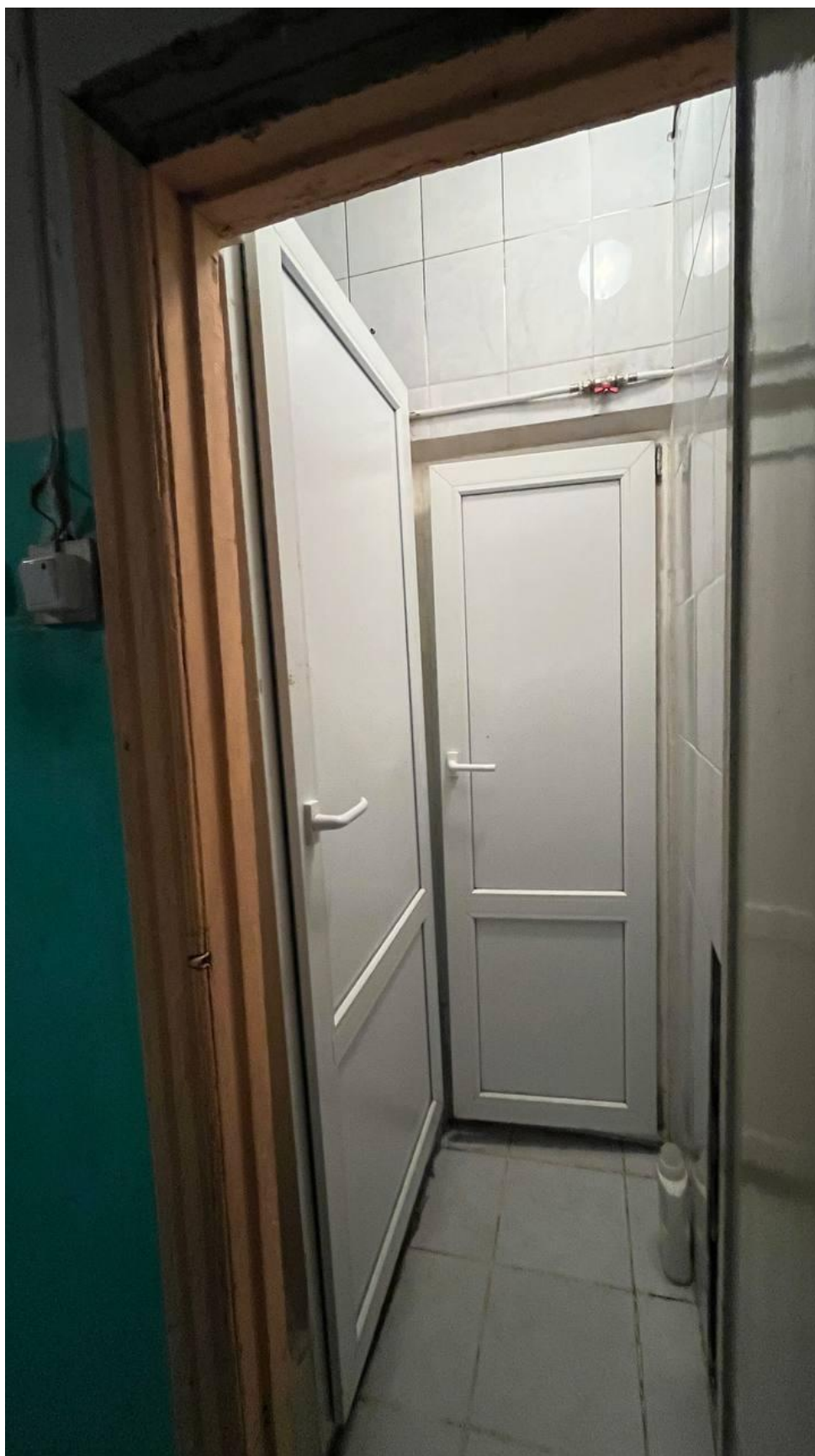
23. Объект культурного наследия регионального значения «Дом К.Я. Маевского» г. Санкт-Петербург, наб. реки Фонтанки, д. 110, лит. А. Квартира 38. Двери общего санузла коридора.
