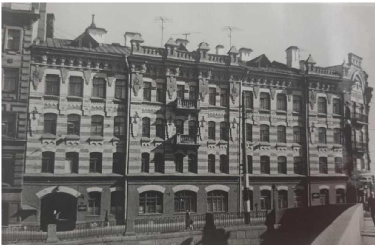
Илл. 7. Фасад здания «Дом К.Я. Маевского» по наб. р. Фонтанки. 1968 г. Архив института «ЛЕНЖИЛПРОЕКТ»
