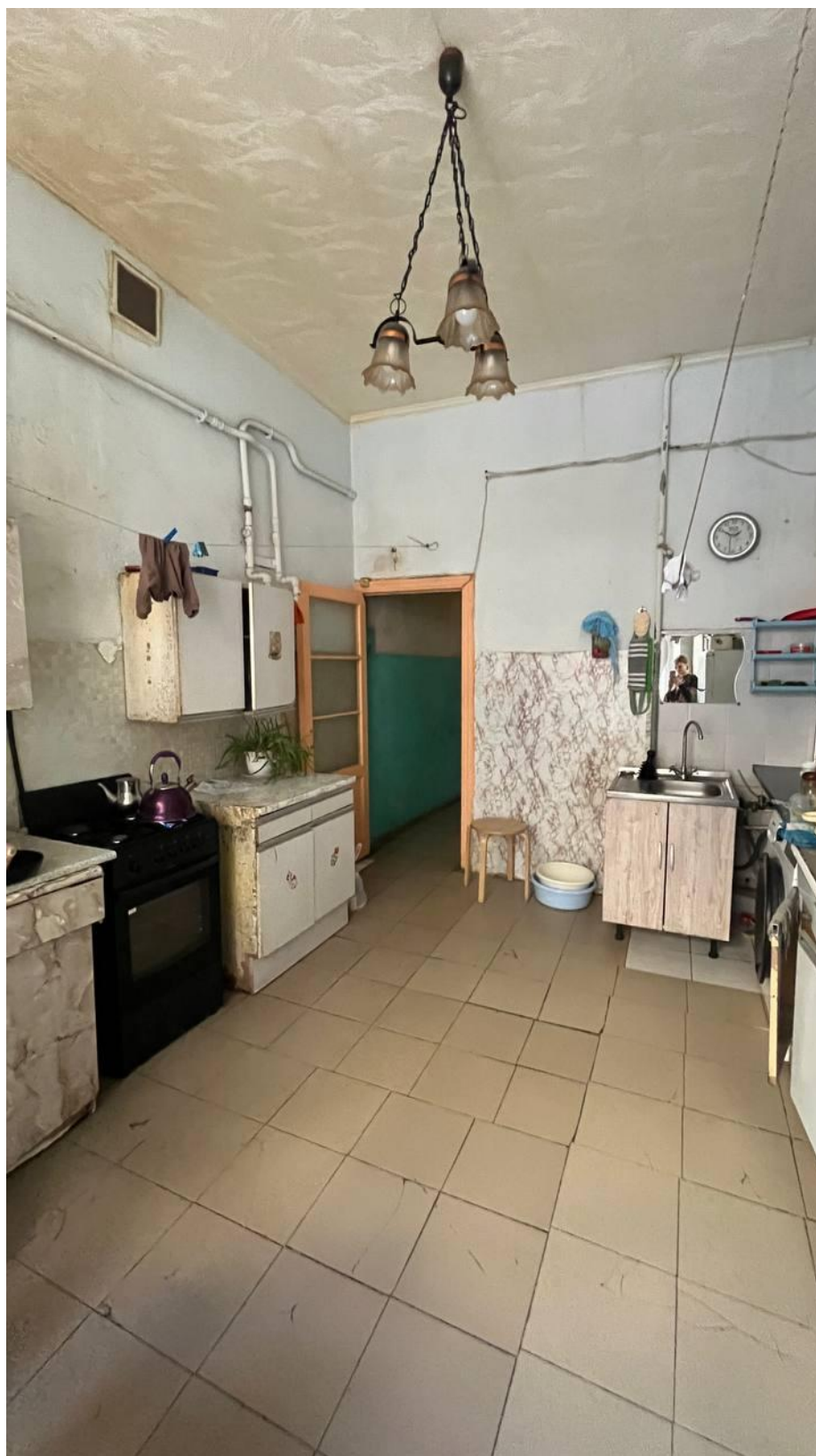
19. Объект культурного наследия регионального значения «Дом К.Я. Маевского» г. Санкт-Петербург, наб. реки Фонтанки, д. 110, лит. А. Квартира 38. Восточная часть кухни.
