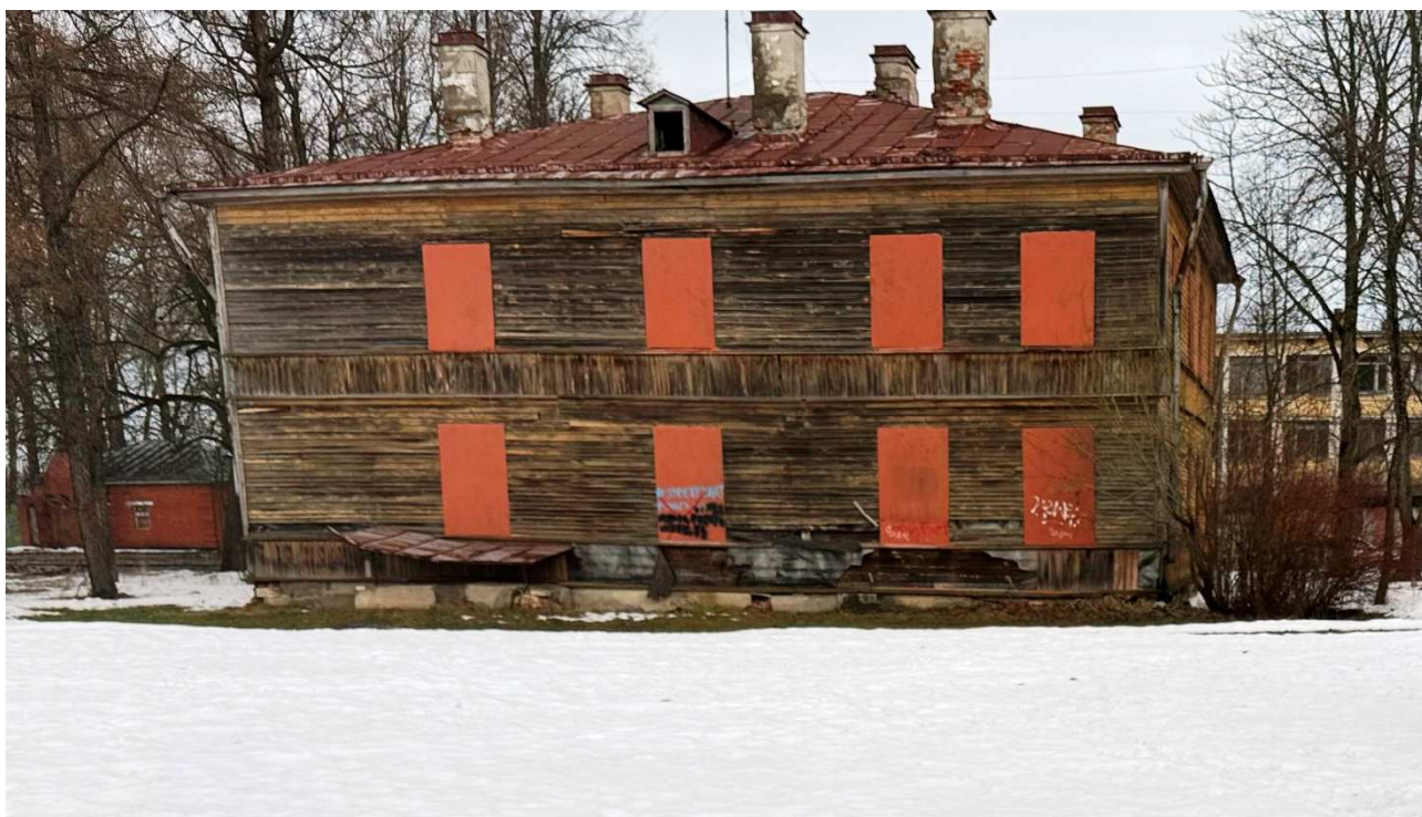
7. Выявленный объект культурного наследия «дом Н. Шарубина(?)». Общий вид южного фасада.
