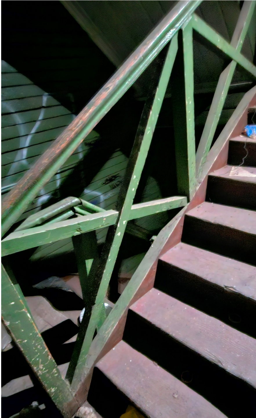
16. Выявленный объект культурного наследия «дом Н. Шарубина(?)». Лестничный марш на 2-й этаж. Вид лестничного ограждения.
