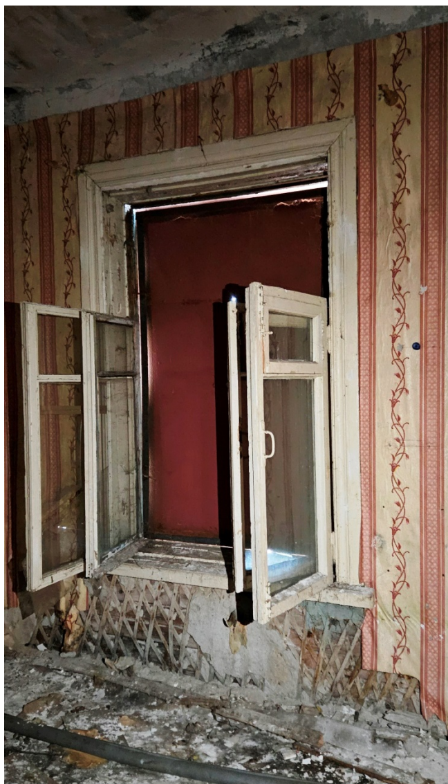
15. Выявленный объект культурного наследия «дом Н. Шарубина(?)». 1-й этаж. Отделка пом.6. Вид оконных заполнений.
