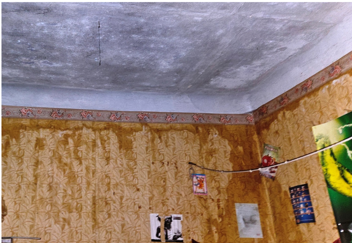
14. Выявленный объект культурного наследия «дом Н. Шарубина(?)». 1-й этаж. Отделка пом.2. Вид потолка.
