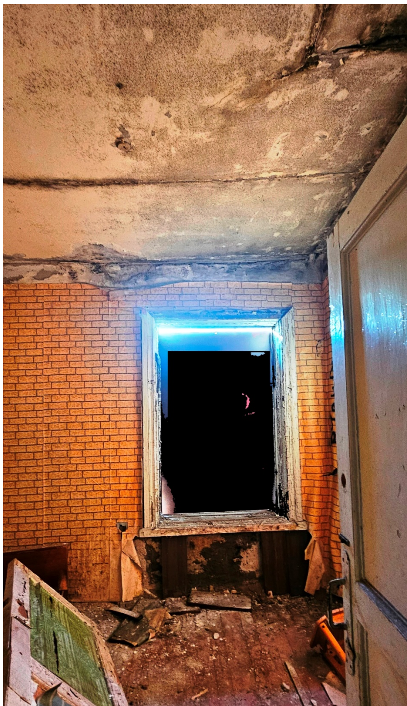
19. Выявленный объект культурного наследия «дом Н. Шарубина(?)». 2-й этаж, пом.6. Вид потолка и отделки стен.
