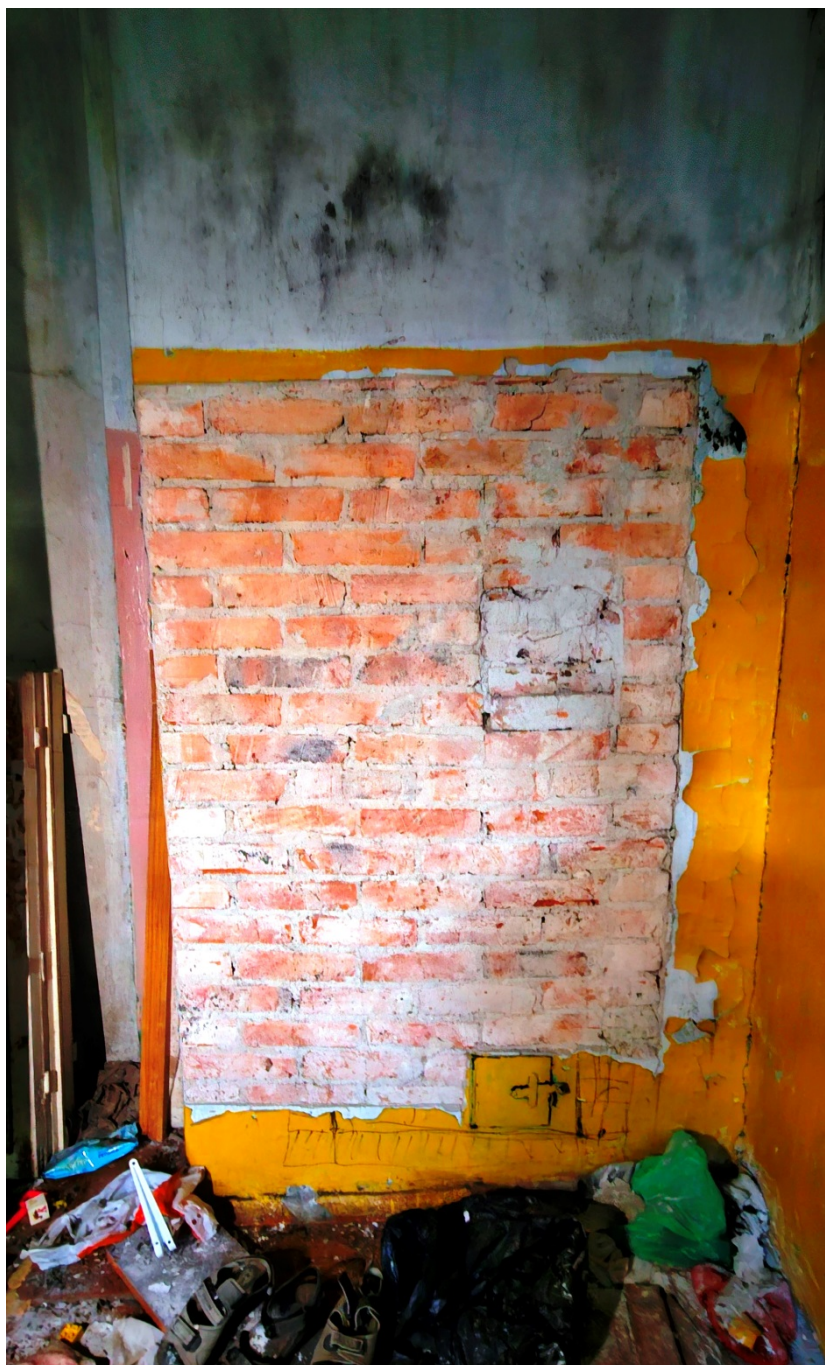
13. Выявленный объект культурного наследия «дом Н. Шарубина(?)». 1-й этаж. Печь в пом. 8.
