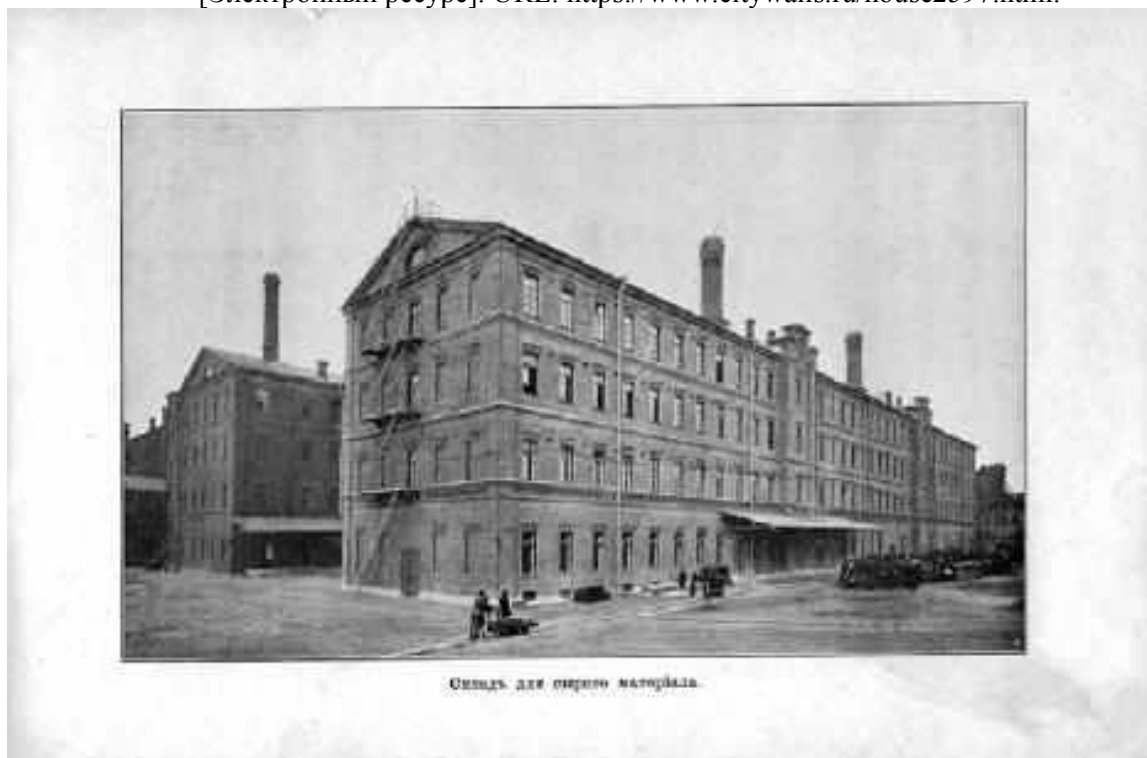
13. Корпуса фабрики «Треугольник» (228 – слева и 231- справа до надстройки). 1905 г. — Российско-Американская резиновая мануфактура "Треугольник". Производственные здания и школа // Citywalls.ru – архитектурный сайт Петербурга [Электронный ресурс]. URL: https://www.citywalls.ru/house2597.html .
