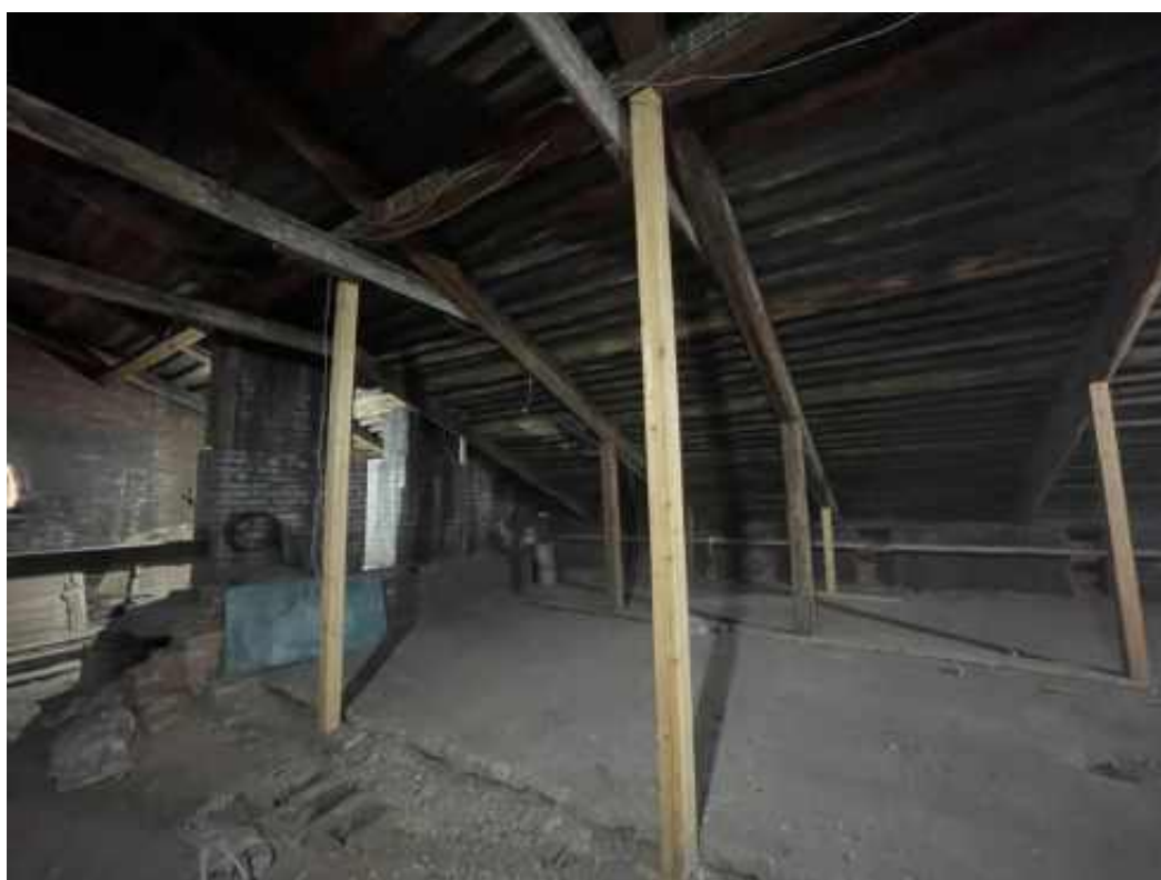
Фото 86. Интерьер чердака объекта культурного наследия регионального значения «Гараж (корпус 266)», входящего в состав объекта культурного наследия регионального значения «Комплекс товарищества Российско-Американской резиновой мануфактуры «Треугольник»
