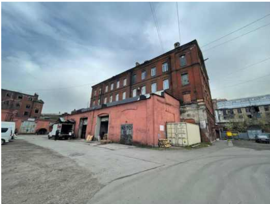
Фото 3. Фрагмент лицевого фасада объекта культурного наследия регионального значения «Гараж (корпус 266)», входящего в состав объекта культурного наследия регионального значения «Комплекс товарищества Российско-Американской резиновой мануфактуры «Треугольник»
