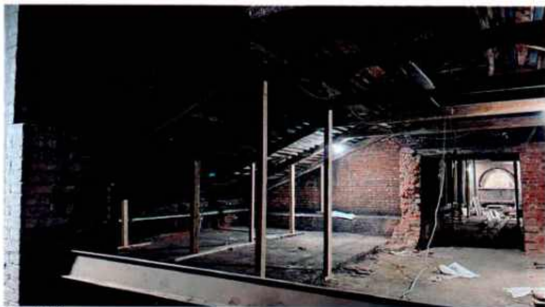
Фото 16. Стропильная система объекта культурного наследия.
