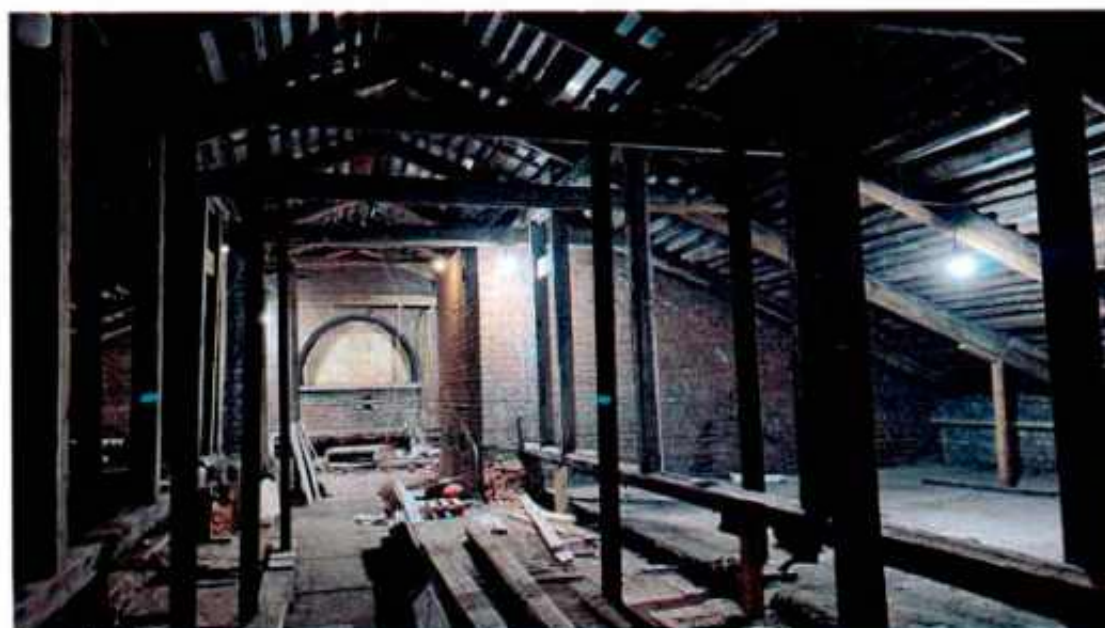
Фото 18. Стропильная система объекта культурного наследия.
