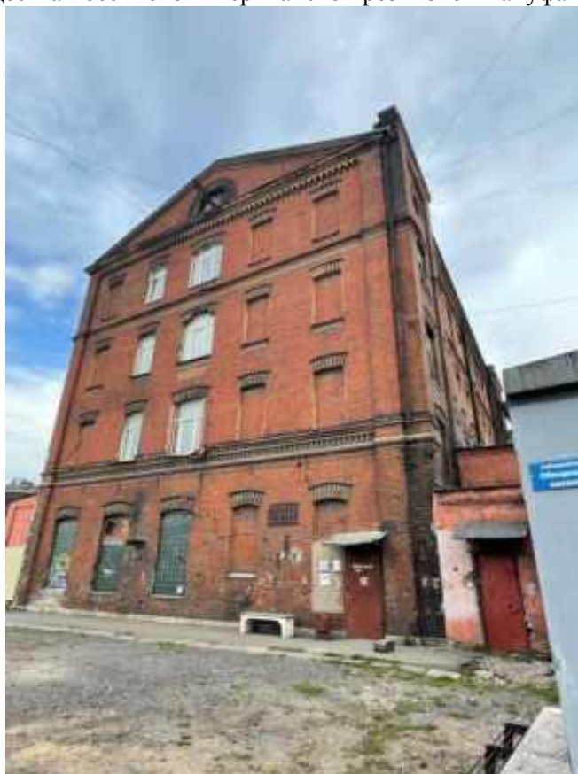
Фото 4. Фрагмент лицевого фасада объекта культурного наследия регионального значения «Гараж (корпус 266)», входящего в состав объекта культурного наследия регионального значения «Комплекс товарищества Российско-Американской резиновой мануфактуры «Треугольник»
