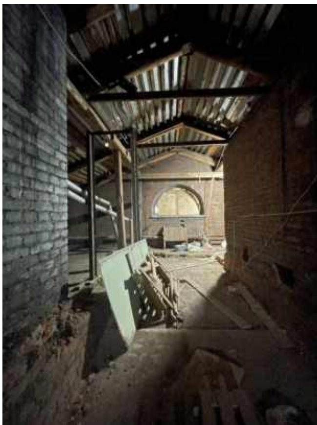
Фото 89. Интерьер чердака объекта культурного наследия регионального значения «Гараж (корпус 266)», входящего в состав объекта культурного наследия регионального значения «Комплекс товарищества Российско-Американской резиновой мануфактуры «Треугольник»
