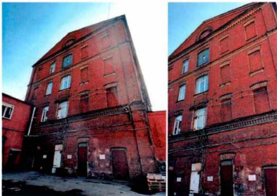
Фото 5, 6. Северо-восточный торцевой фасад объекта культурного наследия.
