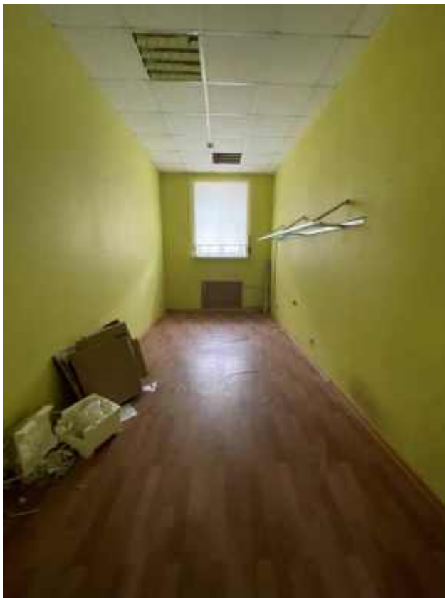
Фото 41. Интерьер 2 этажа объекта культурного наследия регионального значения «Гараж (корпус 266)», входящего в состав объекта культурного наследия регионального значения «Комплекс товарищества Российско-Американской резиновой мануфактуры «Треугольник»
