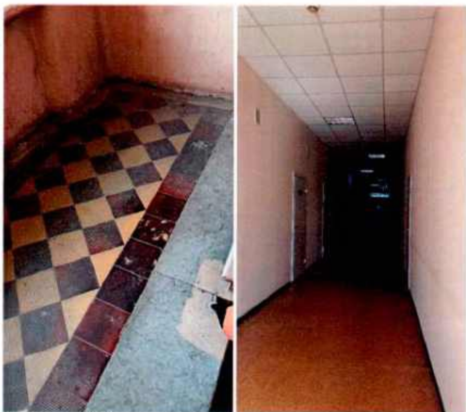
Фото 14. Покрытие межэтажных площадок лестниц объекта культурного наследия.
