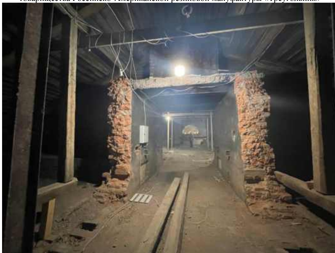
Фото 88. Интерьер чердака объекта культурного наследия регионального значения «Гараж (корпус 266)», входящего в состав объекта культурного наследия регионального значения «Комплекс товарищества Российско-Американской резиновой мануфактуры «Треугольник»
