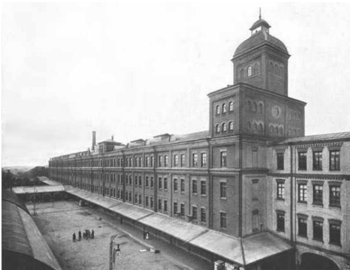
12. 1904 г. — Российско-Американская резиновая мануфактура "Треугольник". Производственные здания и школа // Citywalls.ru – архитектурный сайт Петербурга [Электронный ресурс]. URL: https://www.citywalls.ru/house2597.html .
