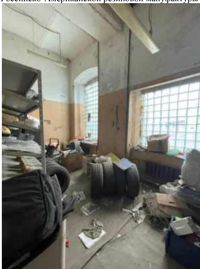
Фото 12. Интерьер 1 этажа объекта культурного наследия регионального значения «Гараж (корпус 266)», входящего в состав объекта культурного наследия регионального значения «Комплекс товарищества Российско-Американской резиновой мануфактуры «Треугольник»
