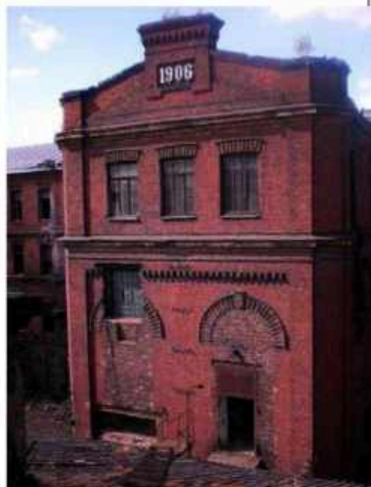
VIII. «Водонапорная башня (корпус 19)», Санкт-Петербург, набережная Обводного канала, дом 134-136-138, литера Б
