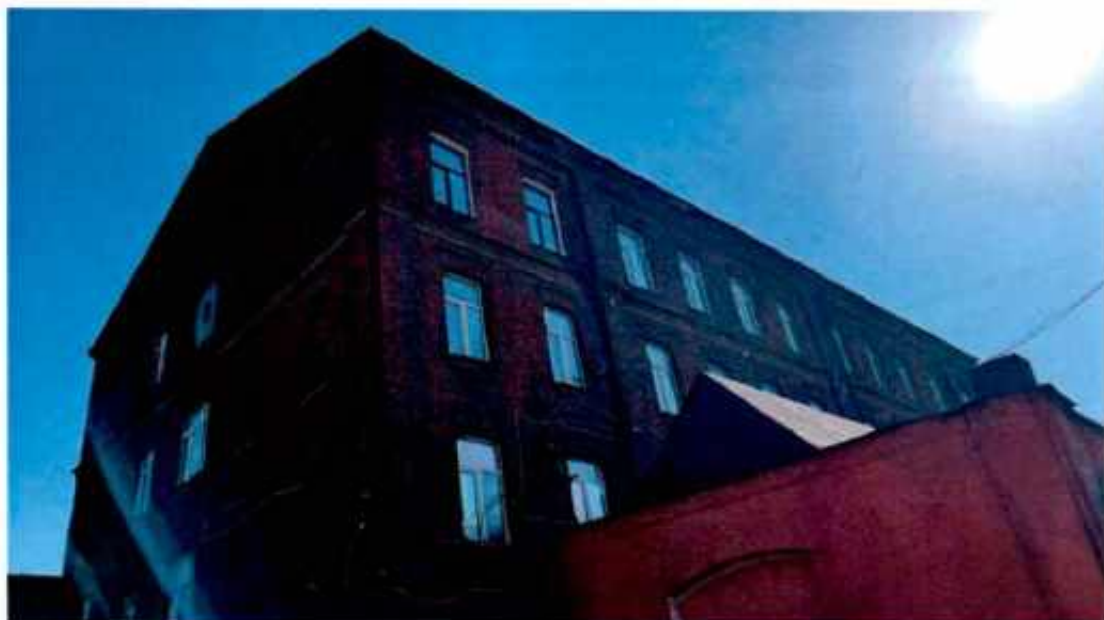
Фото 7. Общий вид на северо-восточный и северо-западный фасад объекта культурного наследия.
