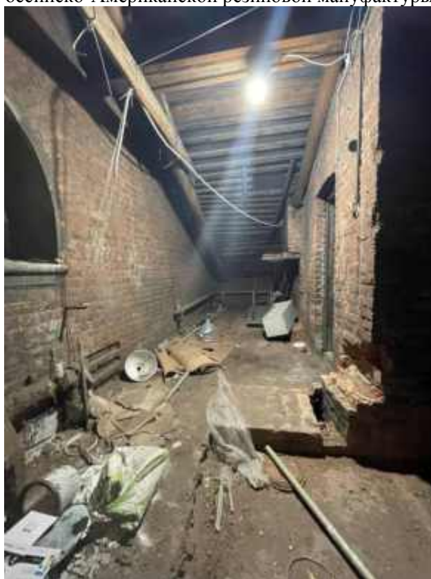
Фото 90. Интерьер чердака объекта культурного наследия регионального значения «Гараж (корпус 266)», входящего в состав объекта культурного наследия регионального значения «Комплекс товарищества Российско-Американской резиновой мануфактуры «Треугольник»
