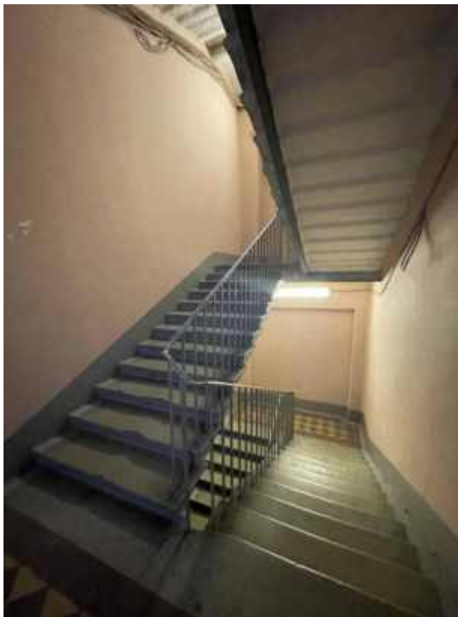
Фото 9. Интерьер 1 этажа объекта культурного наследия регионального значения «Гараж (корпус 266)», входящего в состав объекта культурного наследия регионального значения «Комплекс товарищества Российско-Американской резиновой мануфактуры «Треугольник»
