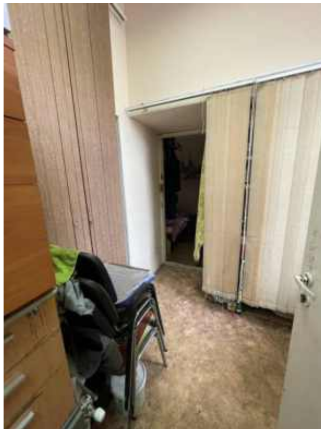
Фото 44. Интерьер 2 этажа объекта культурного наследия регионального значения «Гараж (корпус 266)», входящего в состав объекта культурного наследия регионального значения «Комплекс товарищества Российско-Американской резиновой мануфактуры «Треугольник»
