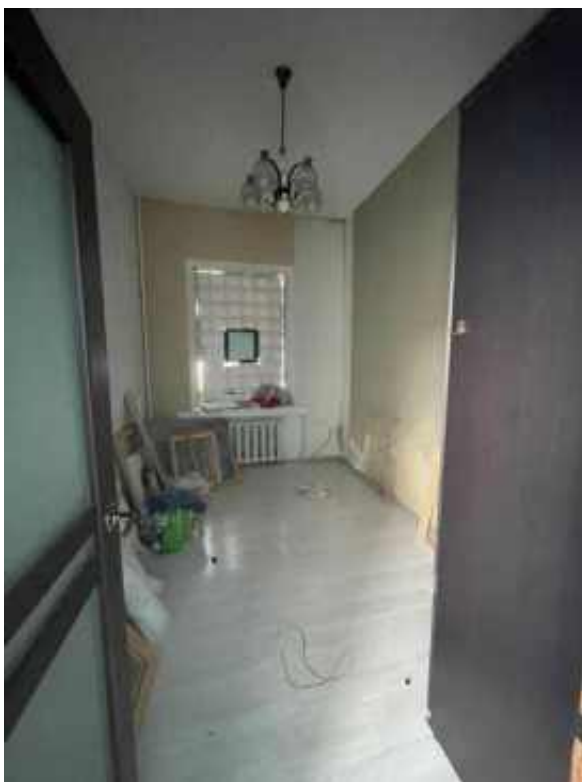
Фото 83. Интерьер 4 этажа объекта культурного наследия регионального значения «Гараж (корпус 266)», входящего в состав объекта культурного наследия регионального значения «Комплекс товарищества Российско-Американской резиновой мануфактуры «Треугольник»
