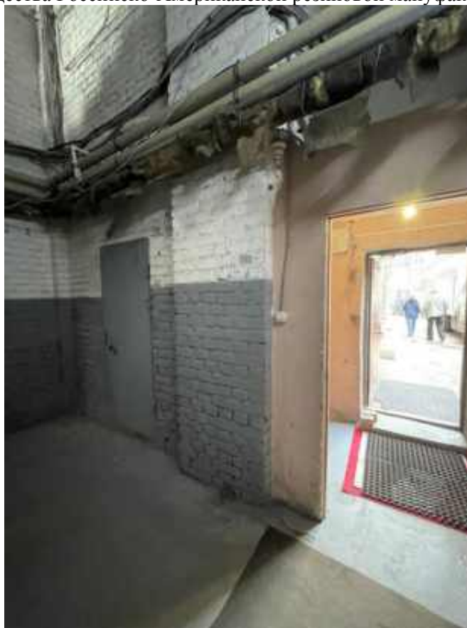
Фото 6. Интерьер 1 этажа объекта культурного наследия регионального значения «Гараж (корпус 266)», входящего в состав объекта культурного наследия регионального значения «Комплекс товарищества Российско-Американской резиновой мануфактуры «Треугольник»
